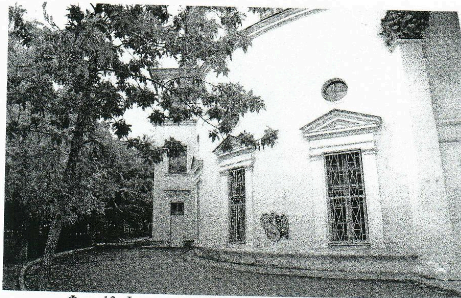
Фото 13. Фрагмент главного фасада с южной стороны
