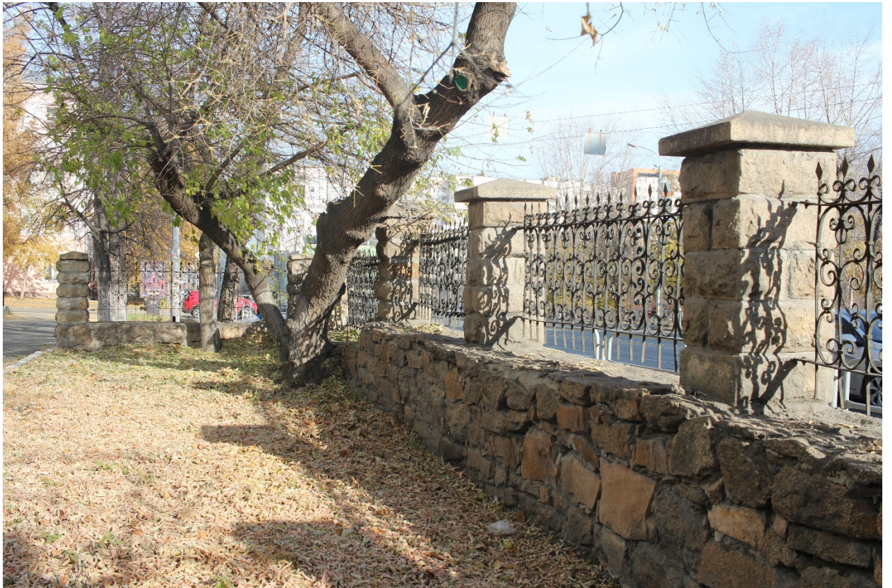
Фото 3. Объект культурного наследия. Ограда. Вид с ЮЗ.
