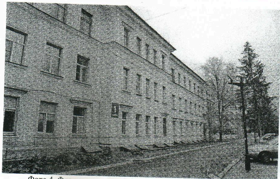
Фото 4. Фрагмент вытянутого юго-восточного фасада здания
