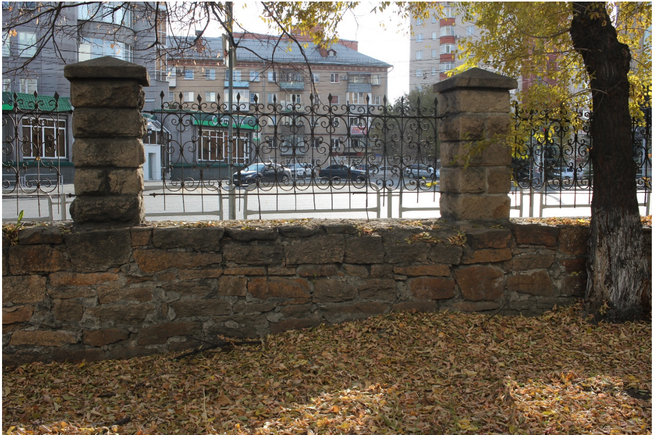
Фото 4. Объект культурного наследия. Ограда. Вид с СЗ.
