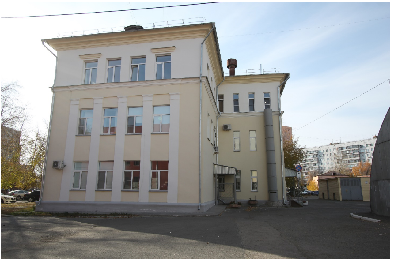
Фото 9. Объект культурного наследия. Корпус первой городской больницы. Боковой фасад.
