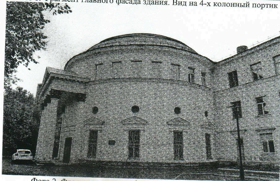
Фото 2. Фрагмент главного фасада здания округлой формы
