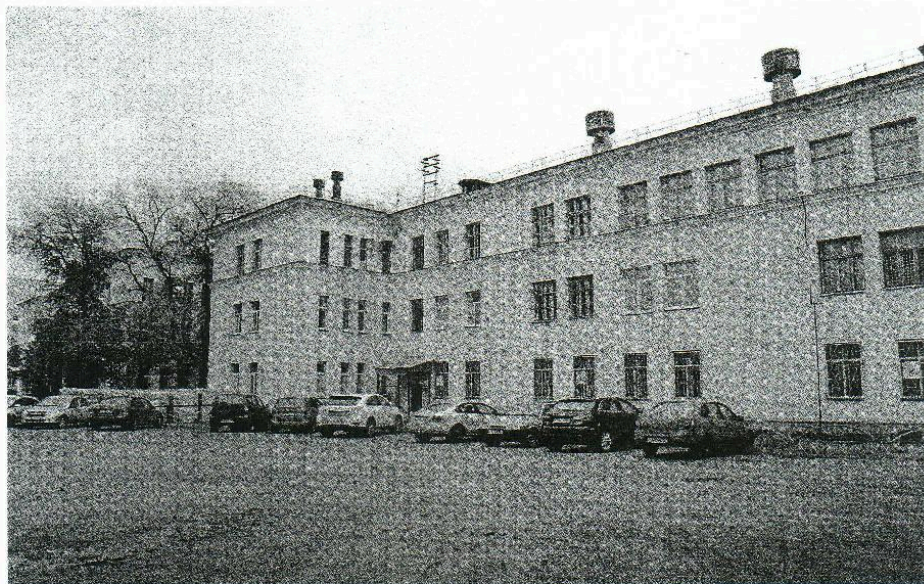
Фото 11. Фрагмент дворового северо-западного фасада
