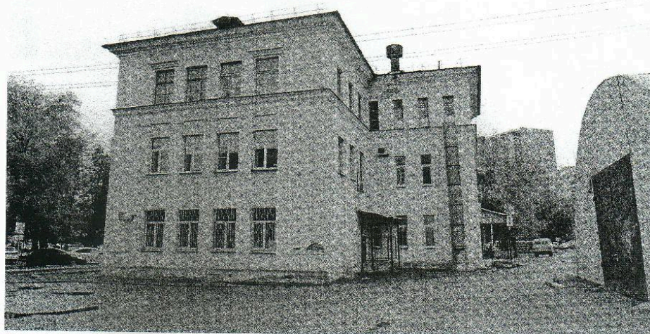
Фото 6. Вид на северный фасад с северо-западной стороны
