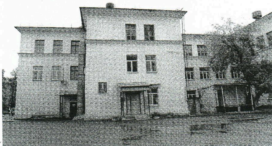
Фото 7. Вид на левое крыло дворового северо-западного фасада
