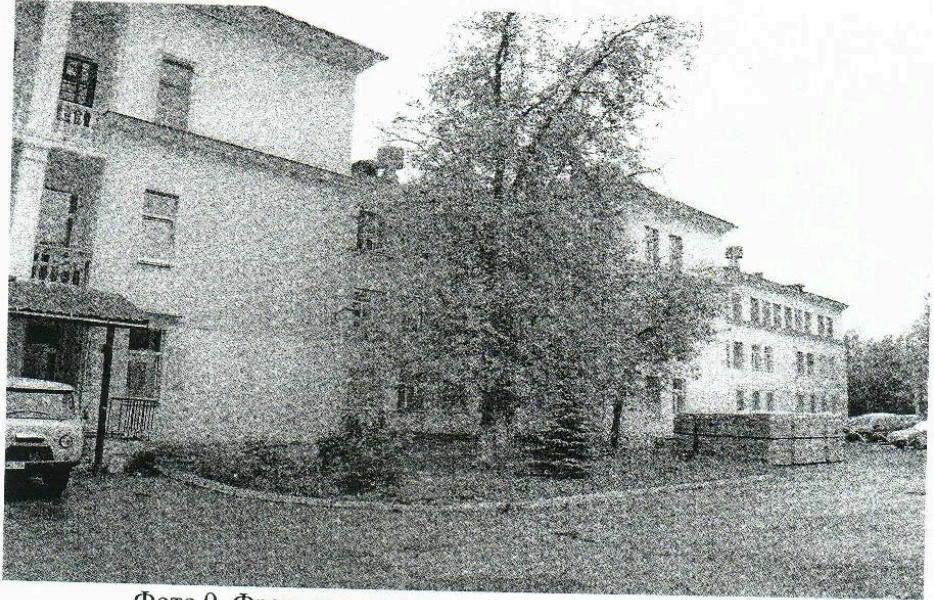
Фото 9. Фрагмент дворового северо-западного фасада
