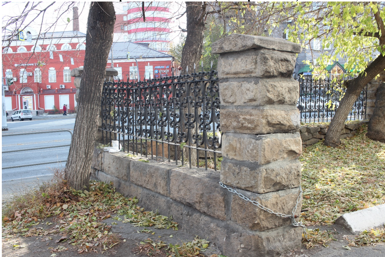
Фото 1. Объект культурного наследия. Ограда. Вид с СЗ.
