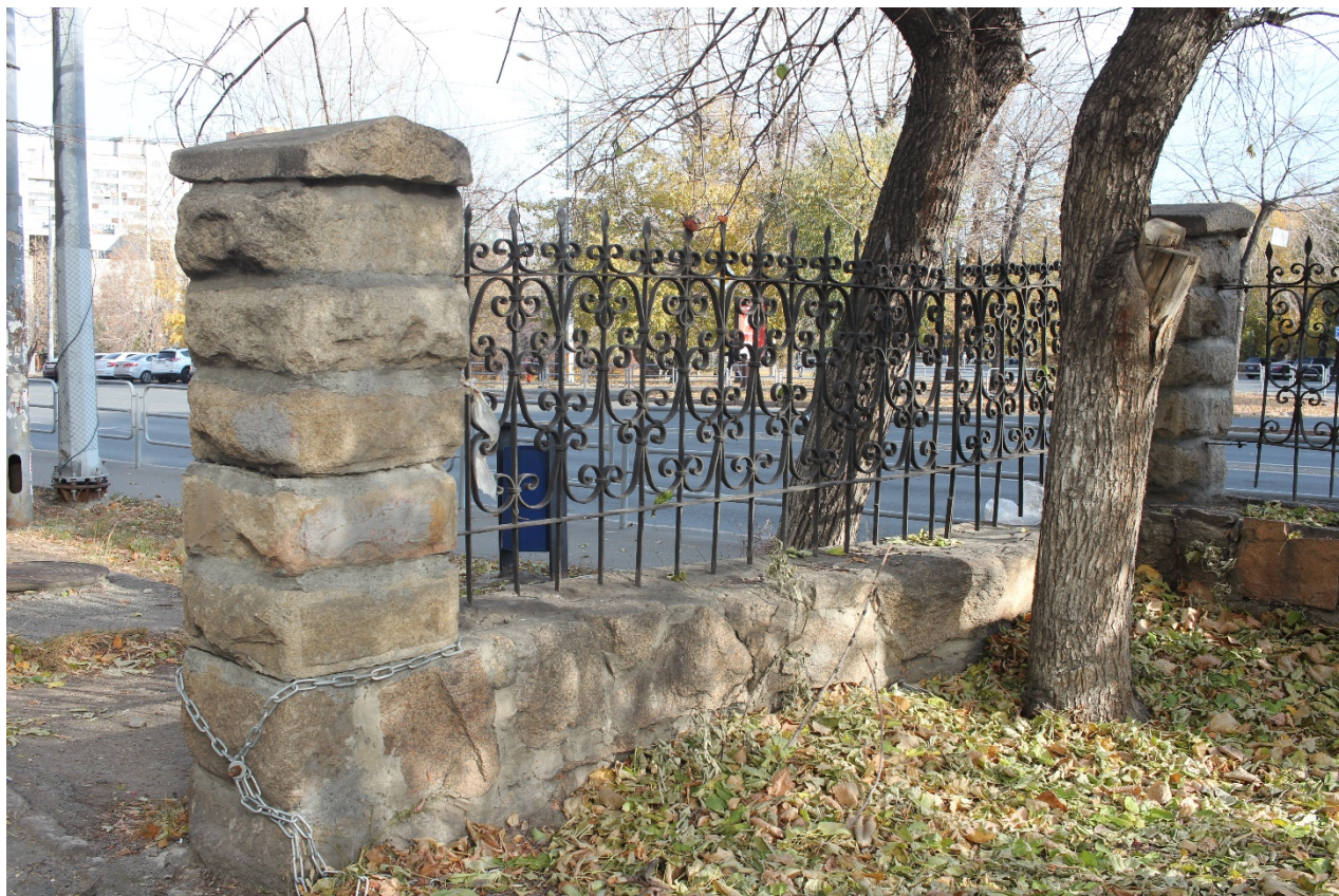
Фото 2. Объект культурного наследия. Ограда. Вид с В.
