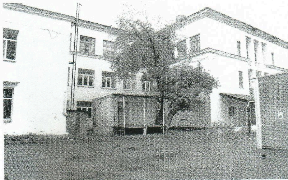
Фото 8. Фрагмент дворового северо-западного фасада
