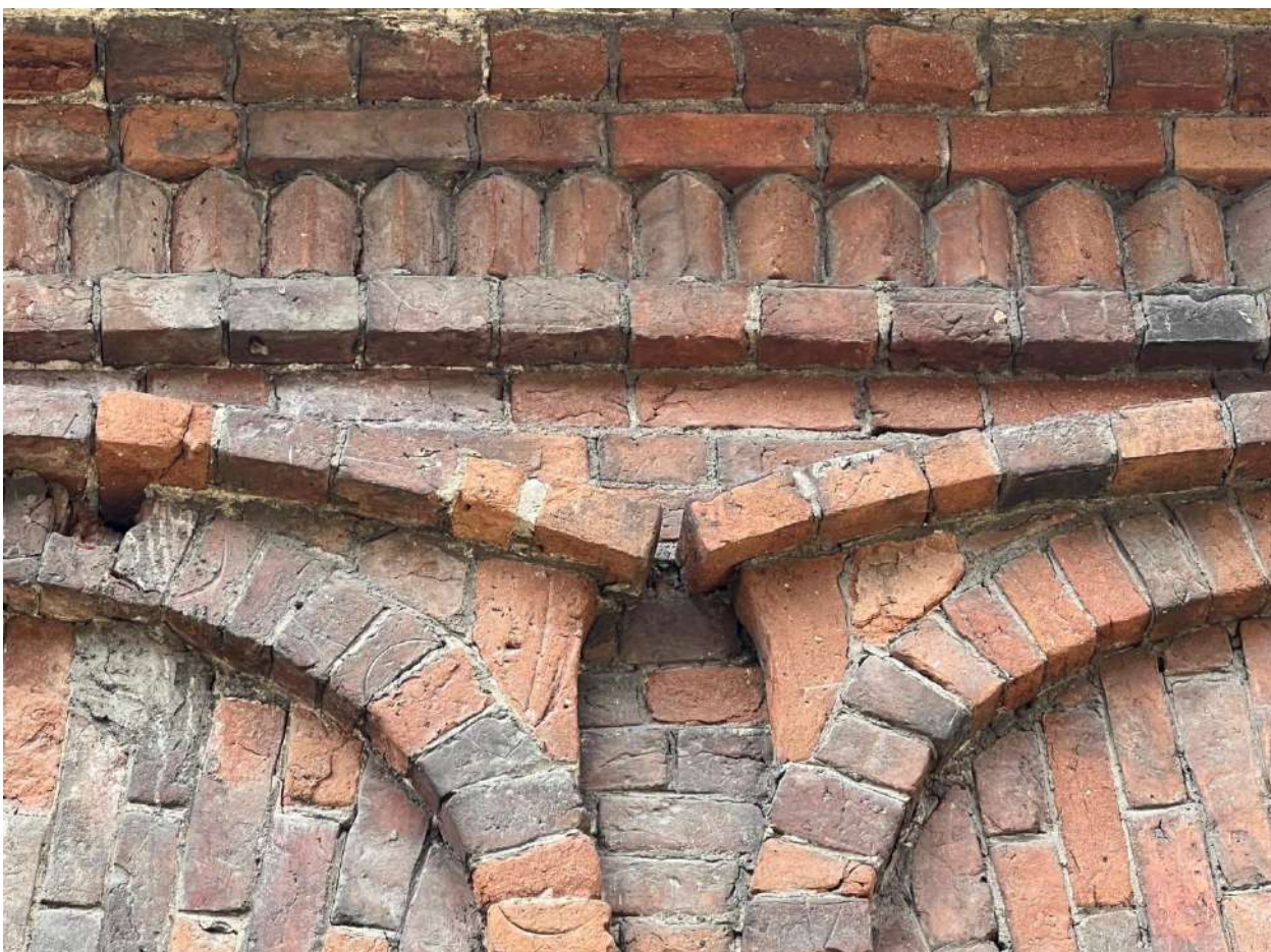
Рис. 6. Кирпичная кладка декоративных элементов главного фасада
