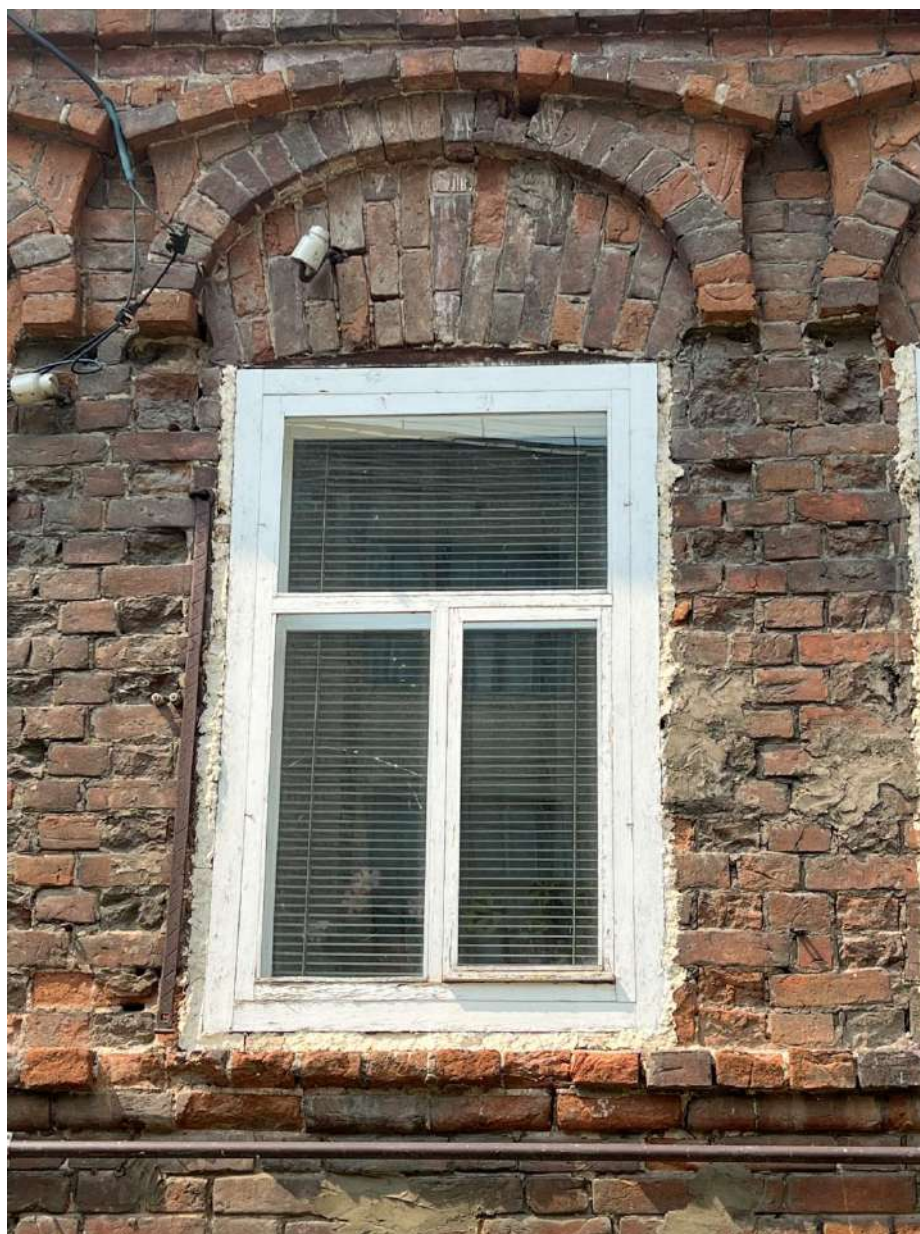
Рис. 5 Оконный проем первого этажа главного фасада
