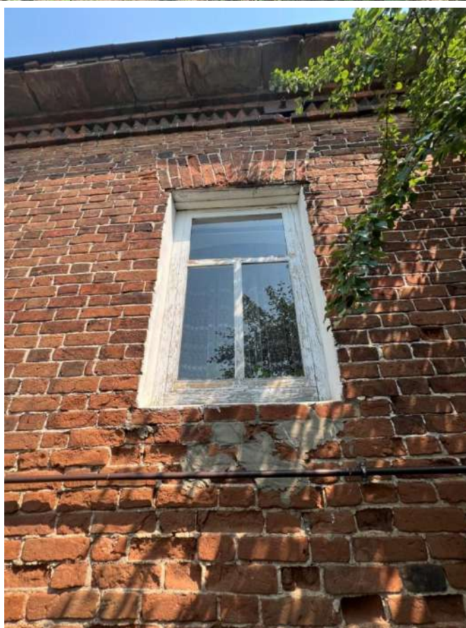
Рис. 7 а, б. Боковой, юго-западный фасад: общий вид (вверху) и оконный проем первого этажа (внизу)
