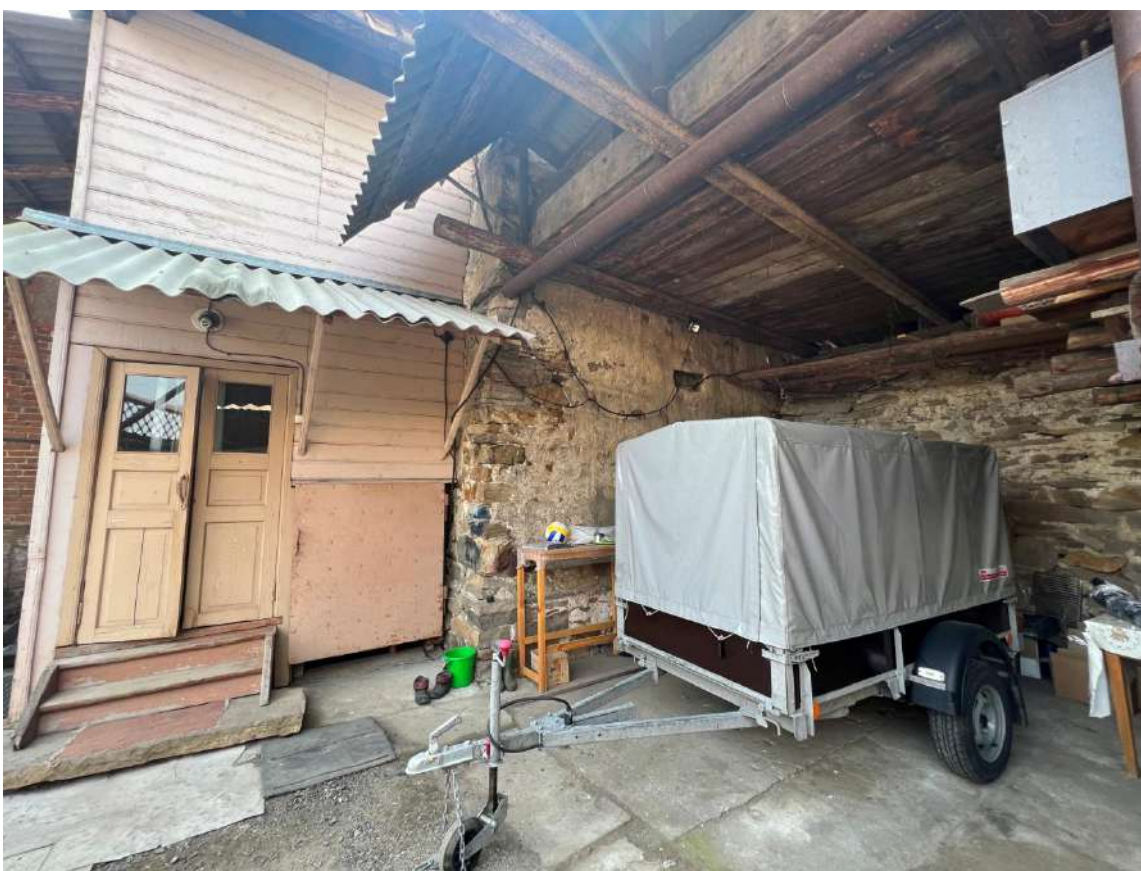
9 а, б. Объем хозяйственной пристройки из бутового камня. Боковой, юго-западный фасад (вверху) и дворовый, северо-западный фасад (внизу)
