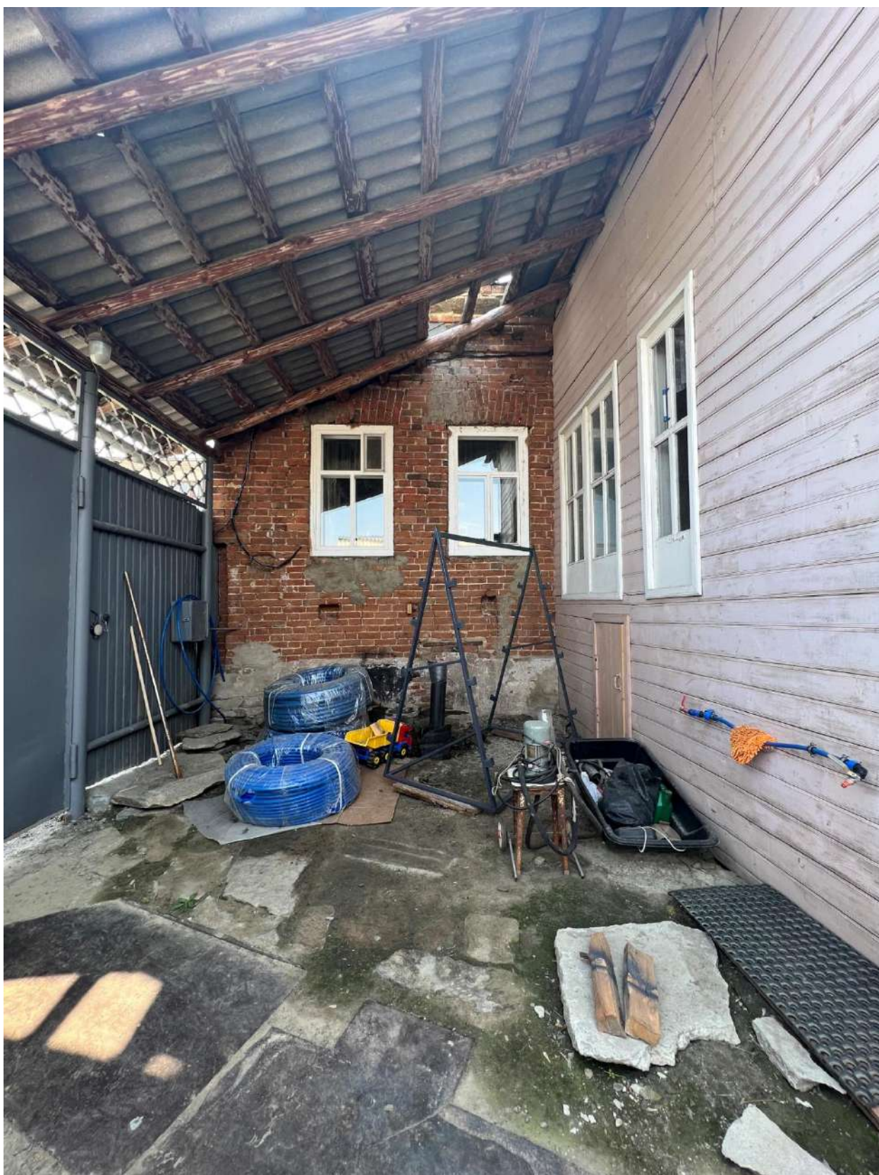
8. Дворовый, северо-западный фасад. Сохранившиеся оконные проемы
