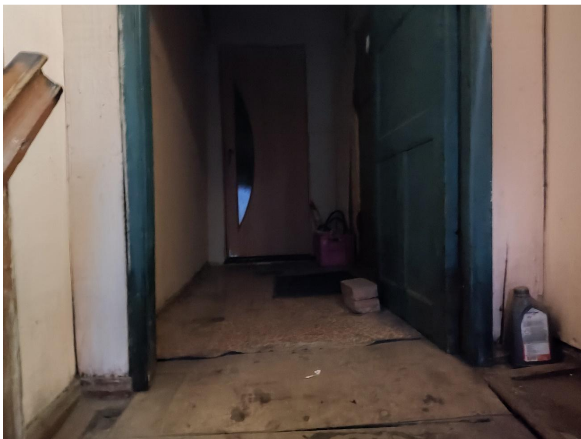
Приложение №7. Выявленный объект культурного наследия «Жилой дом полукаменный». Коридор. Фото по состоянию на ноябрь 2022 года.
