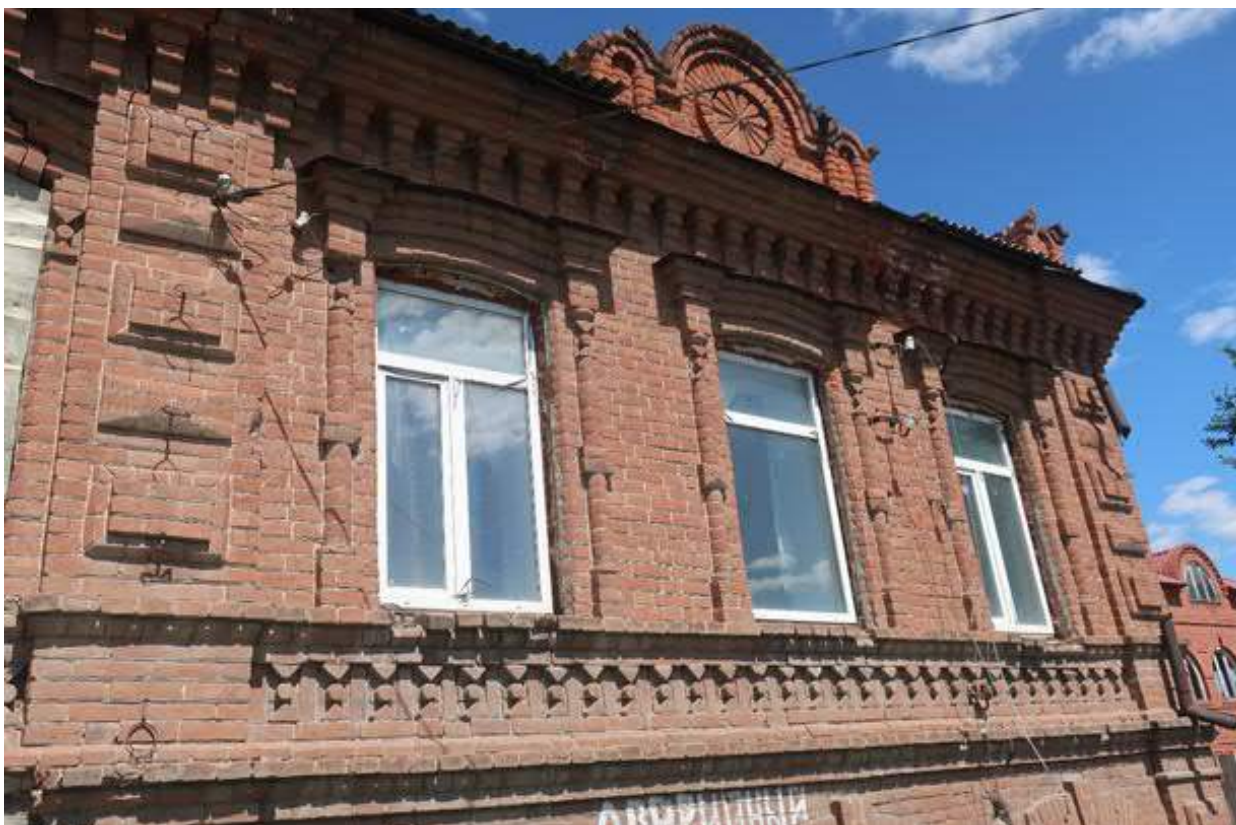
Фото 5. Фрагмент с окнами первого этажа южного парадного фасада Объекта.
