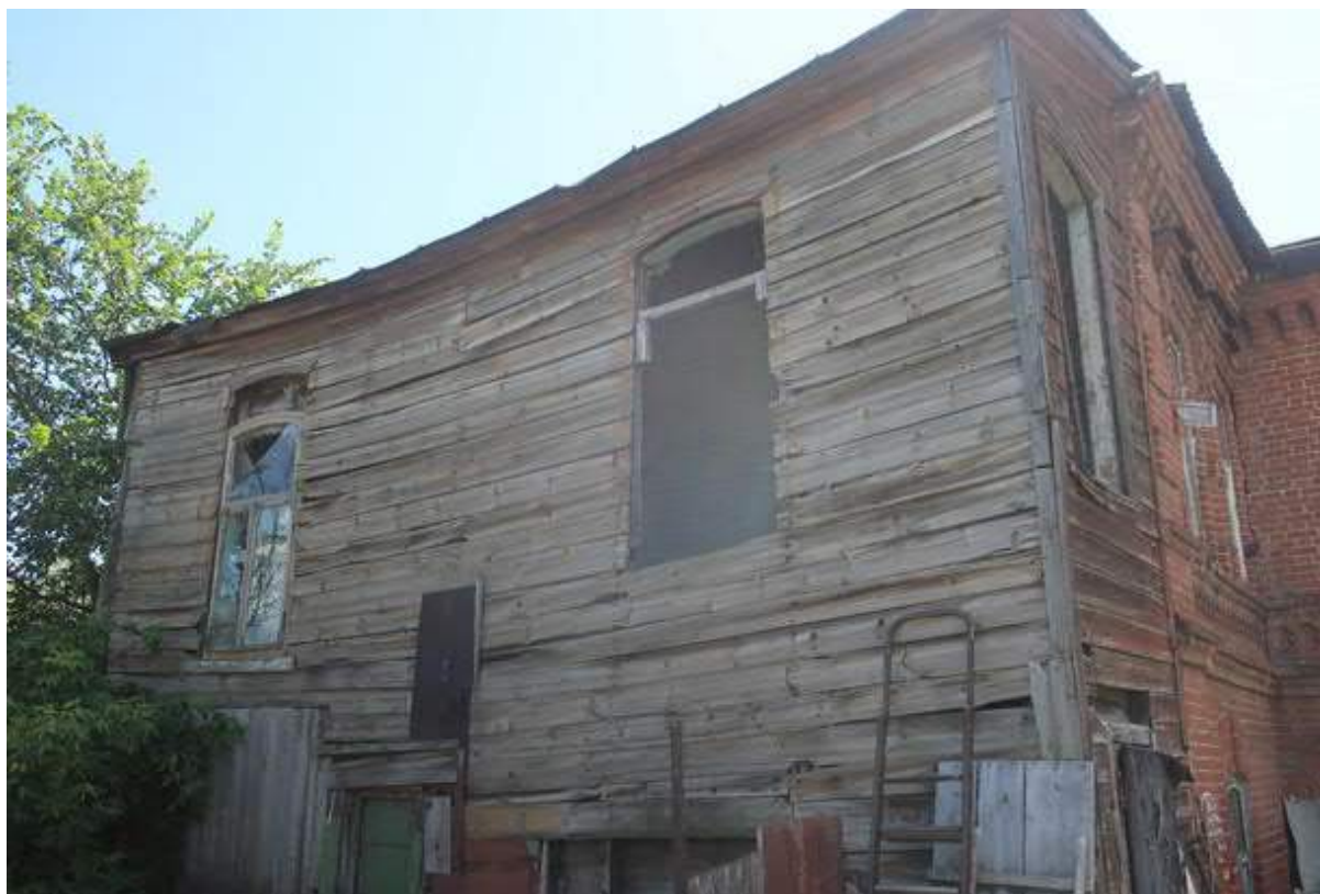
Фото 15. Фрагмент северного фасада Объекта.
