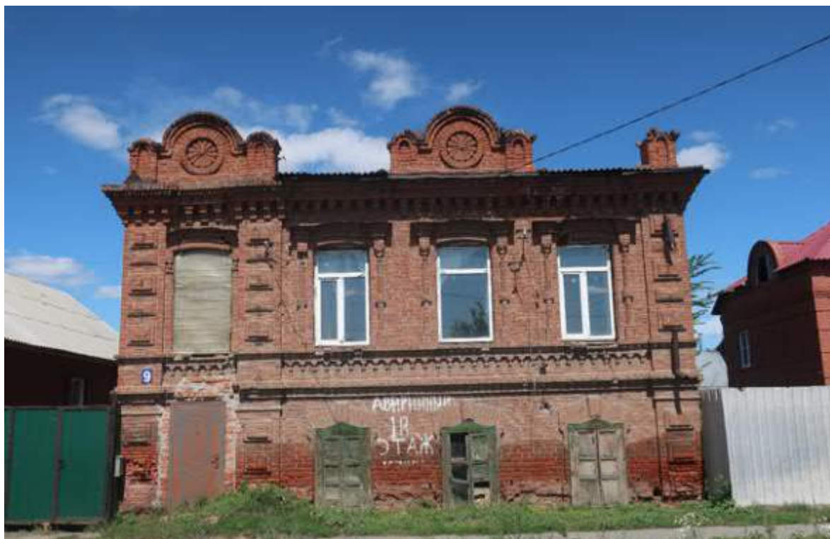
Фото 9. Вид южного парадного фасада Объекта. Фото сделано с четной стороны ул. им. В.И. Чапаева.
