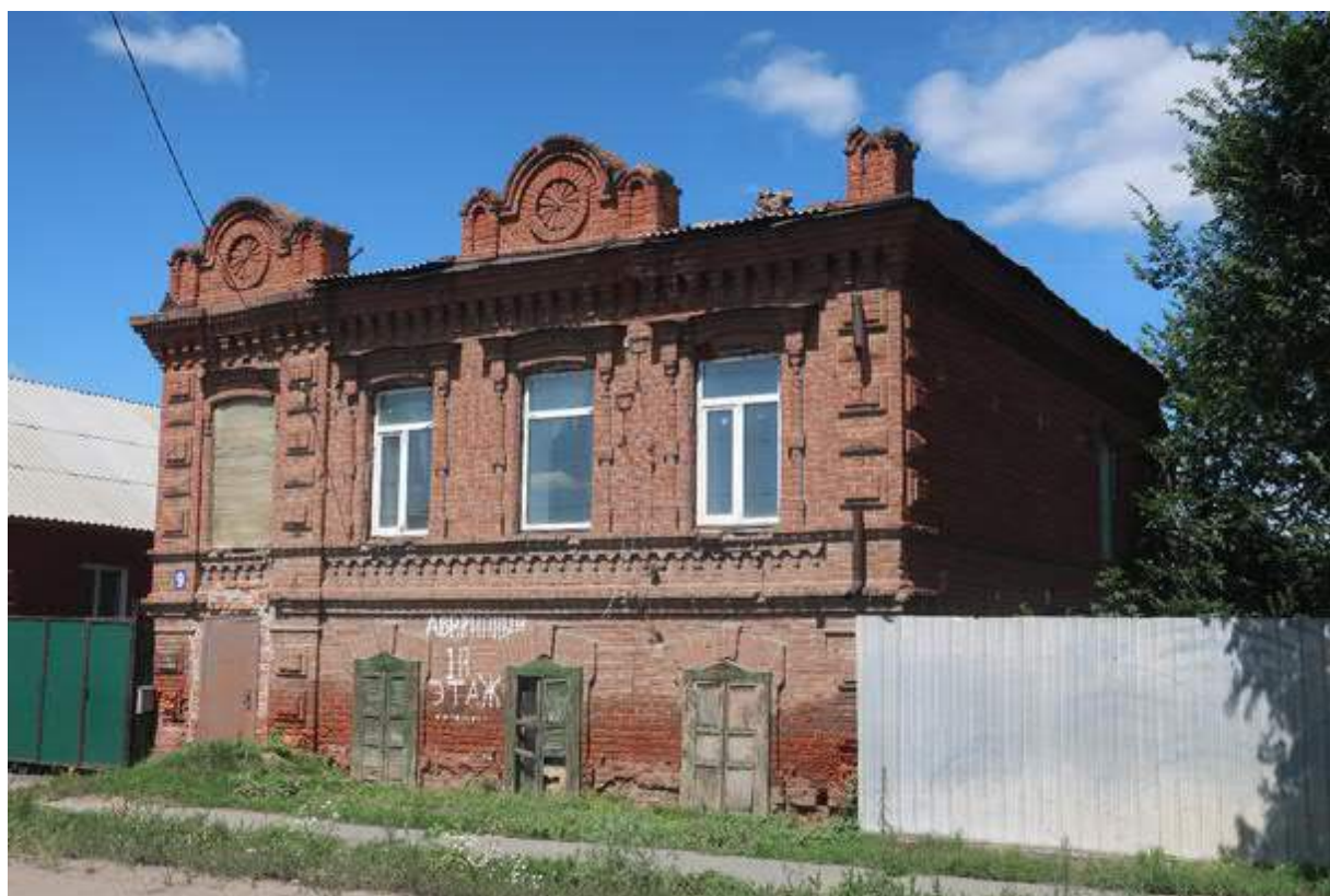
Фото 10. Вид южного парадного и фрагмент восточного фасадов Объекта. Фото сделано с юго-восточной стороны.
