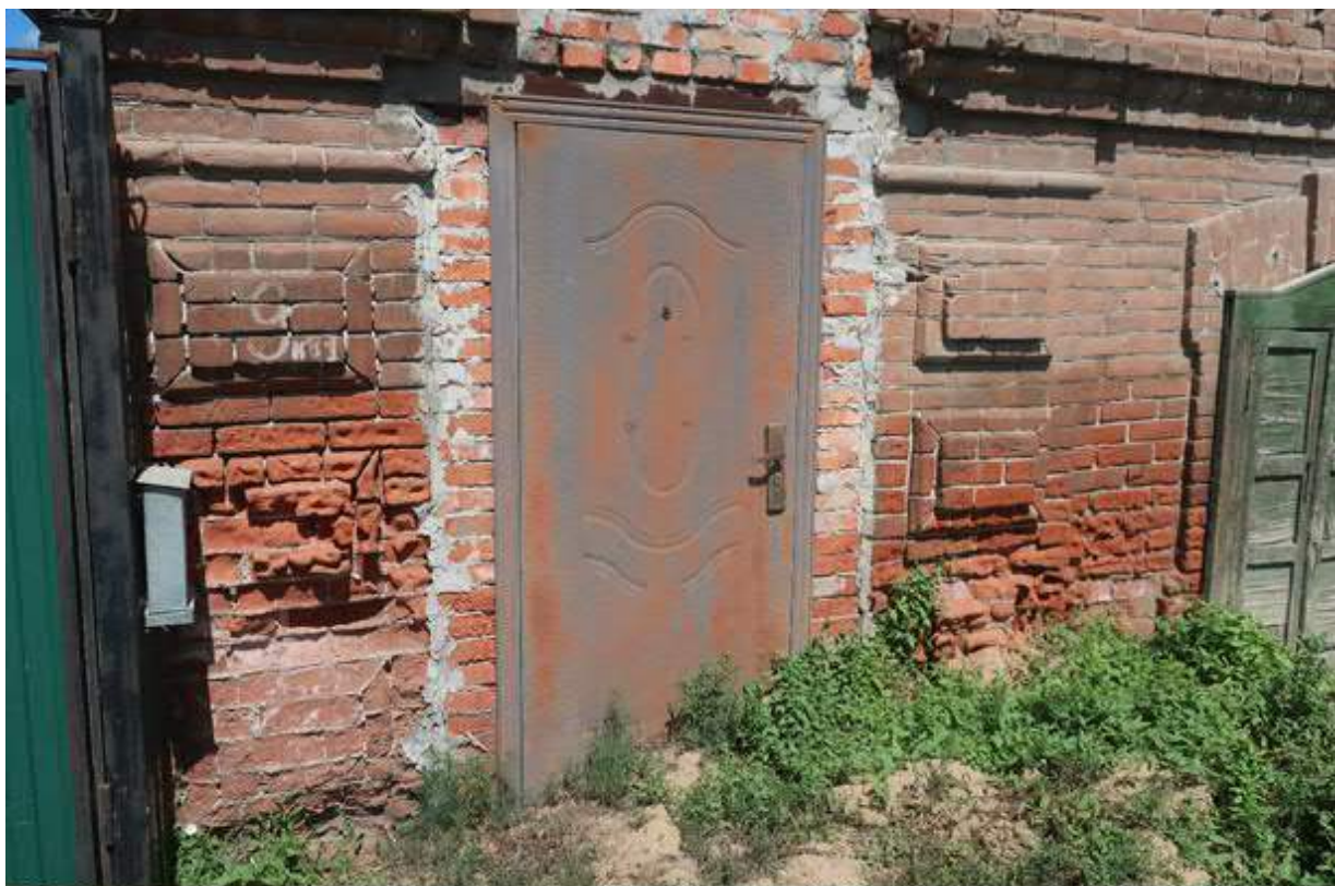
Фото 7. Фрагмент с входной группой южного парадного фасада Объекта.
