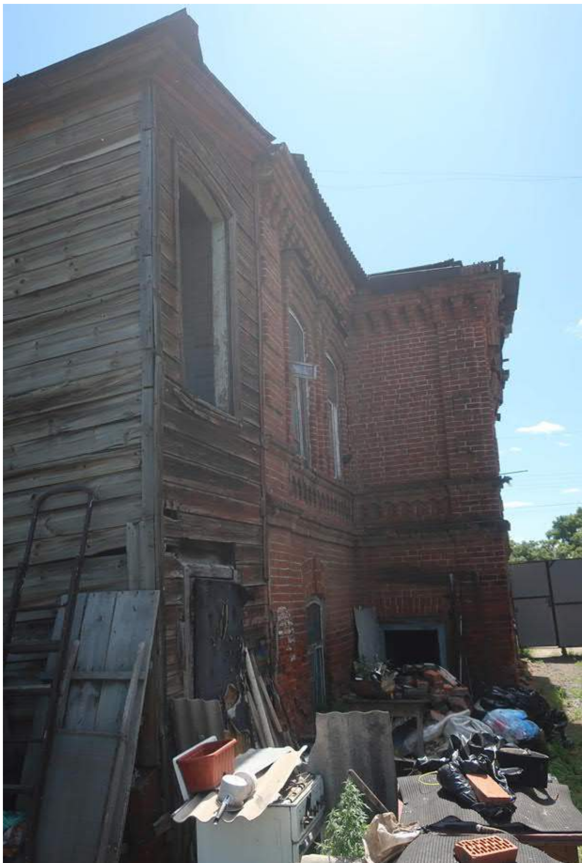
Фото 14. Вид западного фасада Объекта. Фото сделано с северной стороны.
