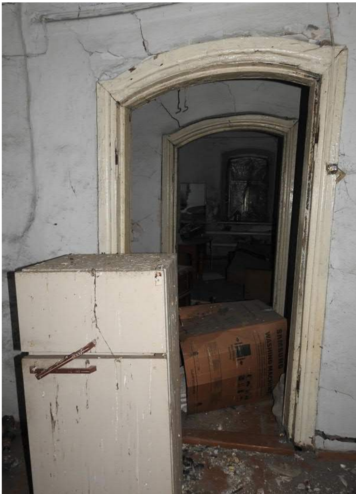
Фото 19. Анфилада внутренних помещений Объекта.
