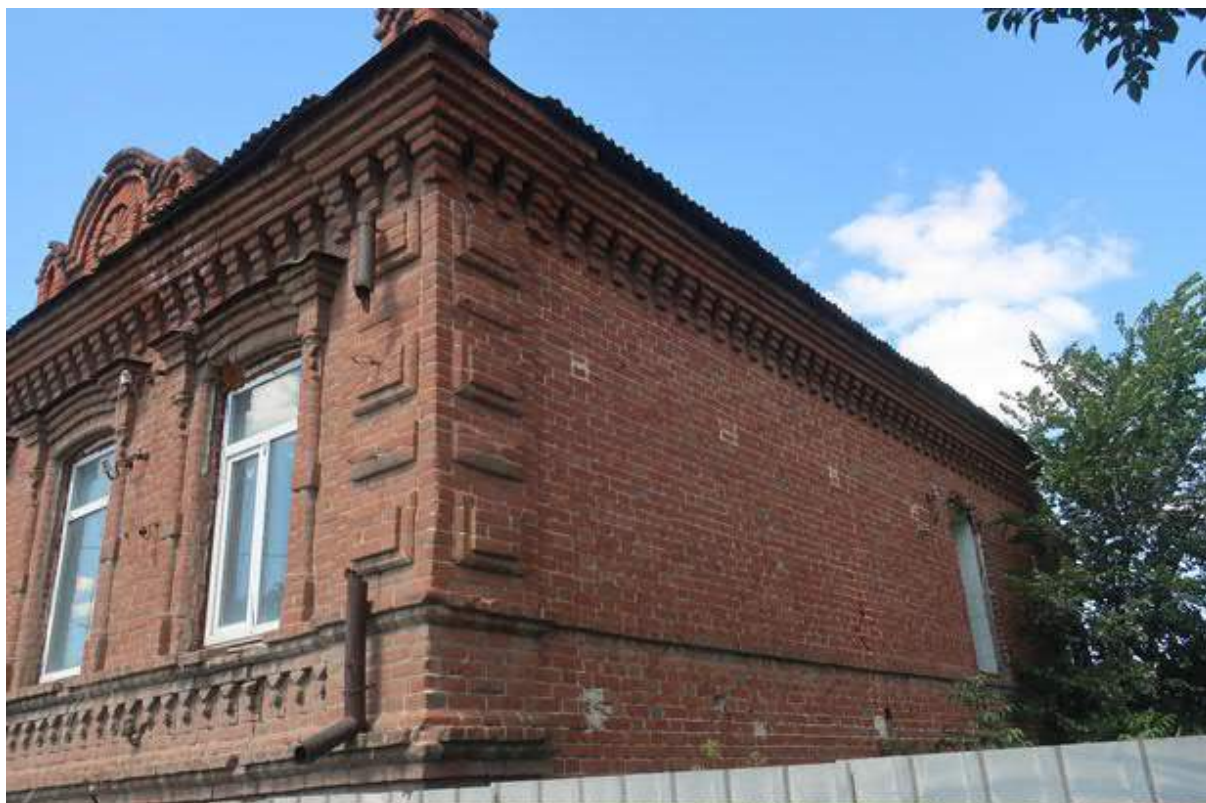
Фото 11. Фрагмент восточного фасада Объекта.
