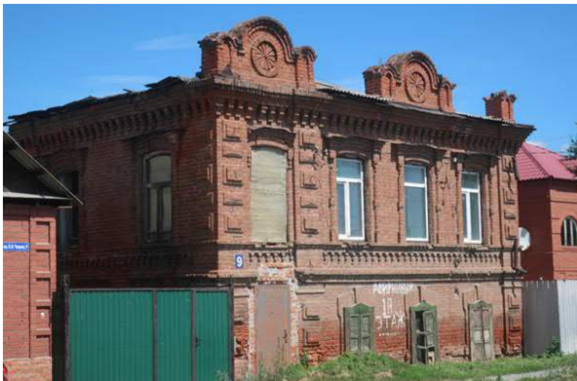
Фото 3. Вид южного парадного и фрагмент западного фасадов Объекта. Фото сделано с юго-западной стороны.
