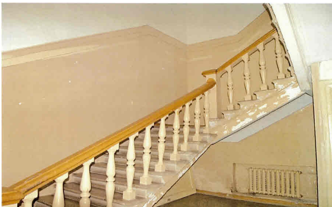
Фото 28. Фрагмент бетонной лестницы с ограждением из балюстрады
