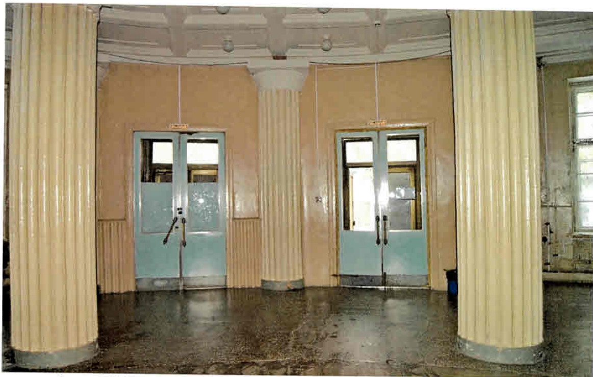
Фото 25. Вид на входные двери в вестибюле 1-го этажа здания
