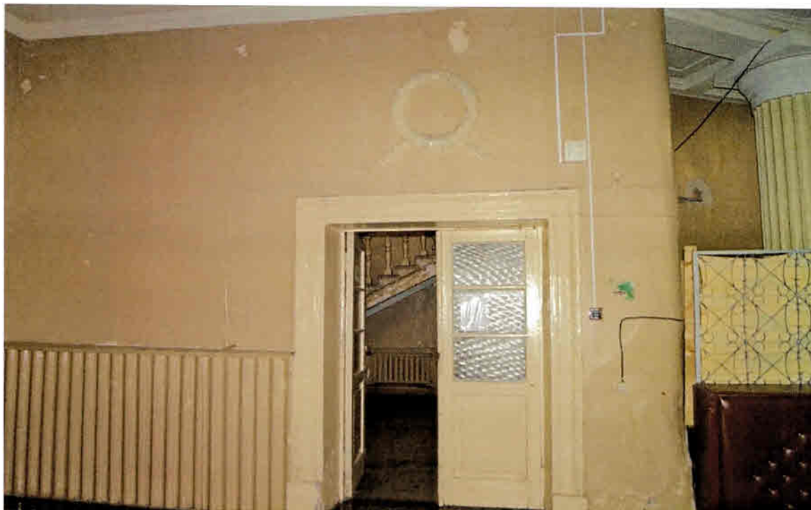
Фото 27. Вид на дверной проем на лестничную клетку
