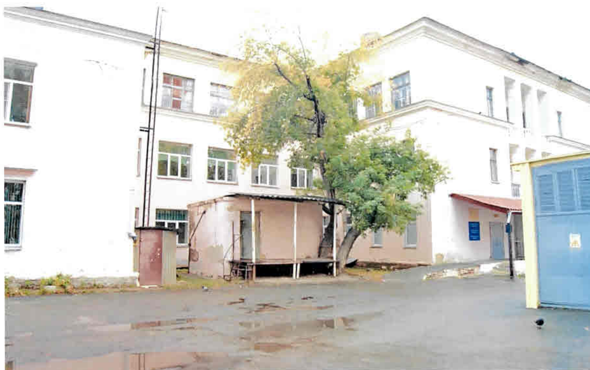
Фото 8. Фрагмент дворового северо-западного фасада
