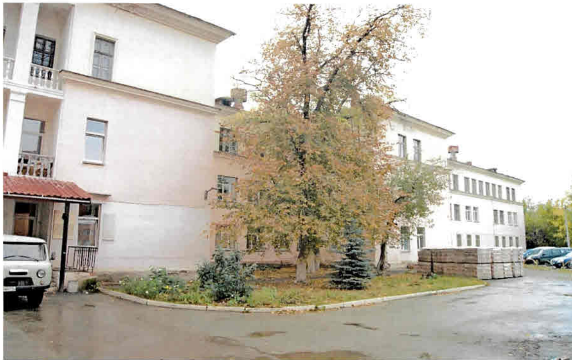
Фото 9. Фрагмент дворового северо-западного фасада
