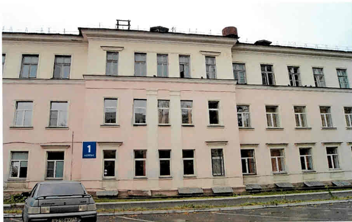
Фото 3. Вид на выступающую часть вытянутого юго-восточного фасада здания
