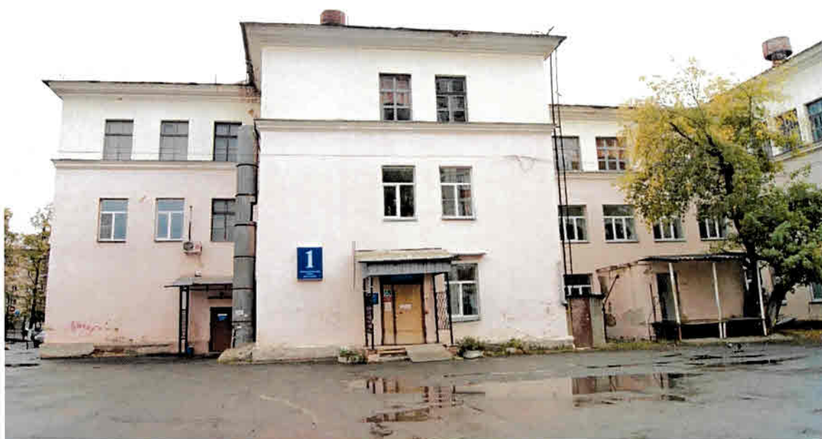
Фото 7. Вид на левое крыло дворового северо-западного фасада
