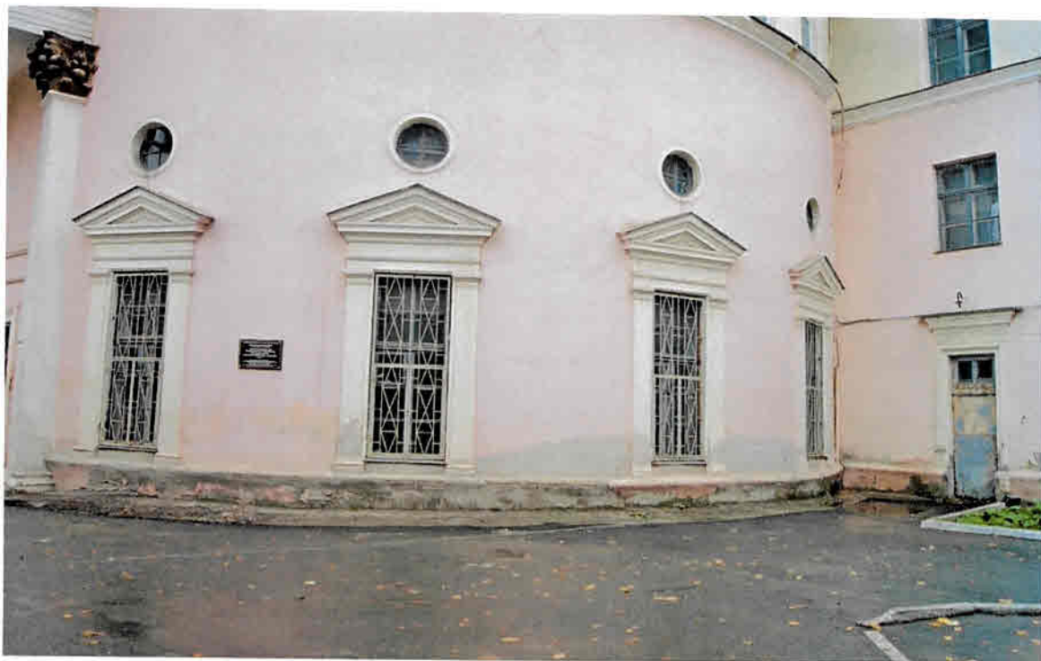
Фото 17. Вид на окна 1-го этажа на главном фасаде закругленной части здания
