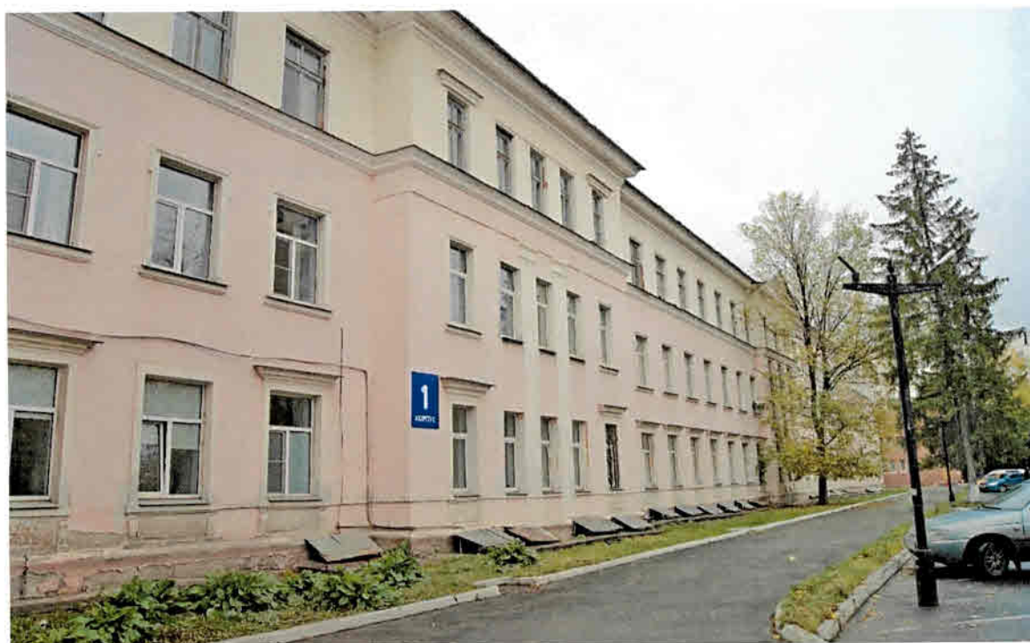
Фото 4. Фрагмент вытянутого юго-восточного фасада здания
