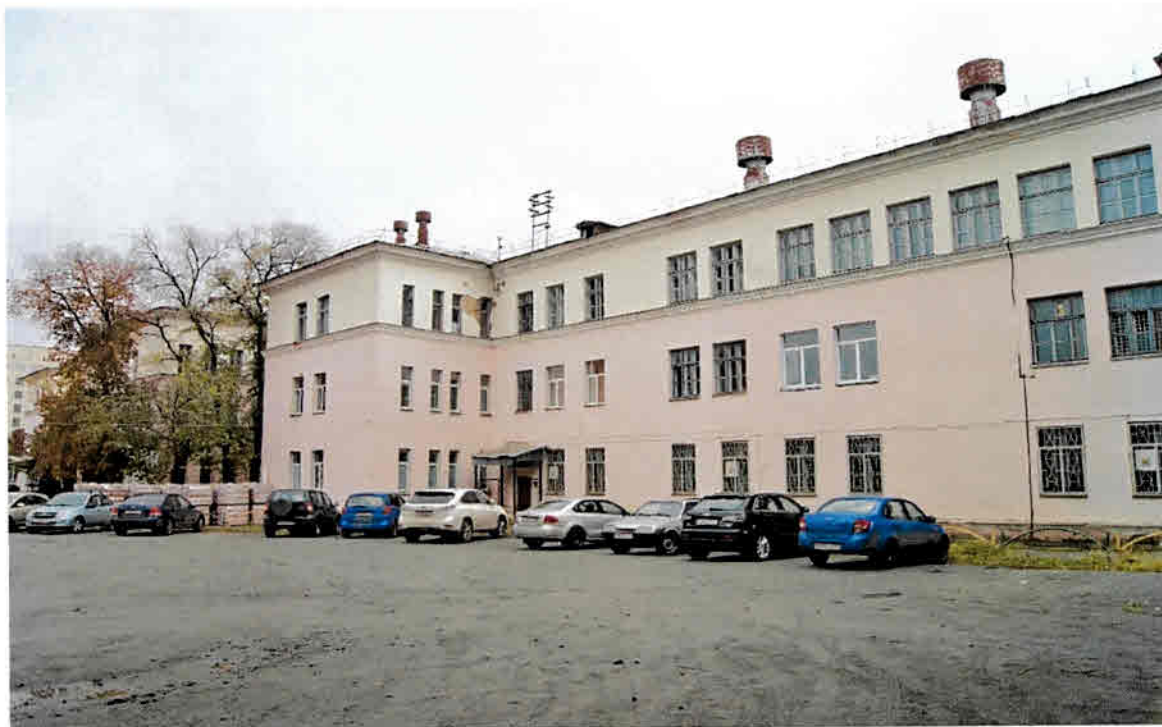
Фото 11. Фрагмент дворового северо-западного фасада
