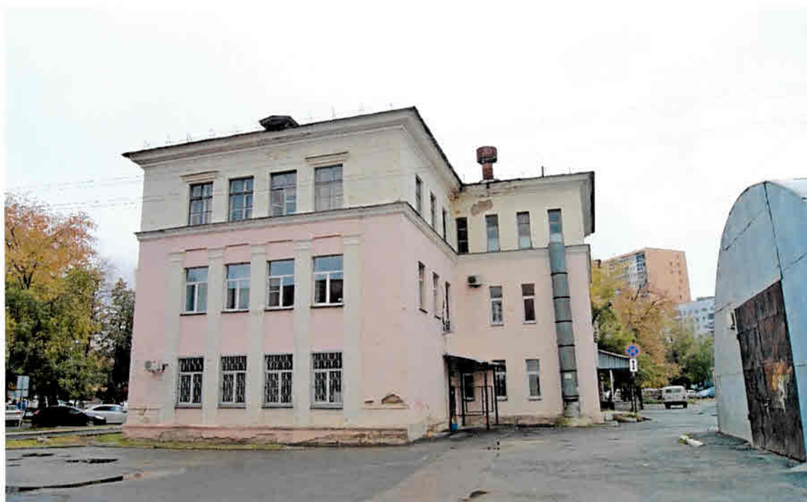
Фото 6. Вид на северный фасад с северо-западной стороны
