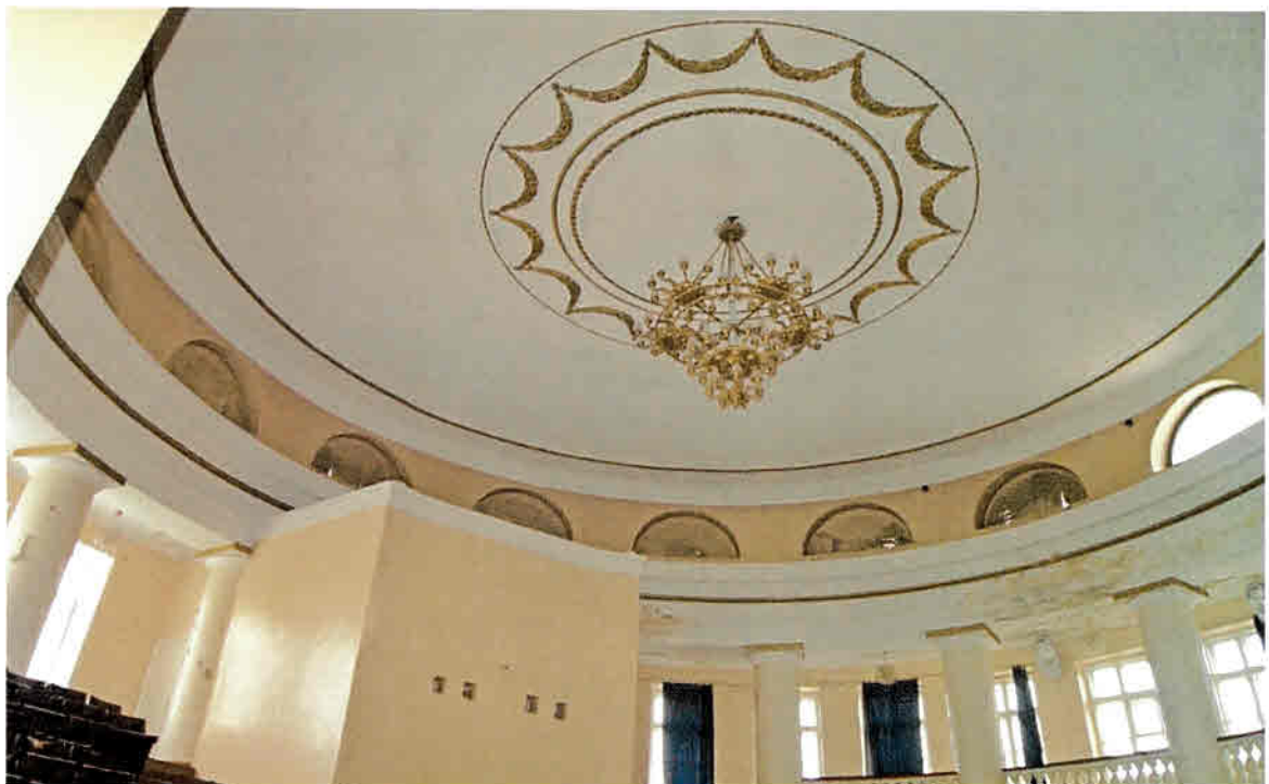
Фото 30. Вид на круглый потолок в лекционном зале на 2-м этаже здания
