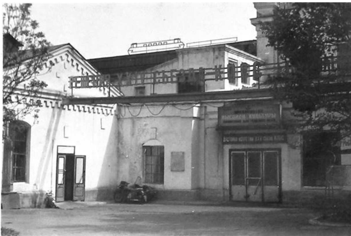
Фото 6. Историческое фото объекта, 1982 г. Источник: https://pik174.ru/catalog/pamyatniki-arkhitektury/lokomotivnoe-depo-tsentr-revolyuetsionnogo-dvizheniya-v-chelyabinske-g-chelyabinsk-ul-krasnoarmeyskaya/ (дата обращения: 02.10.24)
