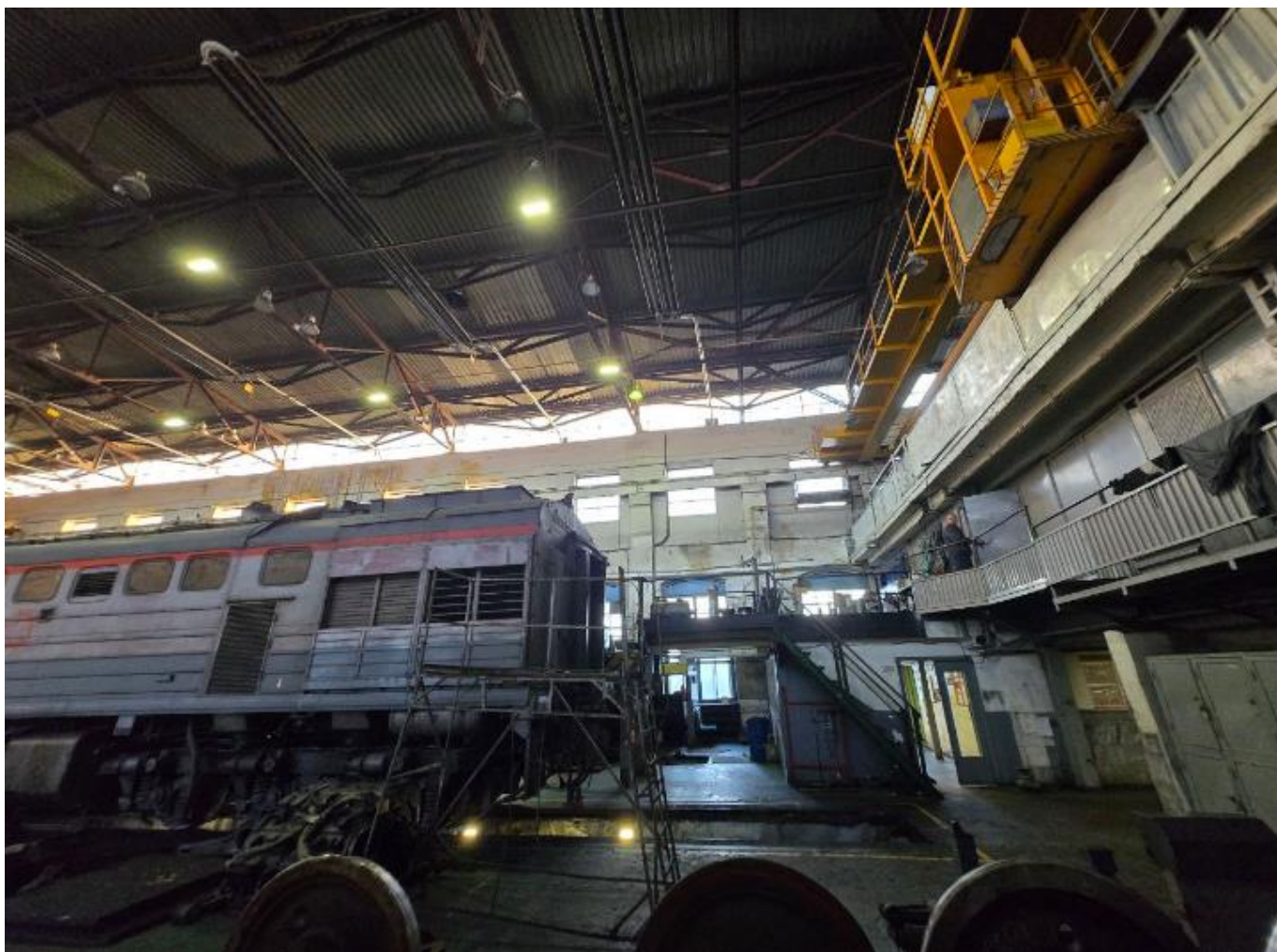
Фото 16. Интерьер выявленного объекта культурного наследия «Локомотивное депо - центр революционного движения в Челябинске 1903-1919 гг.», расположенного по адресу: Челябинская область, г. Челябинск, ул. Красноармейская, 101.
