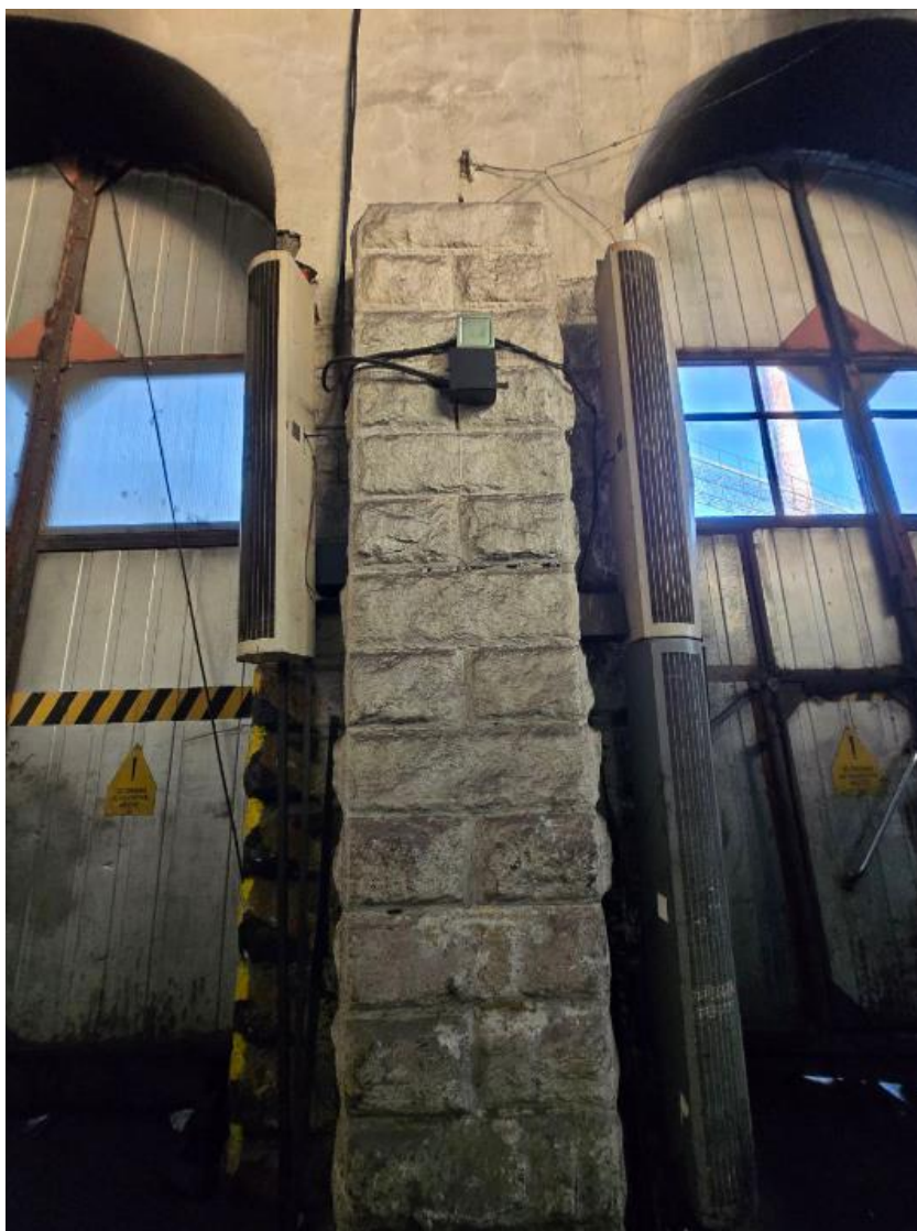
Фото 15. Интерьер выявленного объекта культурного наследия «Локомотивное депо - центр революционного движения в Челябинске 1903-1919 гг.», расположенного по адресу: Челябинская область, г. Челябинск, ул. Красноармейская, 101.
