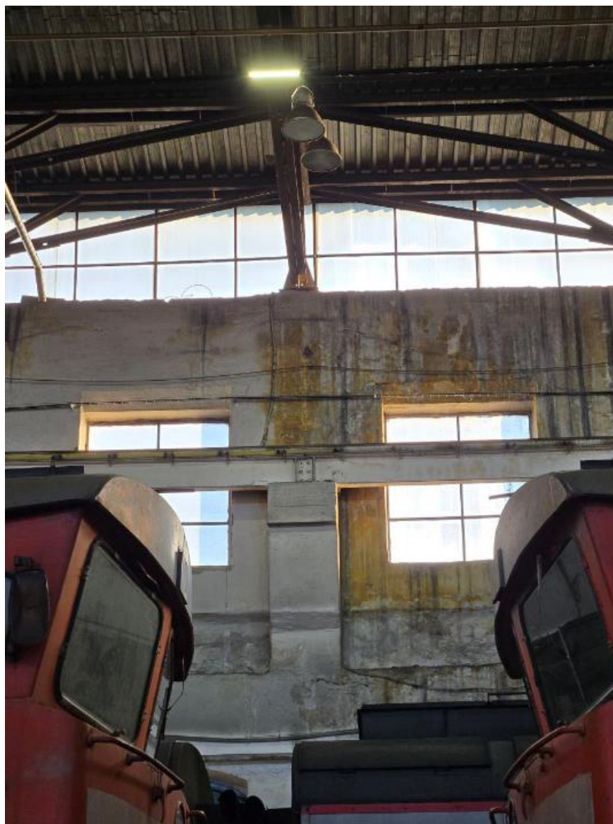
Фото 17. Интерьер выявленного объекта культурного наследия «Локомотивное депо - центр революционного движения в Челябинске 1903-1919 гг.», расположенного по адресу: Челябинская область, г. Челябинск, ул. Красноармейская, 101.
