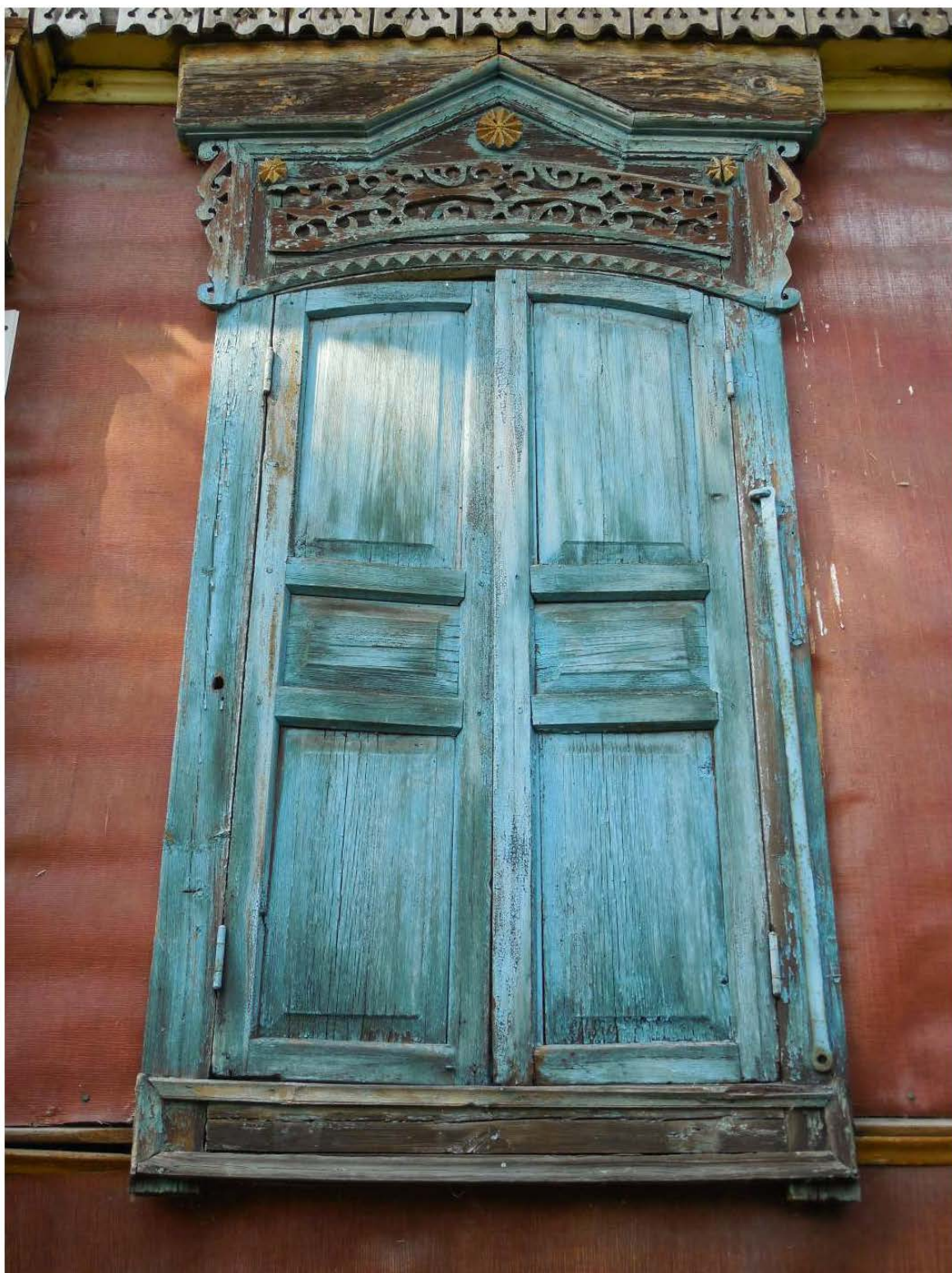
Оконный наличник восточного фасада. Август 2022 г. Фото: В. Г. Демаков
