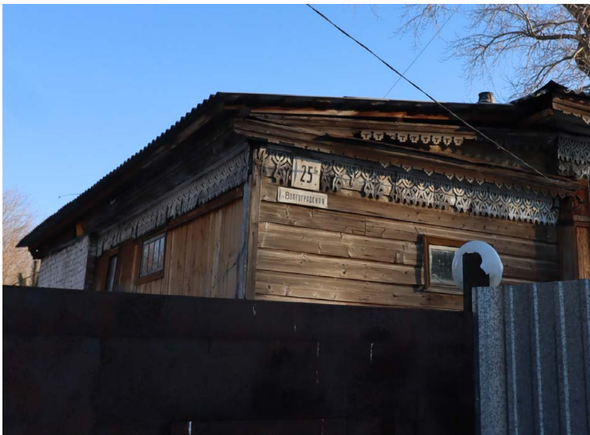
Фото.10 Выявленный объект культурного наследия «Жилой дом заимки Маренова - радиостанции РВ-72», расположенный по адресу: Челябинская область, г. Челябинск, ул. Волгоградская, 25 б. Западный и северный фасад.
