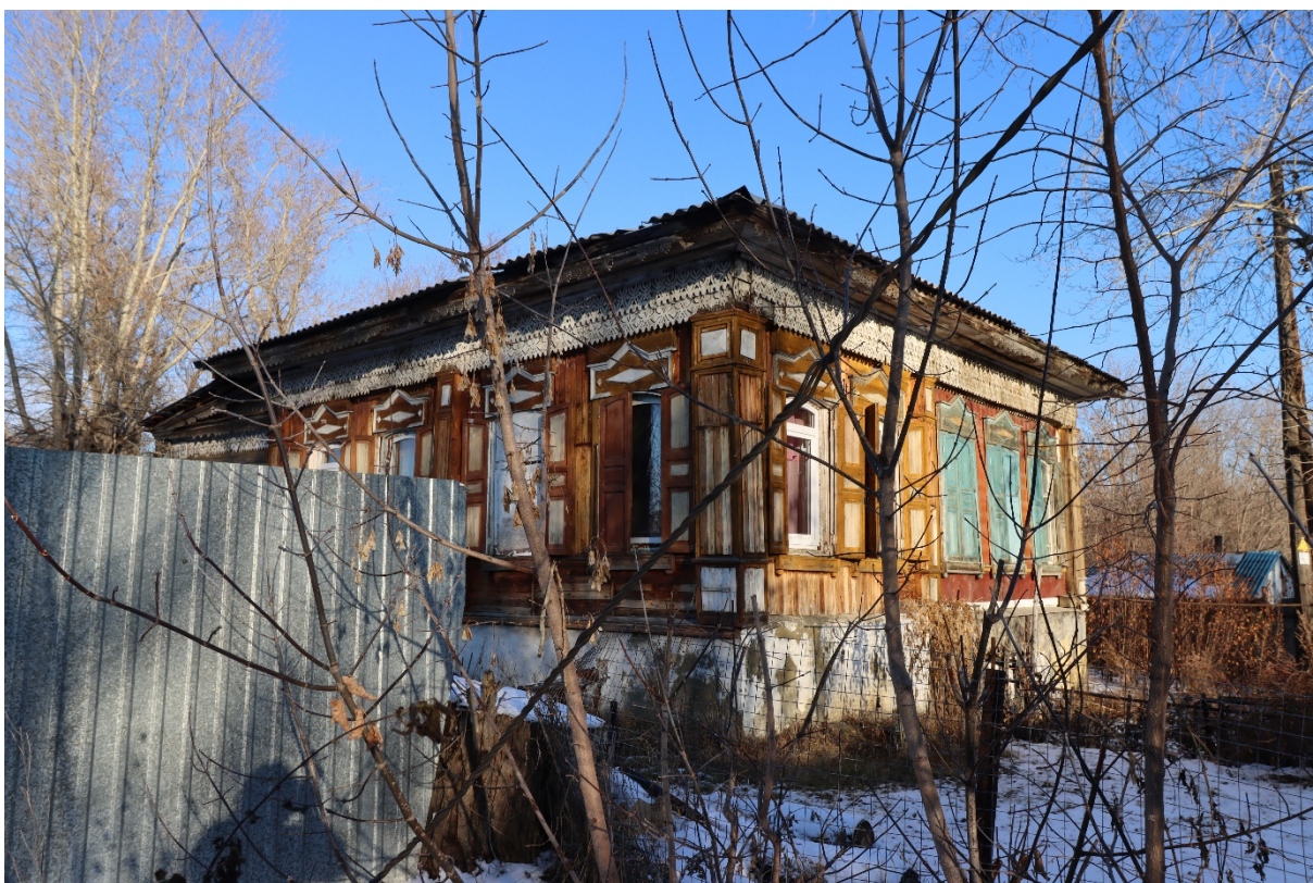
Фото.1 Выявленный объект культурного наследия «Жилой дом заимки Маренова - радиостанции РВ-72», расположенный по адресу: Челябинская область, г. Челябинск, ул. Волгоградская, 25 б. Западный и южный фасад.
