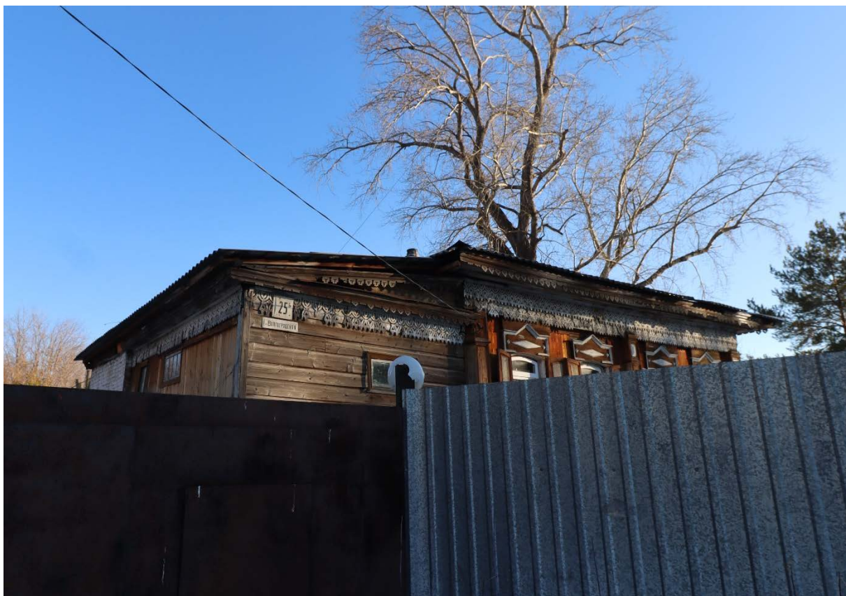
Фото.9 Выявленный объект культурного наследия «Жилой дом заимки Маренова - радиостанции РВ-72», расположенный по адресу: Челябинская область, г. Челябинск, ул. Волгоградская, 25 б. Западный и северный фасад.
