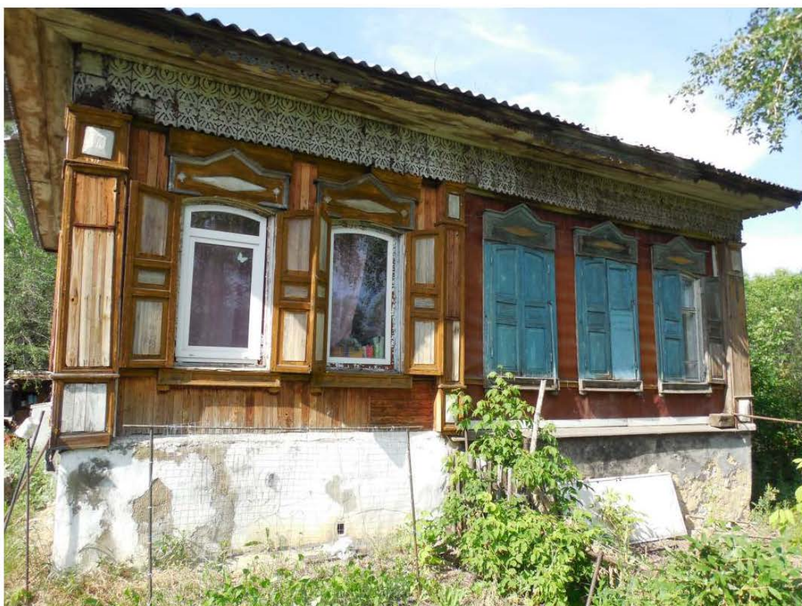
Южный фасад дома. Июнь 2022 г. Фото: В. Г. Демаков
