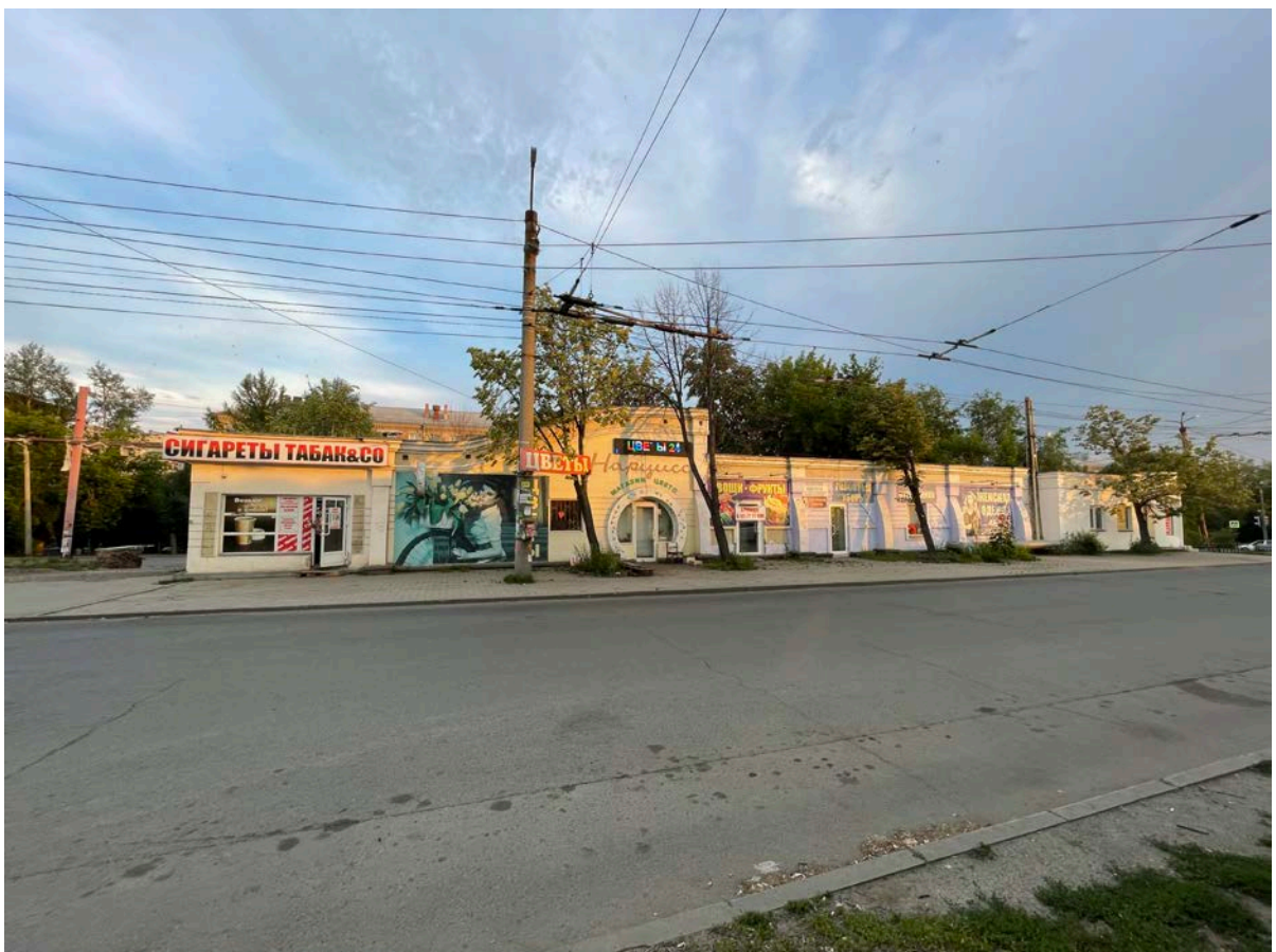
Фото 21. Градостроительная ситуация на территории исследования.
