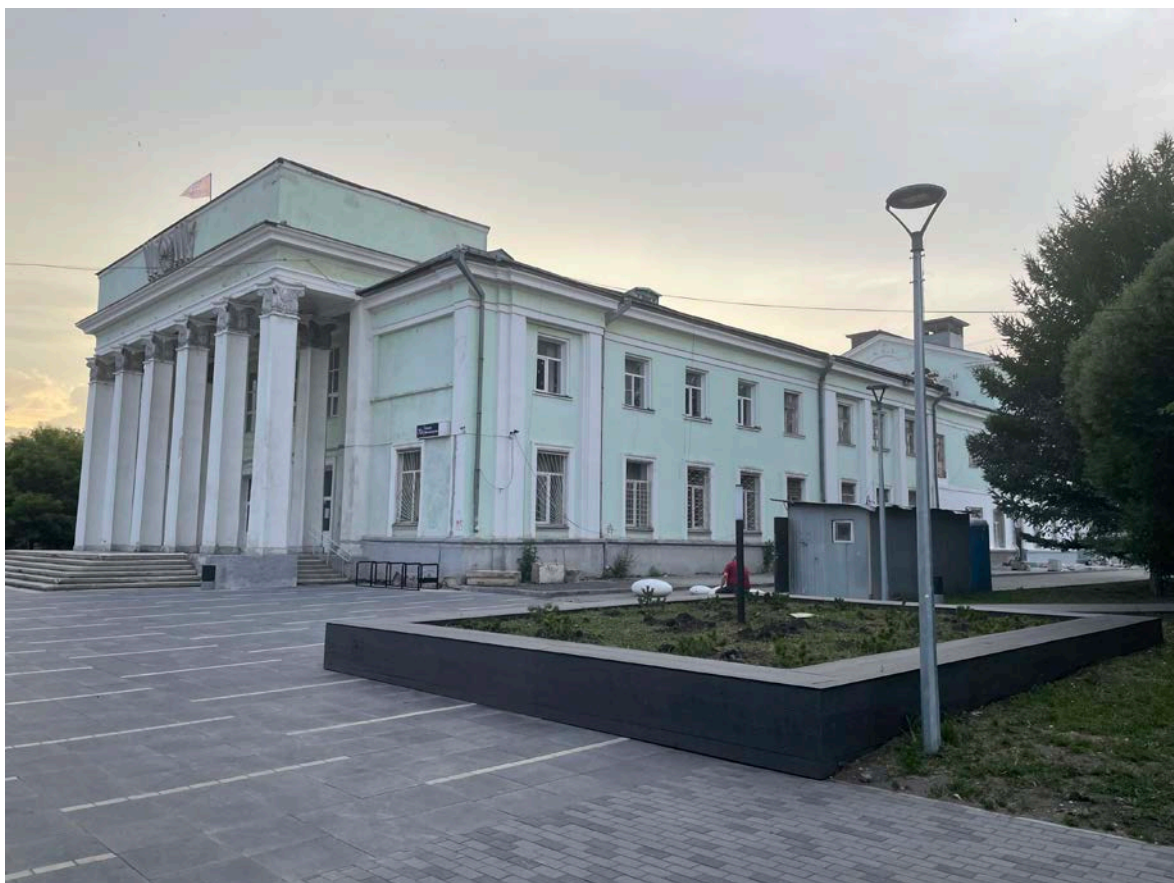
Фото 18. Видовое раскрытие объекта культурного наследия с ЮВ. Шаг 1.
