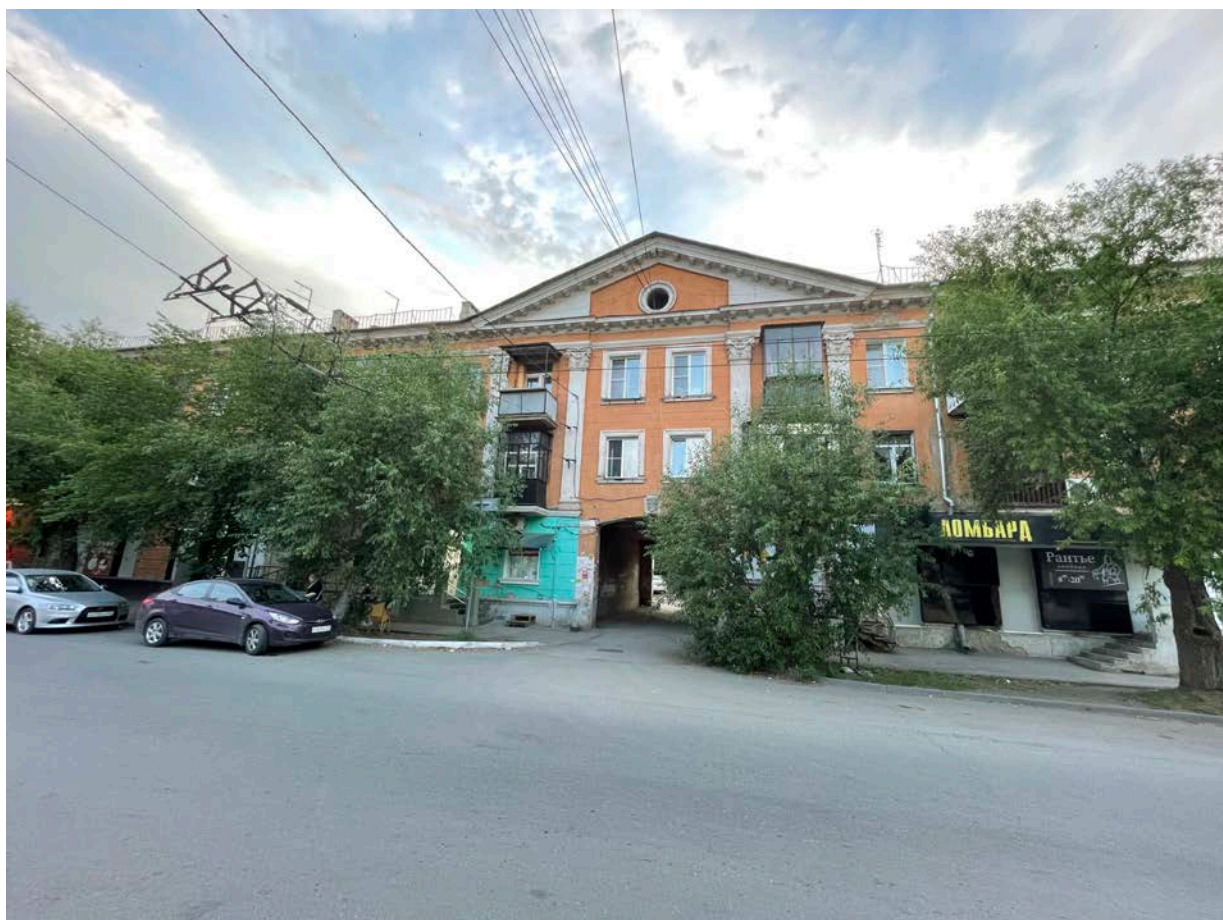
Фото 25. Градостроительная ситуация на территории исследования.
