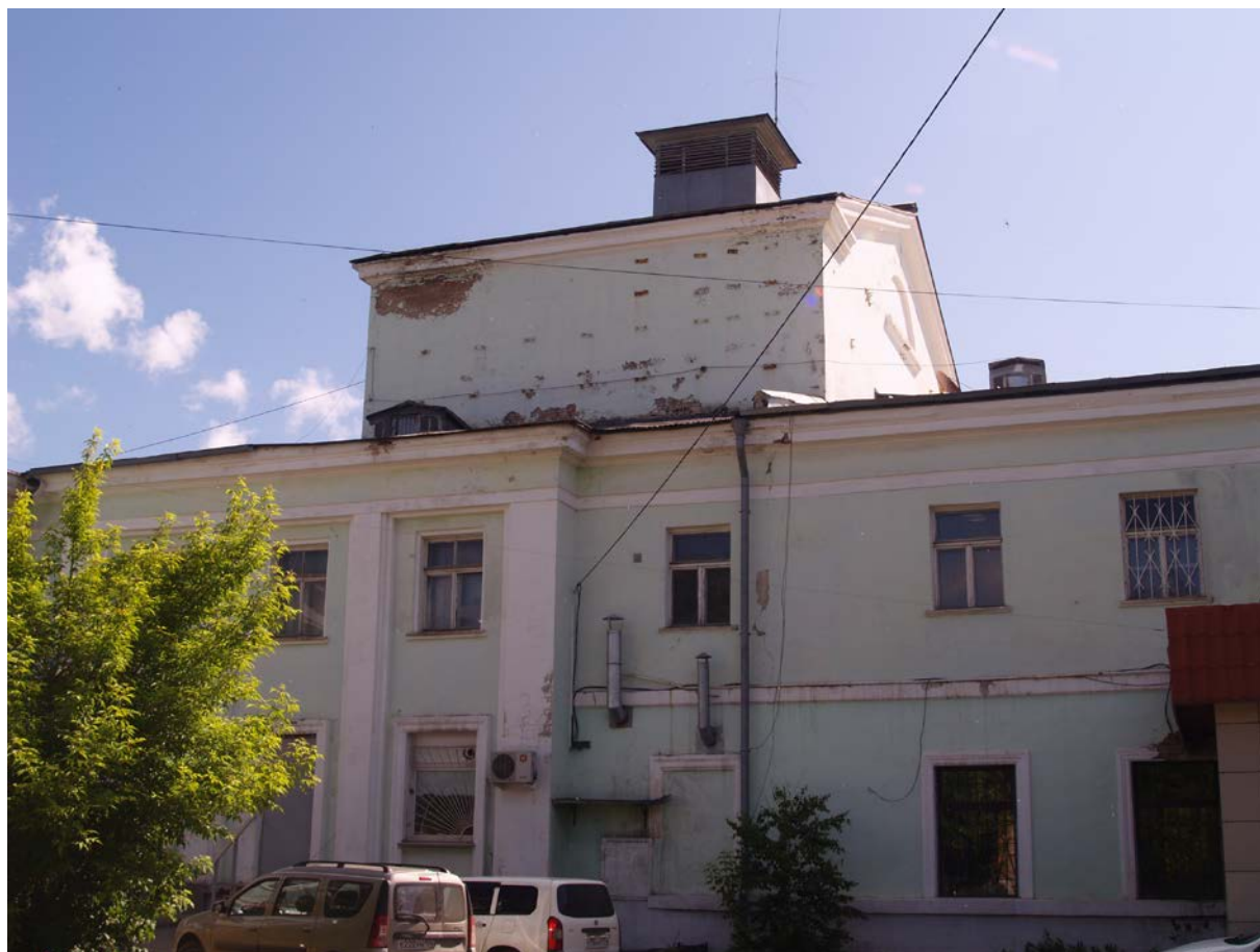
Фото 5. Объект культурного наследия. Общий вид с З.
