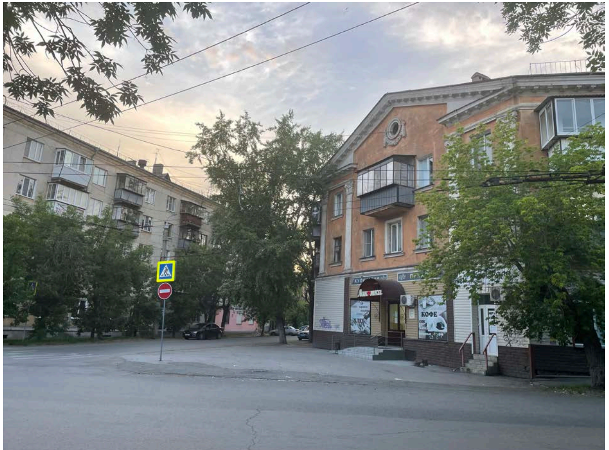
Фото 27. Градостроительная ситуация на территории исследования.
