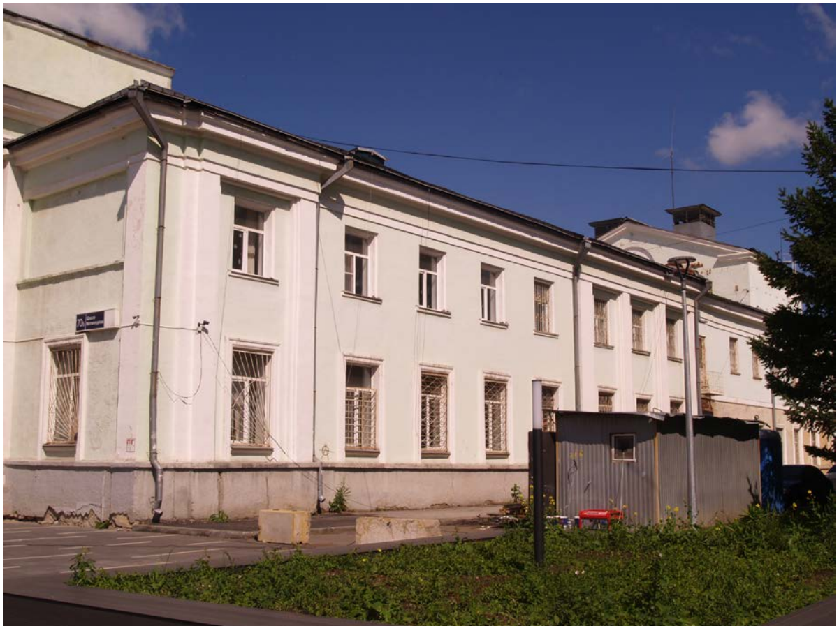
Фото 17. Видовое раскрытие объекта культурного наследия с ЮВ. Шаг 1.
