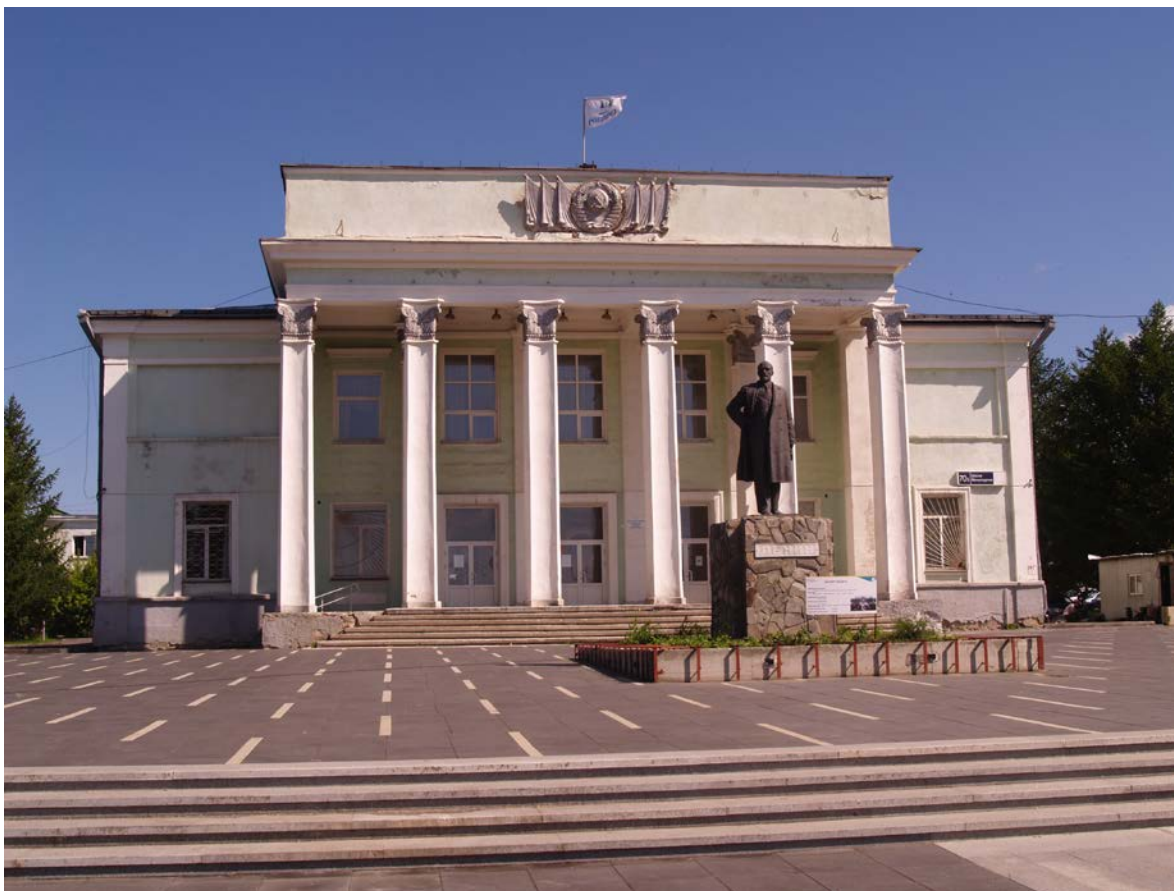
Фото 1. Объект культурного наследия. Общий вид с Ю.
