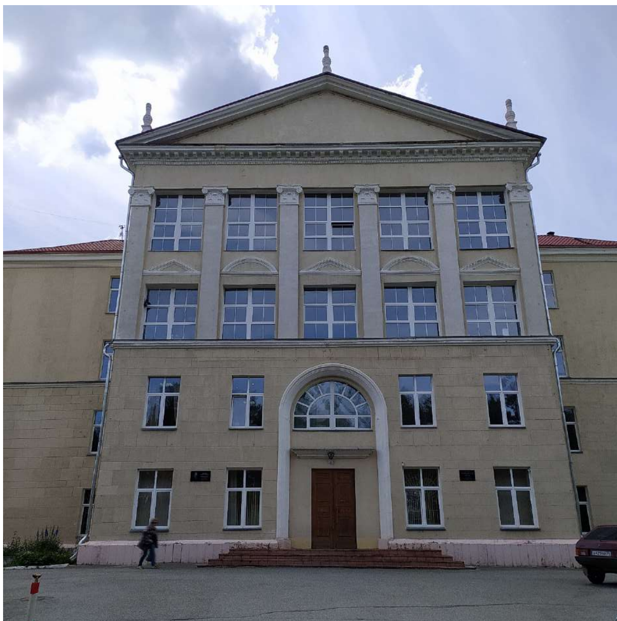
Рис. 3. Центральный ризалит. Вид северо-востока.
