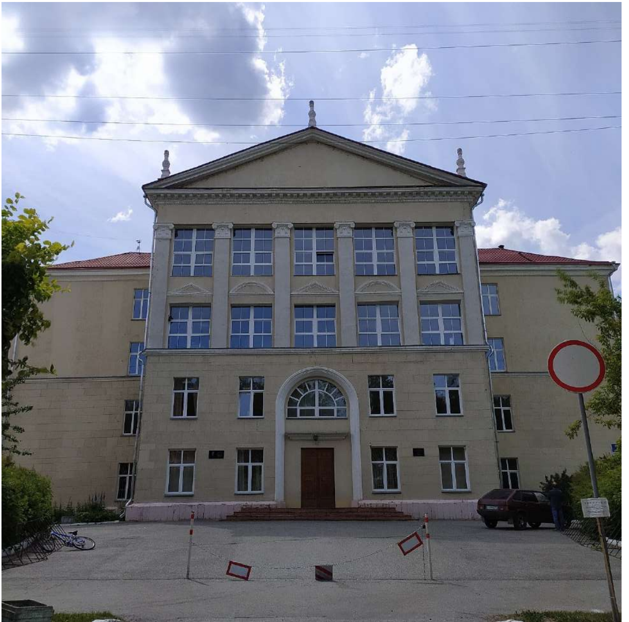
Рис. 2. Главный фасад. Вид северо-востока.
