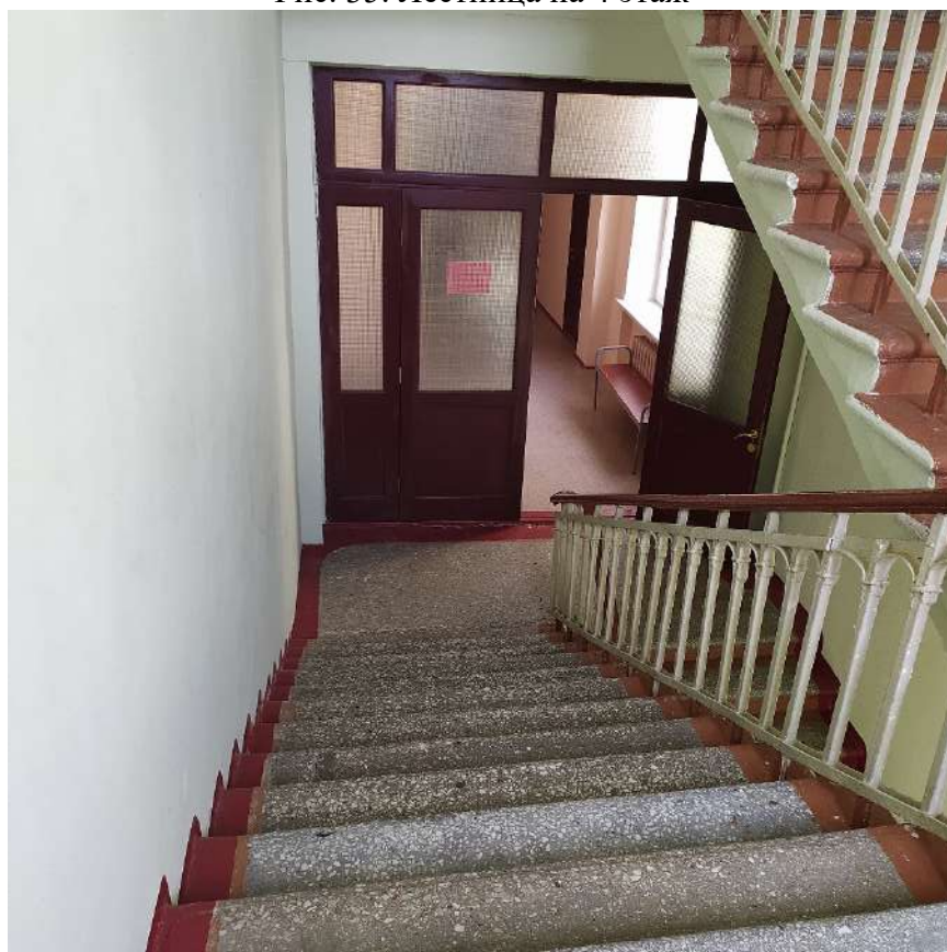
Рис. 36. Лестница на 3 этаж
