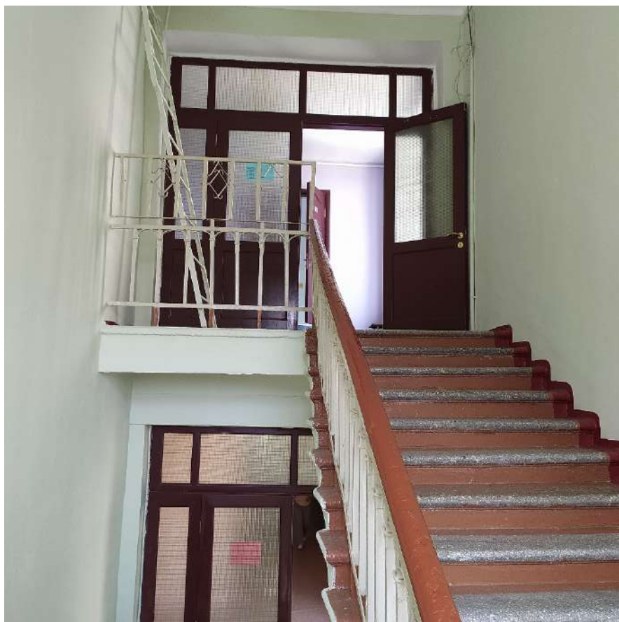
Рис. 35. Лестница на 4 этаж
