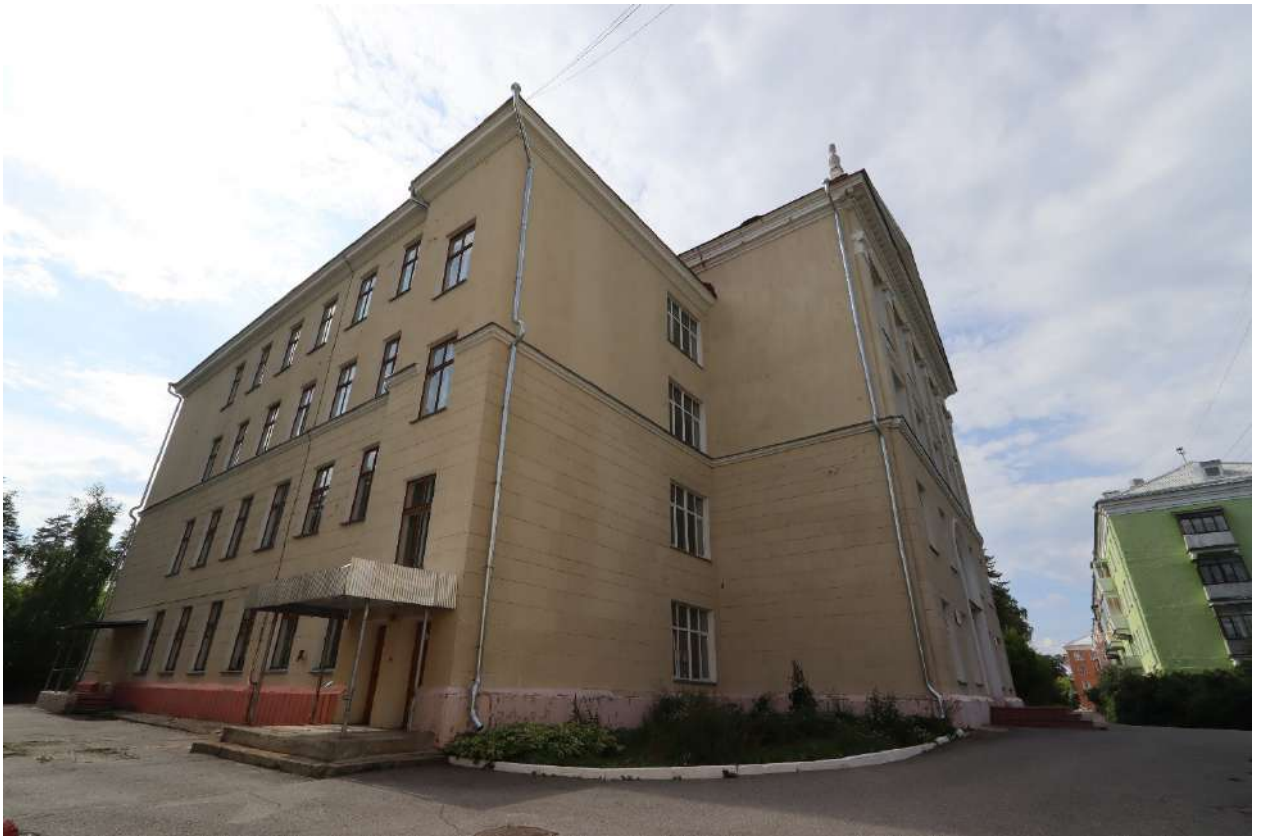
Рис. 9. Боковые фасады центрального и южного бокового ризалитов, южного крыла. Главный фасад основного объема здания. Вид юго-востока.
