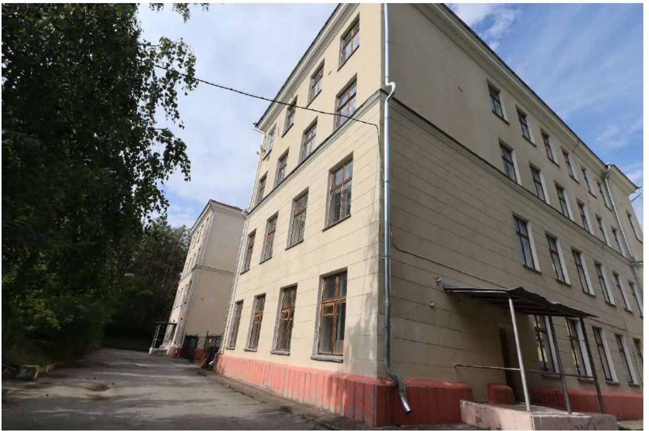
Рис. 11. Боковой (южный) фасады южного крыла и дворовые (западные) фасады южного и северного крыльев. Вид юго-запада.
