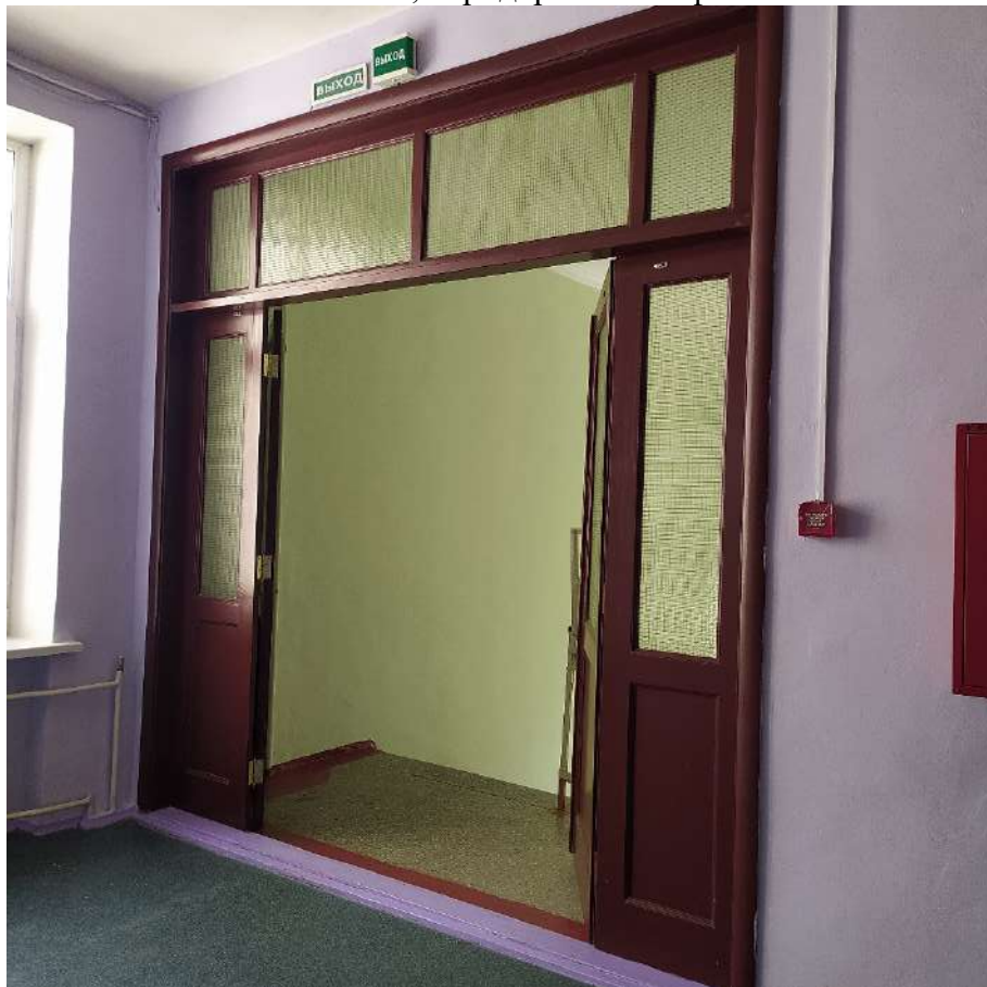
Рис. 30. 4 этаж, выход на лестничную клетку
