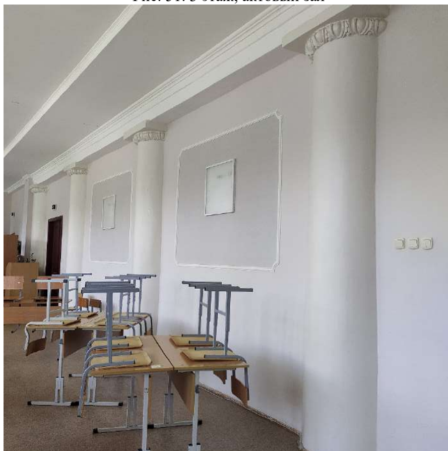
Рис. 52. 3 этаж, актовый зал, колоннада
