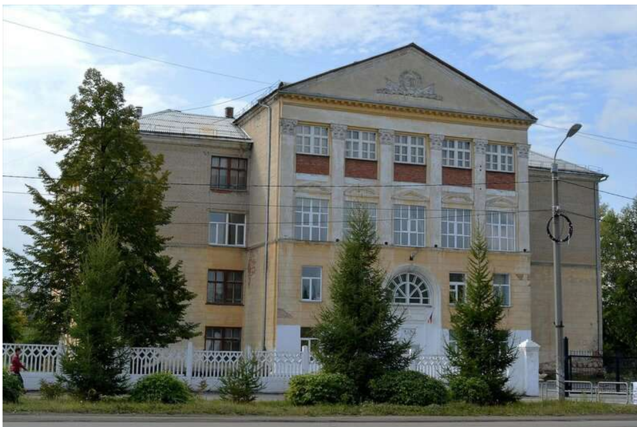
Рис. 107. Бывшее здание школы № 99, в настоящее время – Metallургический центр детского творчества г. Челябинска (ул. Коммунистическая, 7)
