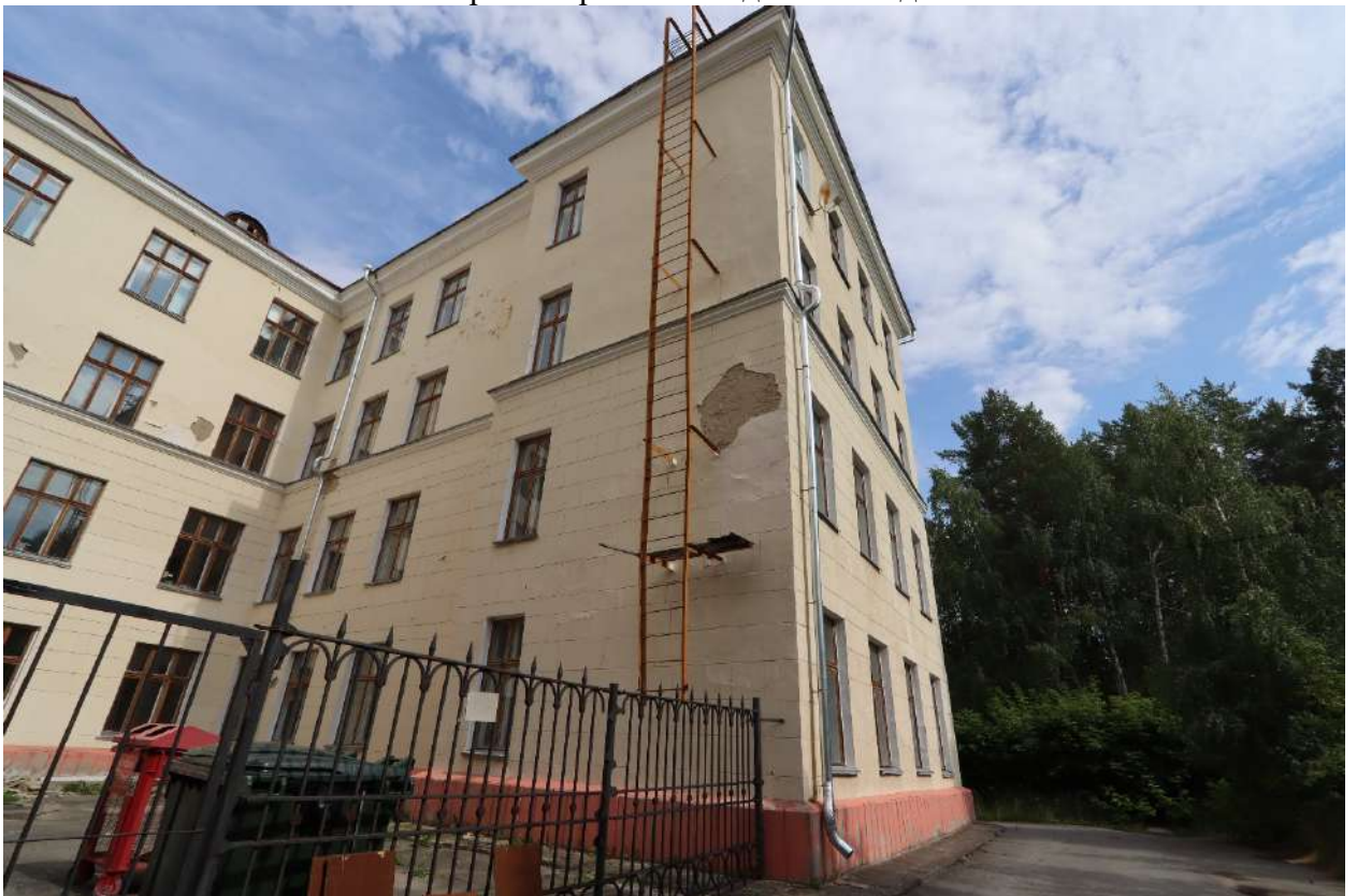
Рис. 12. Боковой (северный) и дворовый (западный) фасады южного крыла. Вид запада.
