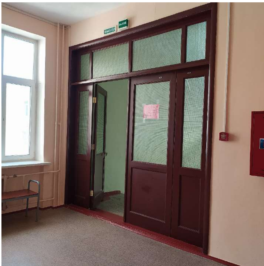
Рис. 37. 3 этаж, выход на лестничную клетку
