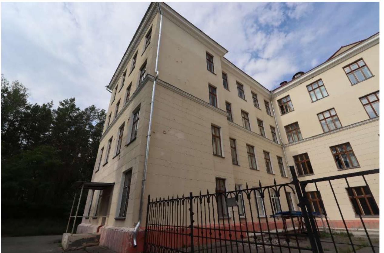
Рис. 14. Дворовые (западный) фасад основного объема здания, южный и западный фасады северного крыла. Вид запада.
