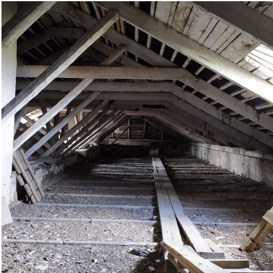
Рис. 18. Кровля здания бокового крыла.
