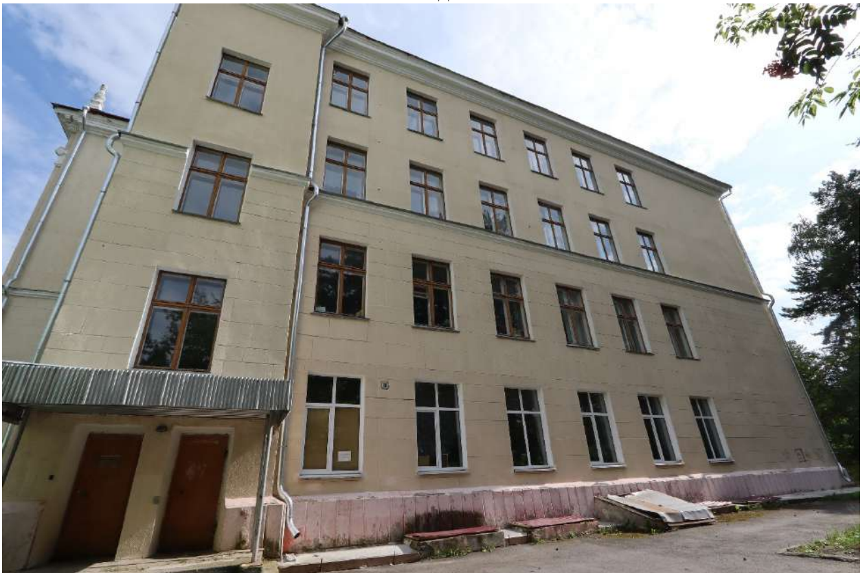
Рис. 16. Боковой (северный) фасад северного крыла. Вид севера.
