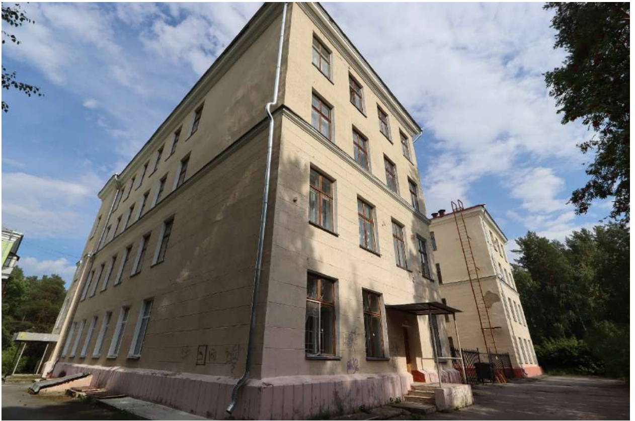
Рис. 15. Дворовый (западный) и боковой (северный) фасады северного крыла. Вид северо-запада.
