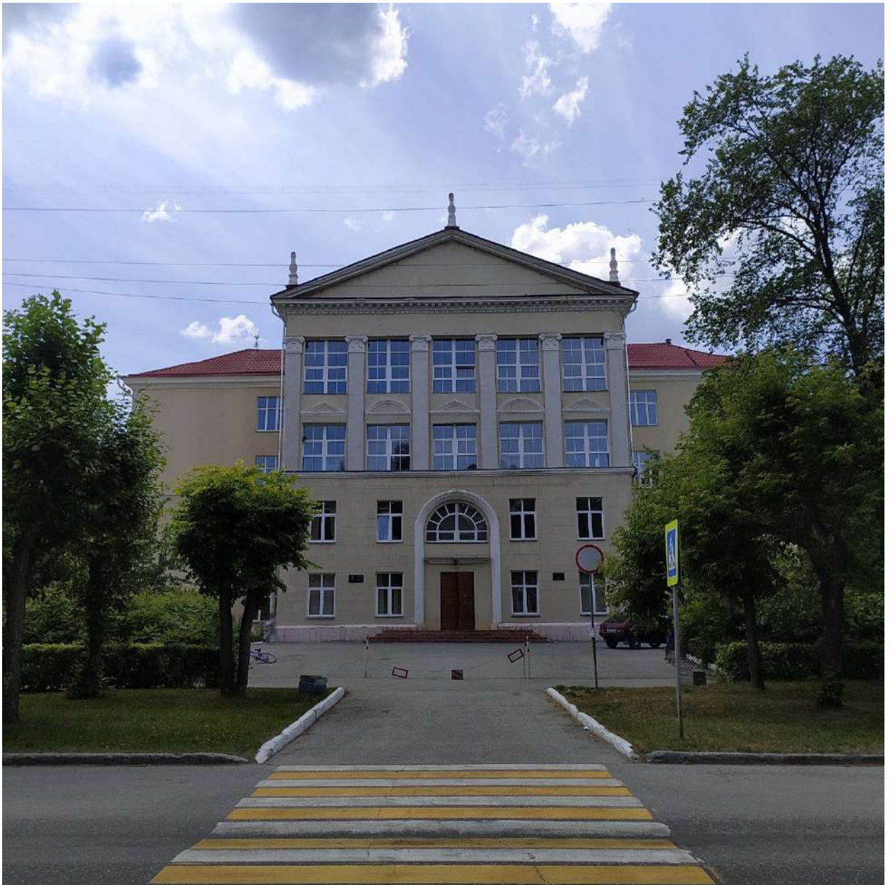
Рис. 1. Главный фасад. Вид северо-востока.
