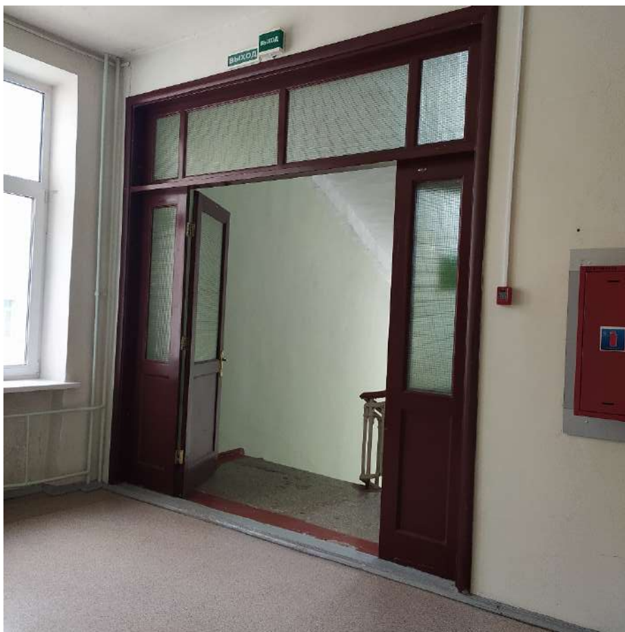
Рис. 68. 2 этаж, выход на лестничную площадку
