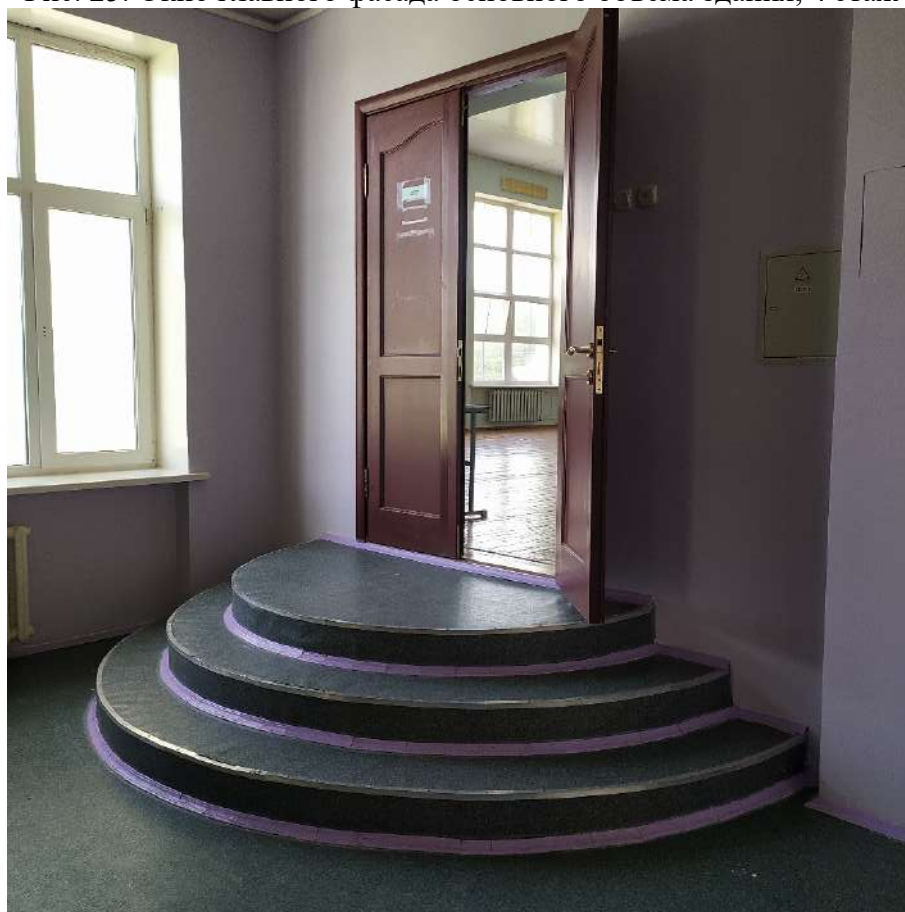
Рис. 26. 4 этаж, лестница в гимнастический зал
