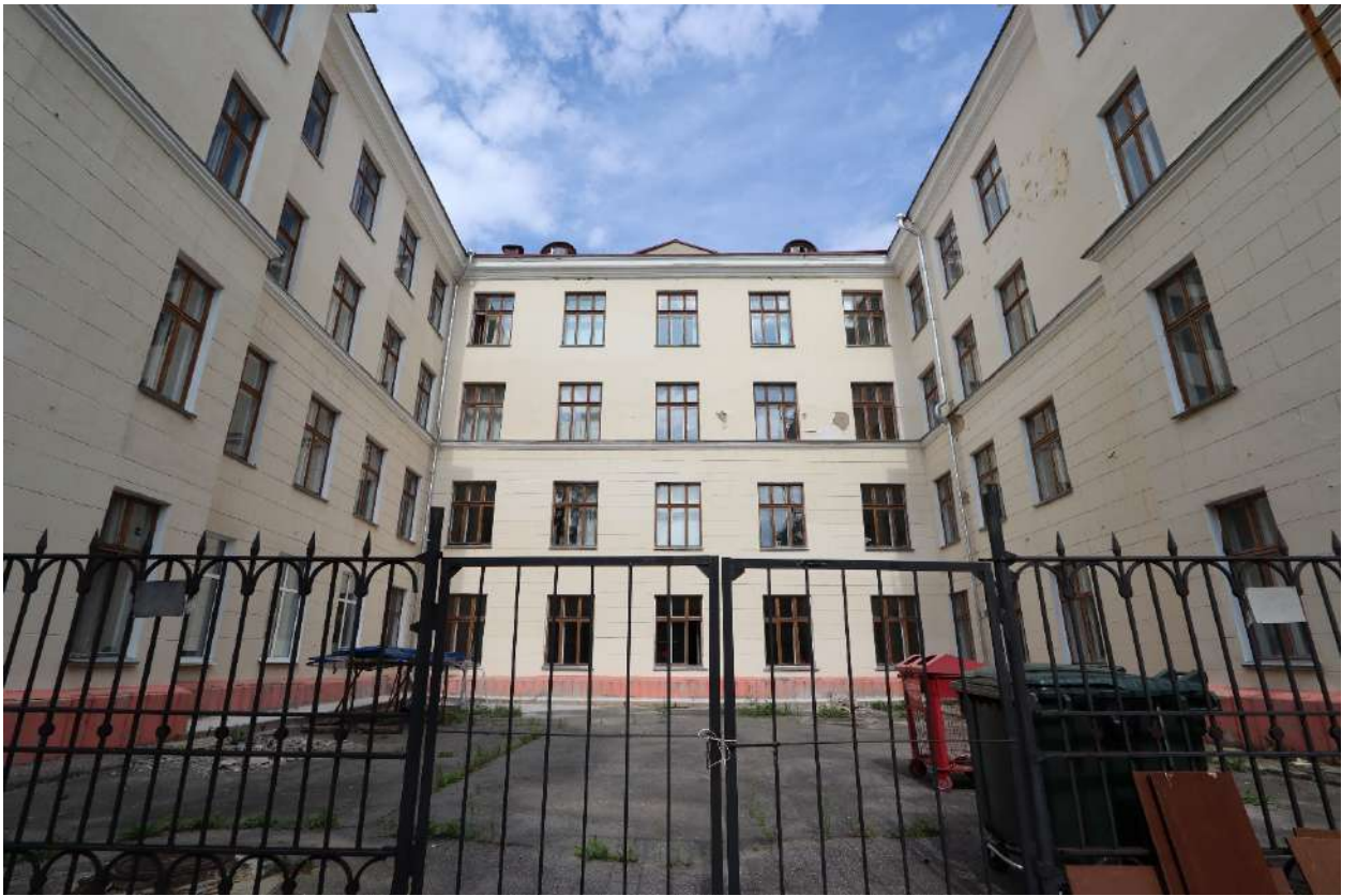
Рис. 13. Дворовые (западный) фасад основного объема здания, западный фасад южного крыла и южный фасад северного крыла. Вид запада.
