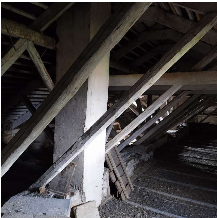
Рис. 19. Кровля здания бокового крыла.
