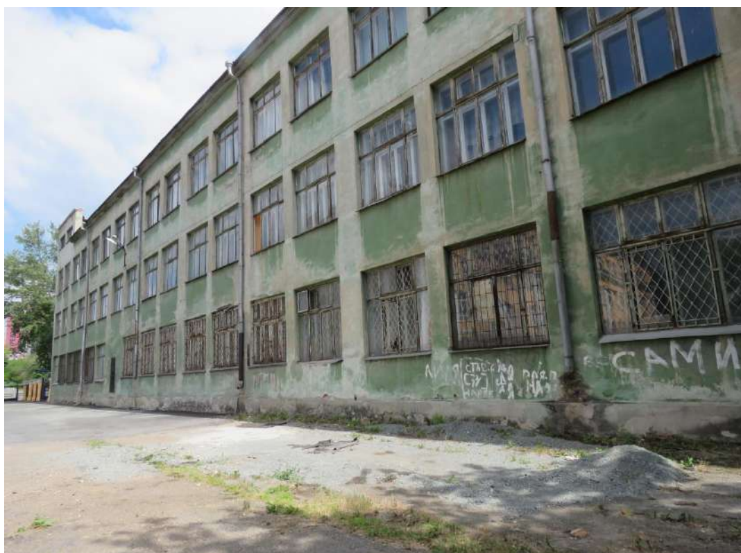
Рис. 7. Боковой западный (уличный) фасад. Вид с юго-запада
