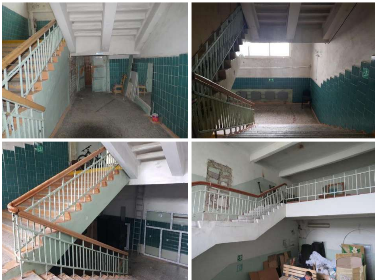
Рис. 18. Лестничные марши лестничного объема на правом (западном) фланге центрального (поперечного) корпуса
