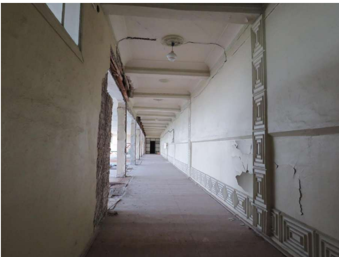
Рис. 26. Фрагмент интерьеров третьего этажа.
