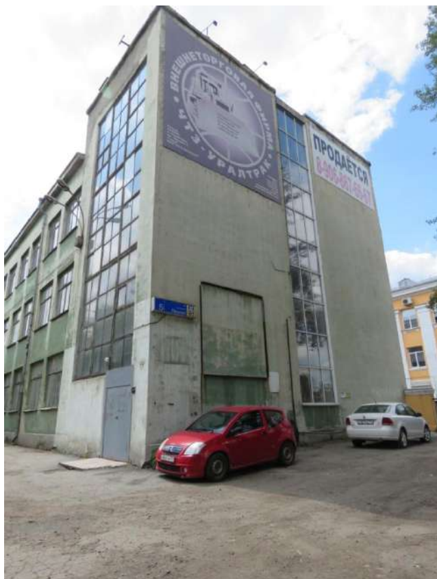
Рис. 11. Торцевой (северный) фасад западного бокового крыла
