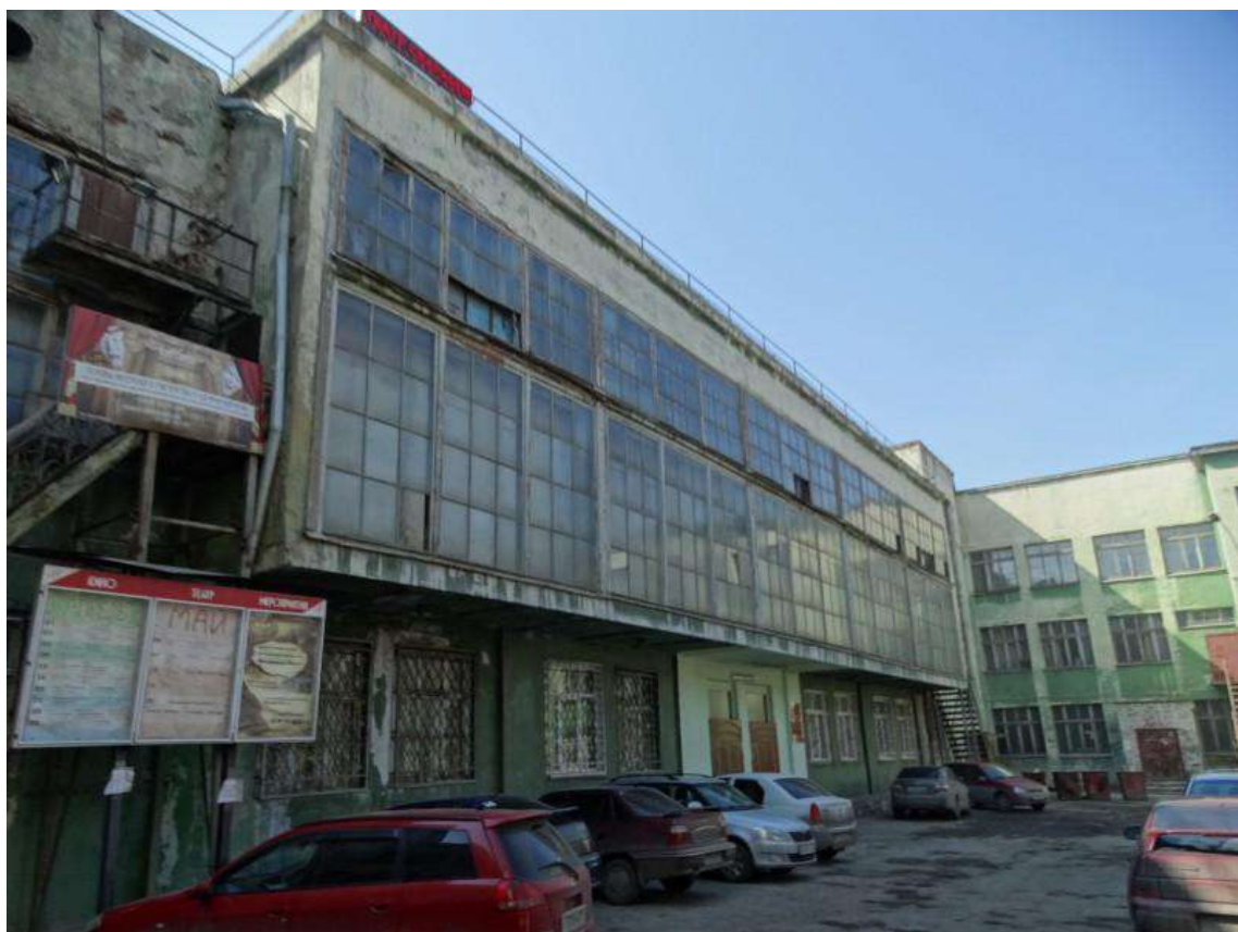
Рис. 35. Выявленный объект культурного наследия «Кинотеатр Кировец», расположенный по адресу г. Челябинск, пр. Ленина, 5. Фото Ю.В. Латышева, 2017
