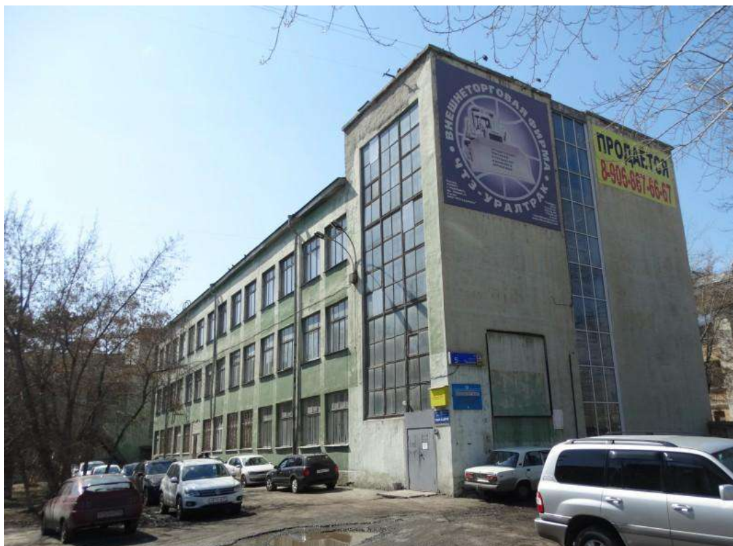
Рис. 36. Выявленный объект культурного наследия «Кинотеатр Кировец», расположенный по адресу г. Челябинск, пр. Ленина, 5. Фото Ю.В. Латышева, 2017
