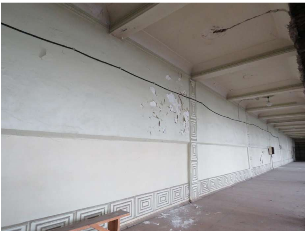
Рис. 25. Фрагмент интерьеров третьего этажа.
