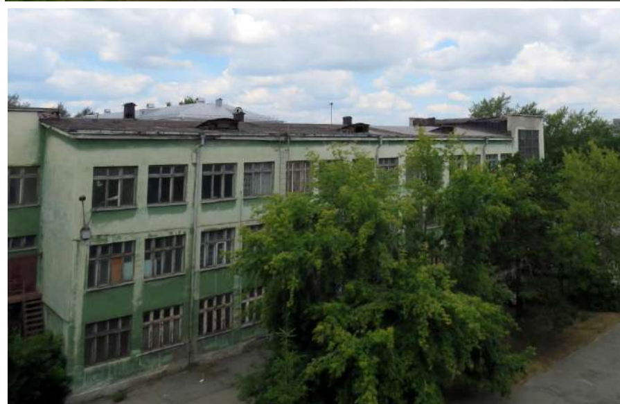
Рис. 17. Скатная кровля центрального (поперечного) корпуса и боковых крыльев.
