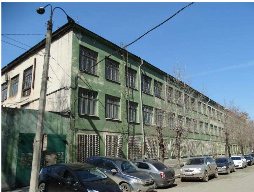
Рис. 37. Выявленный объект культурного наследия «Кинотеатр Кировец», расположенный по адресу г. Челябинск, пр. Ленина, 5. Фото Ю.В. Латышева, 2017
