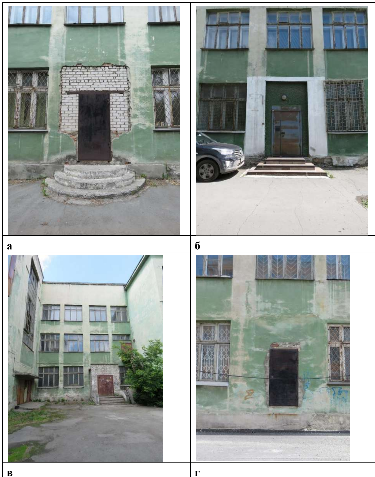
Рис. 16. Поздние входные проемы, пробитые на месте оконных проемов: а. фасад западного бокового крыла со стороны курдоенра; б. фасад восточного бокового крыла со стороны курдоенра; в. правый фланг западного бокового крыла со стороны курдонера; г. боковой западный (уличный) фасад.
