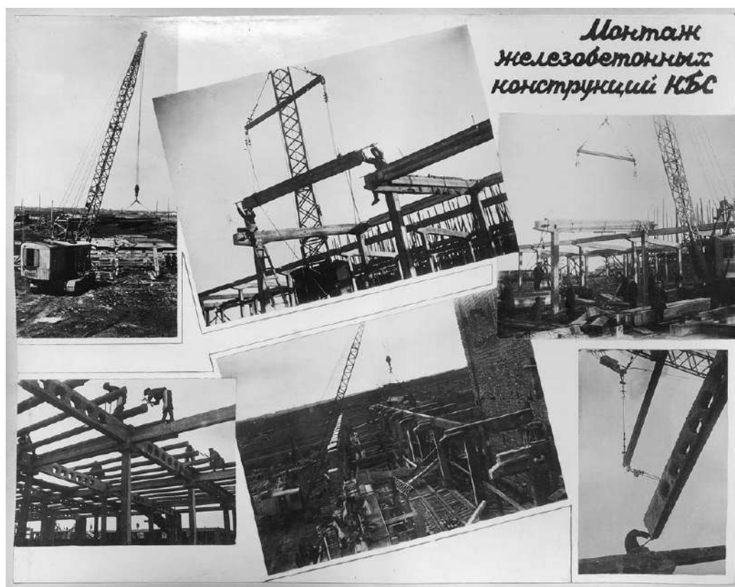
Рис. 23. Соцгород Челябинского тракторного завода. Монтаж железобетонных конструкций КБС. Фото начала 1930-х гг. Источник: ОГАЧО. Ф. 379. Оп. 2. Ед. хр. 63. Фотоальбом «ЧТЗ».
