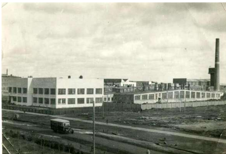
Рис. 19. Соцгород Челябинского тракторного завода. Фабрика-кухня. Фото начала 1930-х гг. Источник: ОГАЧО. Ф. 379. Оп. 2. Ед. хр. 63. Фотоальбом «ЧТЗ».
