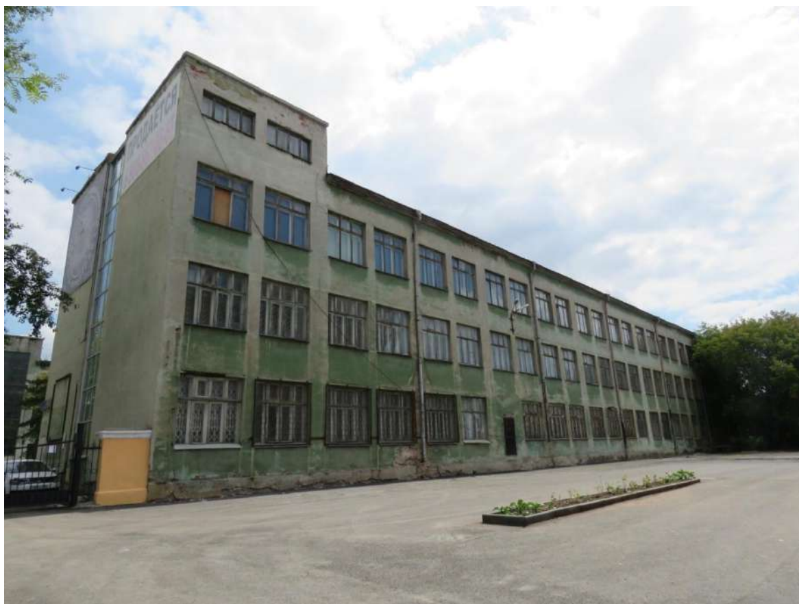
Рис. 6. Боковой западный (уличный) фасад. Вид с северо-запада
