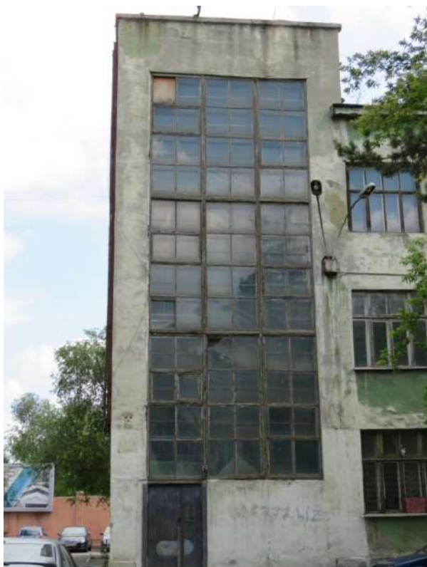
Рис. 9. Левый (северный) фланг фасада восточного бокового крыла со стороны курдонера. Объем лестничной клетки с витражным остеклением
