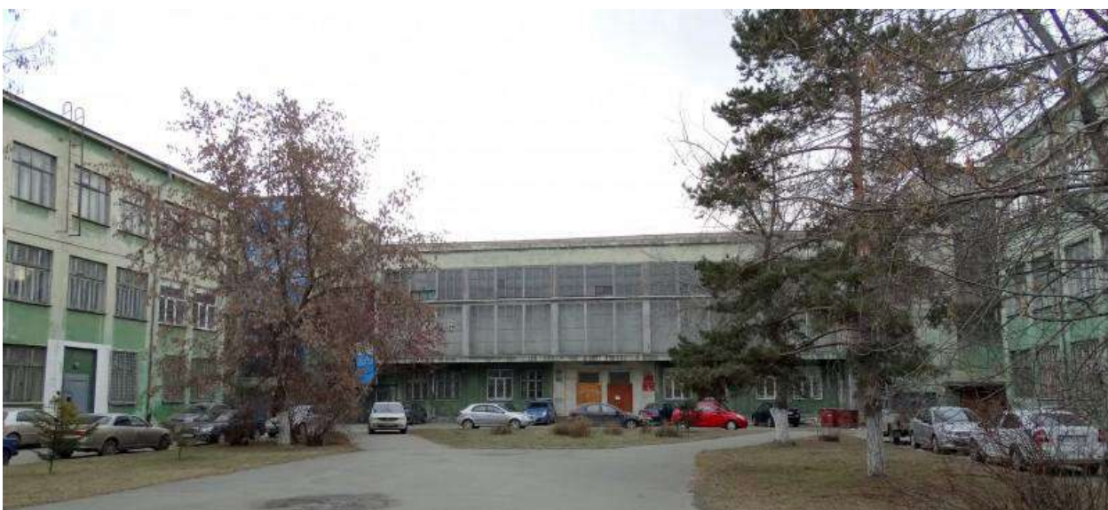
Рис. 33. Выявленный объект культурного наследия «Кинотеатр Кировец», расположенный по адресу г. Челябинск, пр. Ленина, 5. Фото Ю.В. Латышева, 2017
