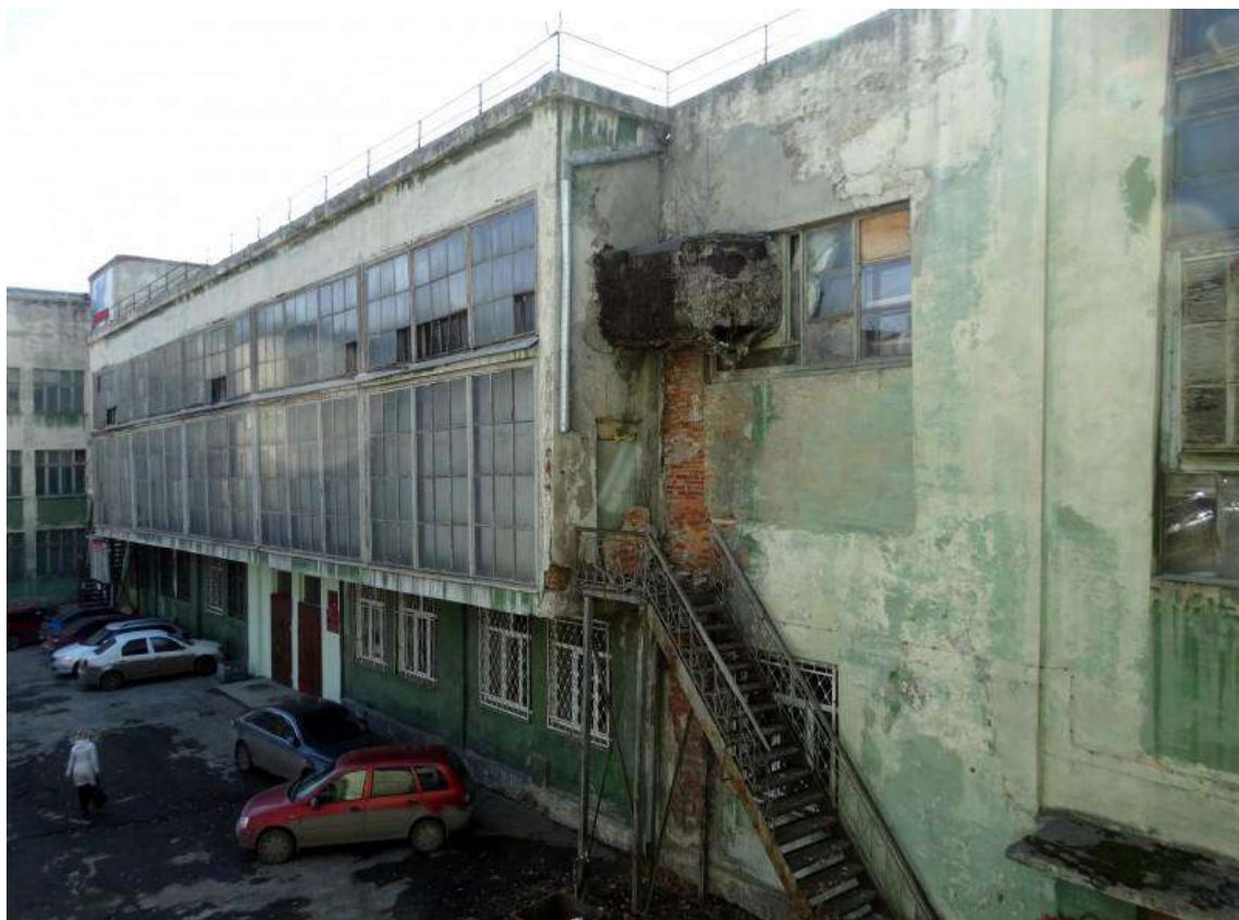
Рис. 34. Выявленный объект культурного наследия «Кинотеатр Кировец», расположенный по адресу г. Челябинск, пр. Ленина, 5. Фото Ю.В. Латышева, 2017
