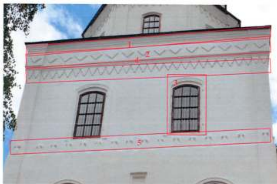
Фрагмент вида на северный фасад церкви
