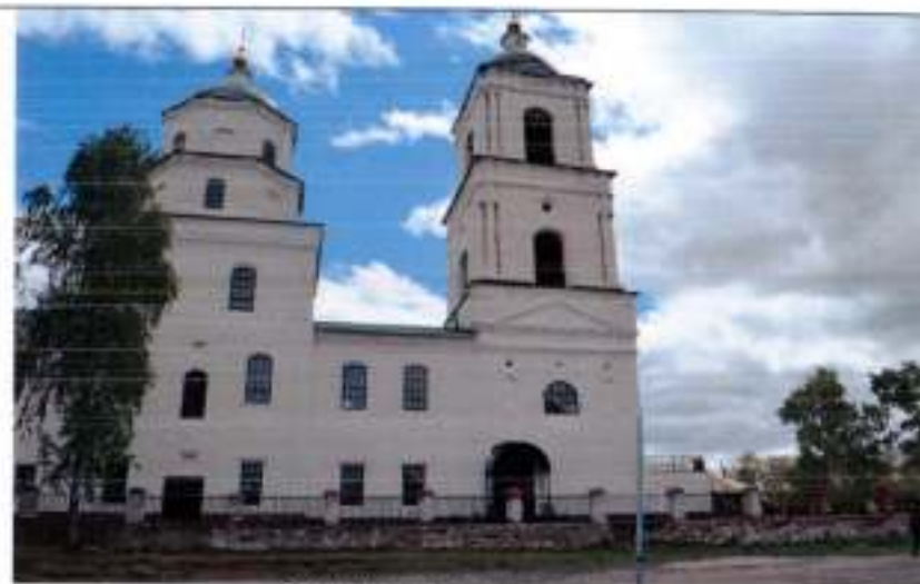
Вид на колокольню церкви, с севера
