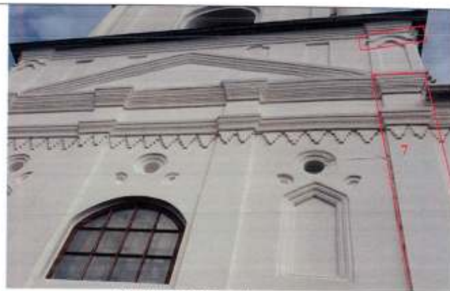
Фрагмент вида на кованный фасад церкви с юга.
