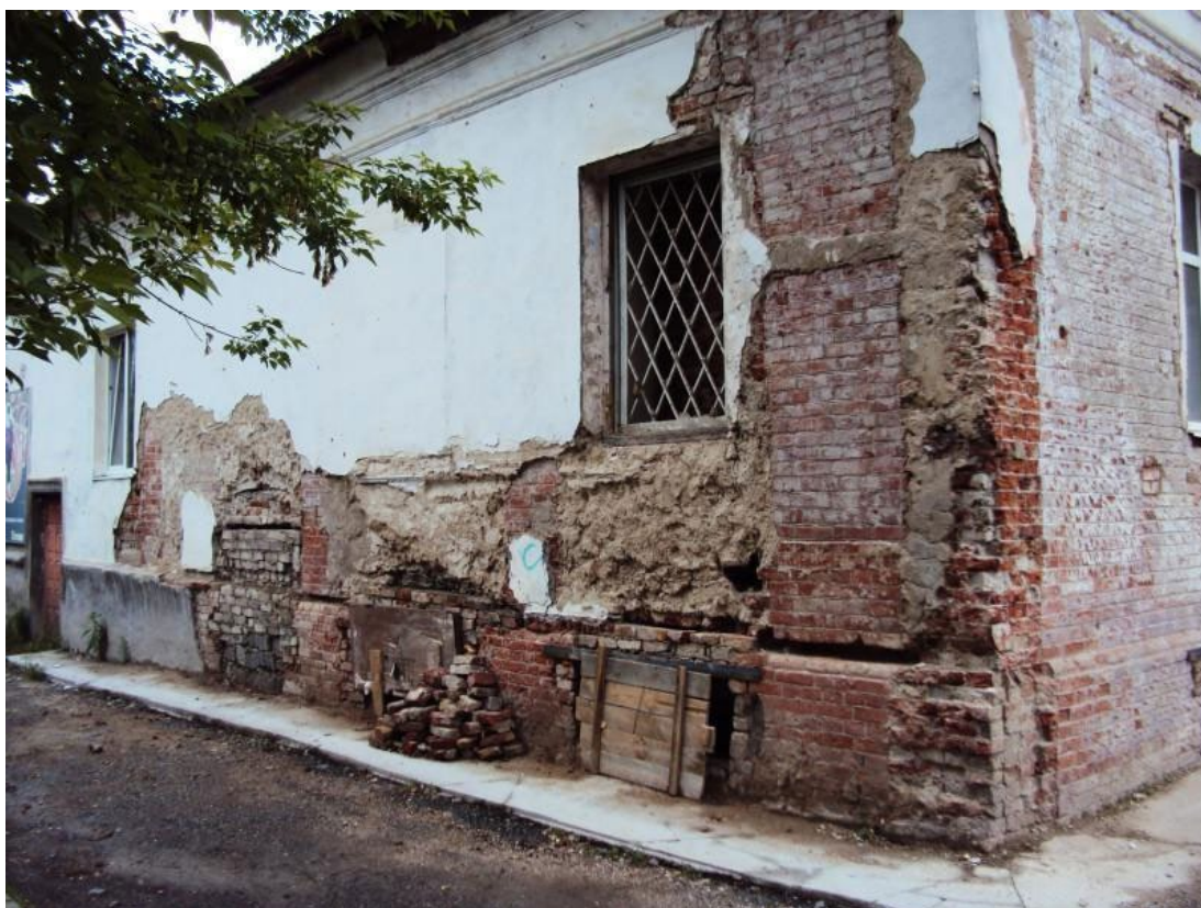
Рис.6. Историческая фотография объекта, 2009 г.
