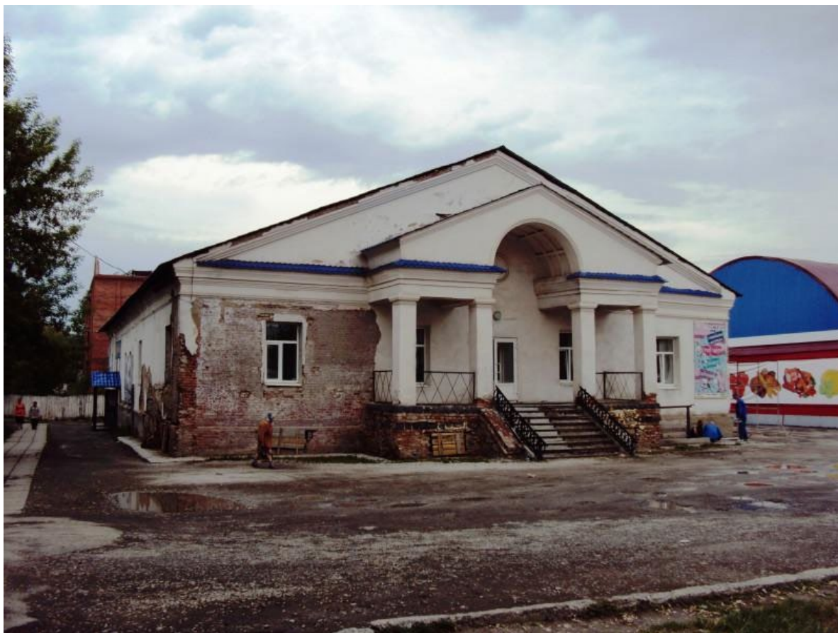
Рис.5. Историческая фотография объекта, 2009 г.
