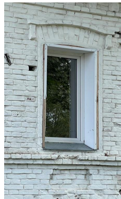
Оконный проем северо-западного фасада с бровкой, подоконной полочкой и нишей
