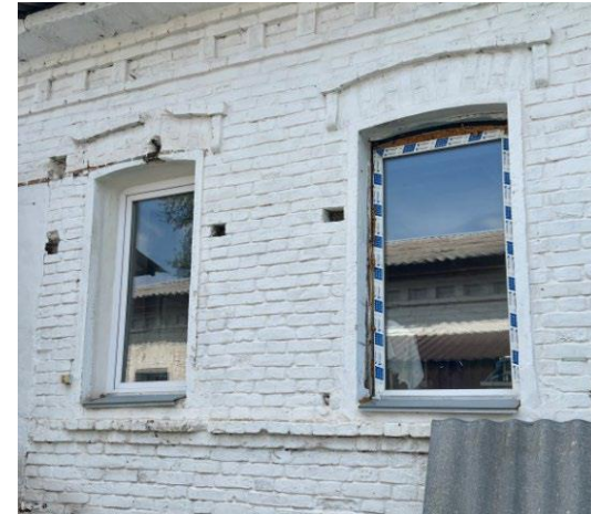
Оформление оконных проемов северо-восточного фасада
