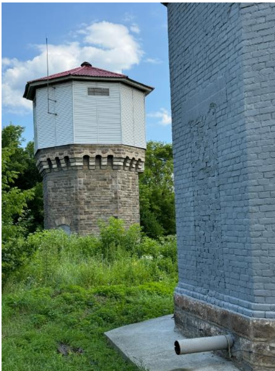
Фото 3. Вид на выявленный объект культурного наследия «Водонапорная башня-1», расположенный по адресу: Челябинская область, Миасский городской округ, г. Миасс, ж/д ст. Миасс-1.
