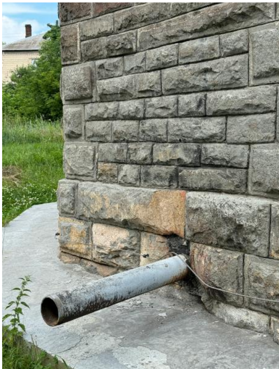
Фото 11. Вид на выявленный объект культурного наследия «Водонапорная башня-1», расположенный по адресу: Челябинская область, Миасский городской округ, г. Миасс, ж/д ст. Миасс-1.
