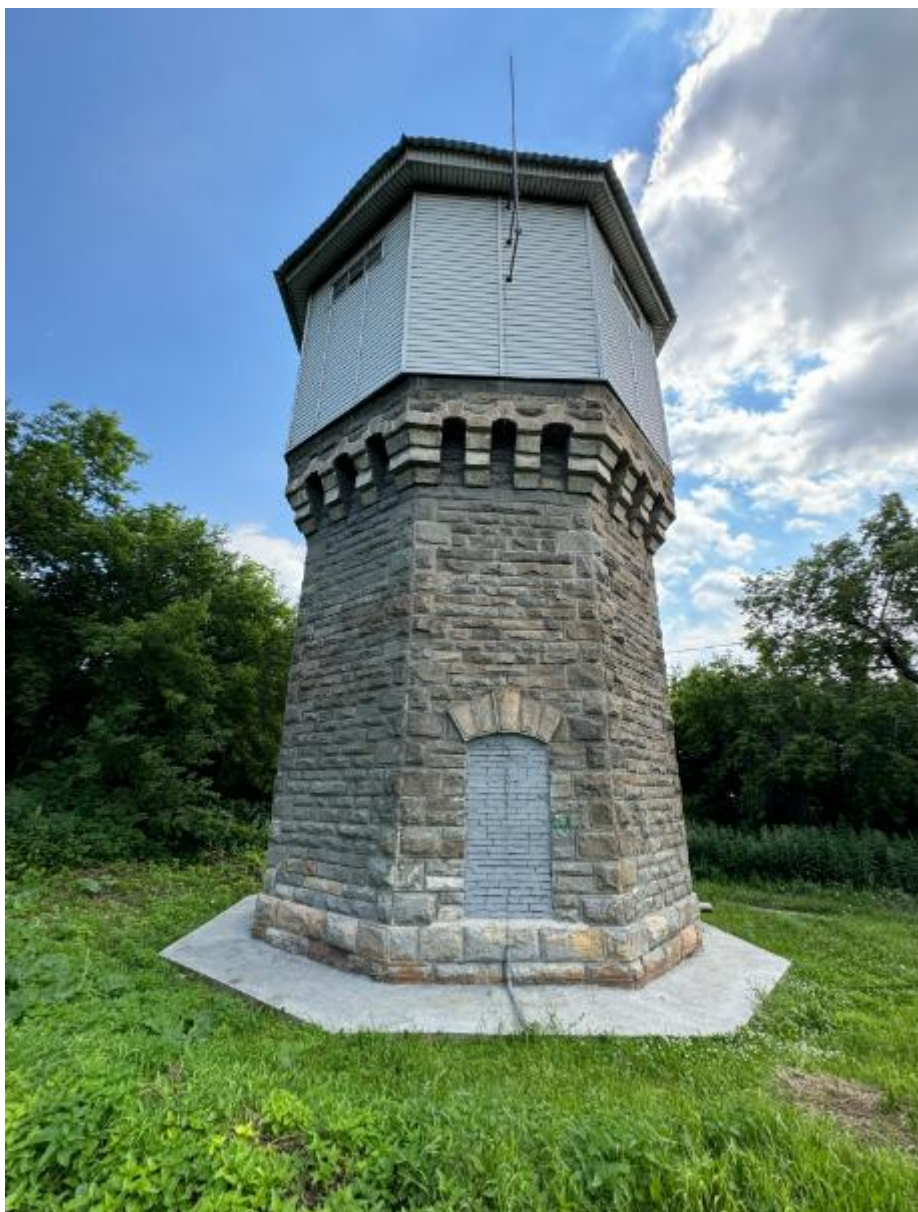
Фото 13. Вид на выявленный объект культурного наследия «Водонапорная башня-1», расположенный по адресу: Челябинская область, Миасский городской округ, г. Миасс, ж/д ст. Миасс-1.
