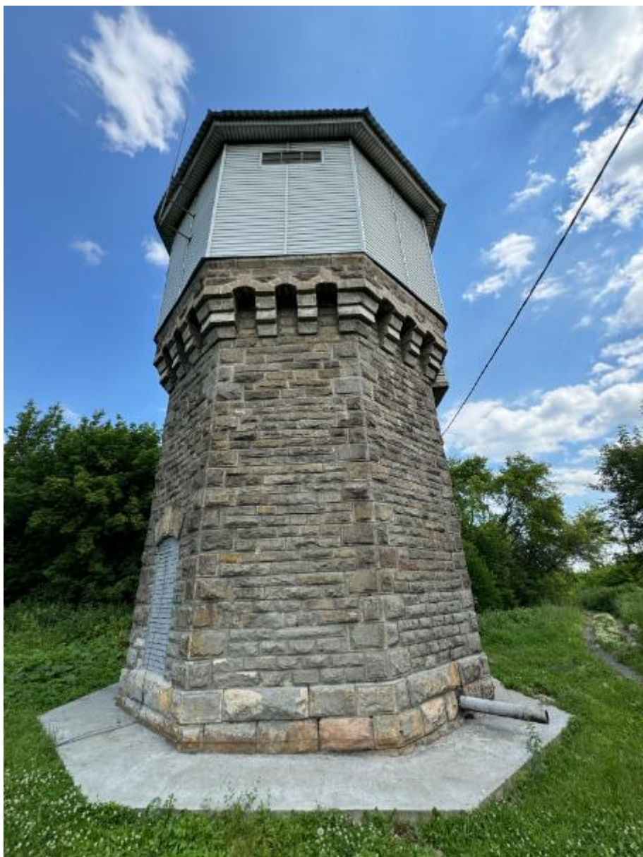
Фото 12. Вид на выявленный объект культурного наследия «Водонапорная башня-1», расположенный по адресу: Челябинская область, Миасский городской округ, г. Миасс, ж/д ст. Миасс-1.
