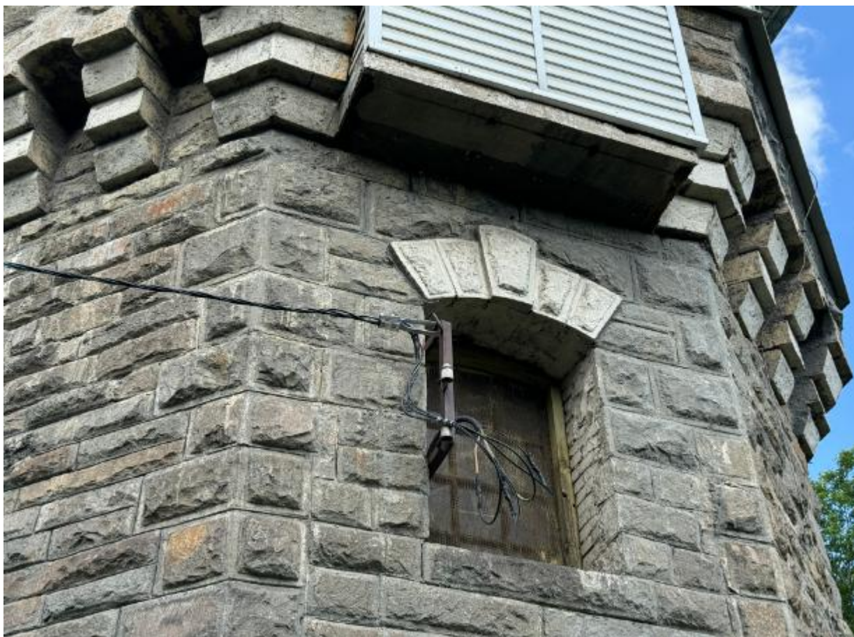
Фото 8. Вид на выявленный объект культурного наследия «Водонапорная башня-1», расположенный по адресу: Челябинская область, Миасский городской округ, г. Миасс, ж/д ст. Миасс-1.
