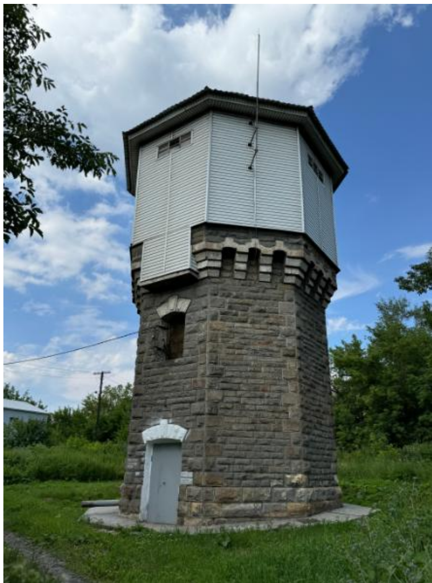
Фото 9. Вид на выявленный объект культурного наследия «Водонапорная башня-1», расположенный по адресу: Челябинская область, Миасский городской округ, г. Миасс, ж/д ст. Миасс-1.
