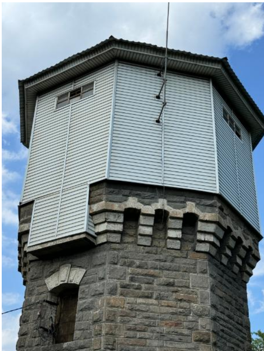
Фото 10. Вид на выявленный объект культурного наследия «Водонапорная башня-1», расположенный по адресу: Челябинская область, Миасский городской округ, г. Миасс, ж/д ст. Миасс-1.
