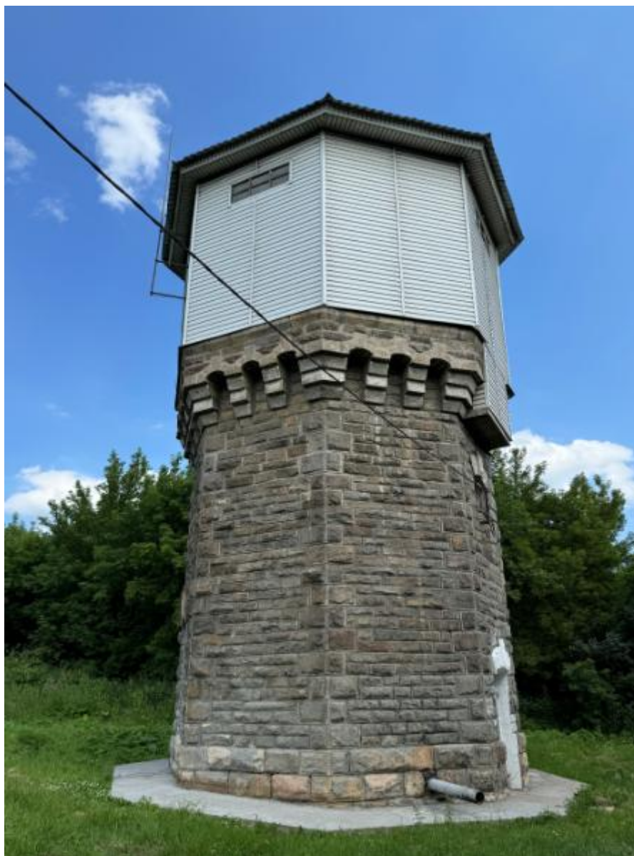
Фото 4. Вид на выявленный объект культурного наследия «Водонапорная башня-1», расположенный по адресу: Челябинская область, Миасский городской округ, г. Миасс, ж/д ст. Миасс-1.
