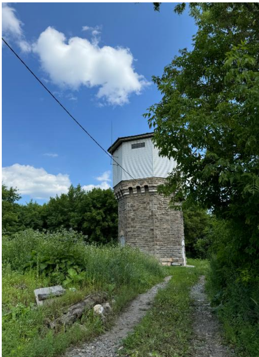
Фото 1. Вид на выявленный объект культурного наследия «Водонапорная башня-1», расположенный по адресу: Челябинская область, Миасский городской округ, г. Миасс, ж/д ст. Миасс-1.
