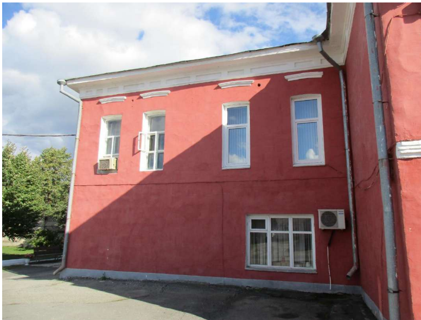
13. Дворовой фасад. Лучковые профилированные сандрики над лучковыми проемами.
