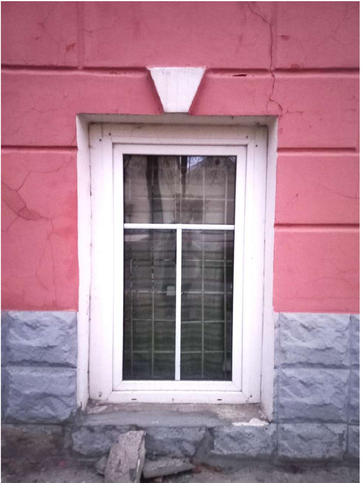
19. Главный фасад. Фрагмент. Оконный проем в уровне первого этажа. Замковый камень. Руст. Октябрь 2023 г.
