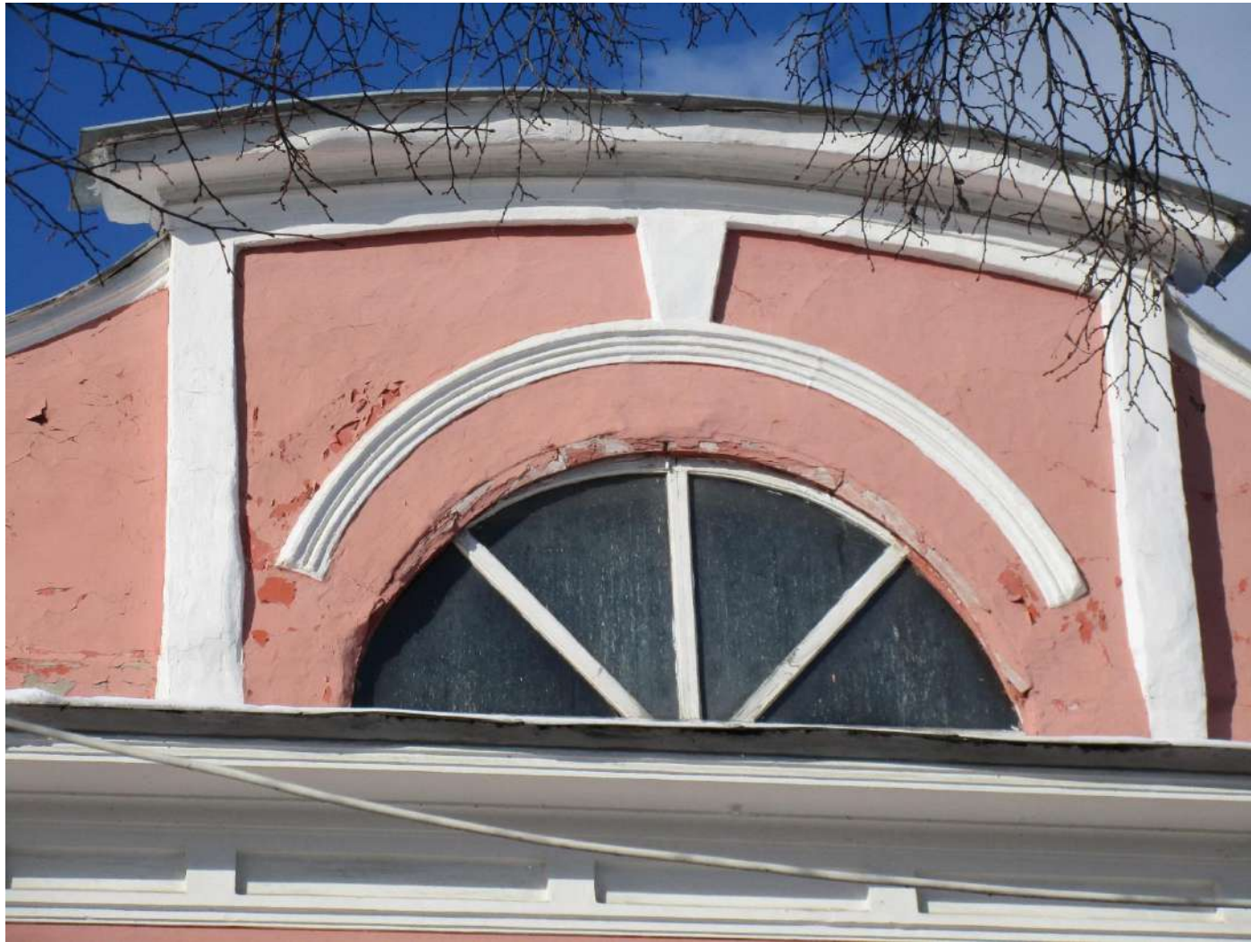
11. Центральная часть аттика. Заполнением полуциркульного проема. Профилированный архивольт под замковым камнем. Октябрь 2023 г.
