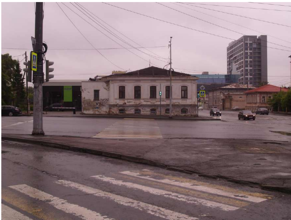
Фото 26. Градостроительная ситуация на территории исследования.
