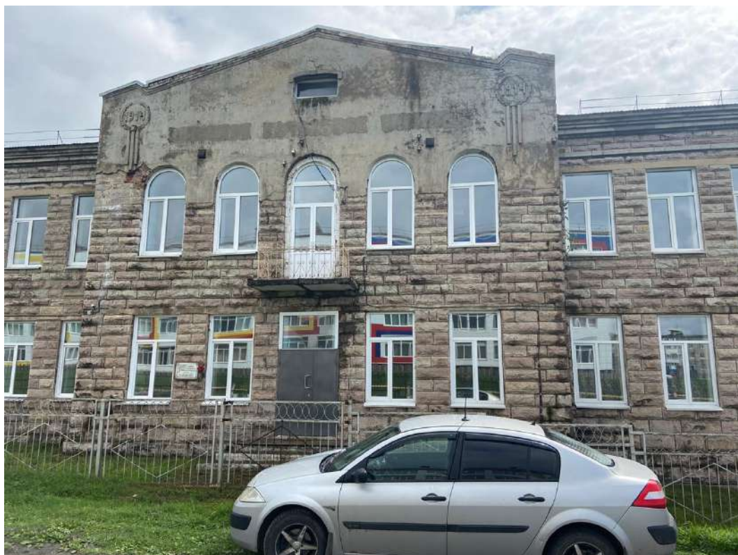
Фото 3. Фрагмент центральной части главного северного фасада. 06.07.2020г.
