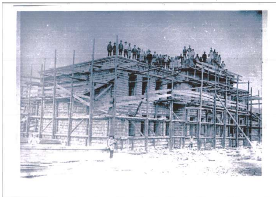
Из фонда краеведческого музея г. Катав-Ивановска. Строительство двухэтажного начального народного училища. 1913 год.
