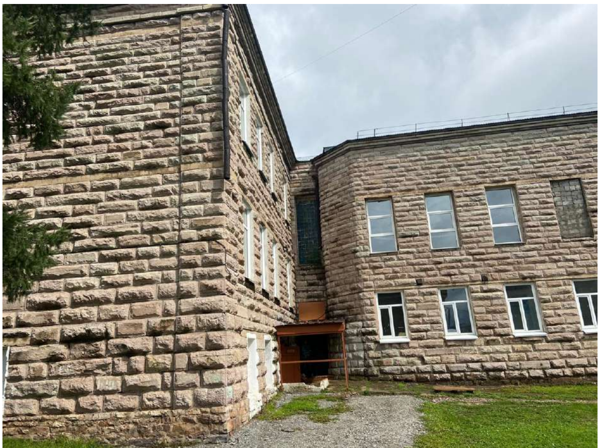
Фото 12. Вид с юго-западной стороны здания. 06.07.2020г.
