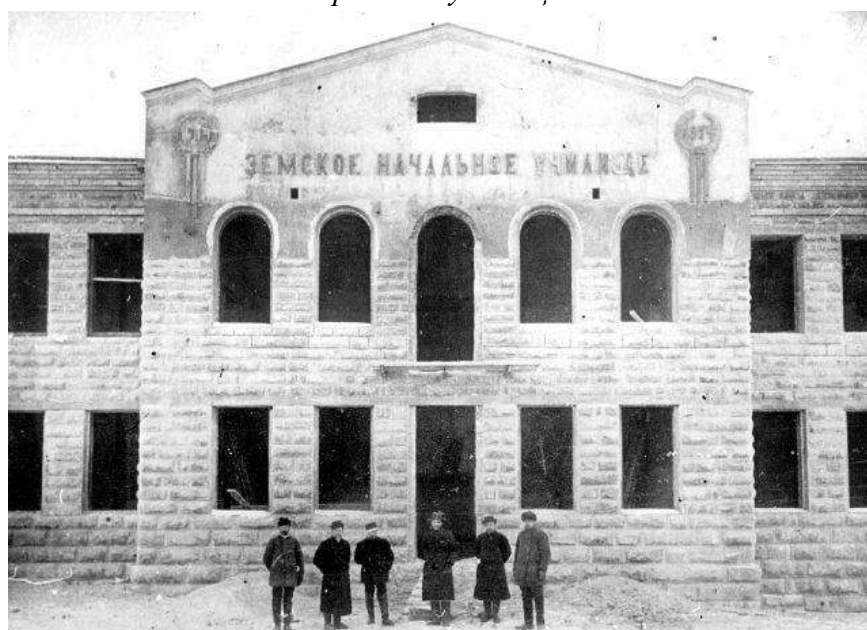
Из фонда краеведческого музея г. Катав-Ивановска. Строительство двухэтажного начального народного училища. 1914 год.
