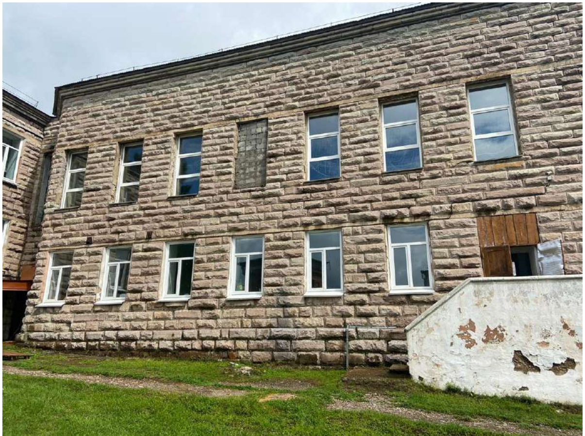
Фото 11. Вид на западный фасад здания. 06.07.2020г.
