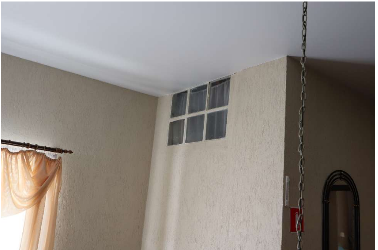
Рис. 30. Внутреннее окно служебного помещения 2 этажа
