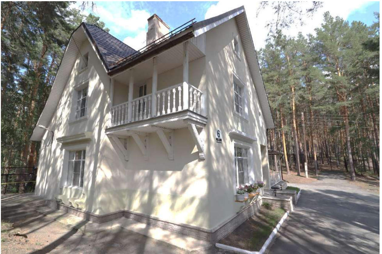
Рис. 9. Главный фасад западного ризалита. Балкон.
