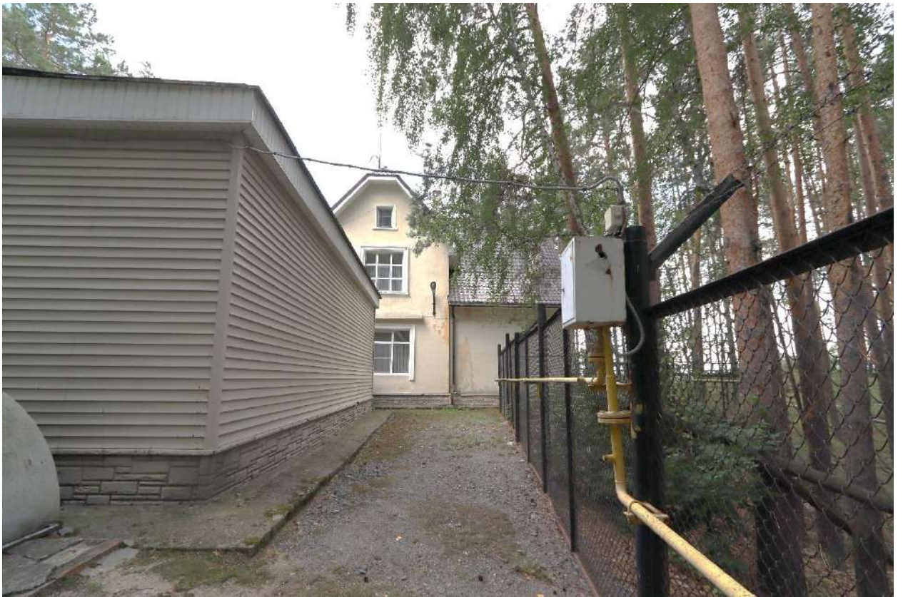
Рис. 5. Северный пристрой. Северные фасады северо-восточного объема здания и западного ризалитов.
