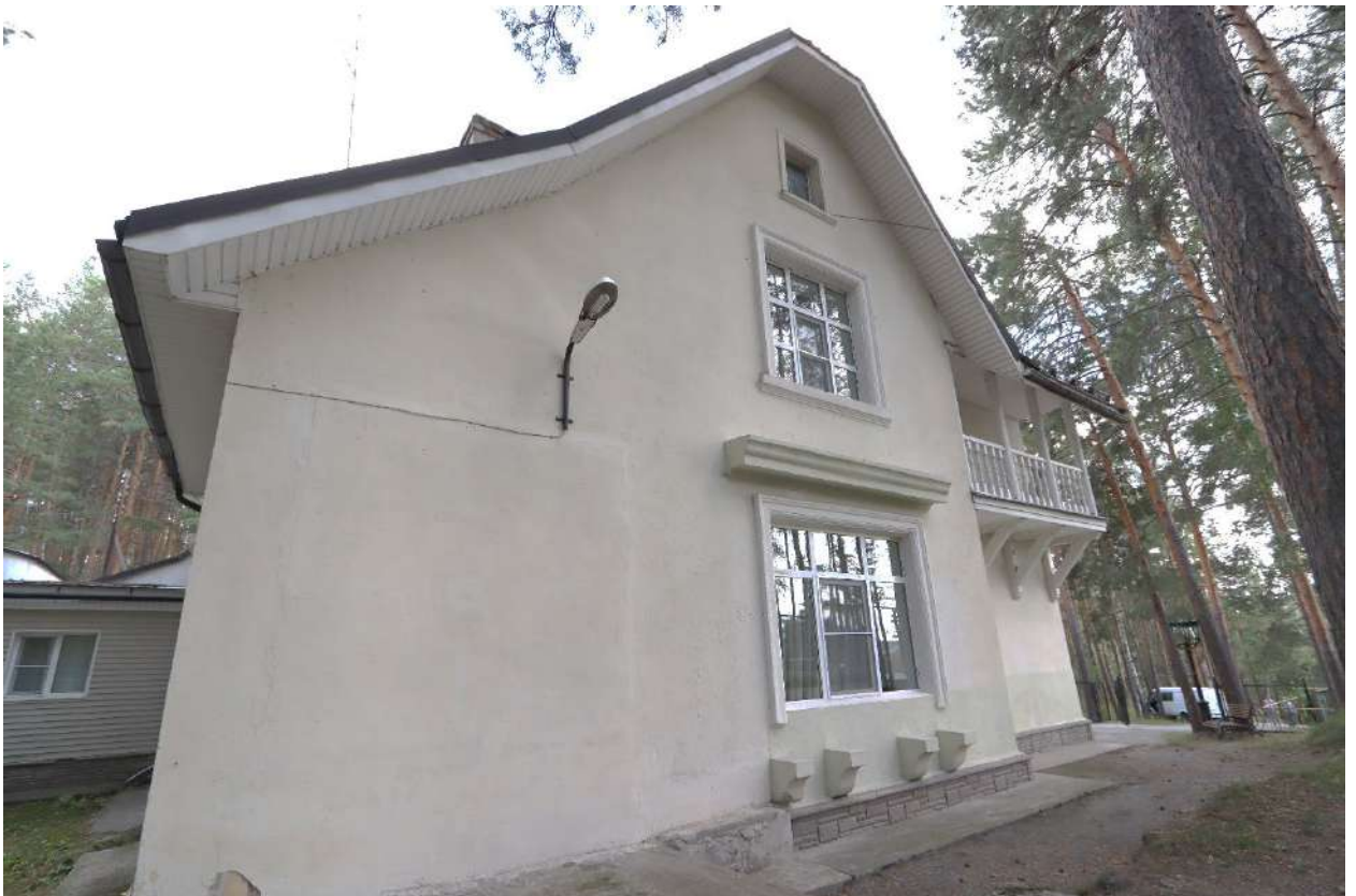
Рис. 8. Главный фасад западного ризалита.
