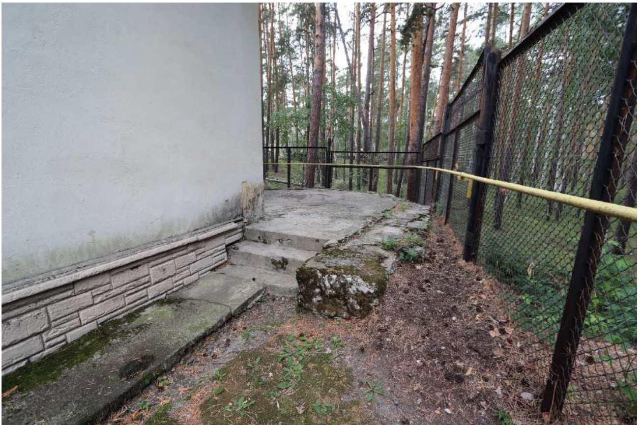
Рис. 12. Фундамент полуциркульной террасы. Лестница со стороны северного фасада.
