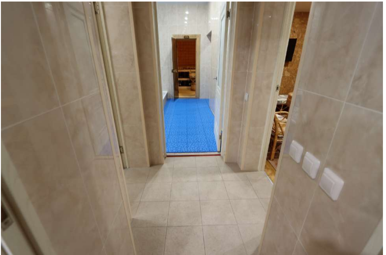
Рис. 42. Коридор северного пристроя, входы в помещения сауны и бассейна
