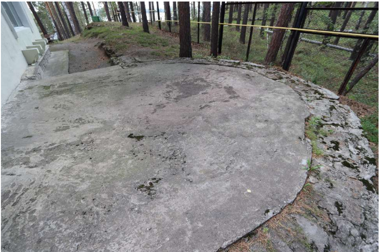
Рис. 10. Фундамент полуциркульной террасы.
