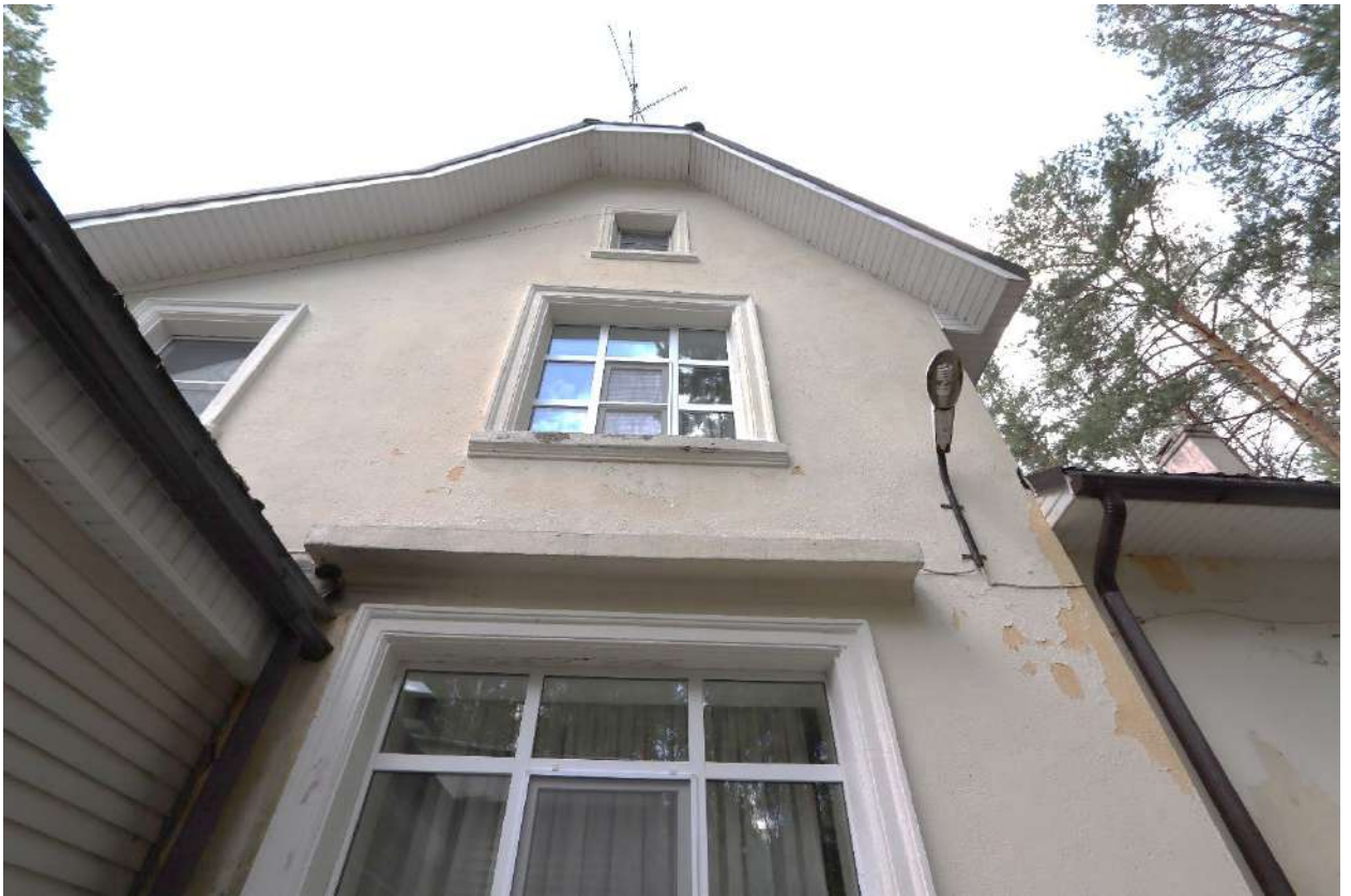
Рис. 7. Главный фасад северного северо-восточного объема здания.
