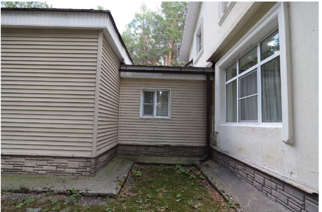
Рис. 6. Северный пристрой. Главный фасад северо-восточного объема здания.
