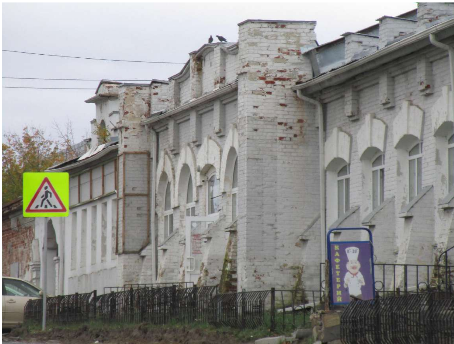
9. Фрагмент северного фасада главного корпуса. Октябрь 2023 г.
