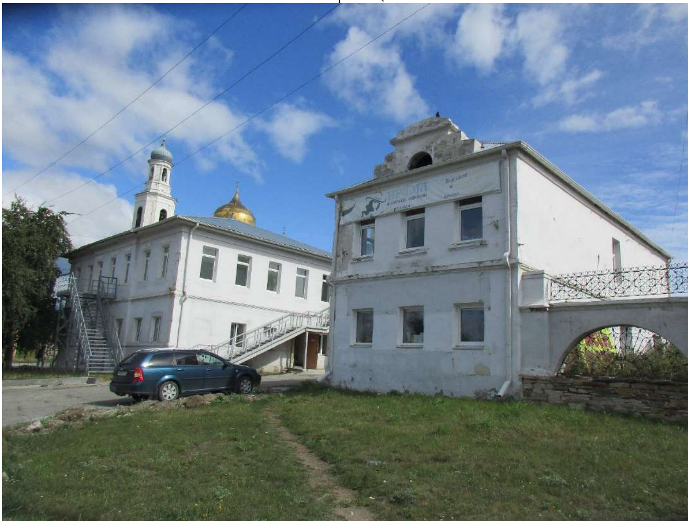
1. Общий вид с ул. Коммуны. Август 2023 г.
