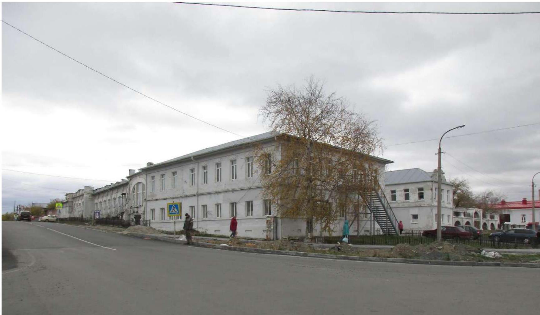
7. Вид с пересечения ул. Ленина и Коммуны. Октябрь 2023 г.
