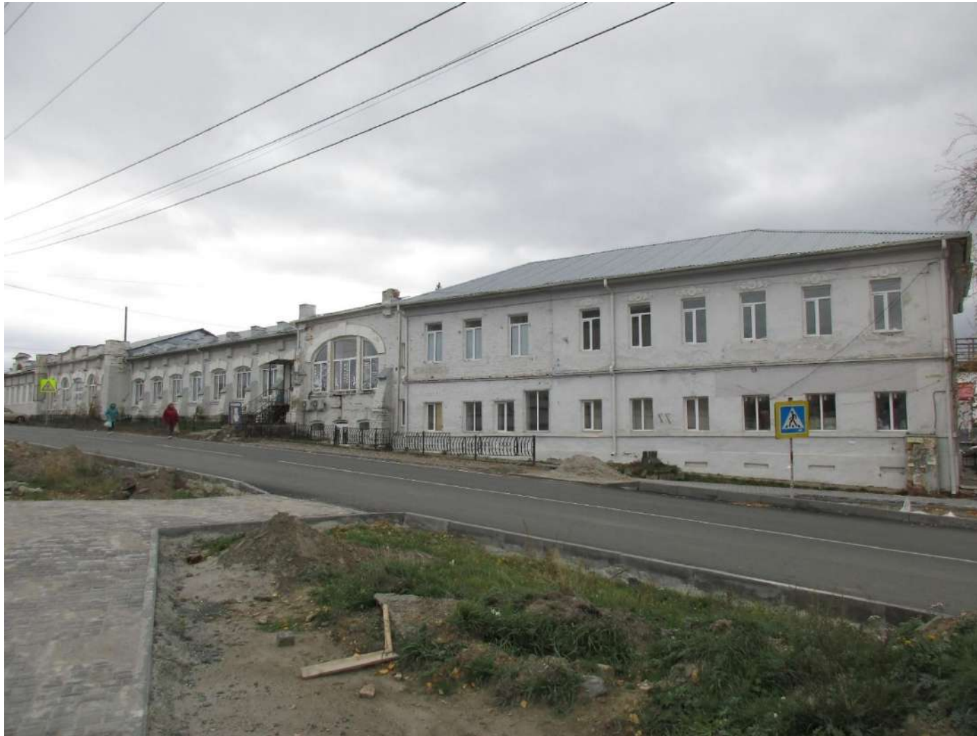
8. Крайний западный объем главного корпуса (справа). Октябрь 2023 г.
