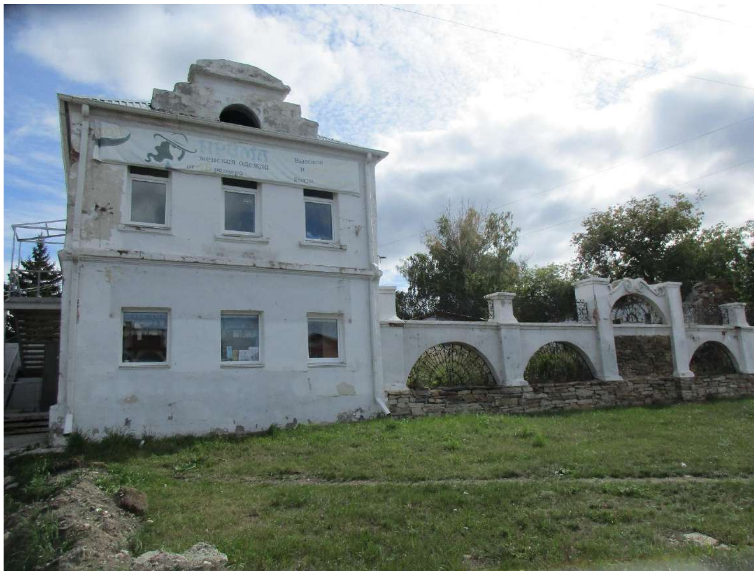
2. Вид на флигель и ограду с запада. Август 2023 г.
