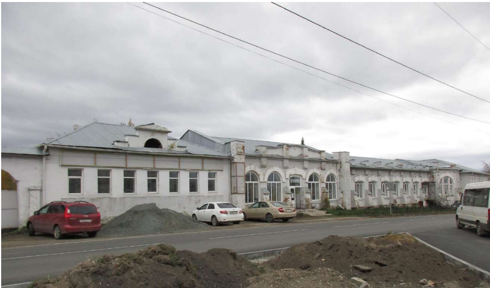
14. Северный фасад главного корпуса. Октябрь 2023 г.
