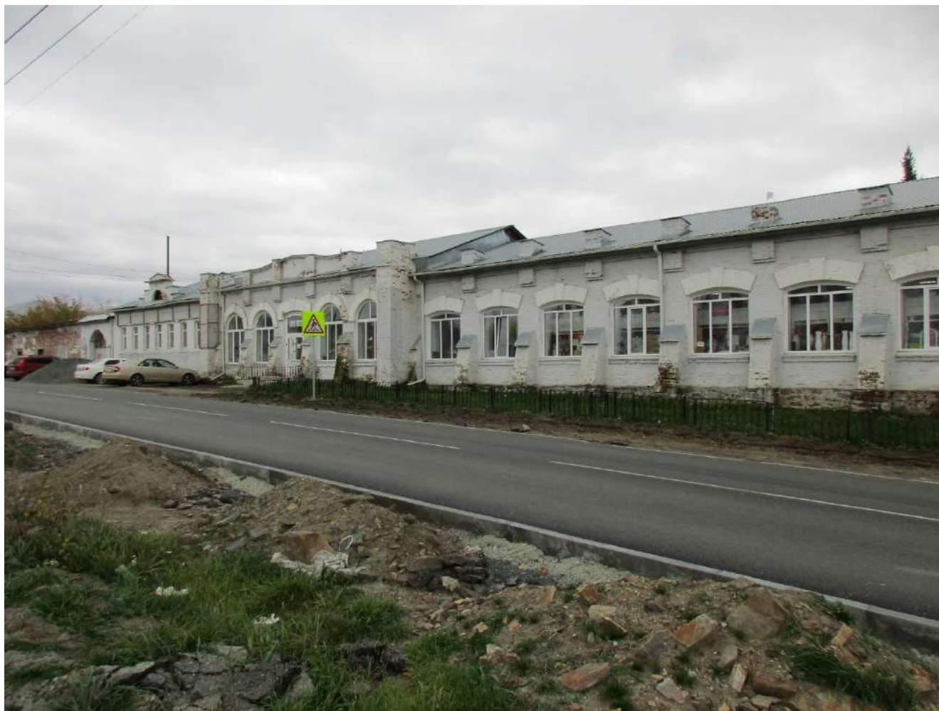
11. Северный фасад главного корпуса. Октябрь 2023 г.
