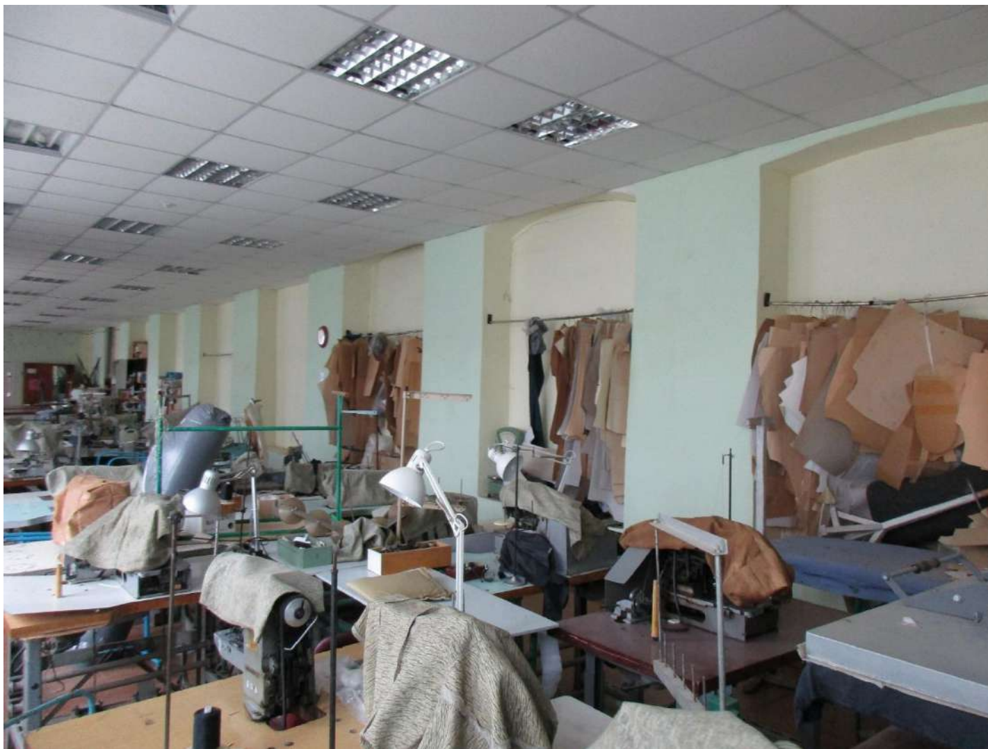
25. Интерьер. Главный корпус. Объем неисторического пристроя. Справа оконные проемы исторической части. Октябрь 2023 г.
