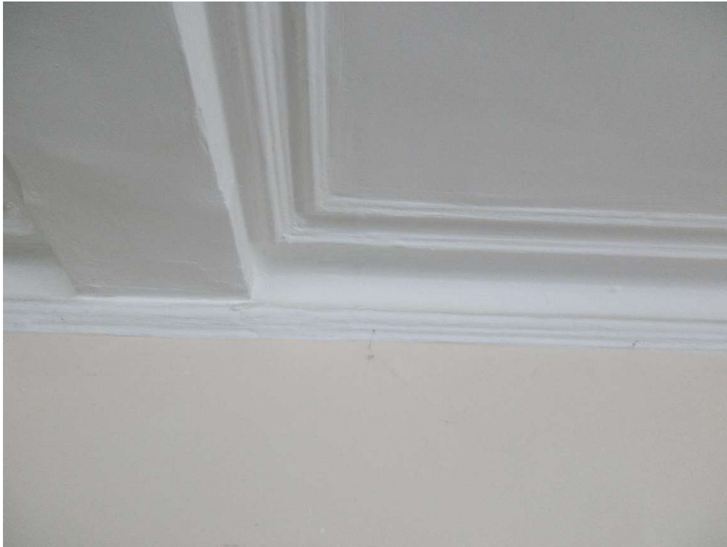
26. Флигель. Интерьер. Второй этаж. Потолочные карнизы.
