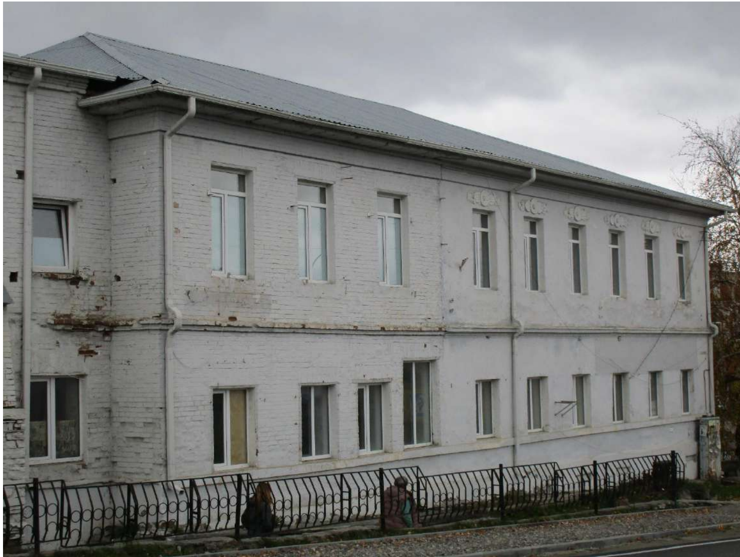
12. Крайний западный объем главного корпуса. Северный фасад. Октябрь 2023 г.
