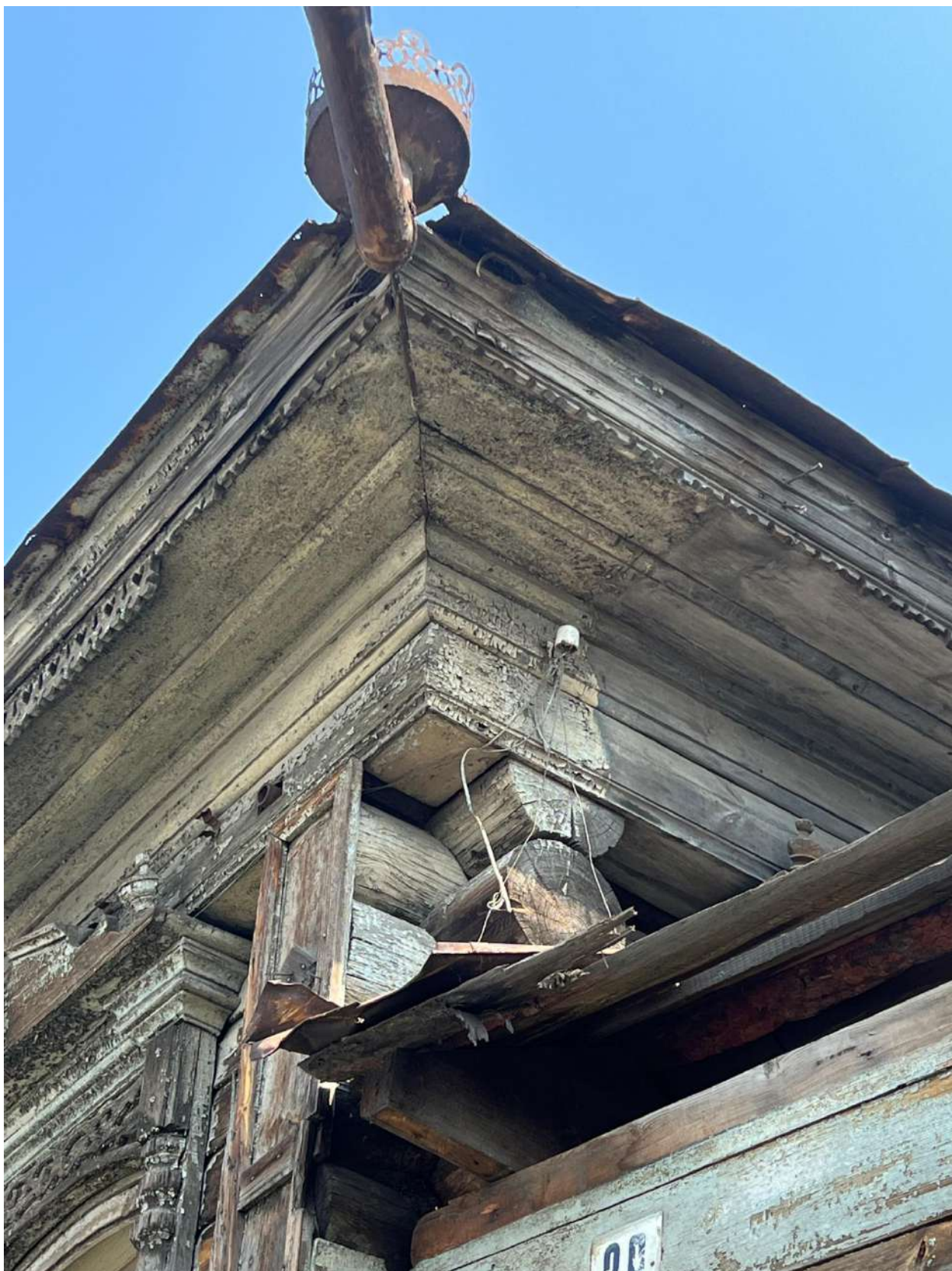
Рис. 7. Фрагмент конструкции дома: «рубка в обло» с закрытием выпусков бревен доской на лицевых фасадах. Подшивной карниз и исторический металлический водосток с ажурным декором
