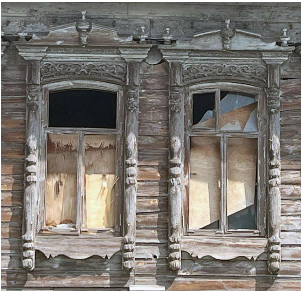
Рис. 4. Фрагмент лицевого, юго-западного фасада. Наличники окон
