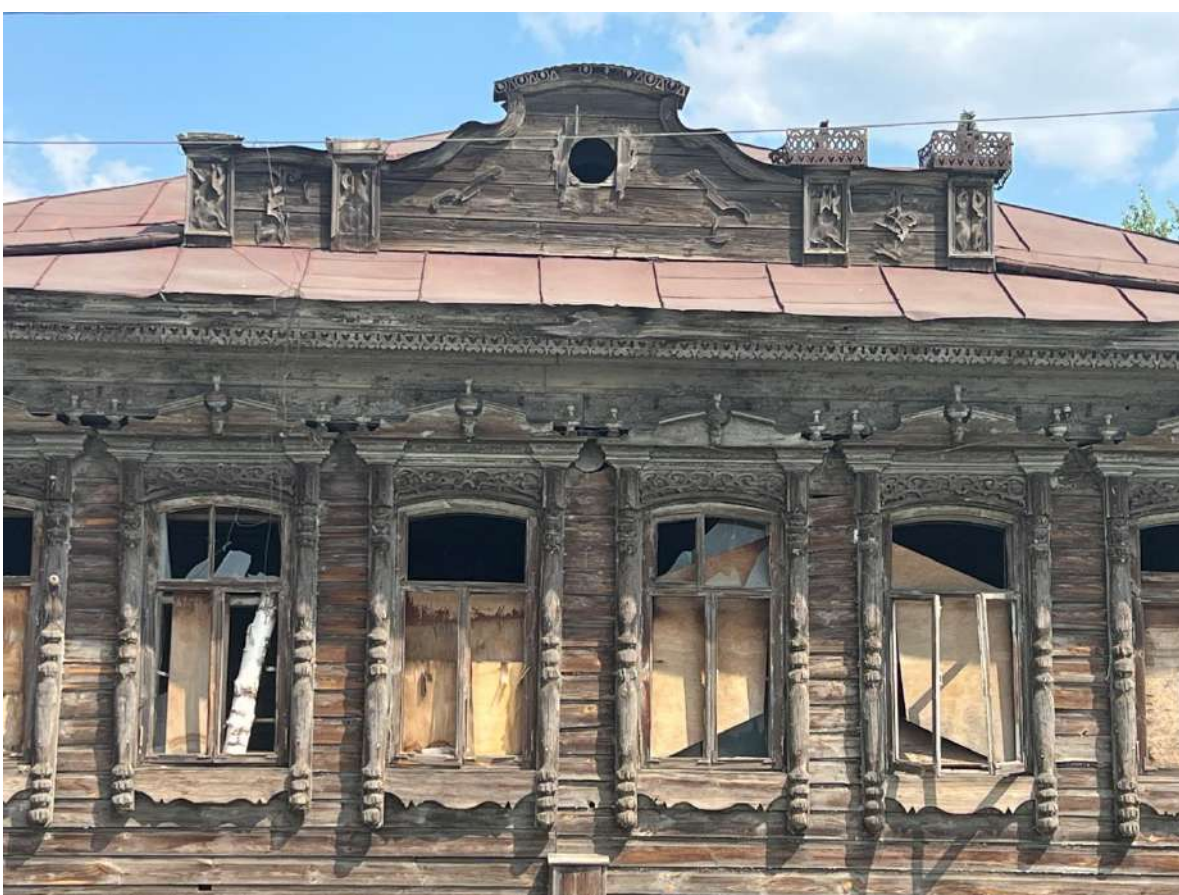
Рис. 3 а, б. Лицевой, юго-западный фасад (вверху). Фрагмент фасада (внизу)
