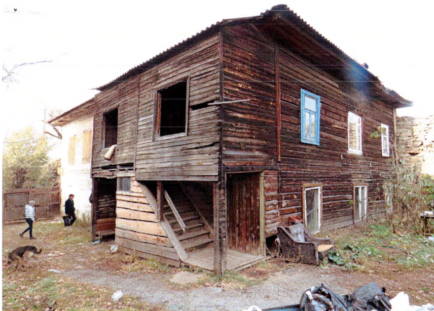
Вид бокового, южного и дворового, восточного фасадов, двора и брандмауэра.
