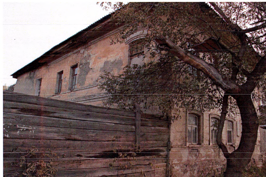
Фрагмент бокового, северного, фасада.
