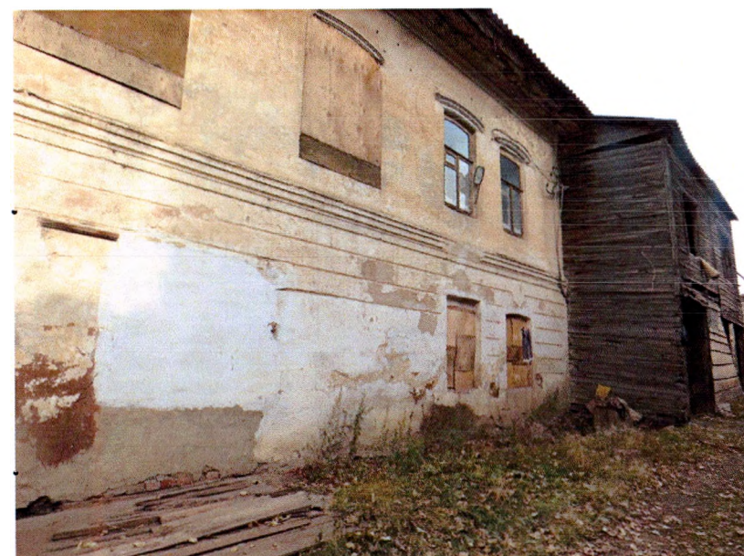
Вид бокового, южного фасада
