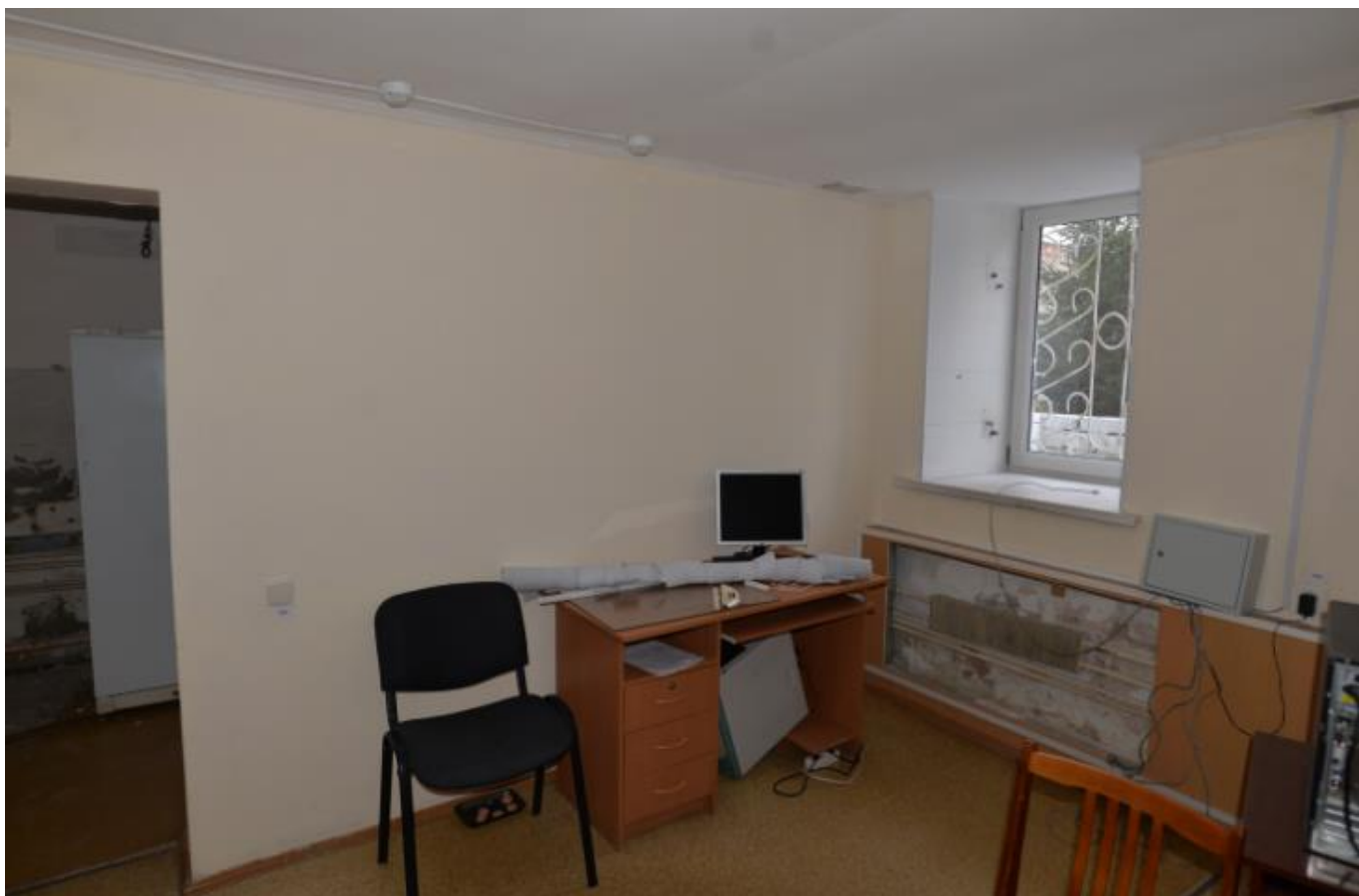
Фото 29. Интерьер выявленного объекта культурного наследия «Городской особняк», расположенного по адресу: Челябинская область, Троицкий городской округ, г. Троицк, ул. им. Степана Разина, 10.
