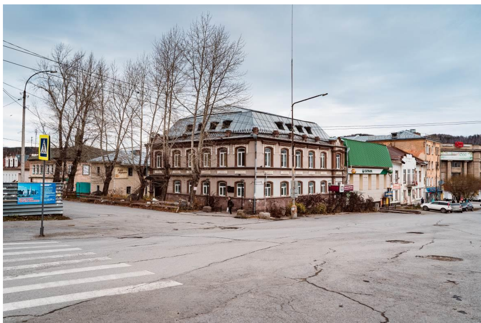
«Особняк купеческий». Вид с юго-запада.
