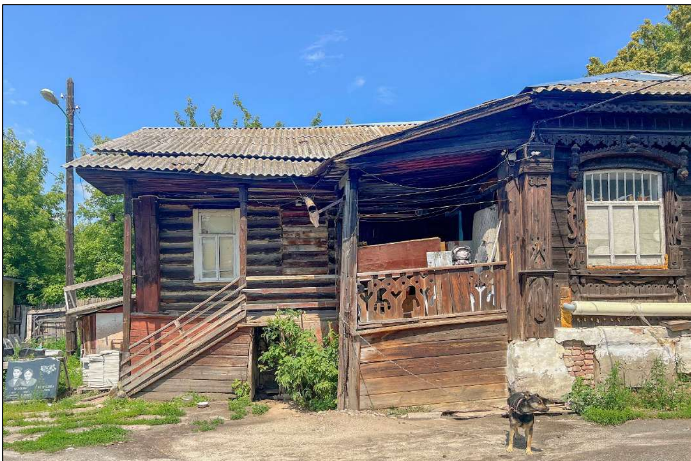
7. Фрагмент фасада Объекта.
