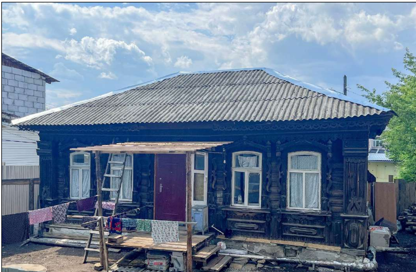
1. Общий вид на Объект.
