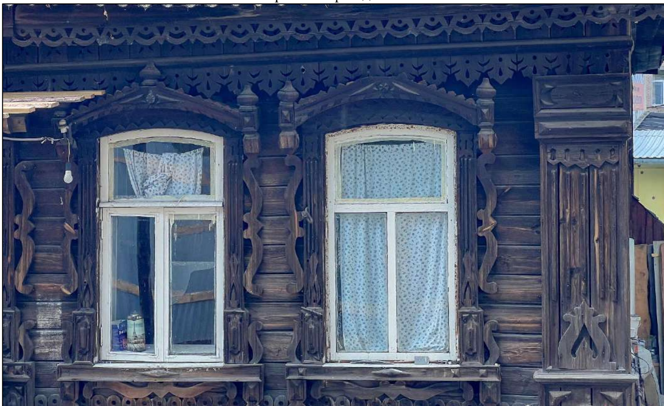
3. Фрагмент фасада Объекта.
