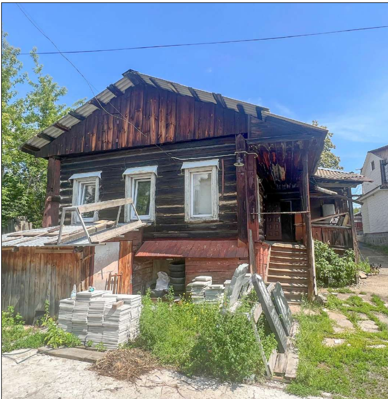
8. Общий вид на Объект.
