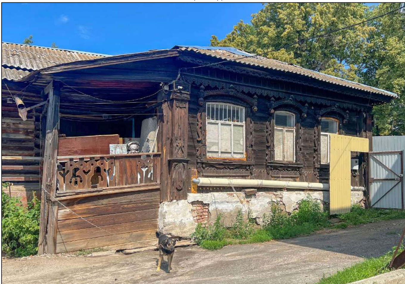
6. Фрагмент фасада Объекта.
