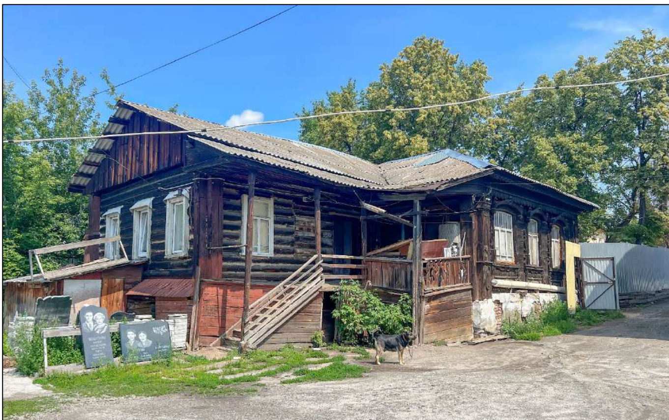
5. Общий вид на Объект.
