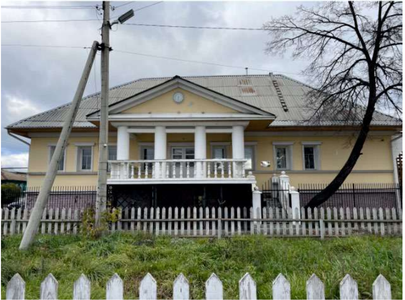
Фото 3. Выявленный объект культурного наследия «Дом купца Лесина» по адресу: Челябинская обл., г. Миасс, ул. Октябрьская, 7. Южный фасад выявленного объекта культурного наследия.
