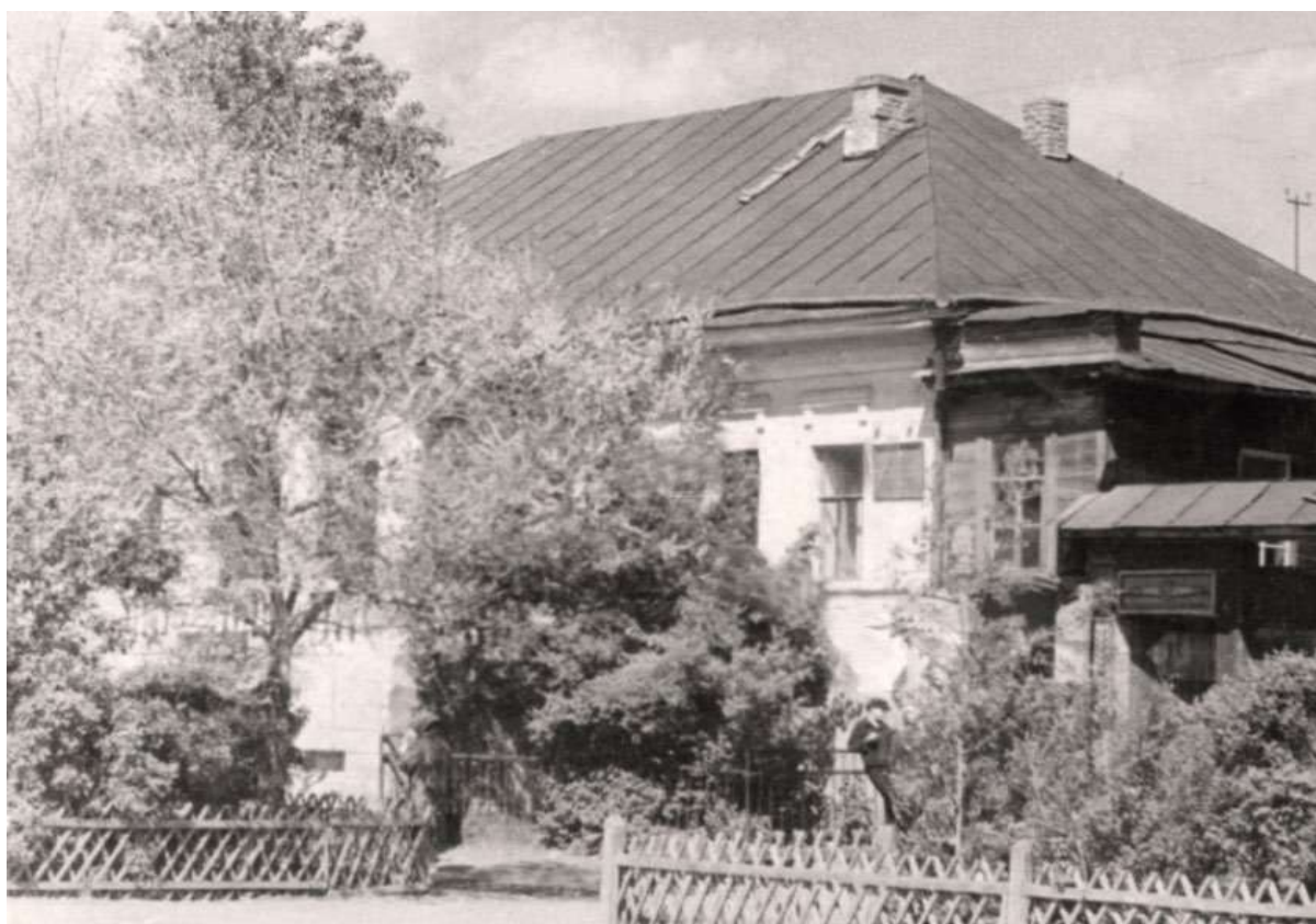
Рис.4. Историческая фотография объекта, 1961 г.
