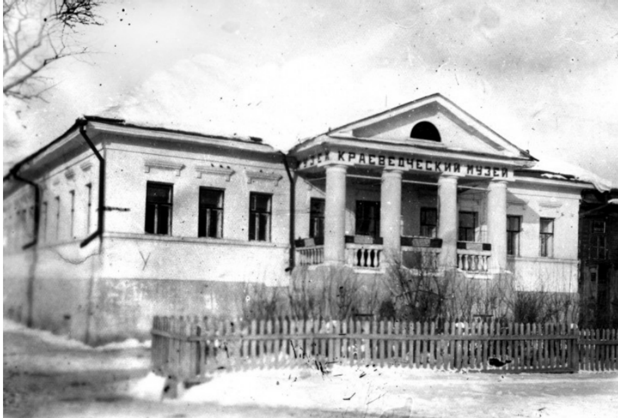
Рис.3. Историческая фотография объекта, 1940 г.
