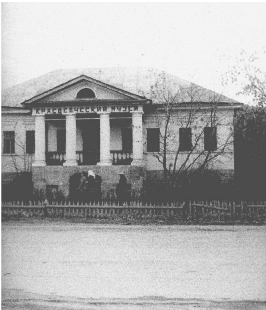
Рис. 5. Историческая фотография объекта, 1961 г.
