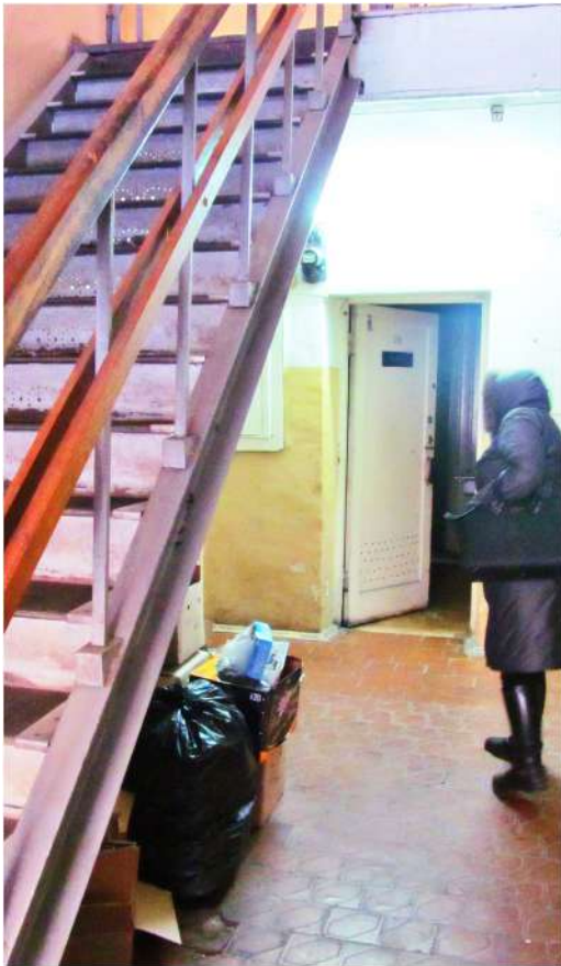
Рис. 35 Вид на интерьер лестничной клетки с 1-го этажа здания
