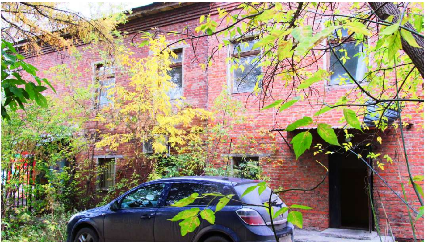
Рис. 10 Вид на восточный фасад здания-памятника со стороны дворовой территории
