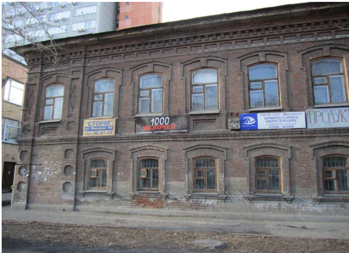
Рис. 46 Главный (южный) фасад дома по ул. Миасской, 44 (Фото - апрель, 2015 г.). Ссылка: https://pp.vk.me/c622016/v622016824/35179/w8jMKjp5dZA.jpg
