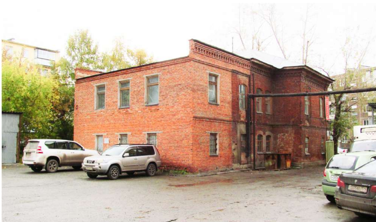
Рис. 7 Вид на здание-памятник с северо-запада со стороны дворовой территории
