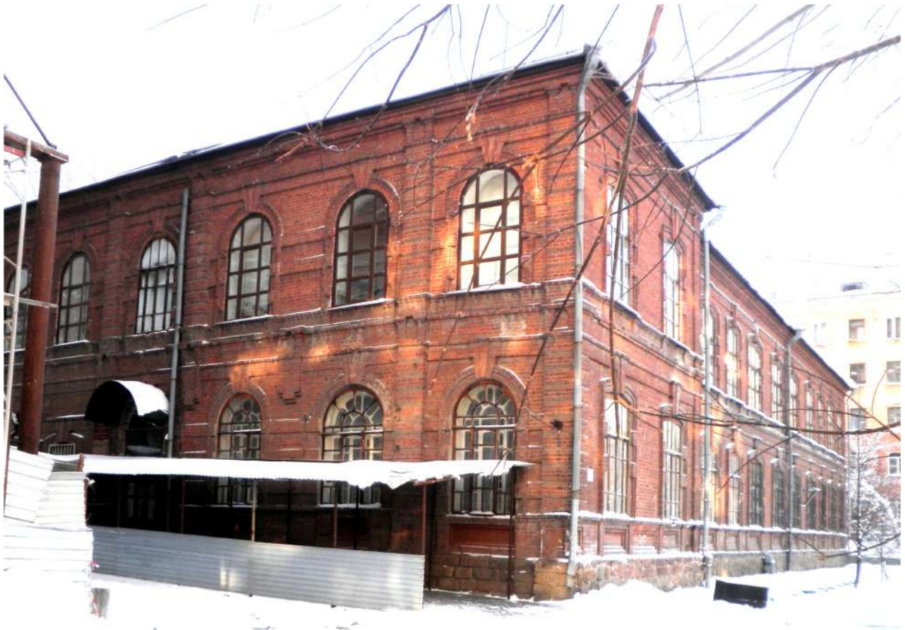
Рис. 49 «Здание второго низшего начального училища» (предположительно) по ул. Борьбы, 28 (1916 г.). Схожее композиционное построение объёма здания. Уступчатый карниз опирается на сухарики; окна второго этажа с рамочными наличниками, ширинки под окнами второго этажа; окна 2-го этажа выше окон 1-го
