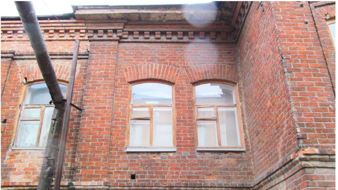
Рис. 18 Вид на окна 2-го этажа западного фасада здания
