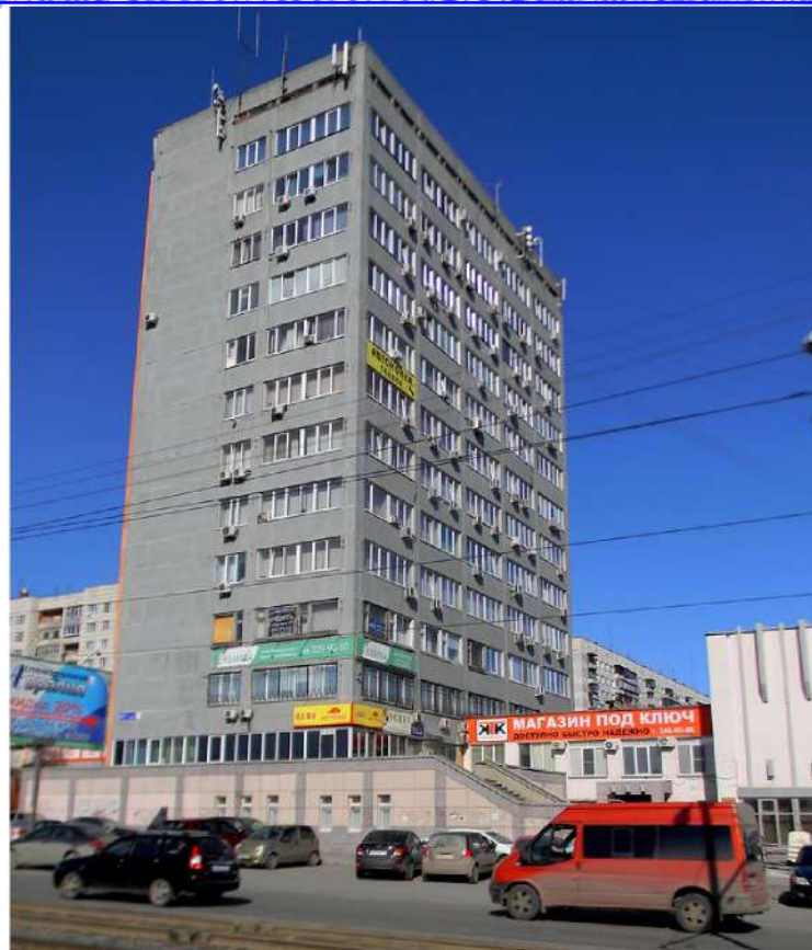
Рис. 36 Здание института «Гипростанок» (Фото 2013 г.)//chelchel-ru.livejournal.com, 22.04.2013. Ссылка: http://imgfotki.yandex.ru/get/5641/5661614_55/0_8eb59_33251174_XL.jpg .
