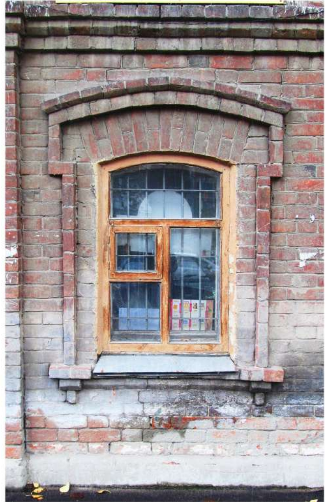
Рис. 17 Вид на окно 1-го этажа главного фасада здания
