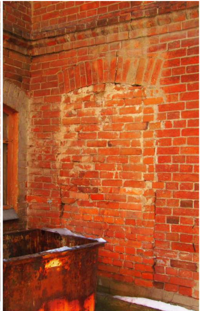
Рис. 20 Вид на заложенный проем 1-го этажа западного фасада здания
