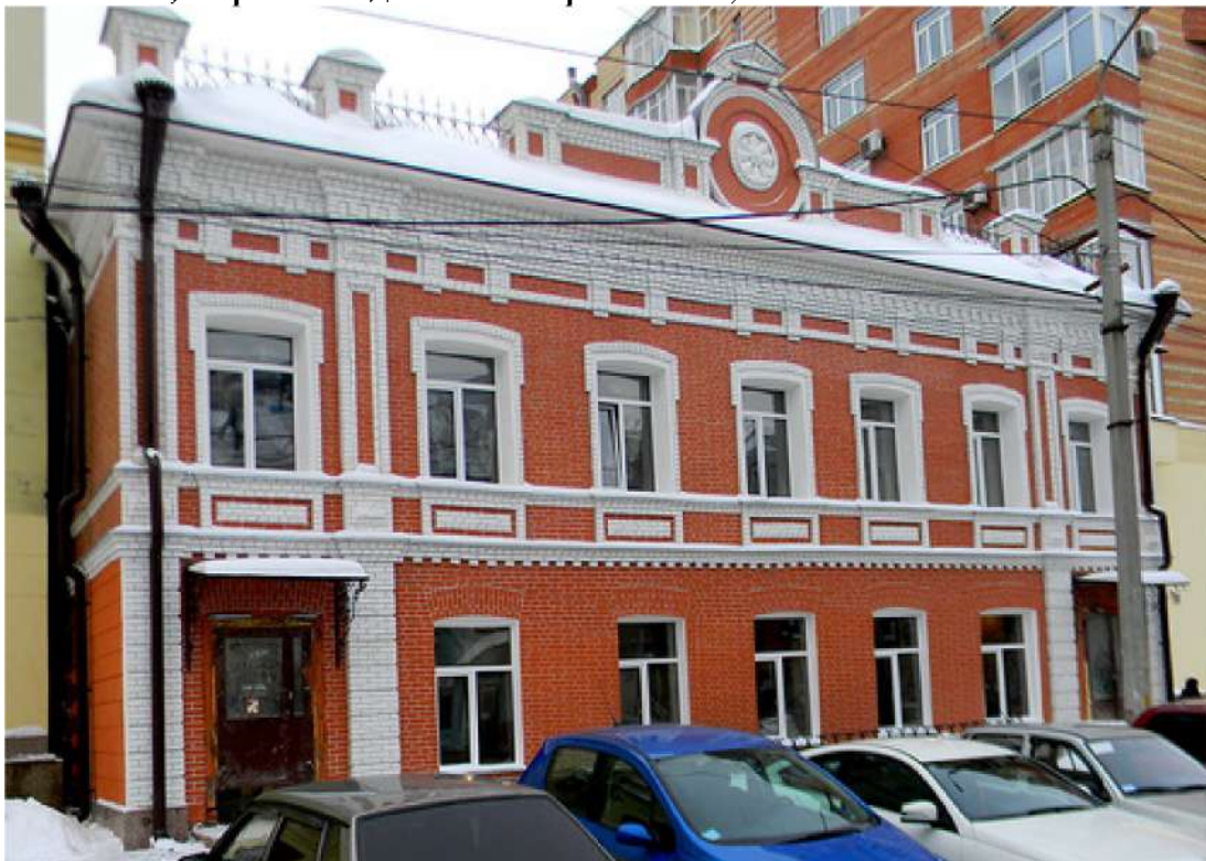
Рис. 50 «Дом жилой» по ул. Коммуны, 81 (кон. XIX в.). Наборный карниз, полоса с сухариками над полосой с рамочными ширинками
