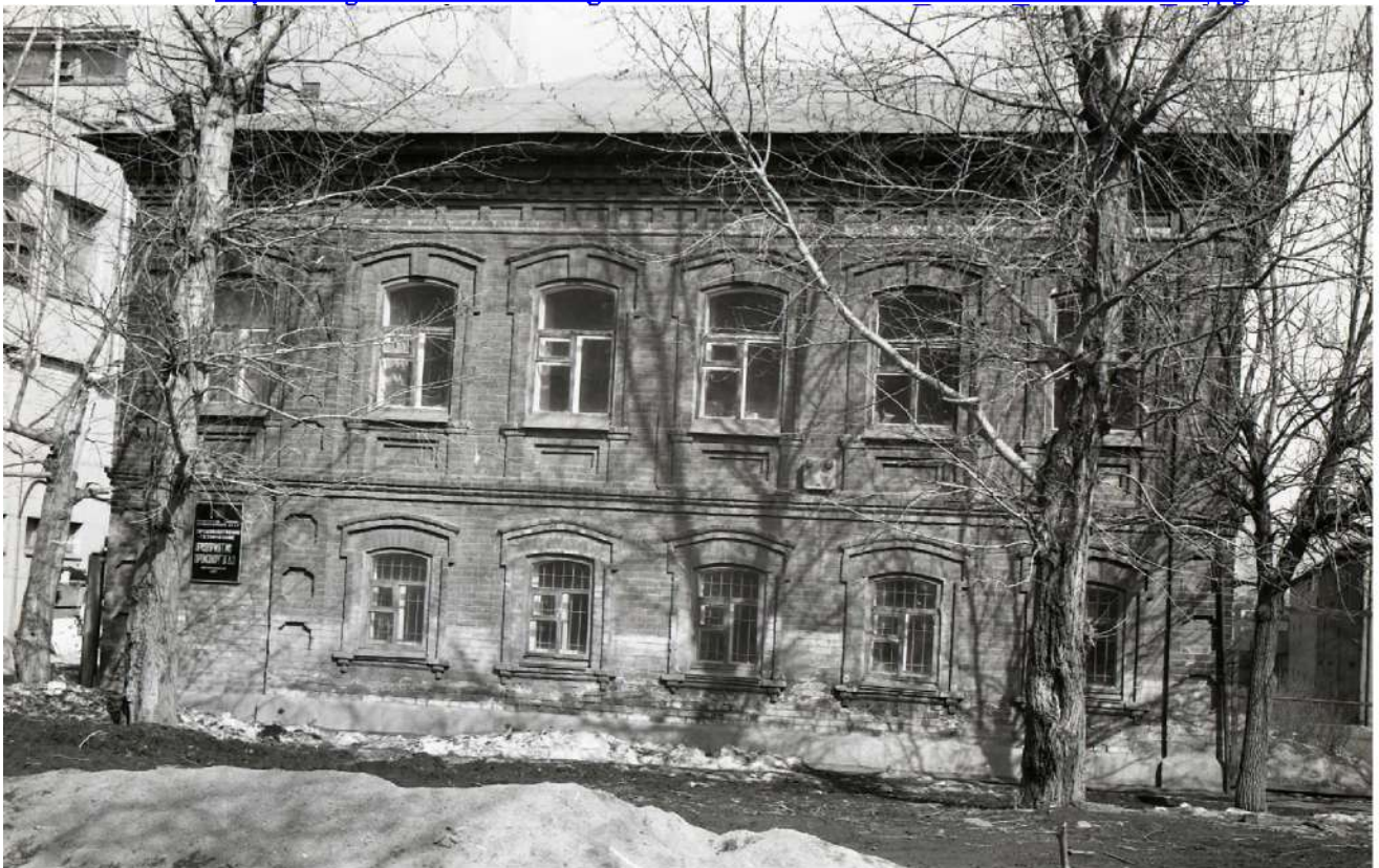
Рис. 38 Дом по ул. Миасской, 44 (Надпись на вывеске: Производство техническое «ПРЕДПРИЯТИЕ ПРОМЭНЕРГОГАЗ») (Фото 1993 года)// Фотография из фонда ЦИКНЧ. Ссылка: https://img-fotki.vandex.ru/get/15543/5661614.9a/0_ad1d5_a732841a_L.jpg .
