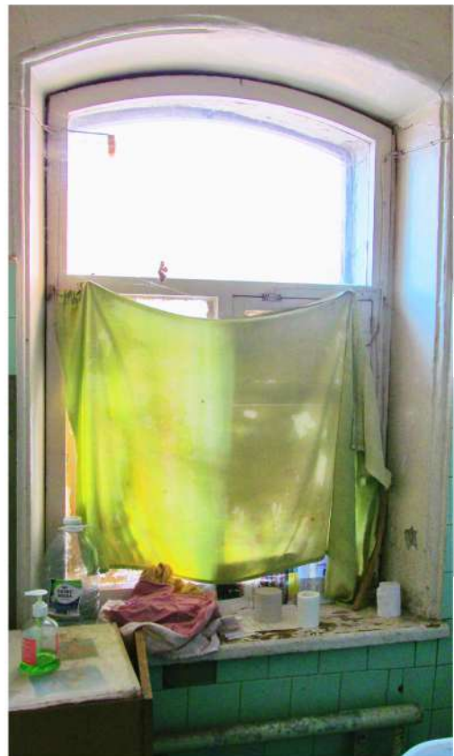
Рис. 42 Вид на окно интерьера с/у 2-го этажа здания
