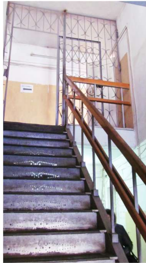
Рис. 36 Вид на интерьер лестничной клетки с 1-го этажа здания
