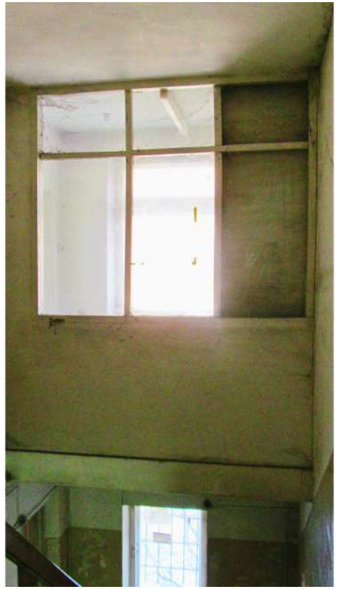
Рис. 38 Вид на интерьер лестничной клетки со 2-го этажа здания
