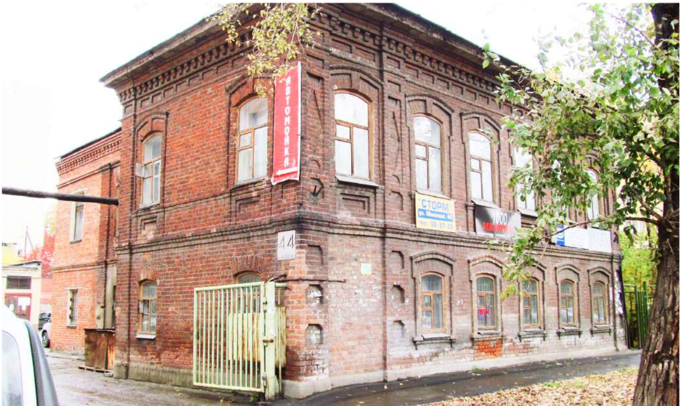
Рис. 8 Вид на юго-западную угловую часть здания-памятника со стороны ул. Миасская
