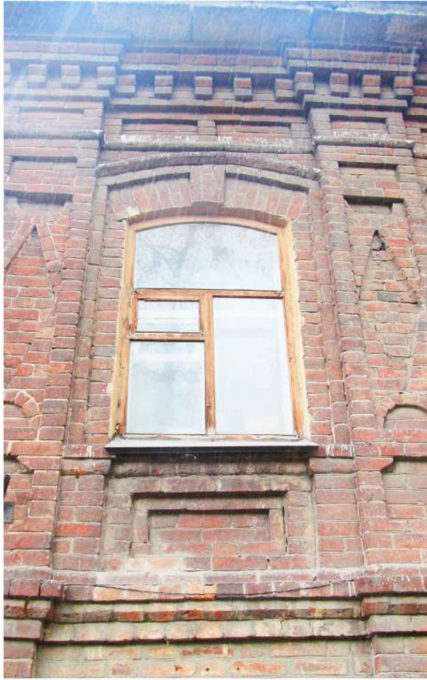
Рис. 16 Вид на окно 2-го этажа главного фасада здания
