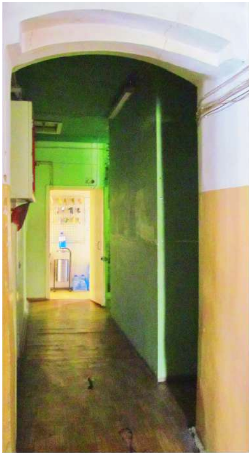
Рис. 39 Вид на проем интерьера коридора 2-го этажа здания
