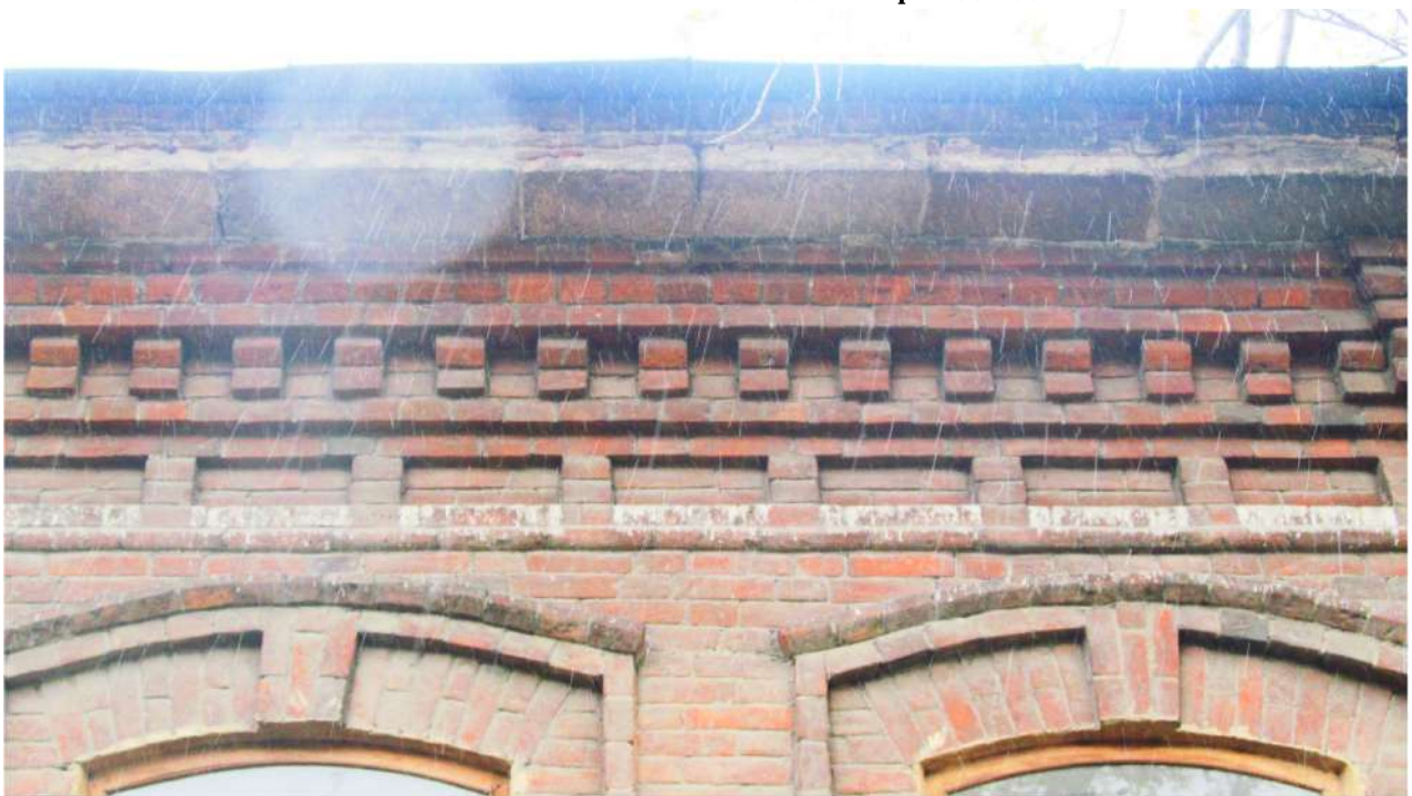
Рис. 21 Вид на карнизную зону главного фасада здания
