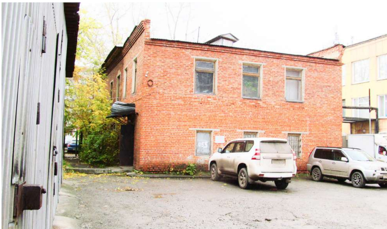
Рис. 6 Вид на здание-памятник с северо-востока со стороны дворовой территории
