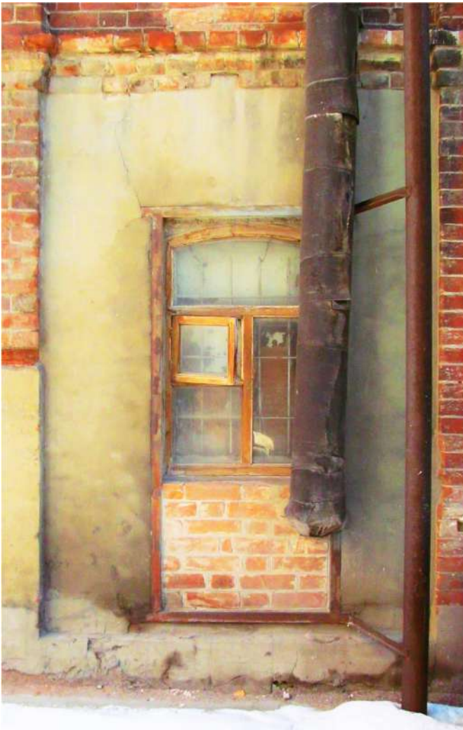
Рис. 19 Вид на окно 1-го этажа западного фасада здания
