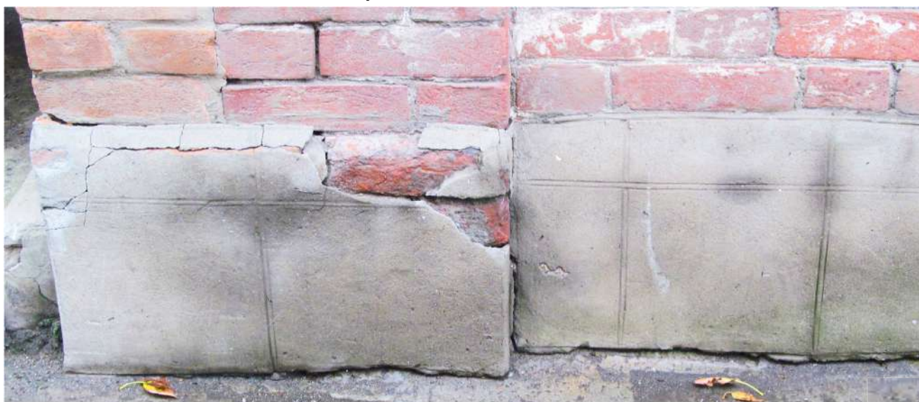
Рис. 28 Вид на цоколь западного фасада
