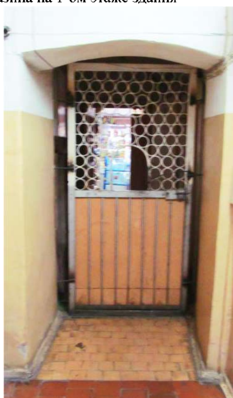
Рис. 34 Вид на проем интерьера лестничной клетки на 1-ом этаже здания
