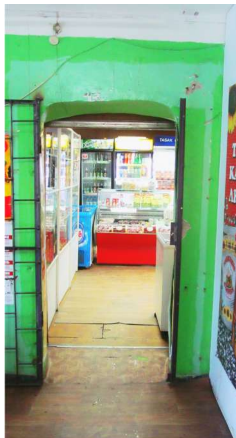
Рис. 32 Вид на проем интерьера продуктового магазина на 1-ом этаже здания
