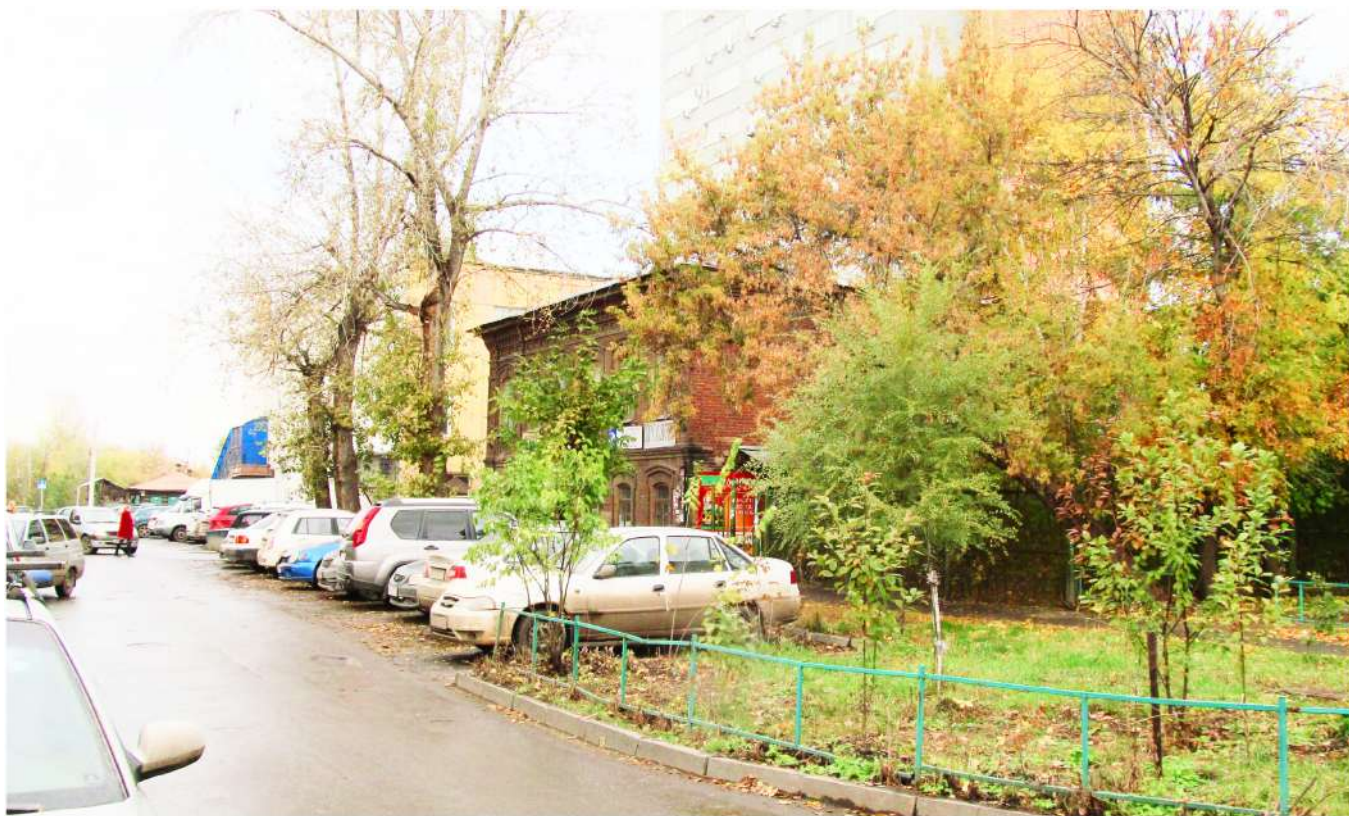
Рис. 4 Вид на здание-памятник с юго-востока со стороны ул. Миасской
