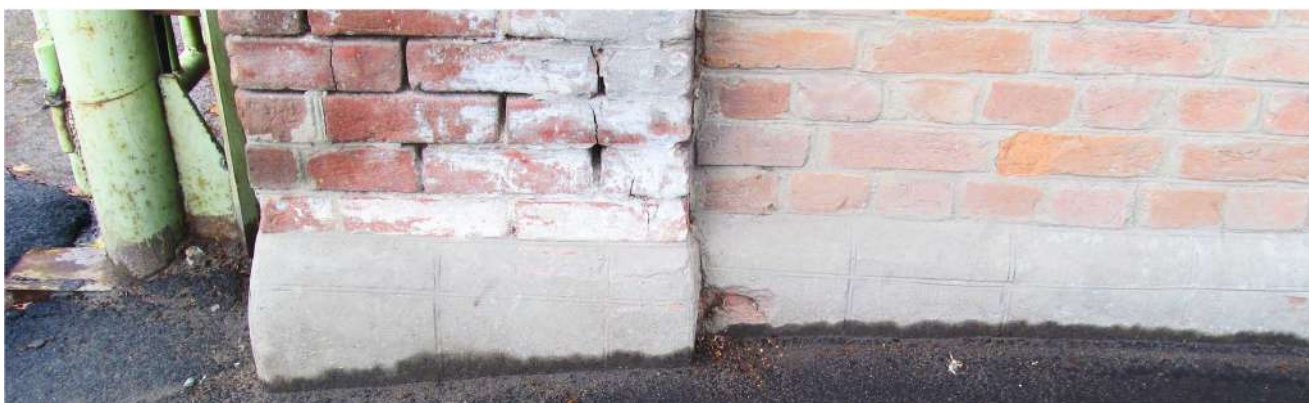
Рис. 27 Вид на цоколь главного фасада
