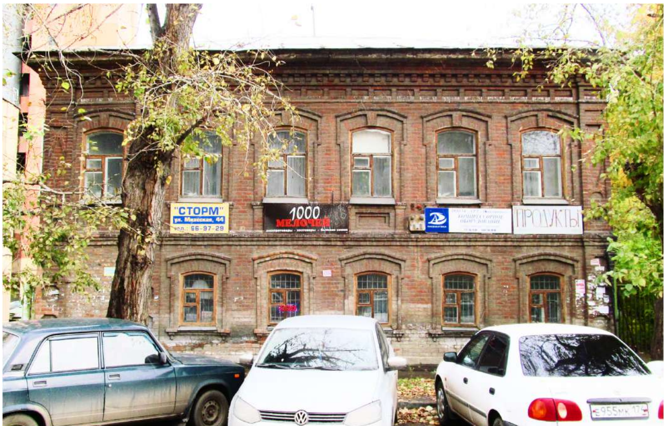
Рис. 9 Вид на главный южный фасад здания-памятника со стороны ул. Миасская
