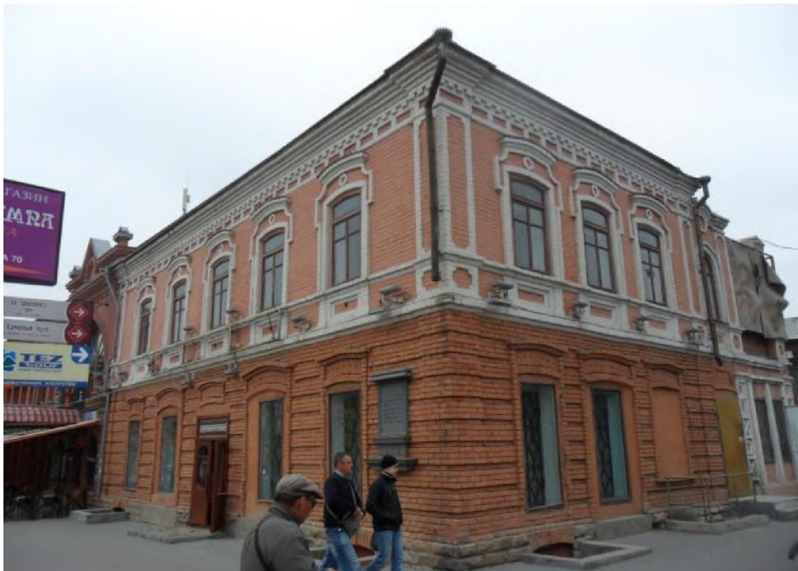
Рис. 48 «Дом купеческий» по ул. Кирова, 145 (кон. 1890-х г.). Схожее решение прикарнизной зоны: полоса с зубчиками над полосой с рамочными ширинками. Перспективные ниши под окнами. Композиционное построение лопаток, в основании лопаток -квадратные ниши с с радиально срезанными углами
