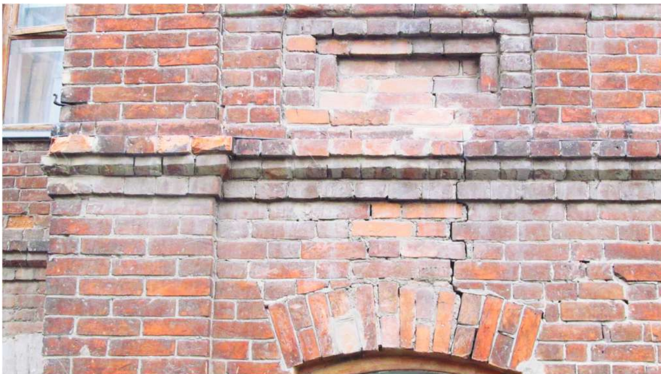
Рис. 26 Вид на декоративное оформление стены западного фасада здания
