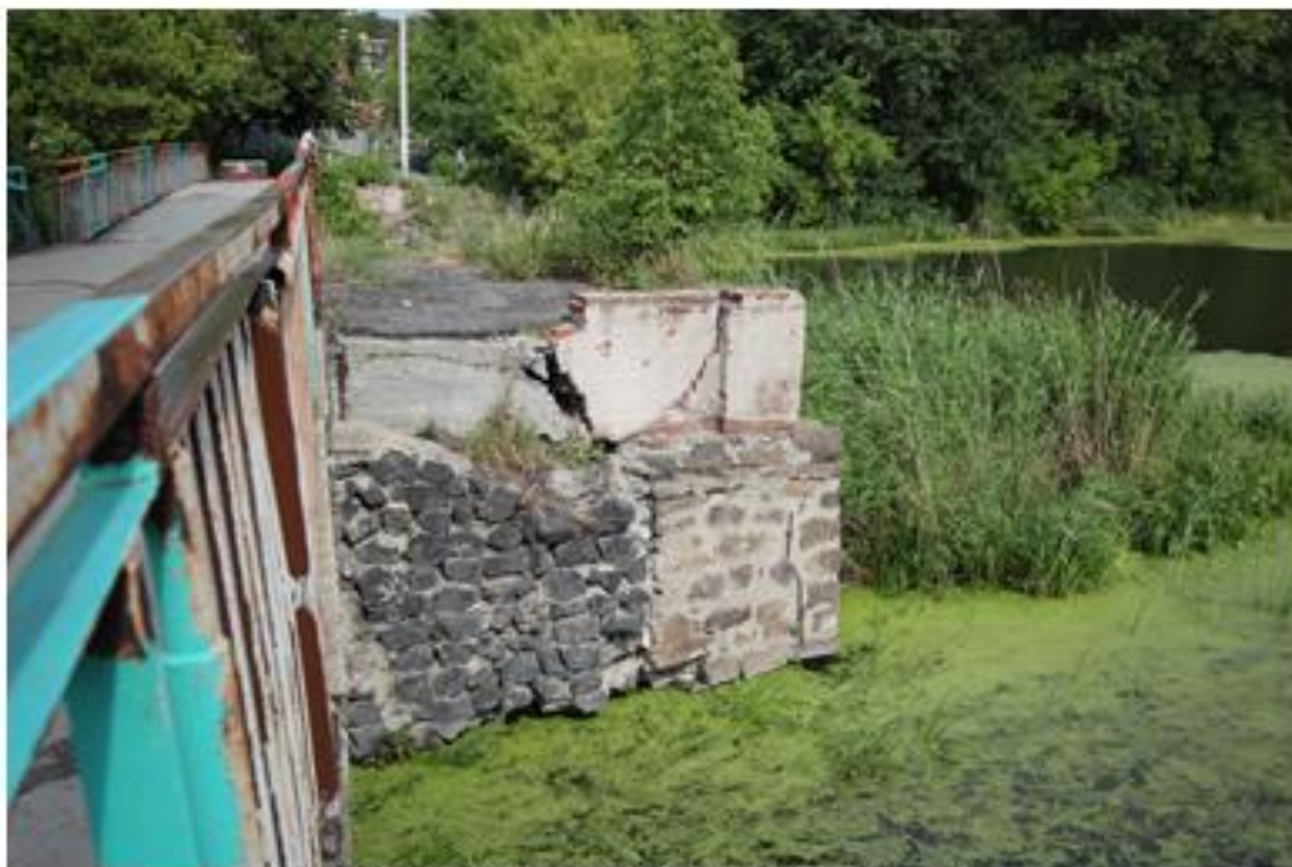
Фрагмент исторической кладки устоев плотины
