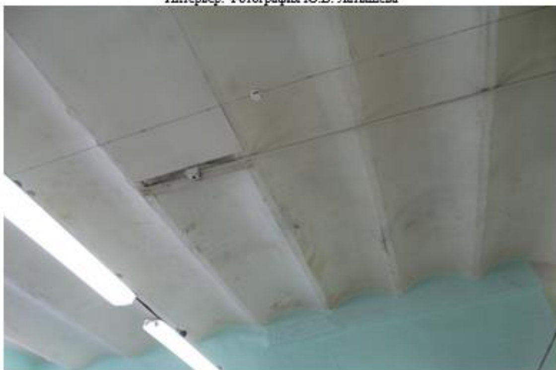
Лучковые своды по металлическим балкам (своды Монье) Фотография Ю.В. Латышева
