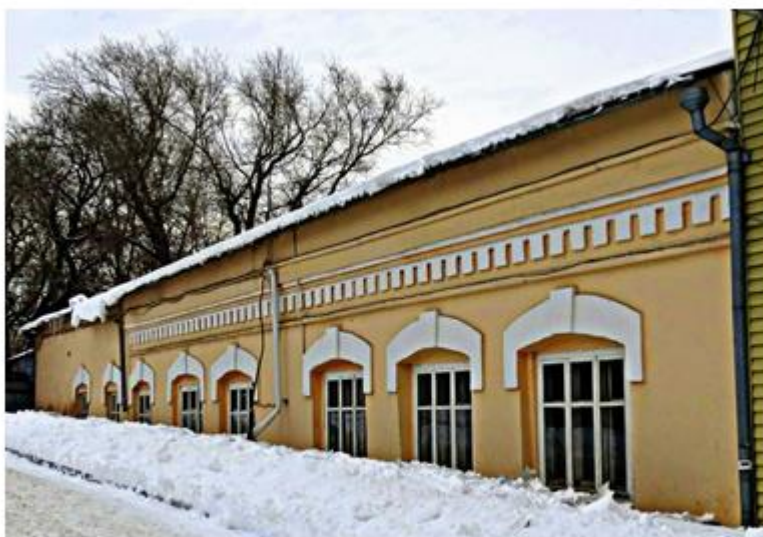
Вид с севера на восточный фасад Фотография Ю.В. Латышева
