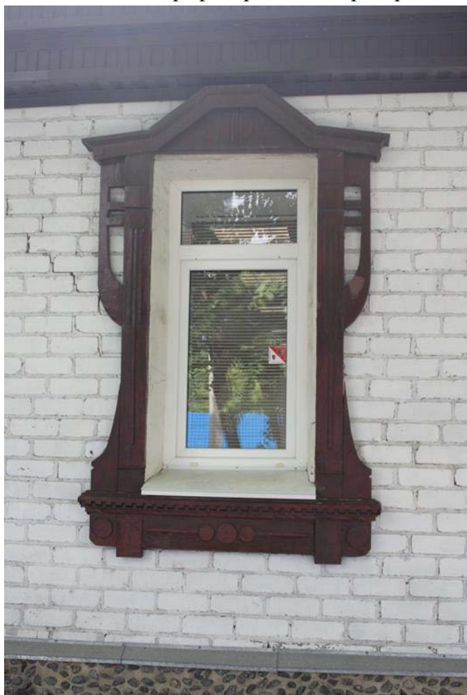
Фото 6. Северный фасад. Наличник пристроя.
