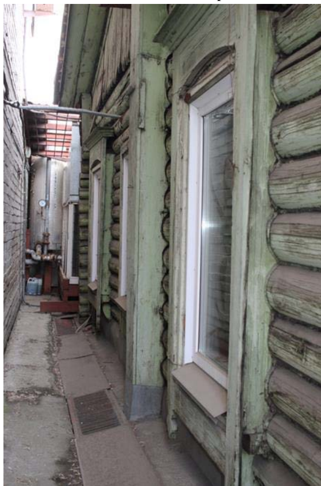
Фото 4. Вид на западный фасад.
