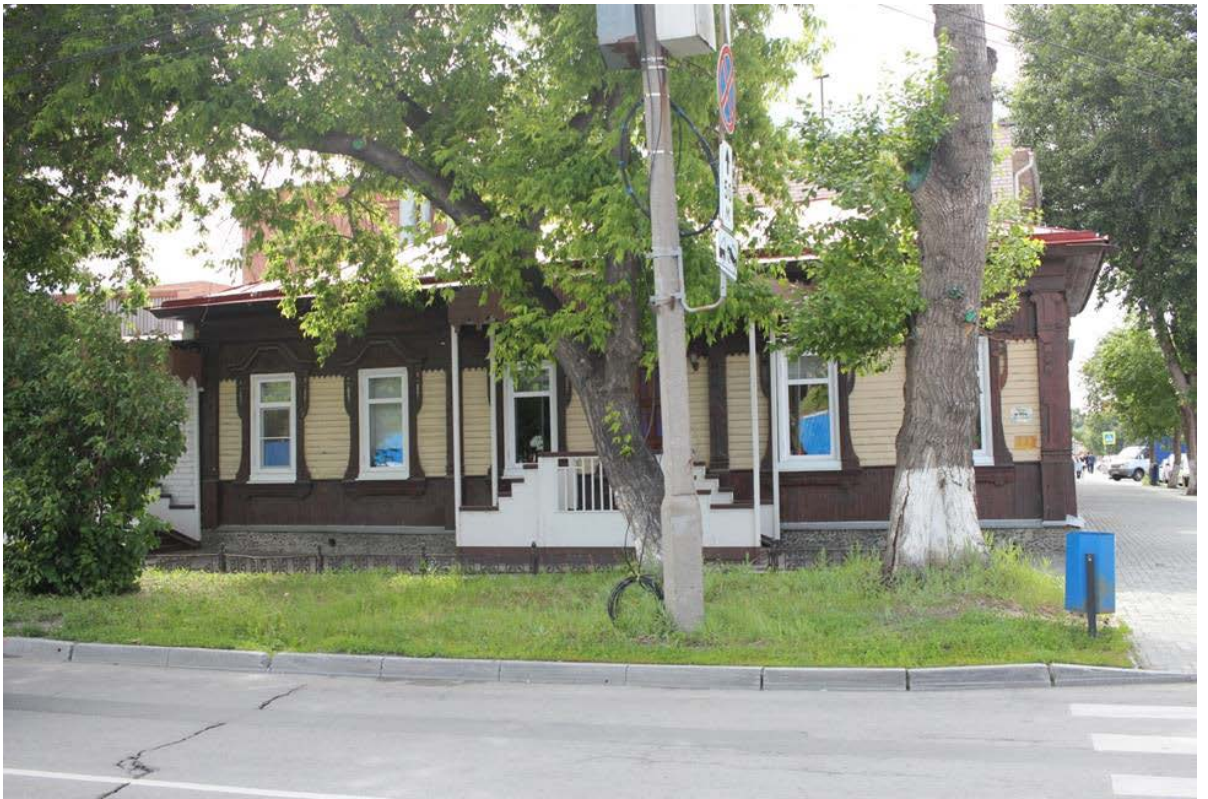
Фото 3. Восточный фасад здания.
