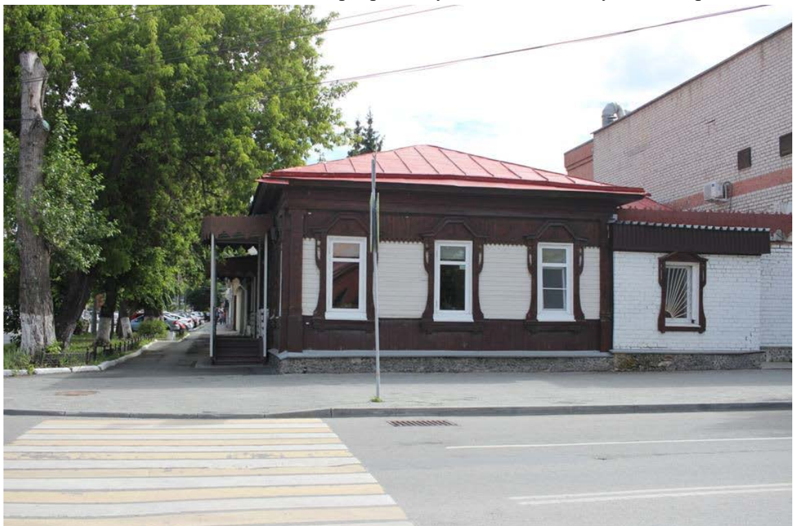
Фото 2. Северный фасад здания.
