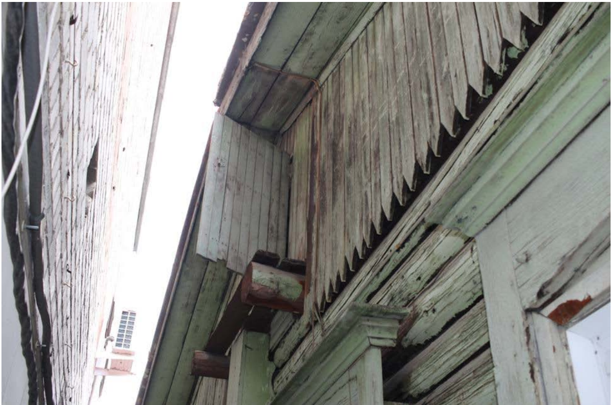
Фото 10. Фрагмент западного фасада. Лаз на чердак.
