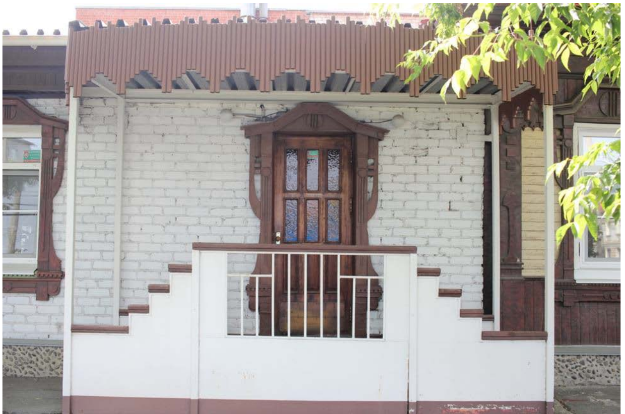
Фото 7. Восточный фасад. Пристрой. Входная группа.
