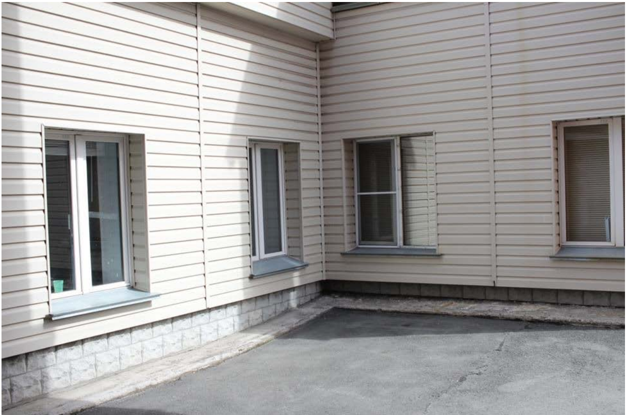
Фото 12. Облицованные сайдингом дворовые фасады здания и его пристроев.
