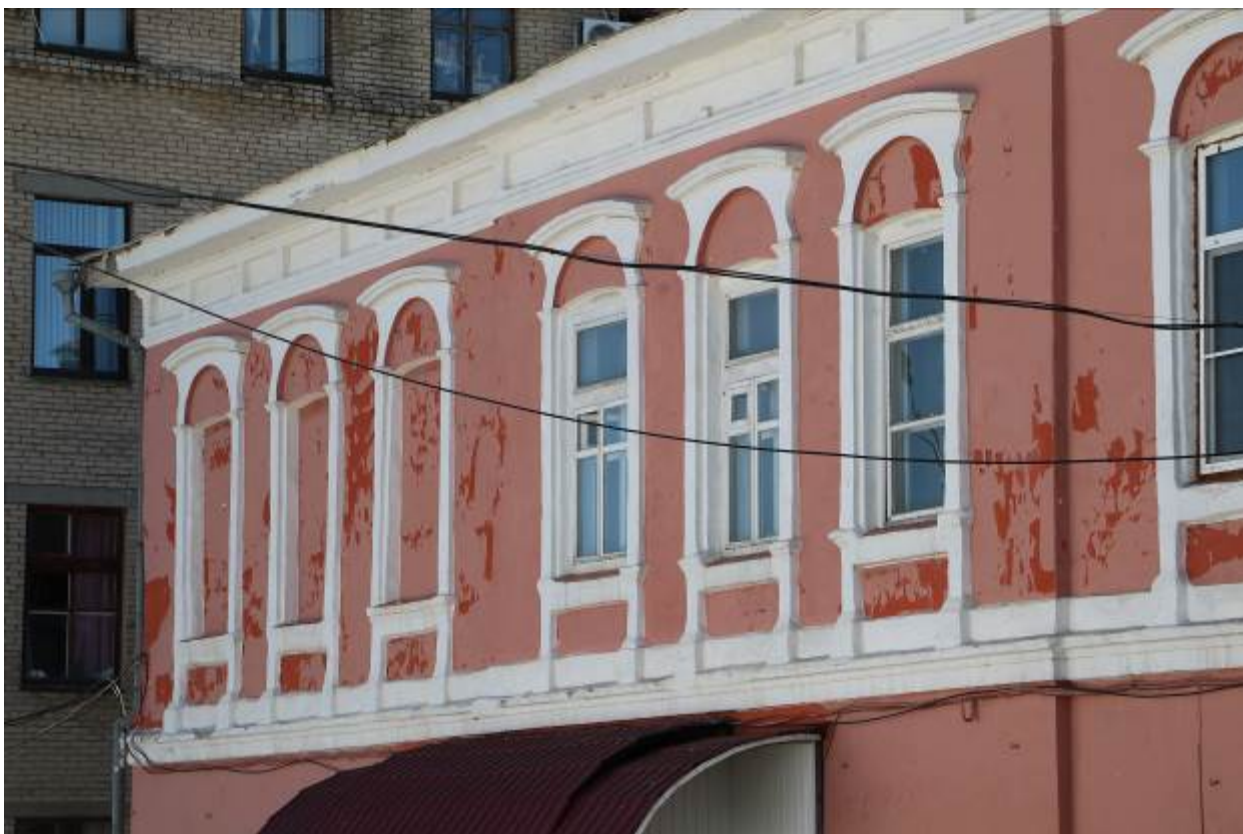
Окна второго этажа бокового фасада Объекта. Вид с 3.
