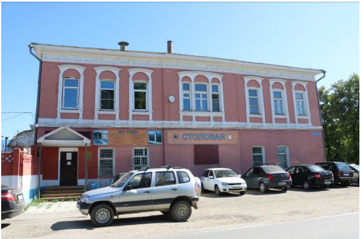
Фасад Объекта, выходящий на ул. Революции. Вид с ЮЗ.
