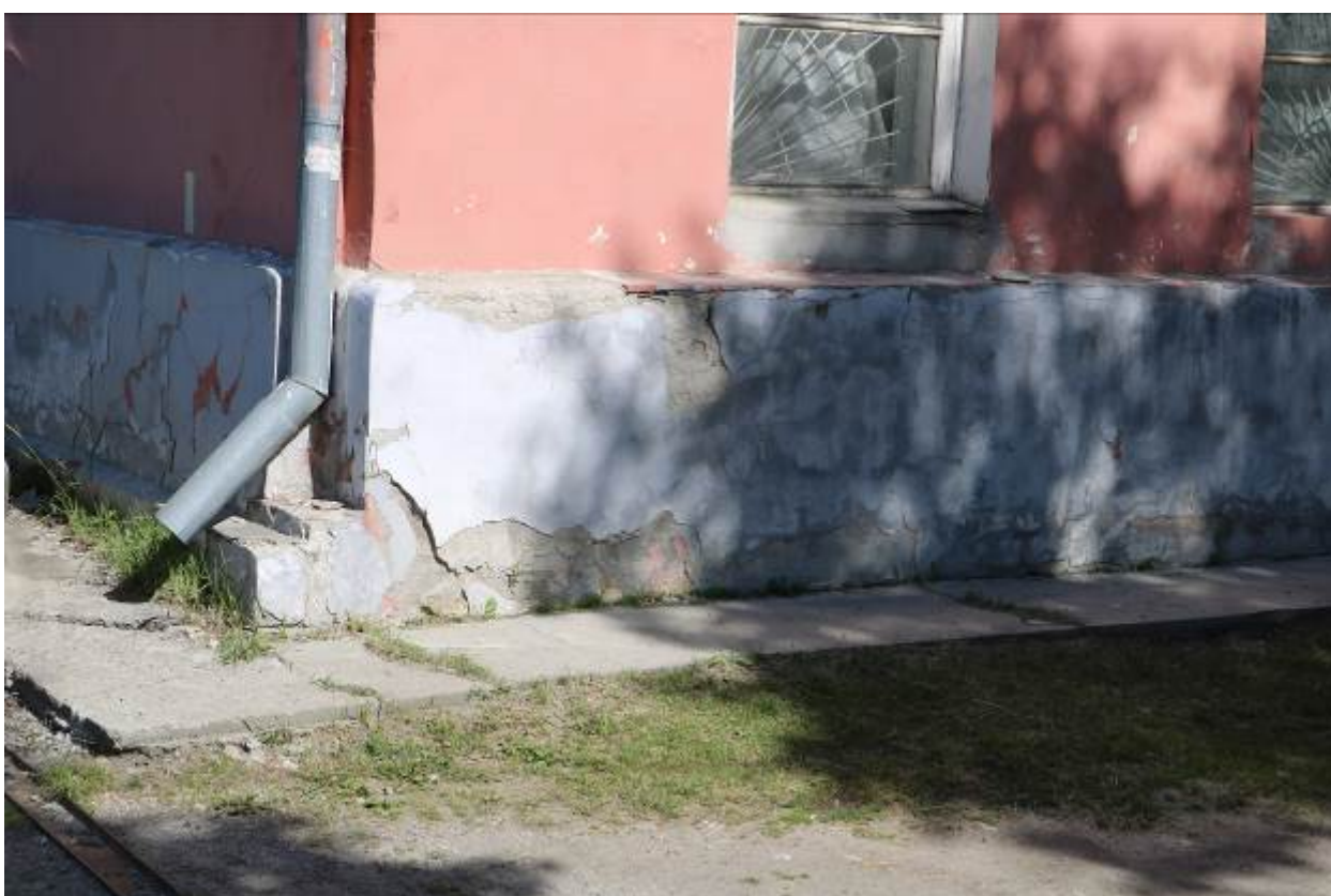
Цоколь Объекта. Вид с Ю.
