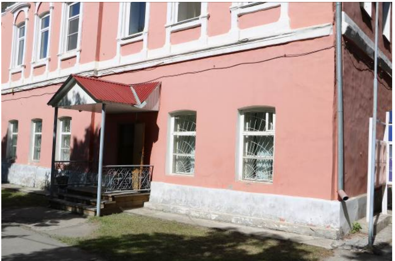
Современный вход в здание, расположенный со стороны ул. Советской. Вид с ЮВ.
