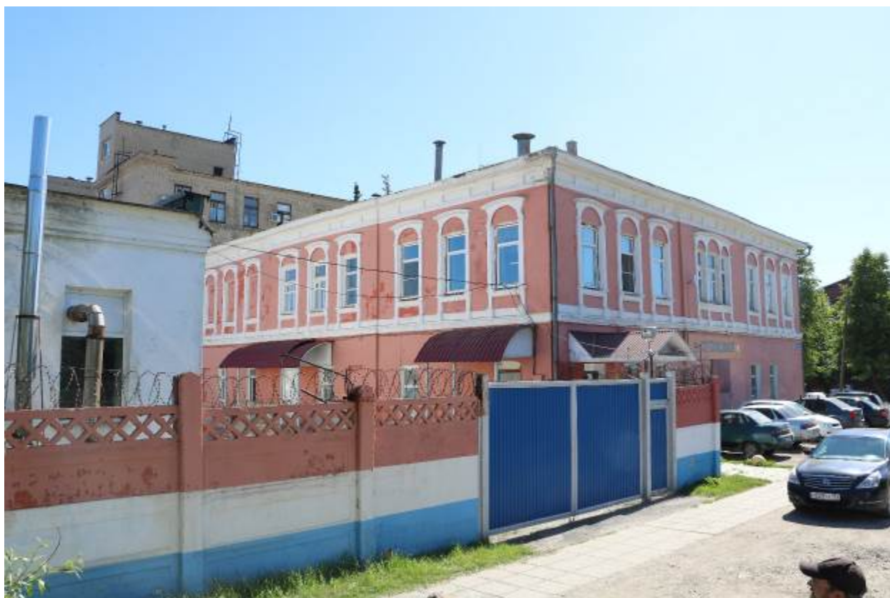
Рис. 2. Вид на здание с северо-запада при движении по ул. Революции
