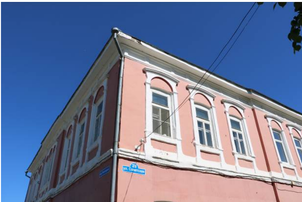
Окна второго этажа фасадов Объекта, выходящих на улицы Советскую и Революции. Вид с Ю.
