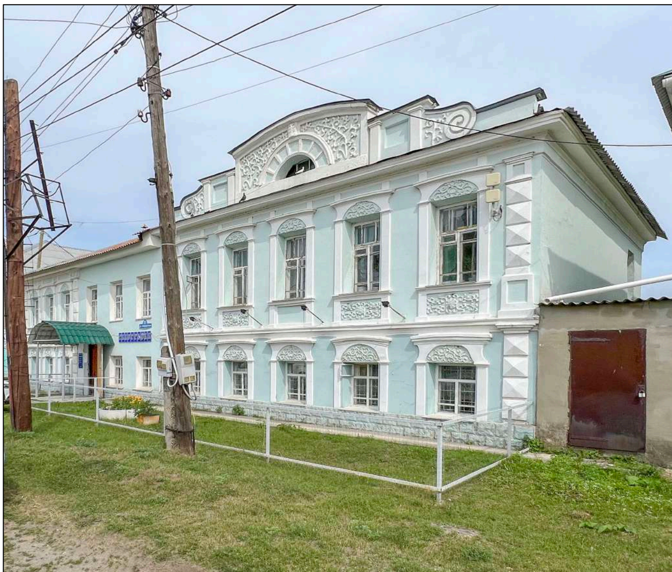
2. Общий вид на фасад Объекта.
