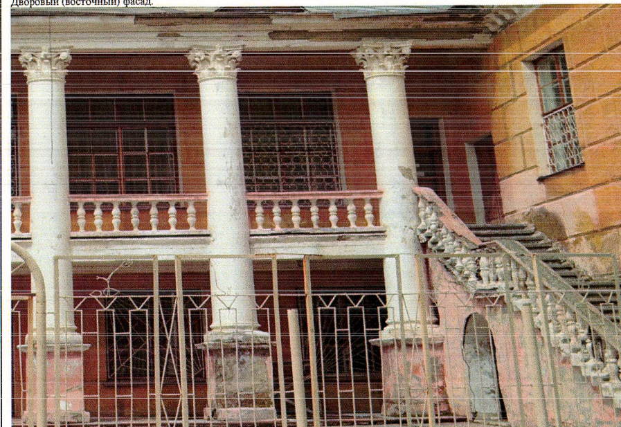
Фрагмент дворового (восточного) фасада.
