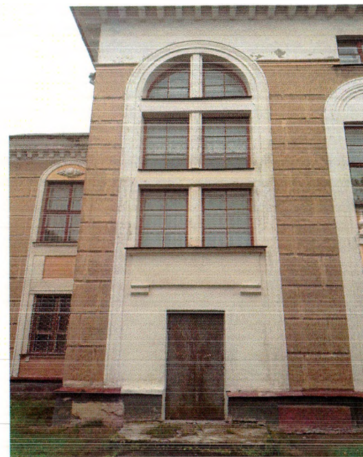
Вид на правый фланг северного фасада.
