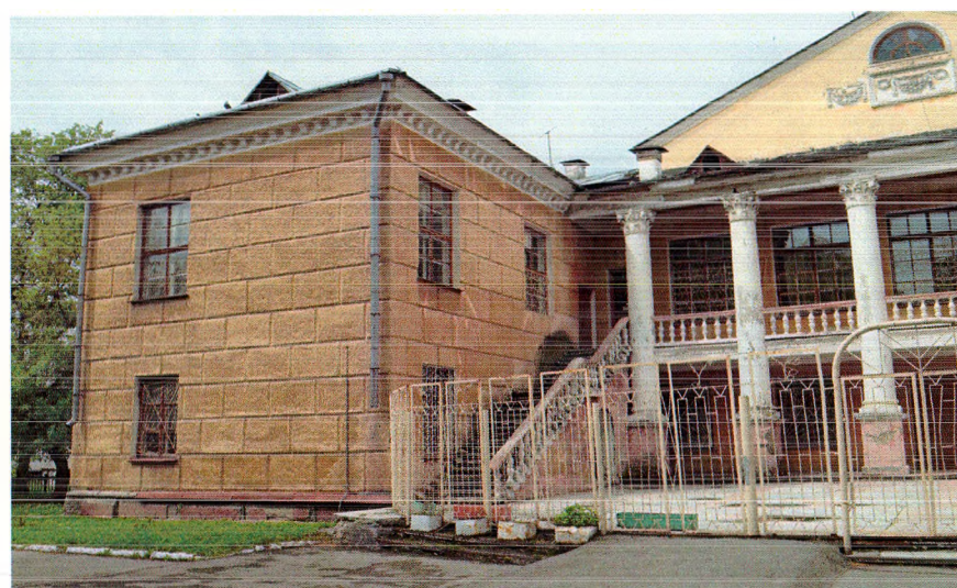
Фрагмент дворового (восточного) фасада.
