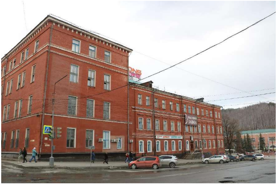
Фото 8. Южный фасад по ул. Ленина. Северо-восточное направление
