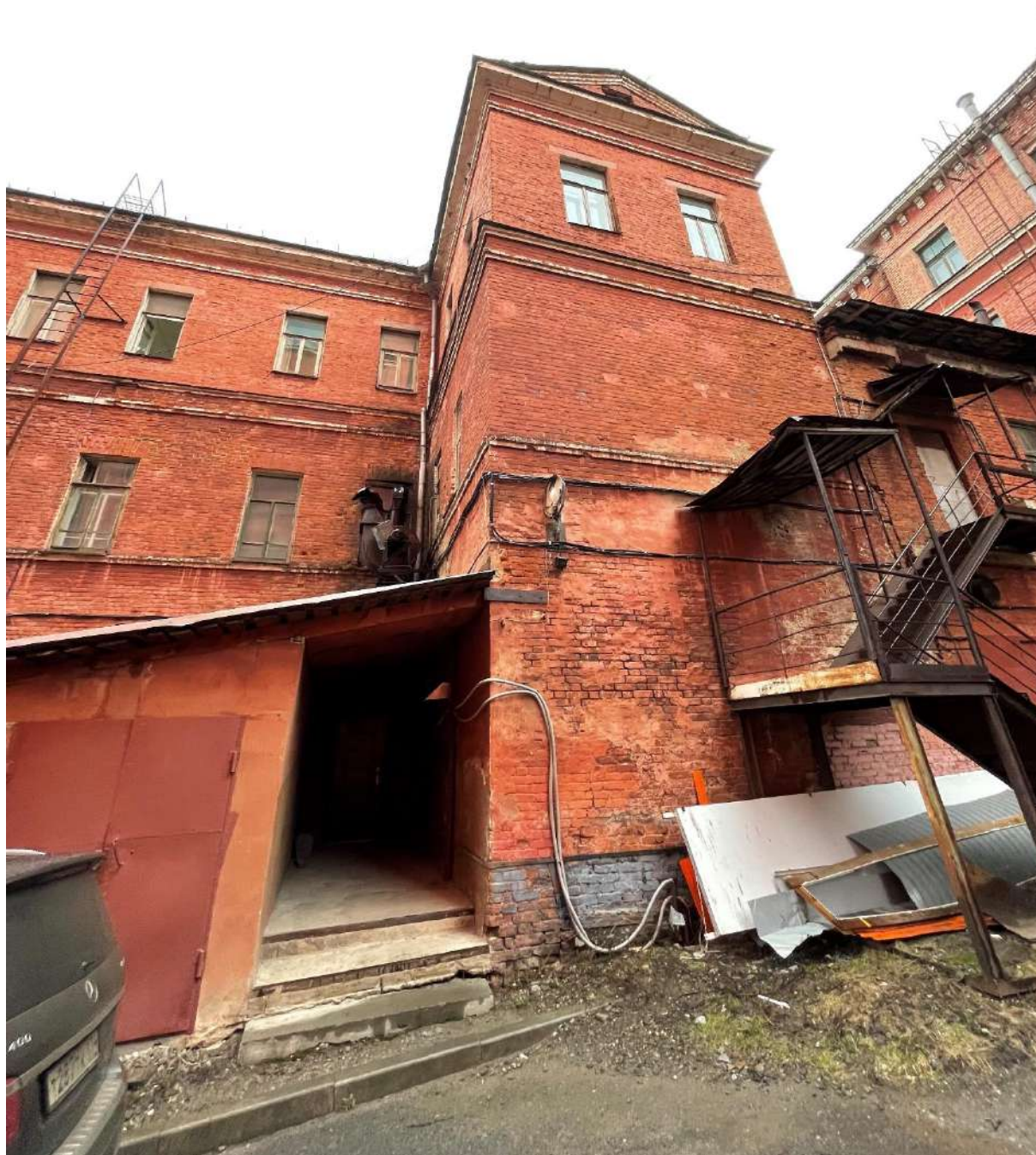
Фото 13. Объект культурного наследия. Общий вид с С. Фрагмент фасада.
