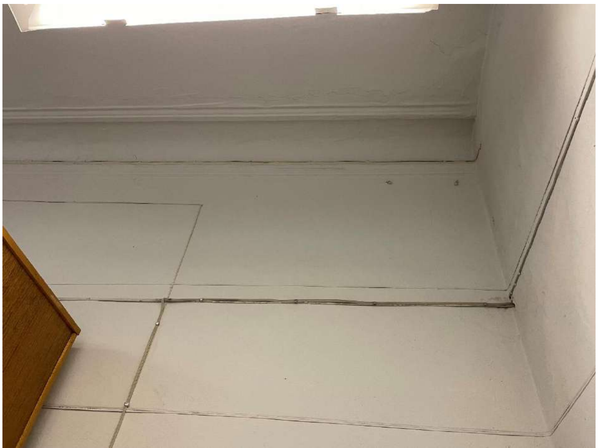
Фото 60. Объект культурного наследия. Внутренние помещения.
