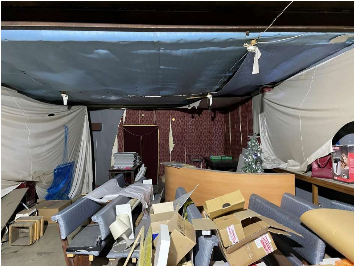
Фото 82. Объект культурного наследия. Внутренние помещения.
