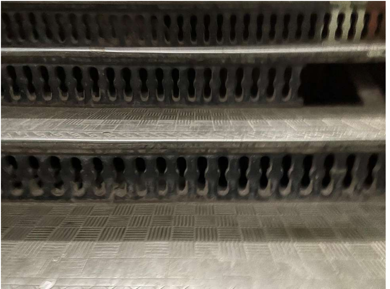
Фото 68. Объект культурного наследия. Внутренние помещения. Фрагмент лестницы.
