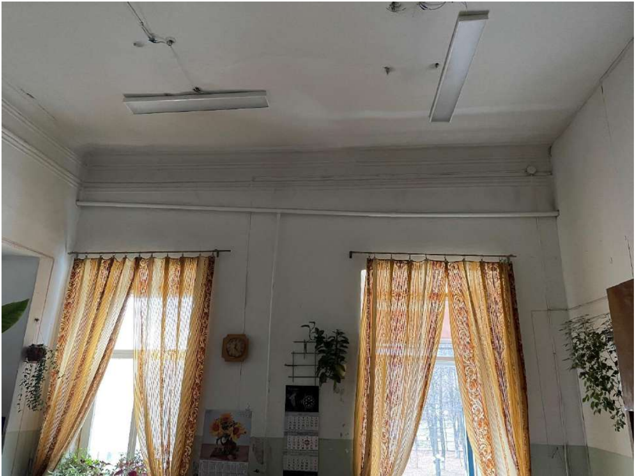
Фото 53. Объект культурного наследия. Внутренние помещения.
