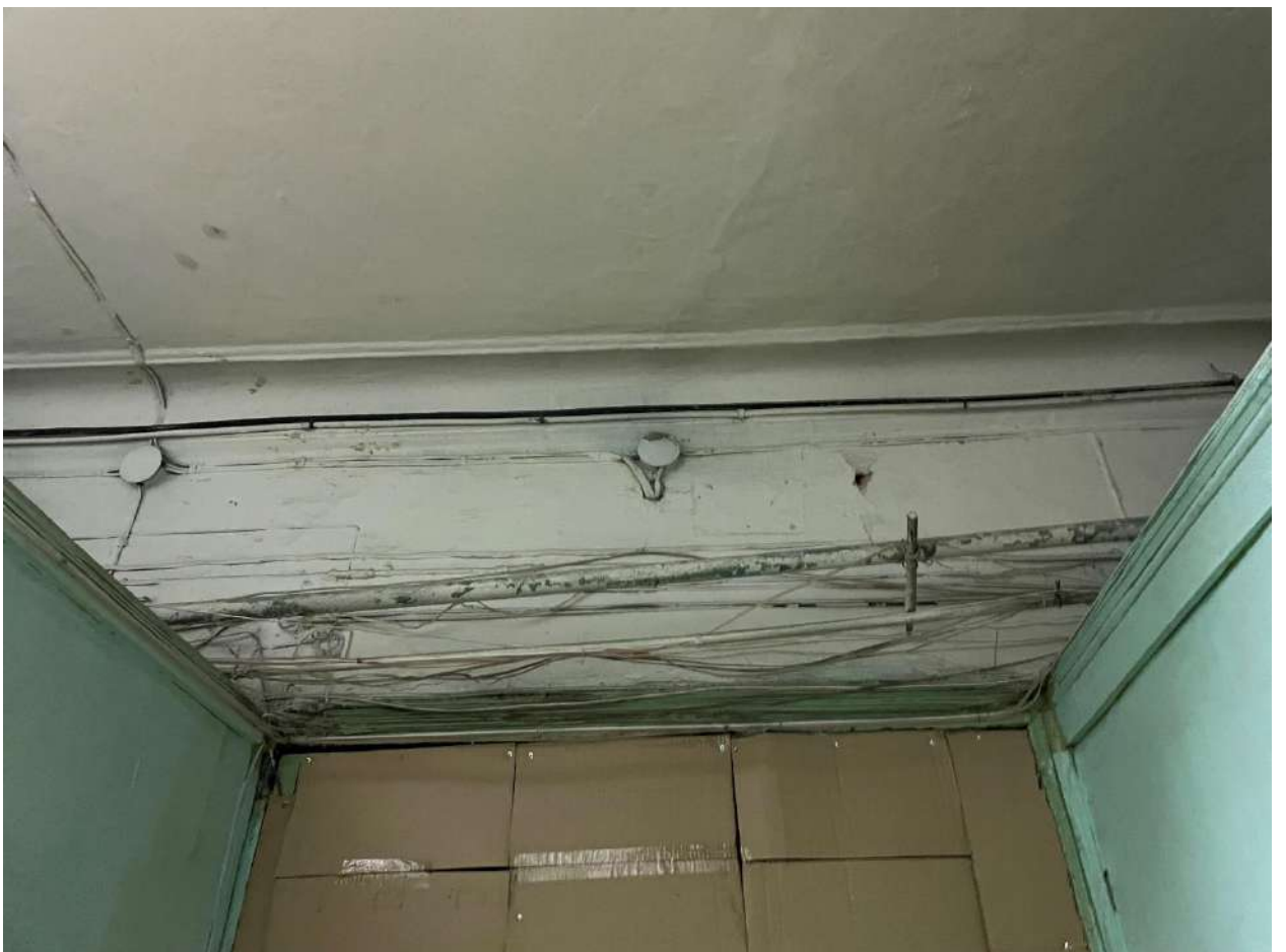
Фото 69. Объект культурного наследия. Внутренние помещения.
