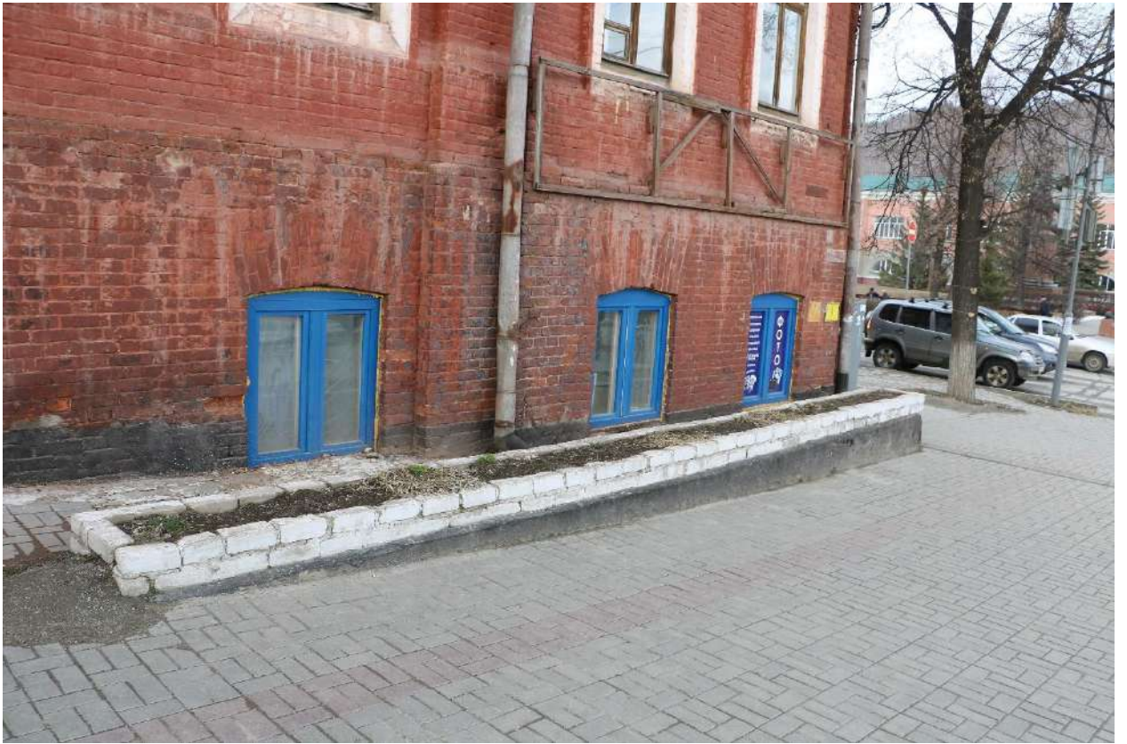
Фото 21. Объект культурного наследия. Фрагмент нижней части фасада.
