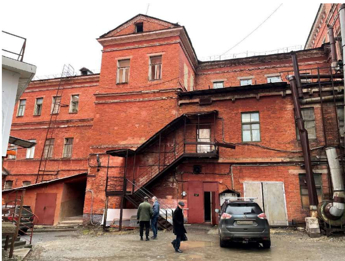
Фото 29. Фрагмент северного фасада.
