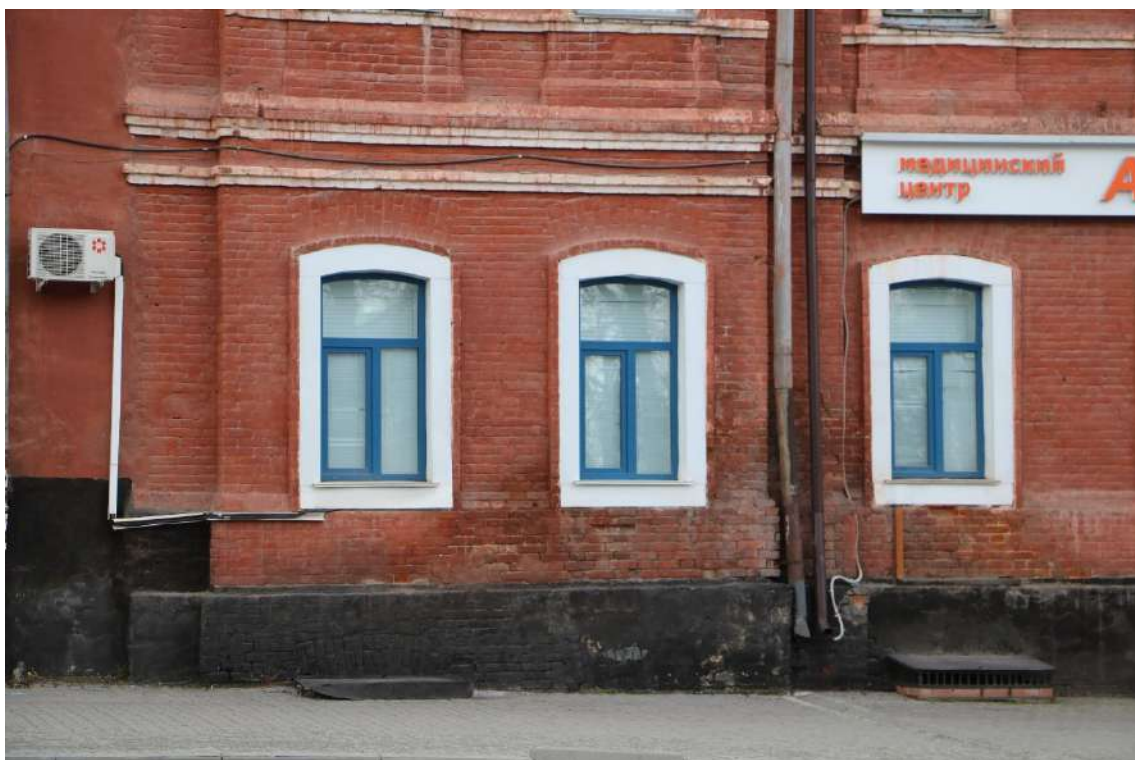
Фото 21. Фрагмент южного фасада. Окна первого этажа
