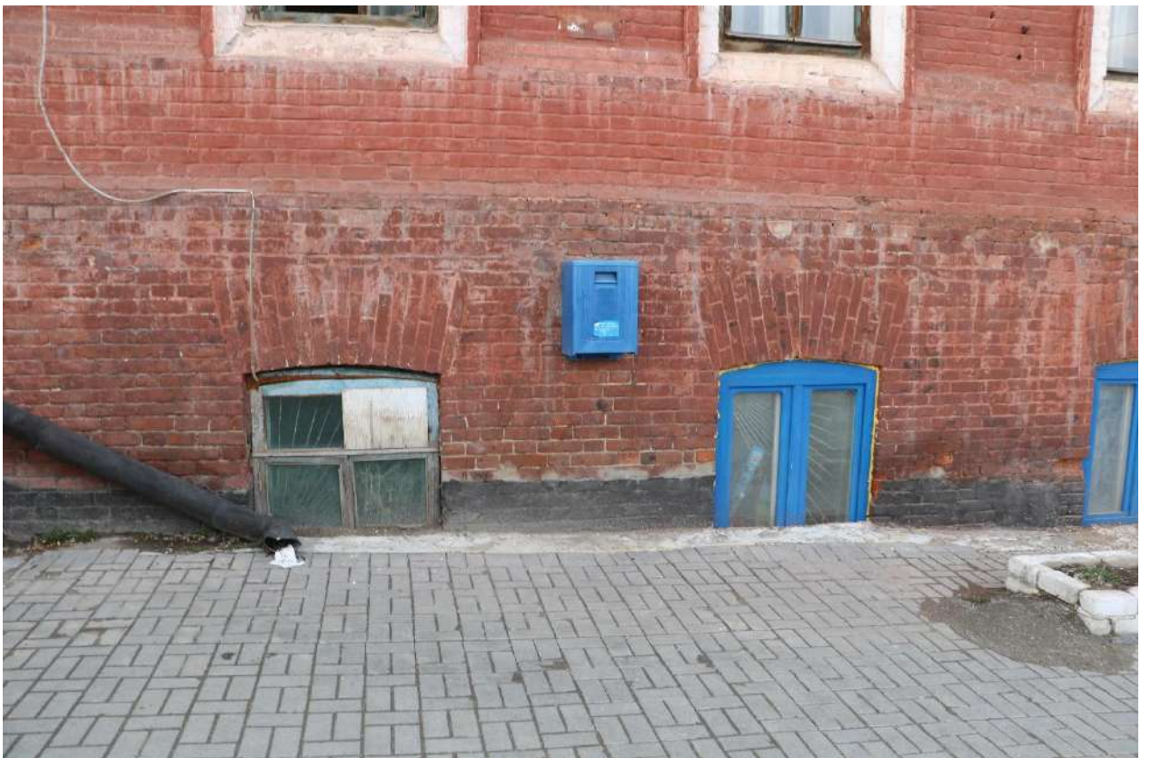
Фото 19. Объект культурного наследия. Главный вход. Фрагмент нижней части фасада.
