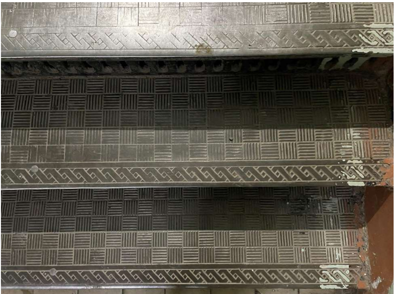
Фото 64. Объект культурного наследия. Внутренние помещения. Фрагмент лестницы.
