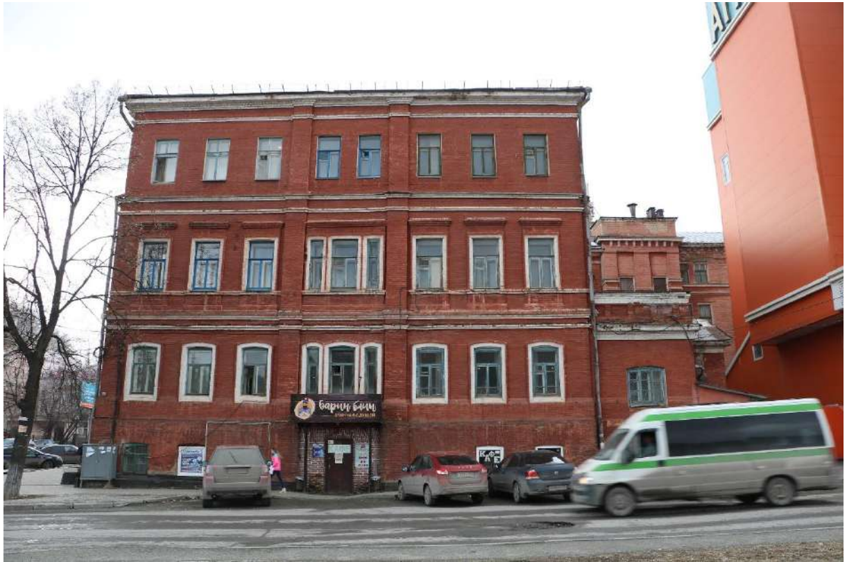
Фото 10. Западный фасад по ул. Златоустовская. Западное направление.
