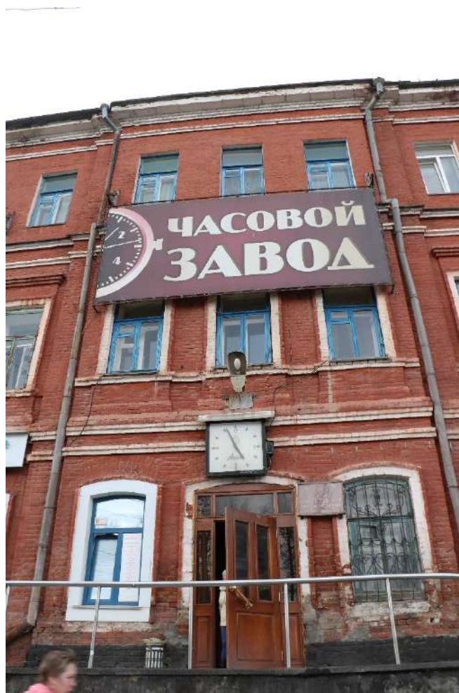
Фото 19. Фрагмент южного фасада
