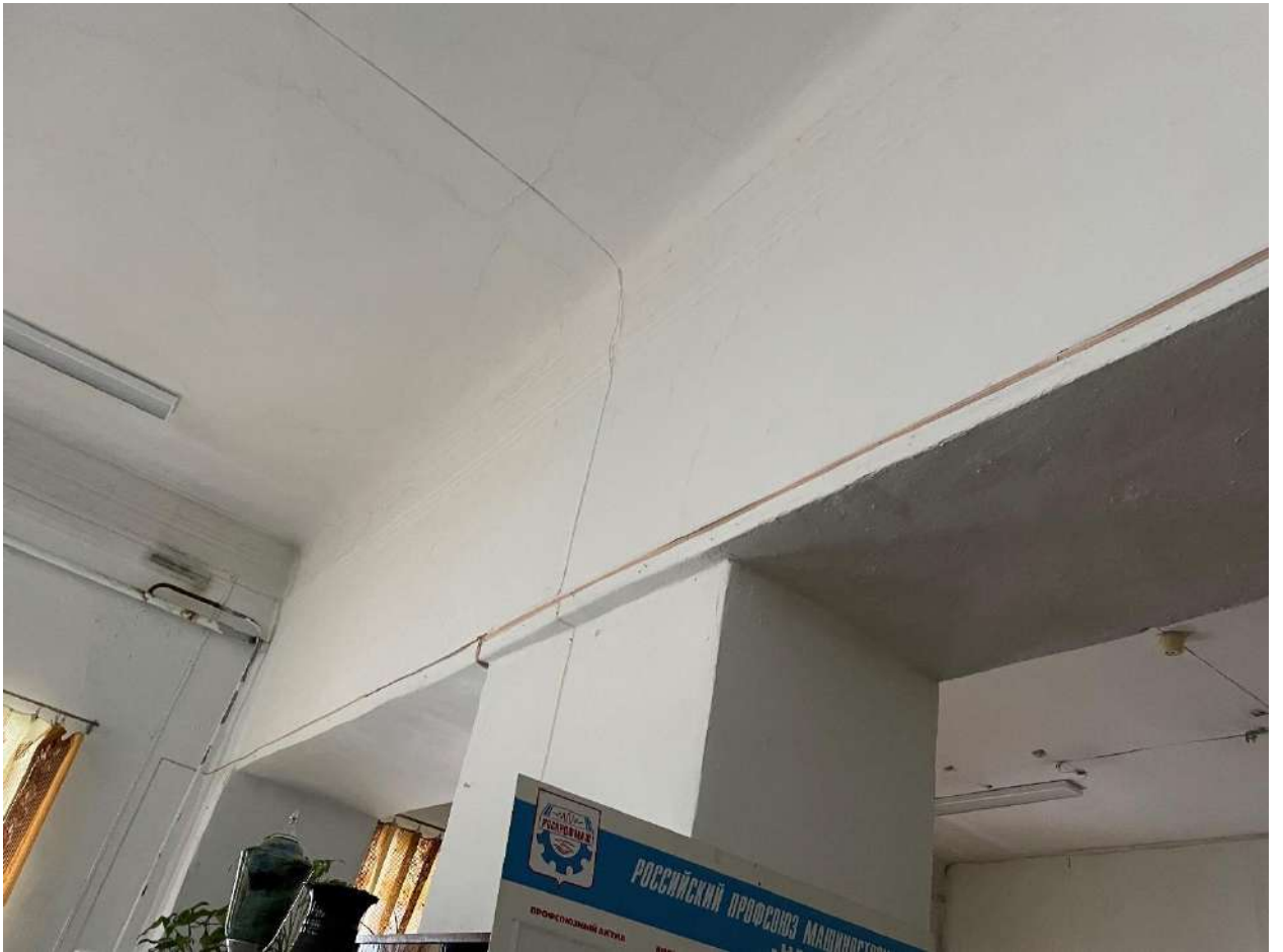
Фото 51. Объект культурного наследия. Внутренние помещения.
