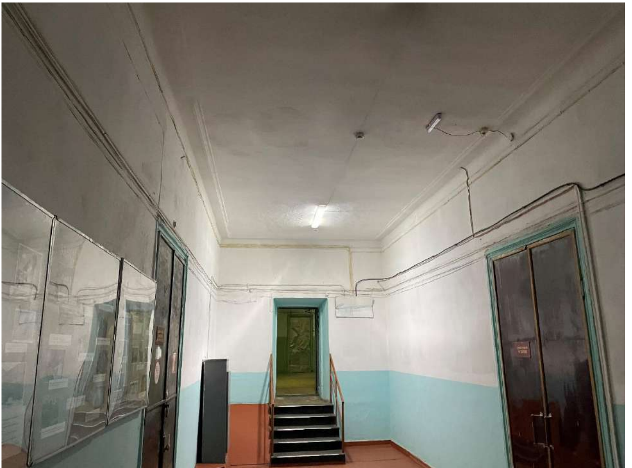
Фото 58. Объект культурного наследия. Внутренние помещения.
