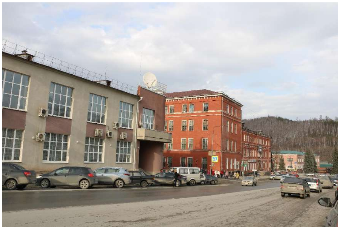
Фото 7. Южный фасад по ул. Ленина. Северо-восточное направление
