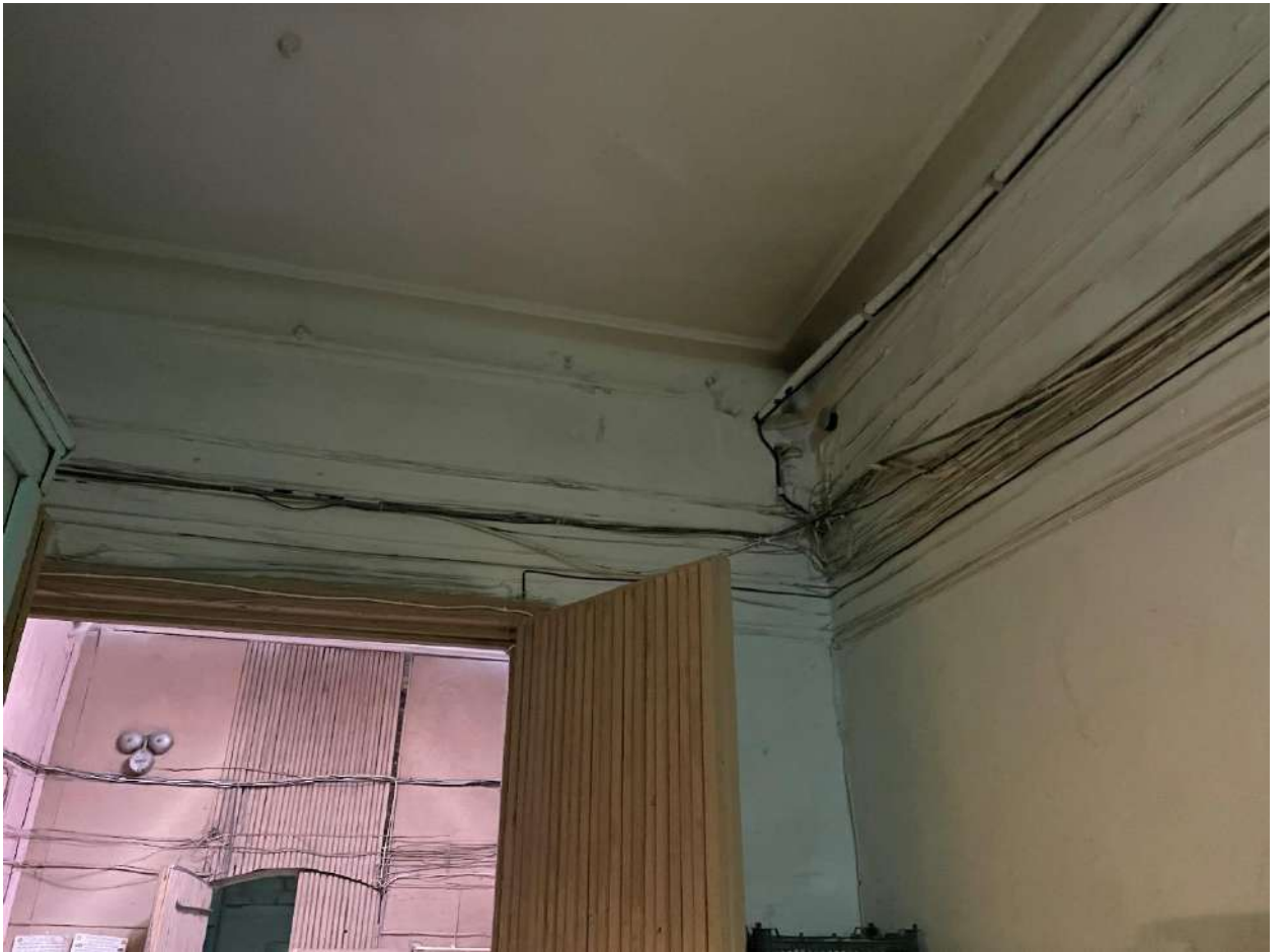
Фото 72. Объект культурного наследия. Внутренние помещения.
