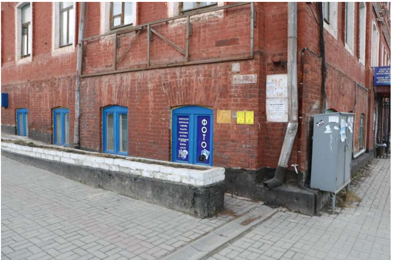
Фото 22. Объект культурного наследия. Фрагмент нижней части фасада.
