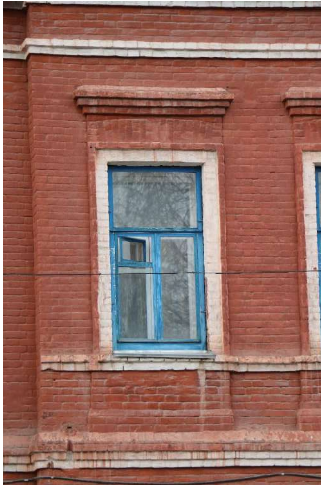
Фото 22. Фрагмент южного фасада. Окна второго этажа
