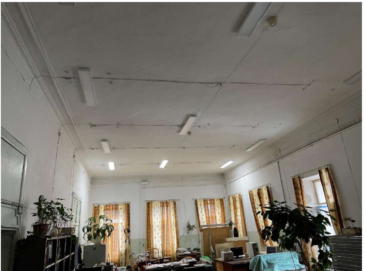
Фото 50. Объект культурного наследия. Внутренние помещения.
