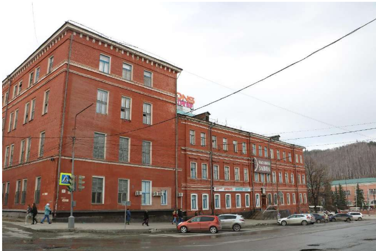
Фото 1. Объект культурного наследия. Общий вид с Ю.
