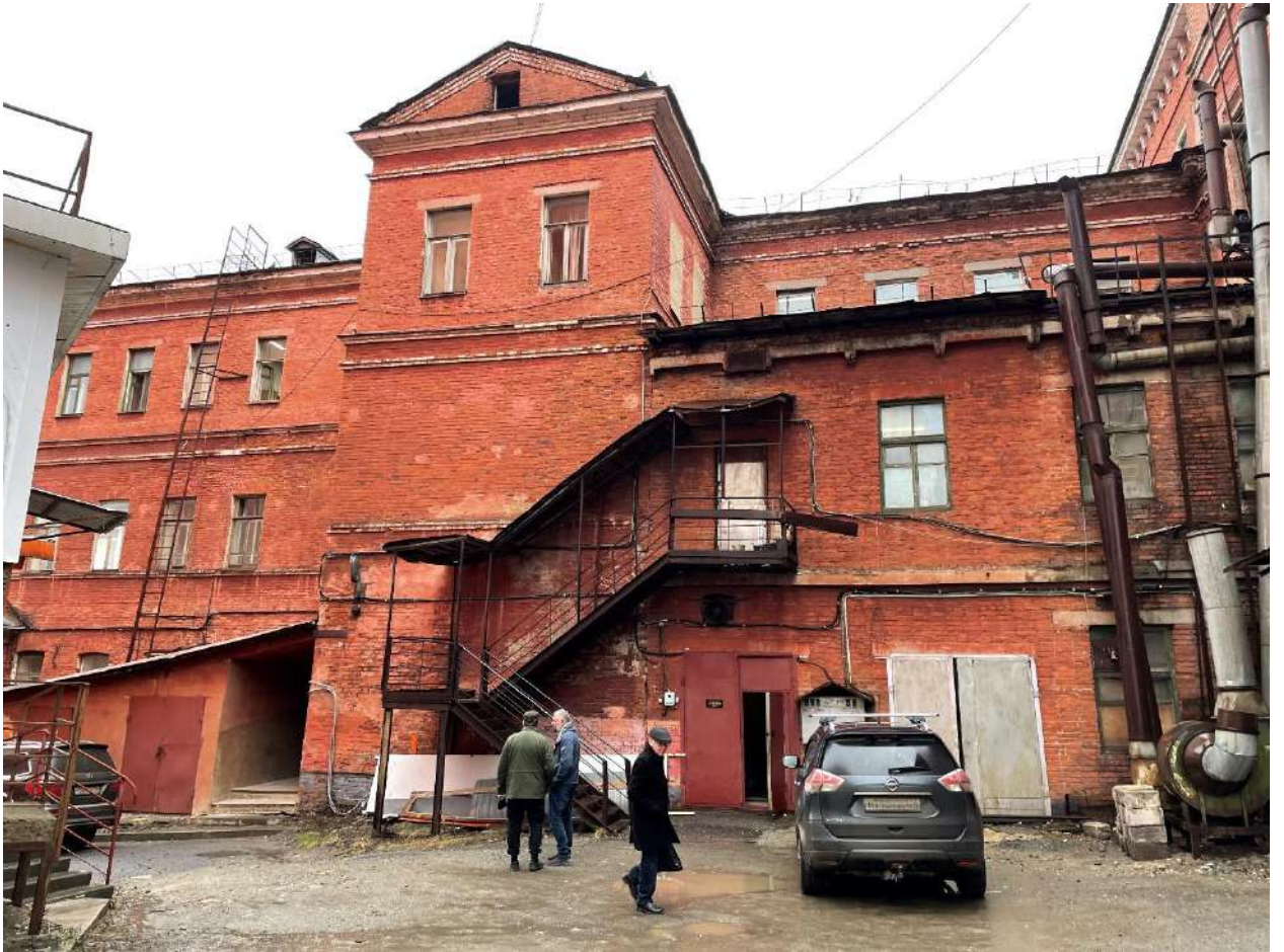
Фото 14. Объект культурного наследия. Общий вид с С. Фрагмент фасада.
