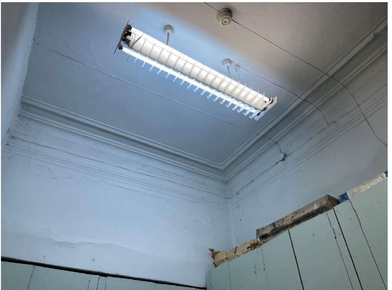
Фото 54. Объект культурного наследия. Внутренние помещения.
