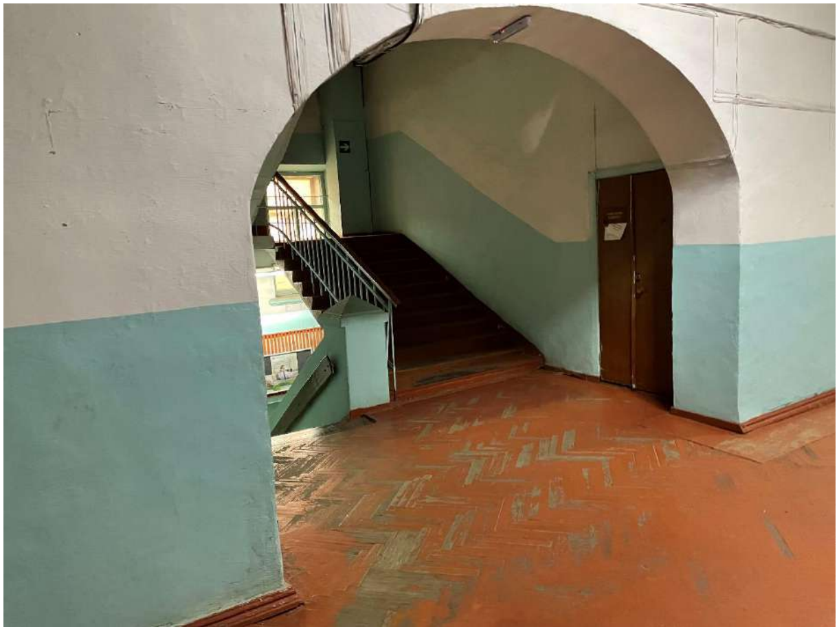
Фото 59. Объект культурного наследия. Внутренние помещения.
