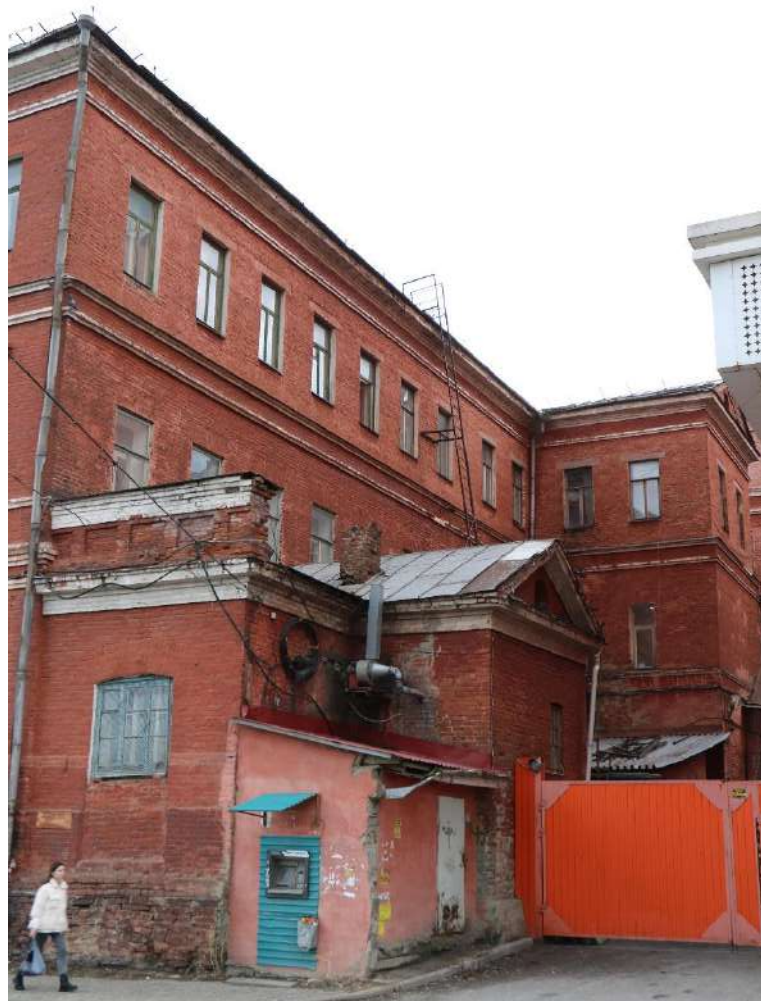
Фото 27. Фрагмент северного фасада.
