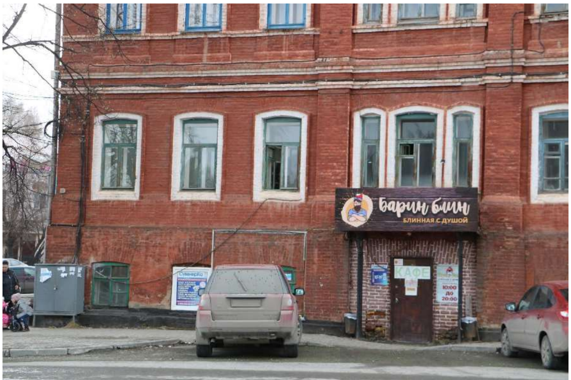
Фото 25. Фрагмент восточного фасада.
