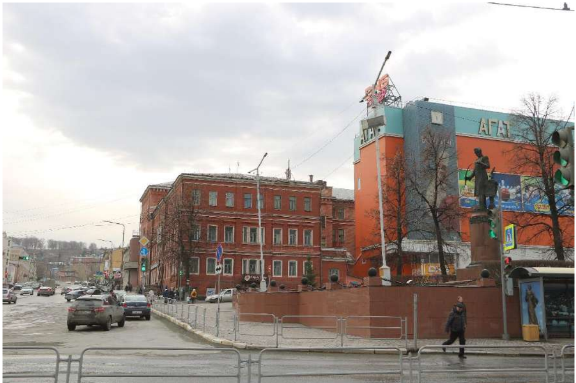
Фото 11. Западный фасад по ул. Златоустовская. Западное направление.
