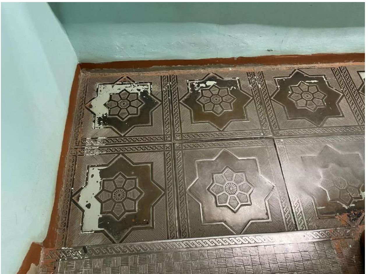
Фото 62. Объект культурного наследия. Внутренние помещения. Фрагмент лестницы.
