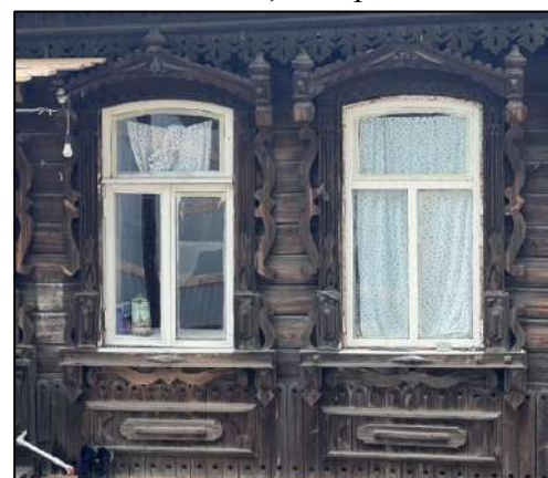
Оформление оконных проемов
