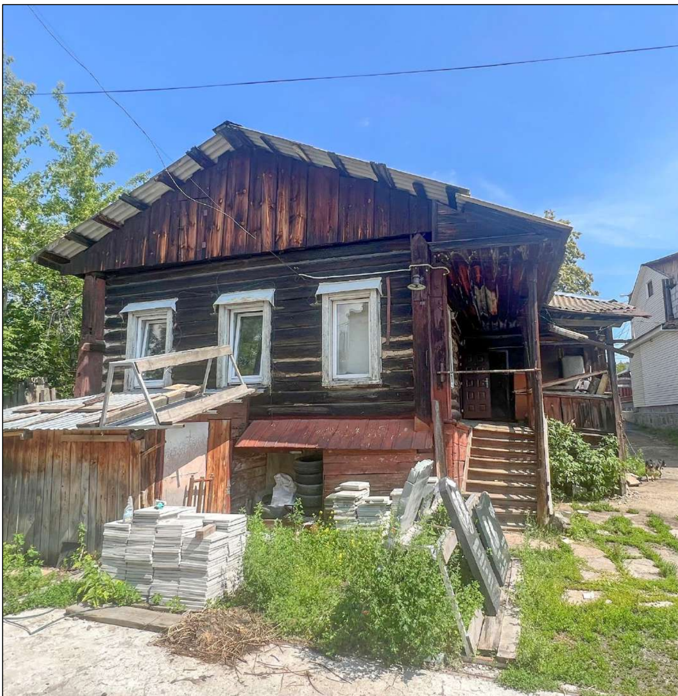
8. Общий вид на Объект.
