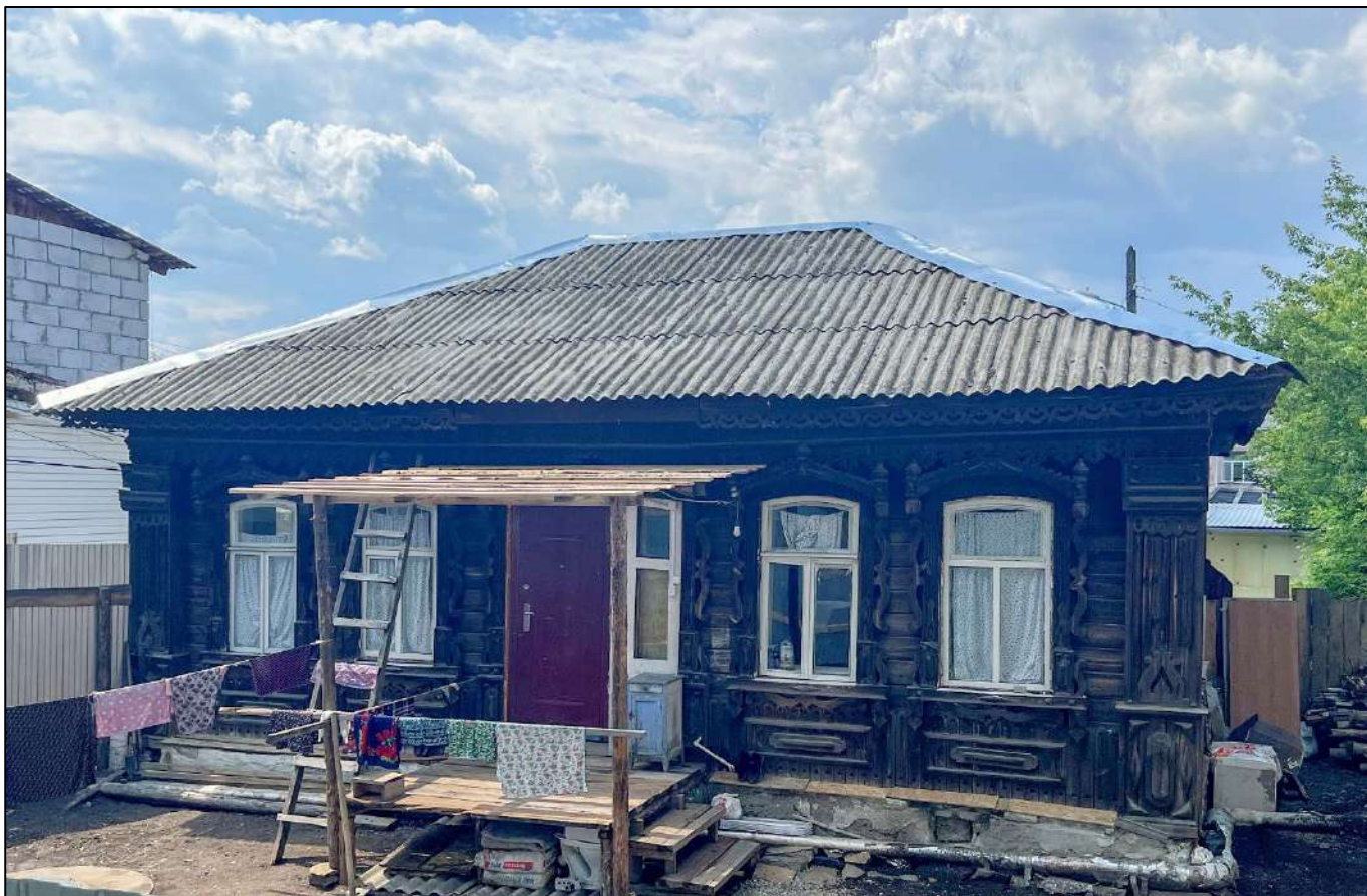
1. Общий вид на Объект.
