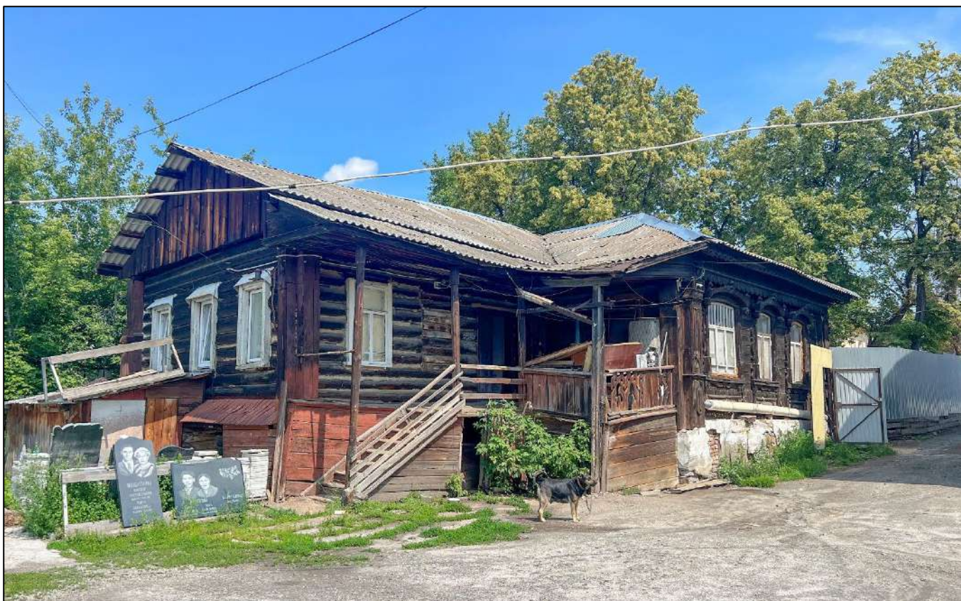
5. Общий вид на Объект.
