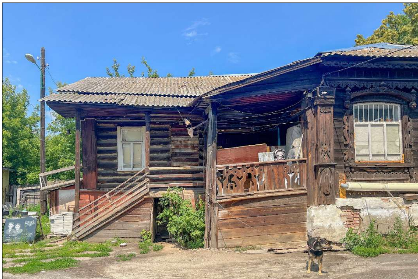
7. Фрагмент фасада Объекта.
