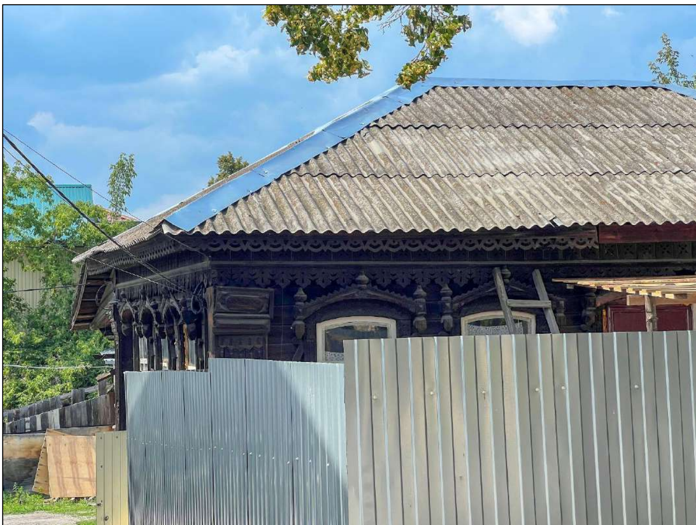
2. Фрагмент фасада Объекта.
