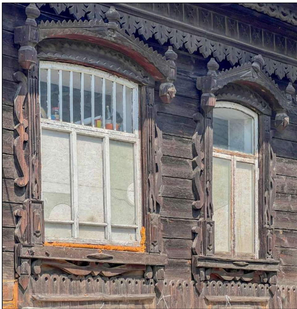
13. Фрагмент декоративного убранства фасада Объекта.
