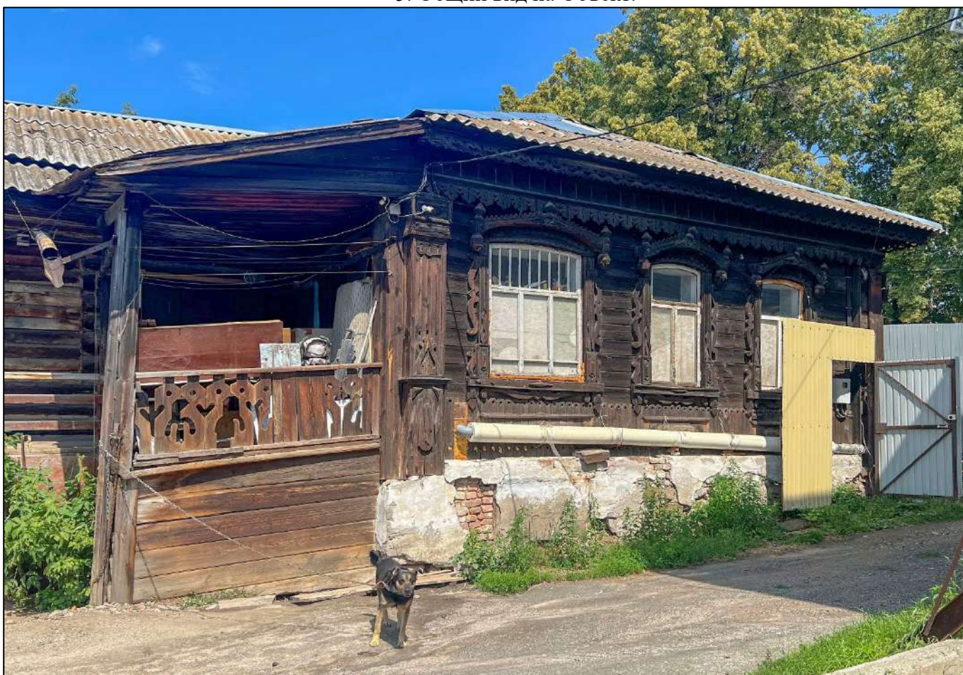
6. Фрагмент фасада Объекта.
