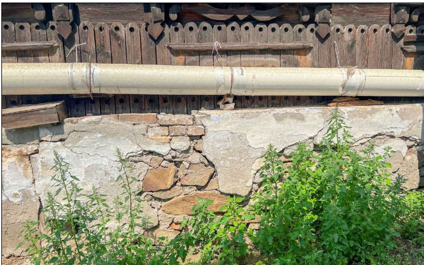
14. Фрагмент декоративного убранства фасада Объекта.
