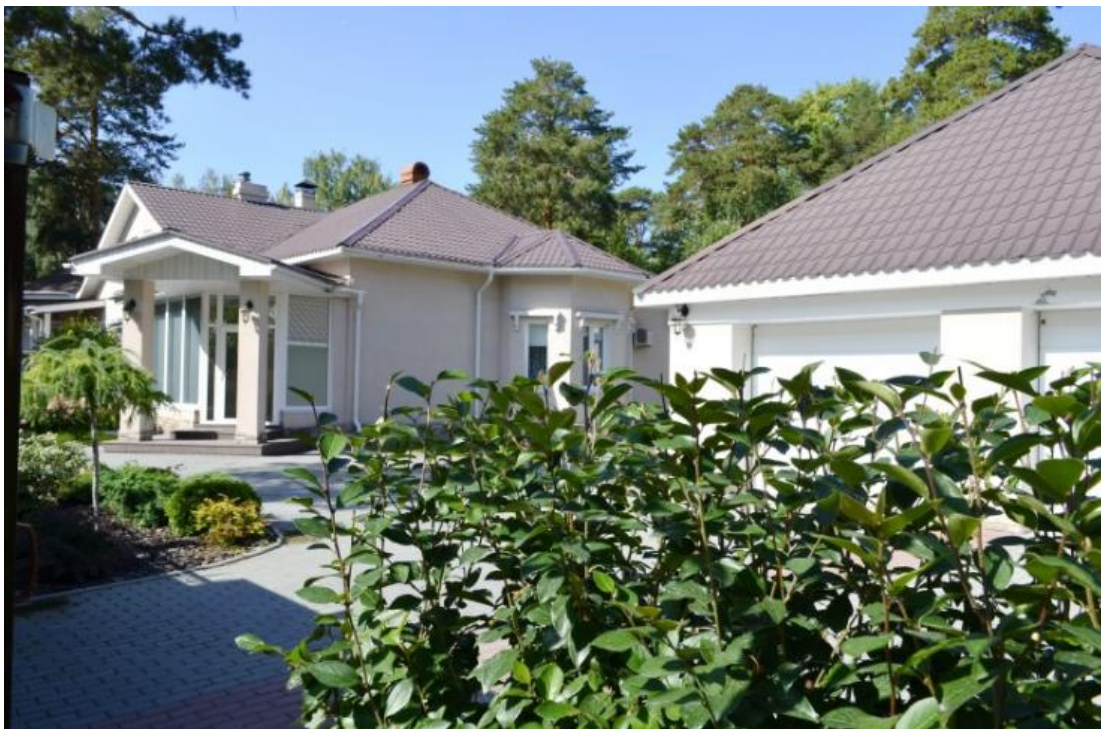
Фото 3. Вид с юго-восточной стороны на здание по адресу: Челябинска область, г. Озерск, ул. Царевского, д. 6
