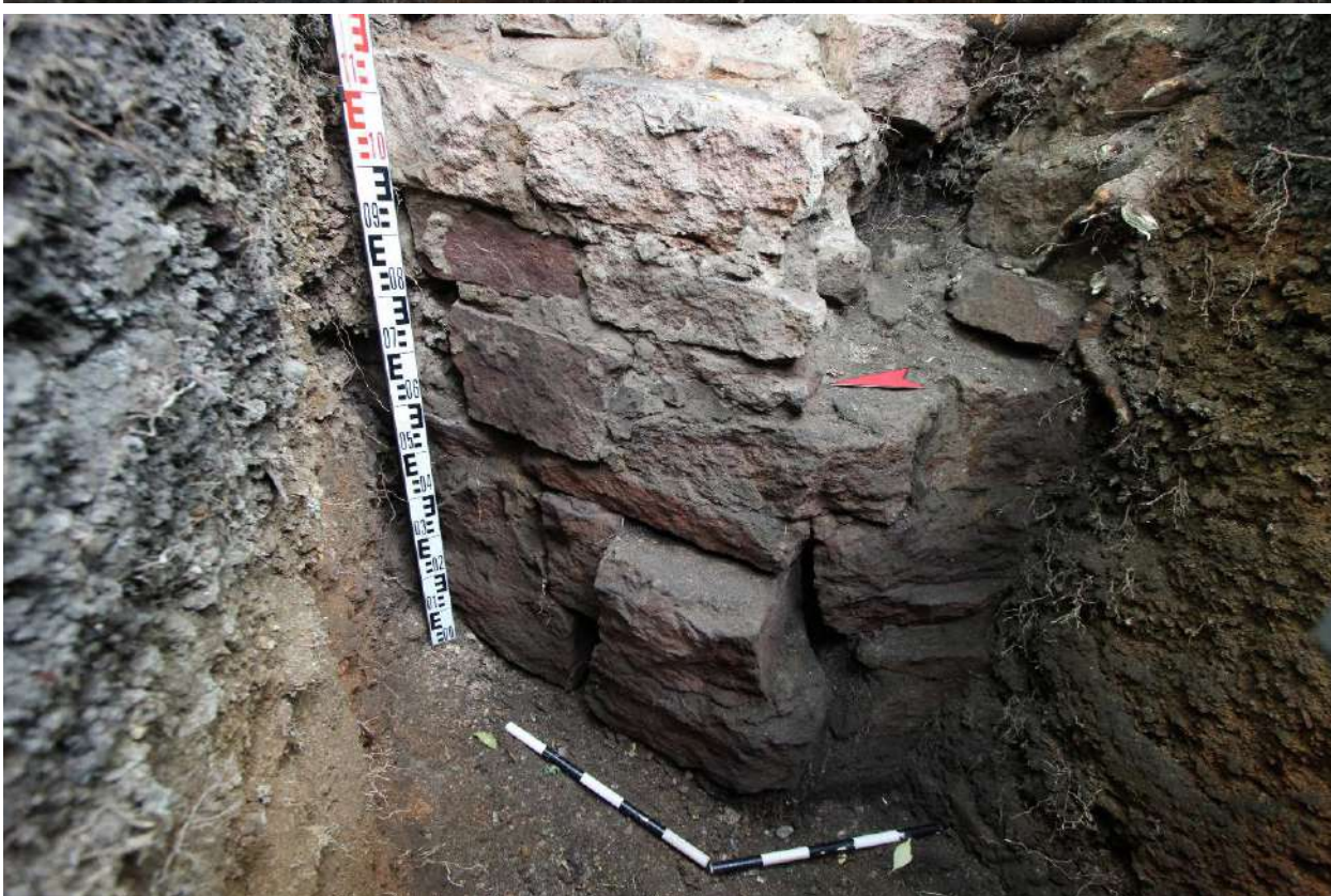
Рис. 12 а, б. Шурф № 2 с фиксацией подземной части подпорной стены. Источник: Раздел «Обеспечение сохранности объекта культурного наследия «Культурный слой г. Челябинска XVIII – XIX вв.»... с. 111.
