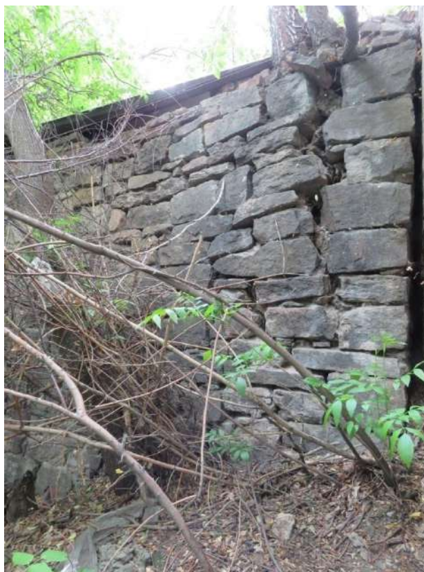
Рис. 6. Подпорная стенка дрожже-винокуренного завода Аникиных. Фрагмент кладки западной стены
