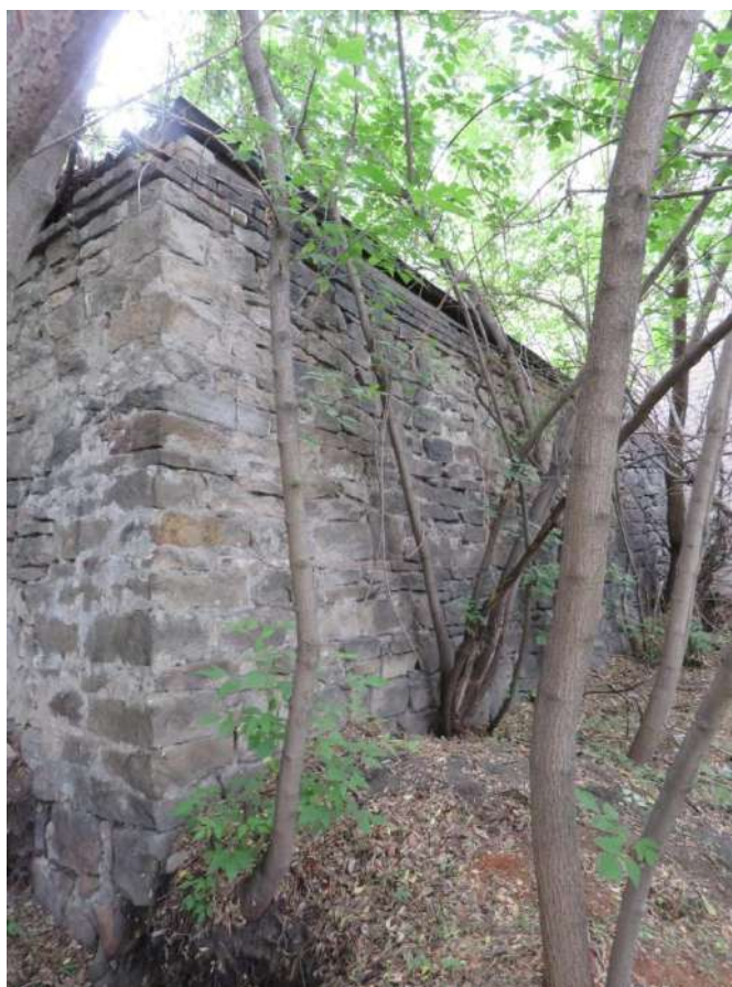
Рис. 4. Подпорная стенка дрожже-винокуренного завода Аникиных. Общий вид западной стены
