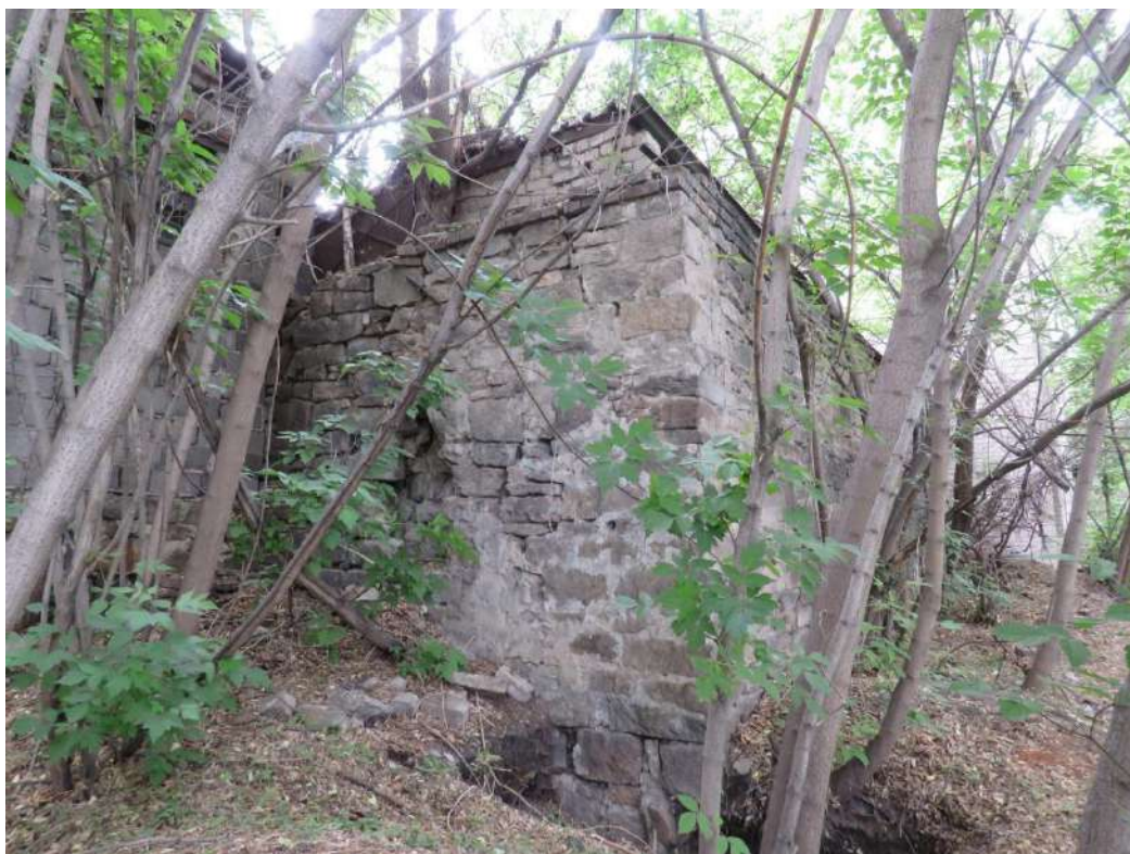
Рис. 1. Подпорная стенка дрожже-винокуренного завода Аникиных. Общий вид с севера.
