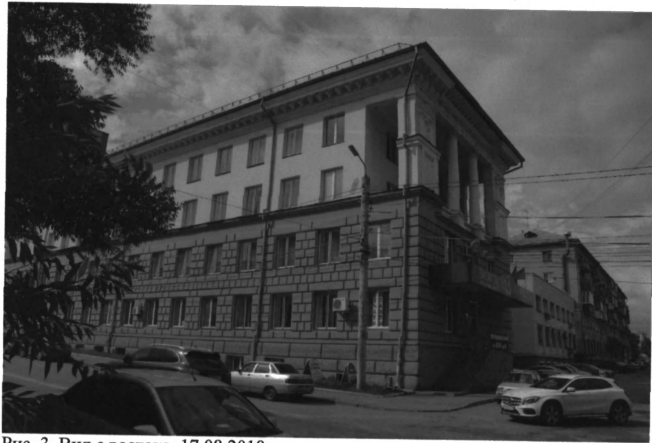
Рис. 3. Вид с востока. 17.08.2018 г.
