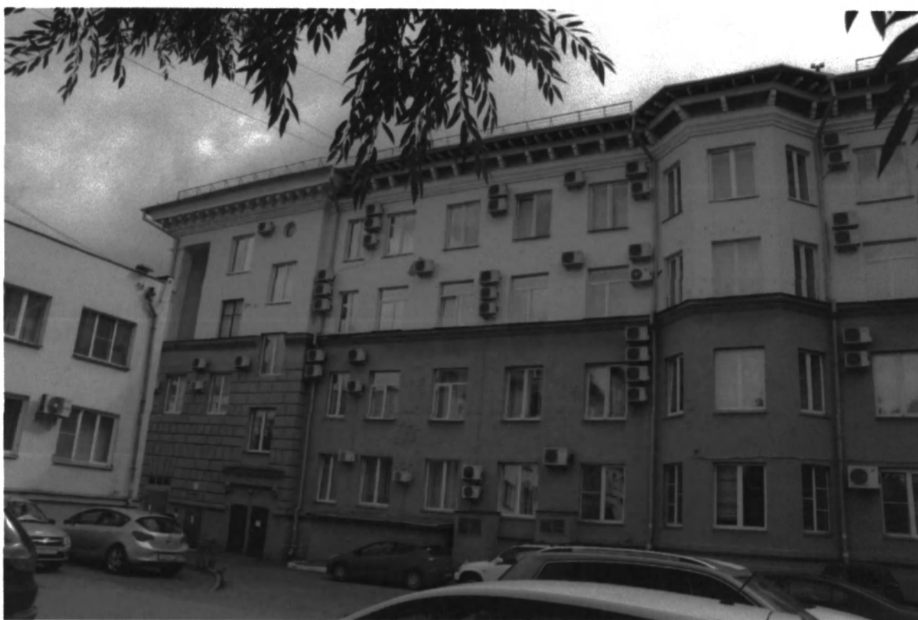
Рис. 5. Вид с северо-запада. Дворовой фасад. 17.08.2018 г.
