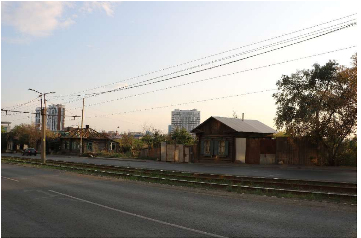
Фото 3. Объект культурного наследия. Общий вид с В.
