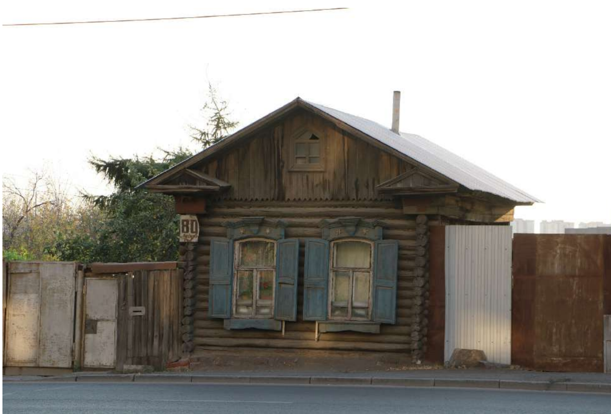
Фото 2. Объект культурного наследия. Общий вид с В.
