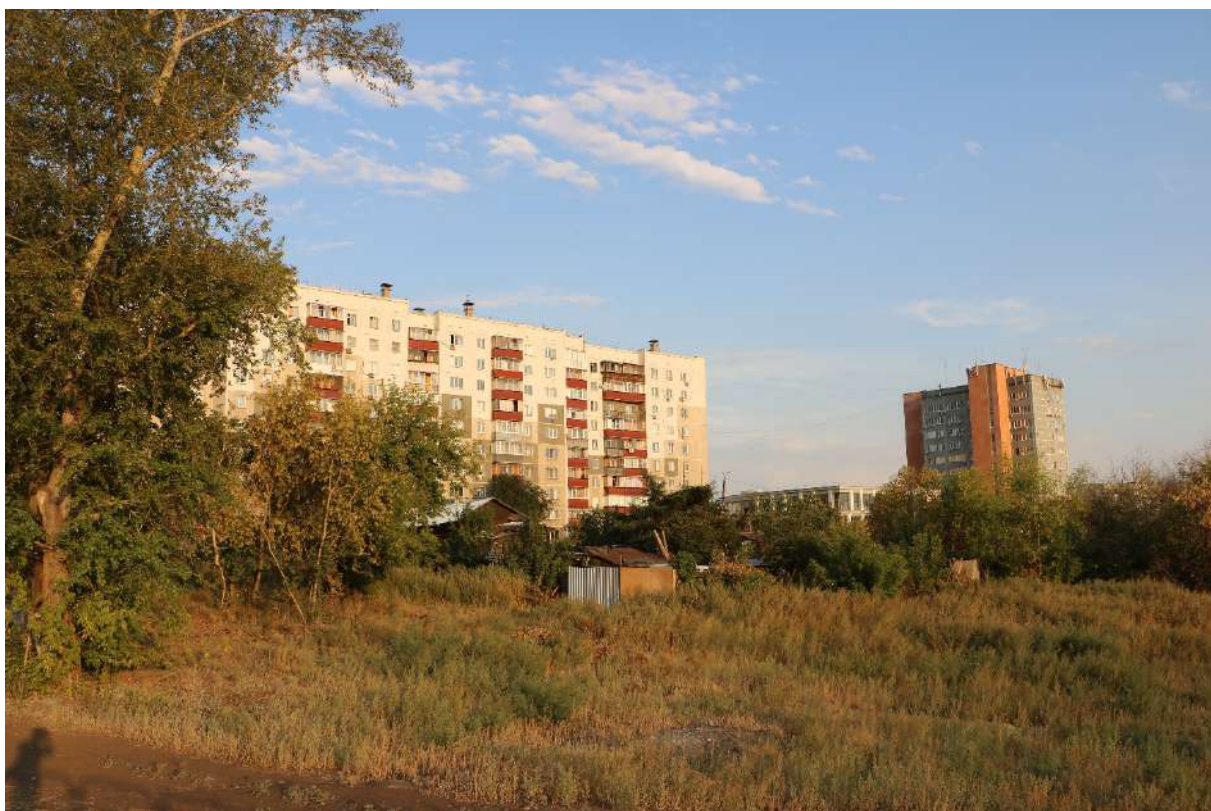
Рис. 19. Вид на объект с северо-запада (комфортный вид восприятия).
