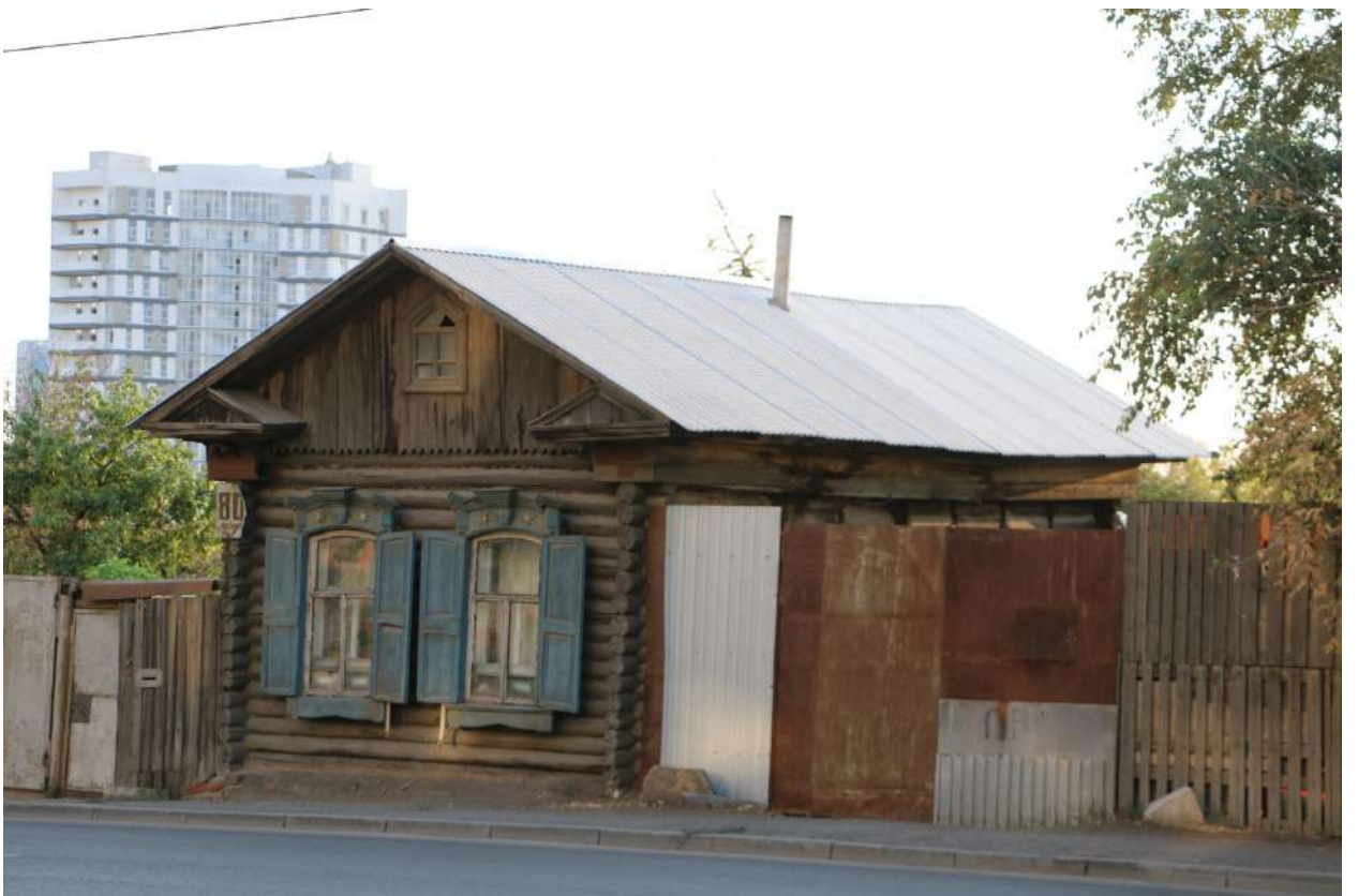
Фото 4. Объект культурного наследия. Общий вид с В.
