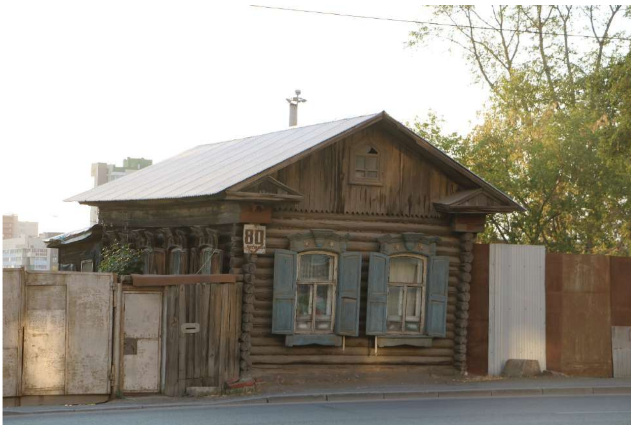
Фото 1. Объект культурного наследия. Общий вид с В.
