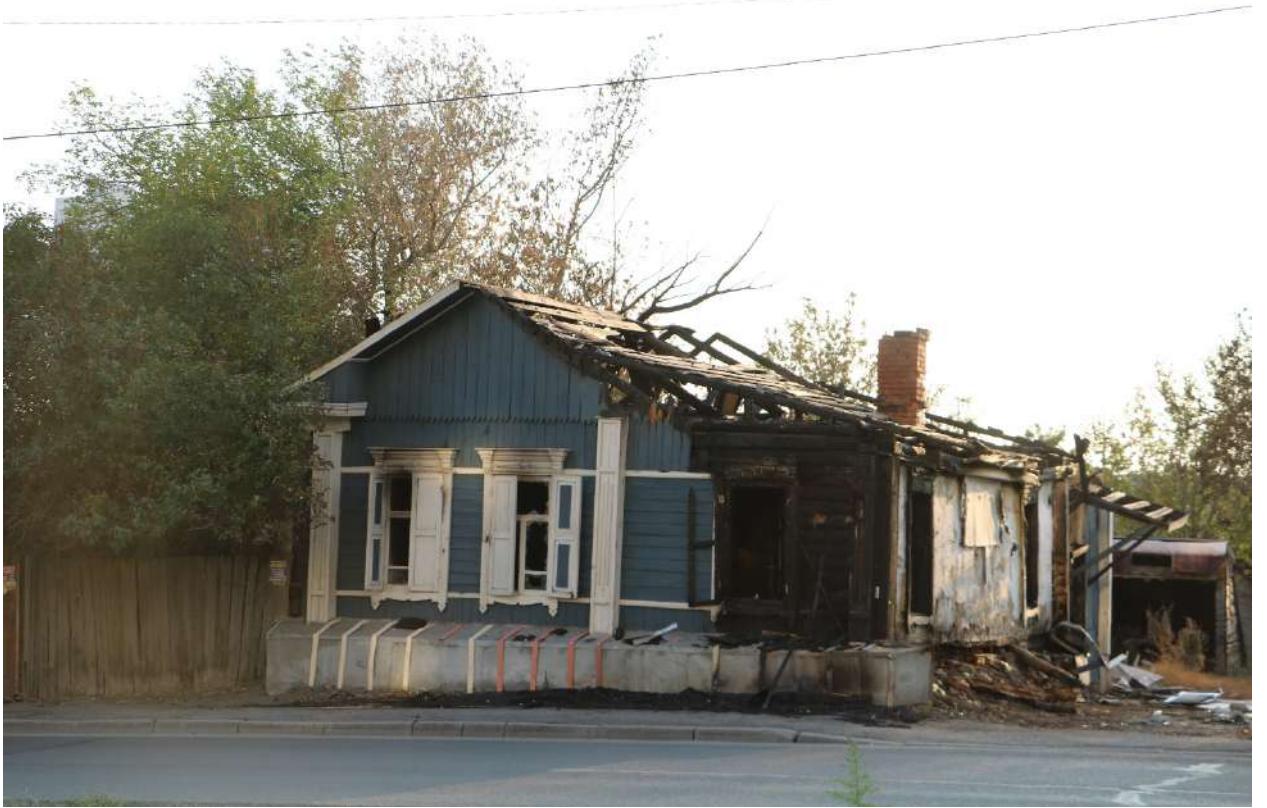
Фото 5. Градостроительная ситуация на территории исследования.
