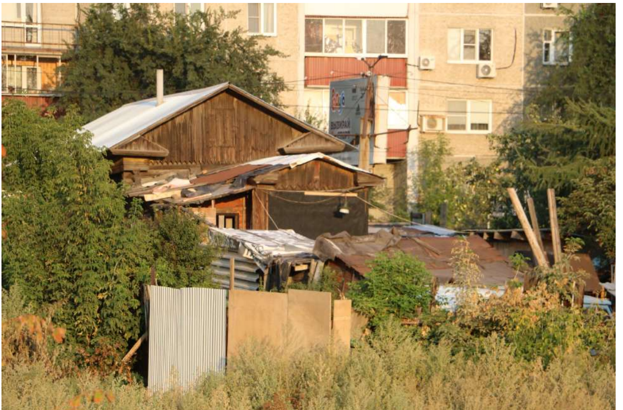
Фото 10. Объект культурного наследия. Общий вид с Ю
