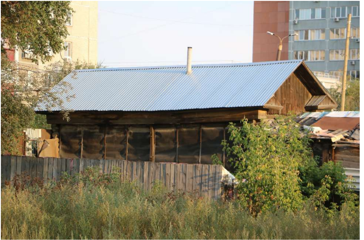
Фото 9. Объект культурного наследия. Общий вид с СЗ
