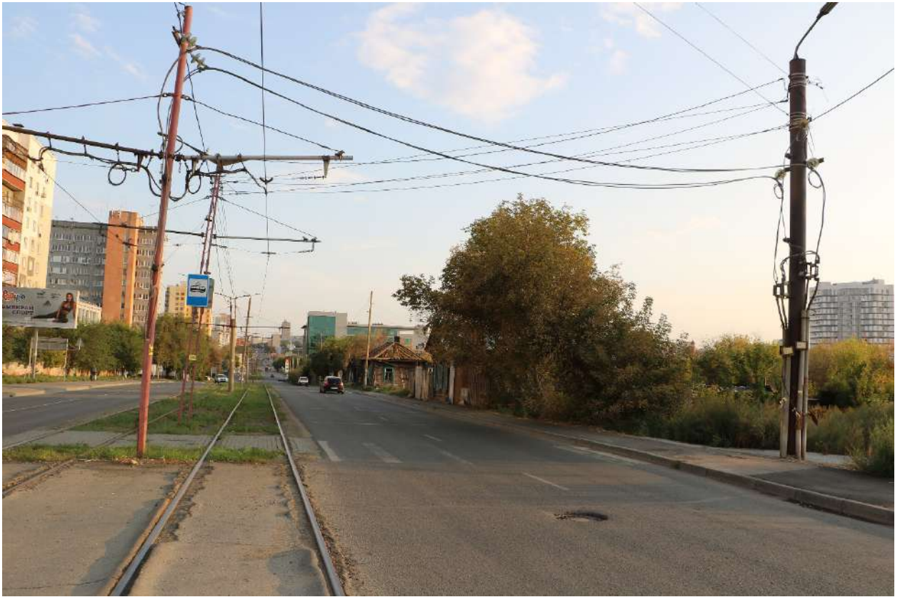
Фото 7. Градостроительная ситуация на территории исследования.
