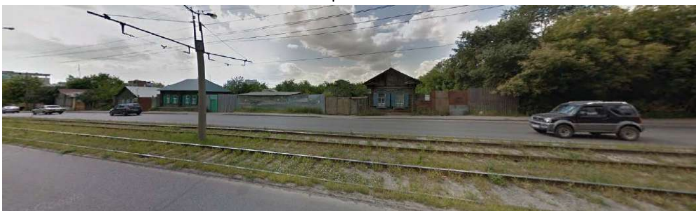
Рис. 9. Видовое раскрытие здания с противоположной стороны ул.Российская.
