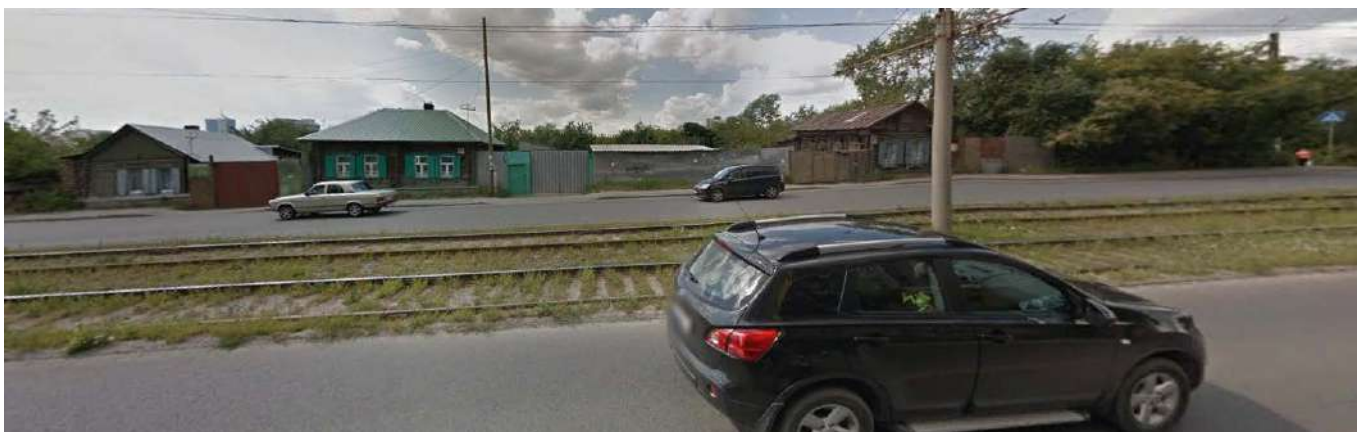
Рис. 8. Видовое раскрытие здания с противоположной стороны ул.Российская.
