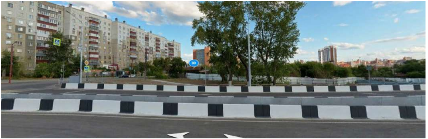
Рис. 13. Видовое раскрытие здания с северо-западной стороны при движении по развязке. Крайняя точка бассейна видимости.
