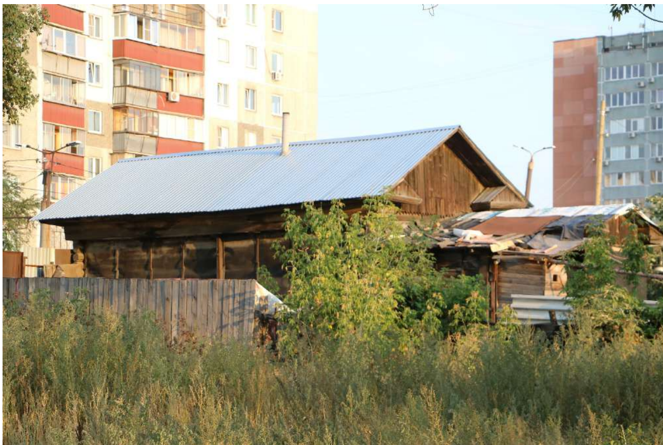
Рис. 22. Вид на объект с северо-запада (комфортный вид восприятия).
