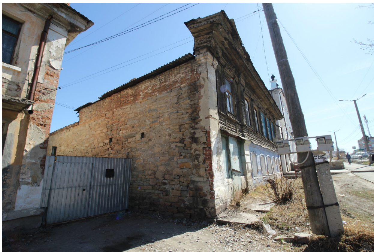
Рис. 2. Вид на здание с северо-запада при движении по ул. Пролетарская
