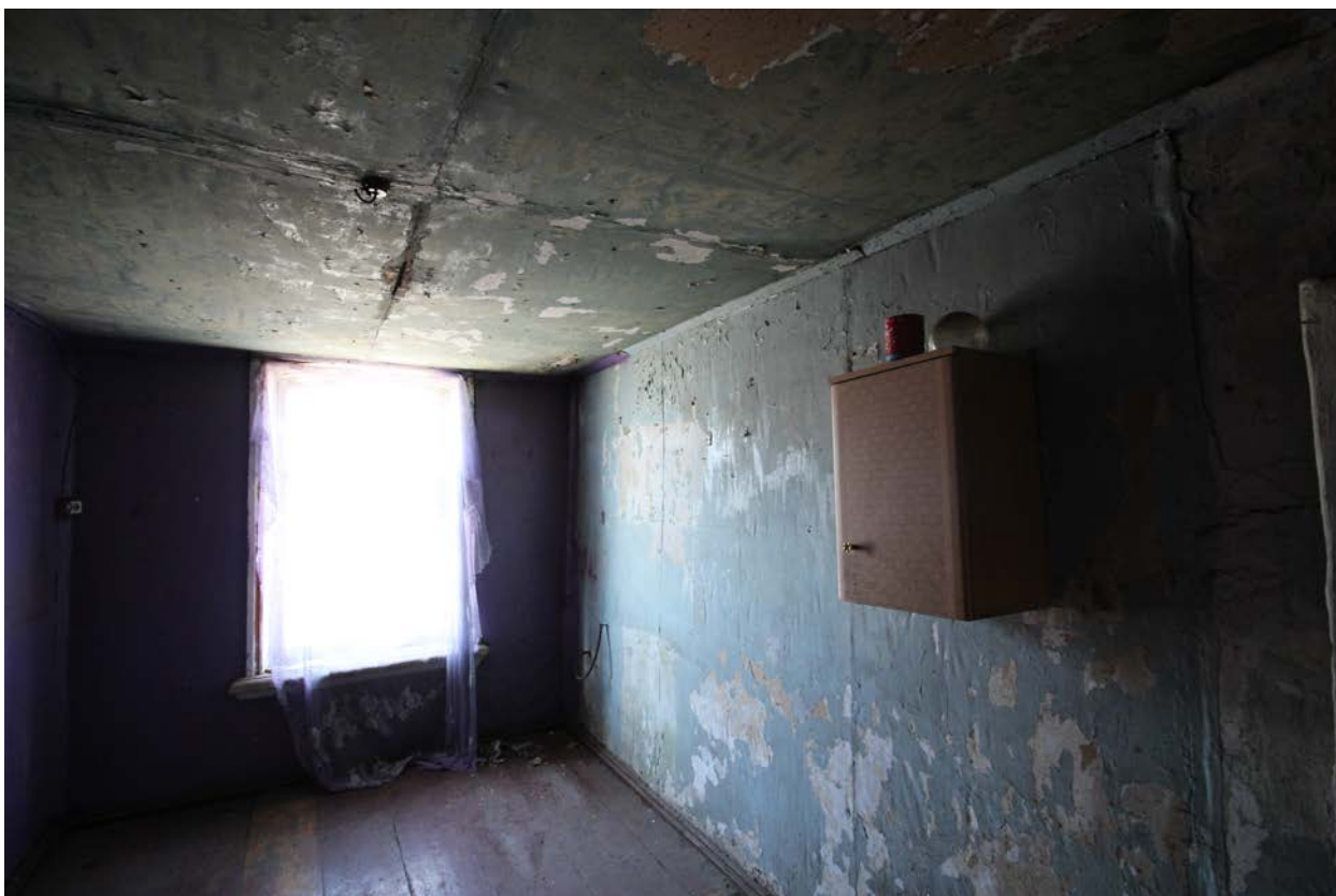
Фото 13. Объект культурного наследия. Внутренние помещения.
