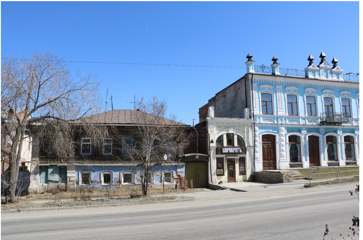
Рис. 3. Вид на здание с запада при движении по ул. Пролетарская
