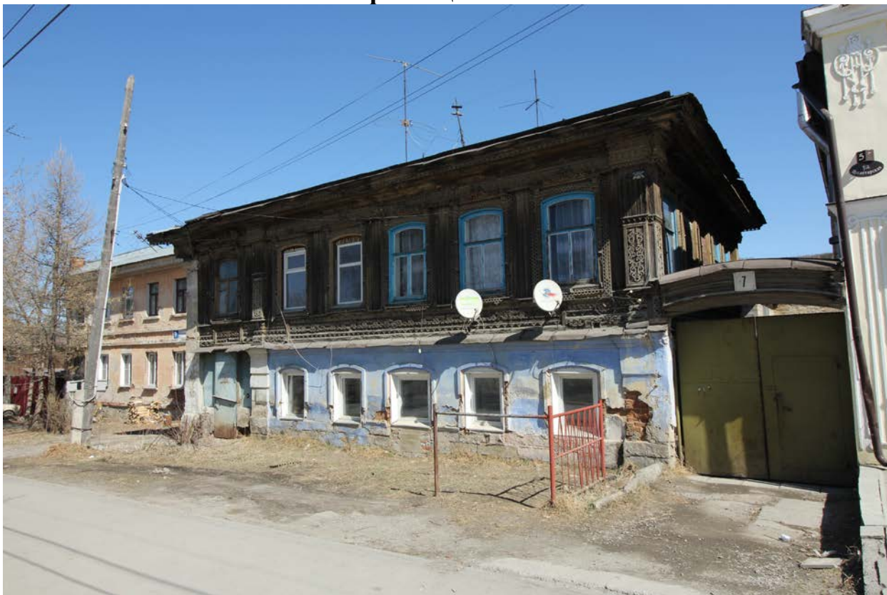
Фото 1. Объект культурного наследия. Общий вид с З.
