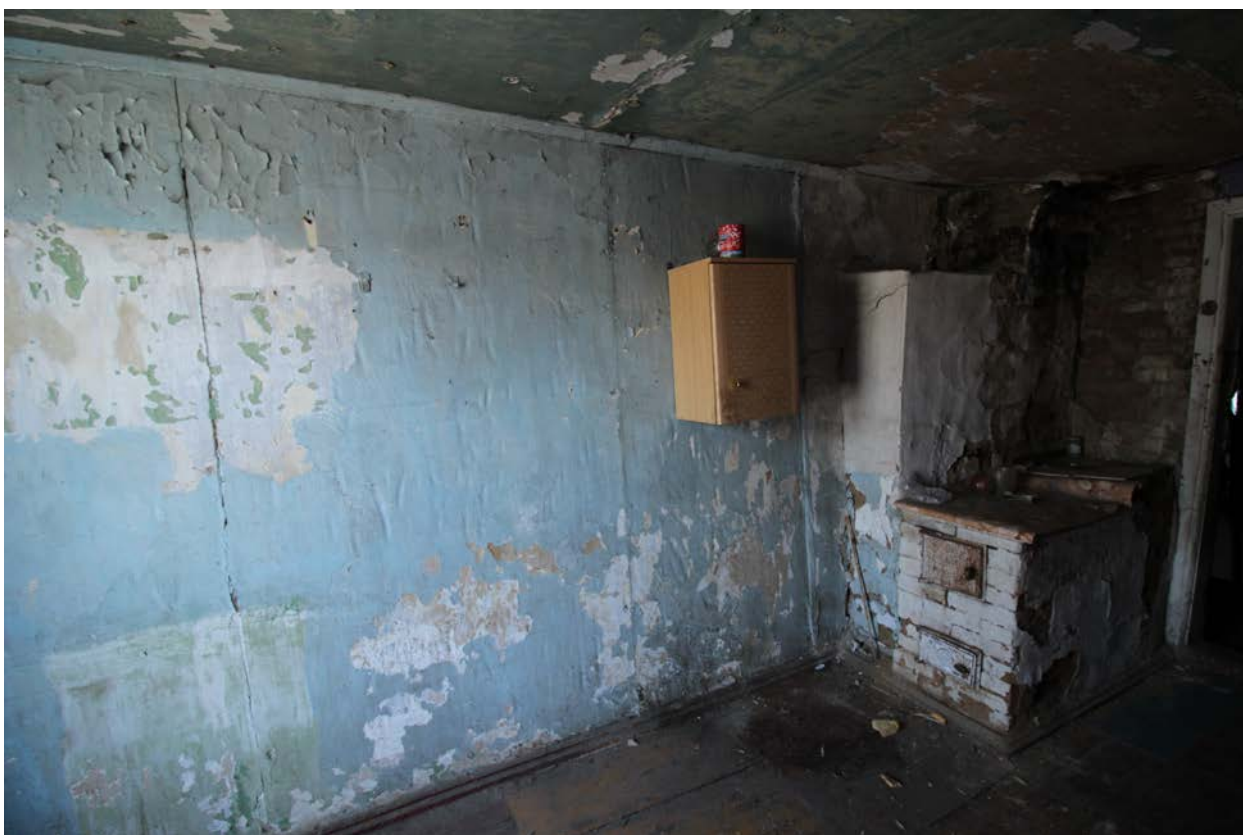
Фото 12. Объект культурного наследия. Внутренние помещения.
