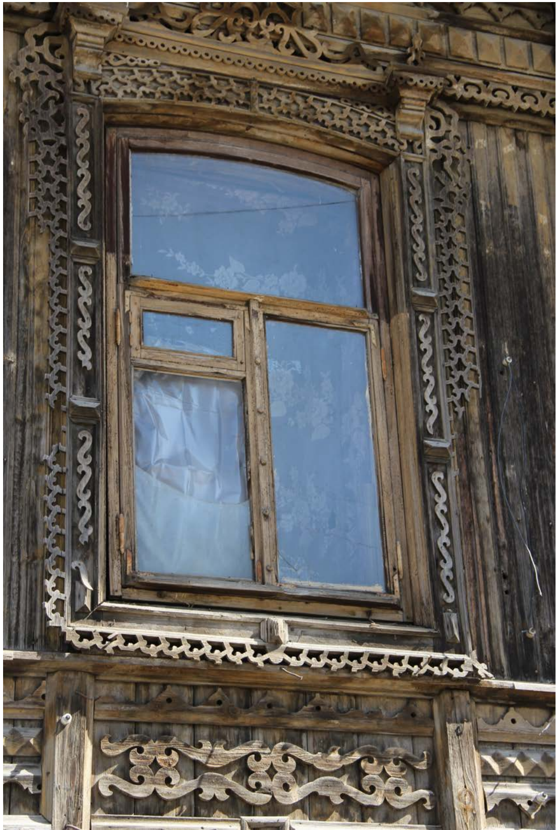
Фото 4. Объект культурного наследия. Декоративные элементы. Резьба на окнах.
