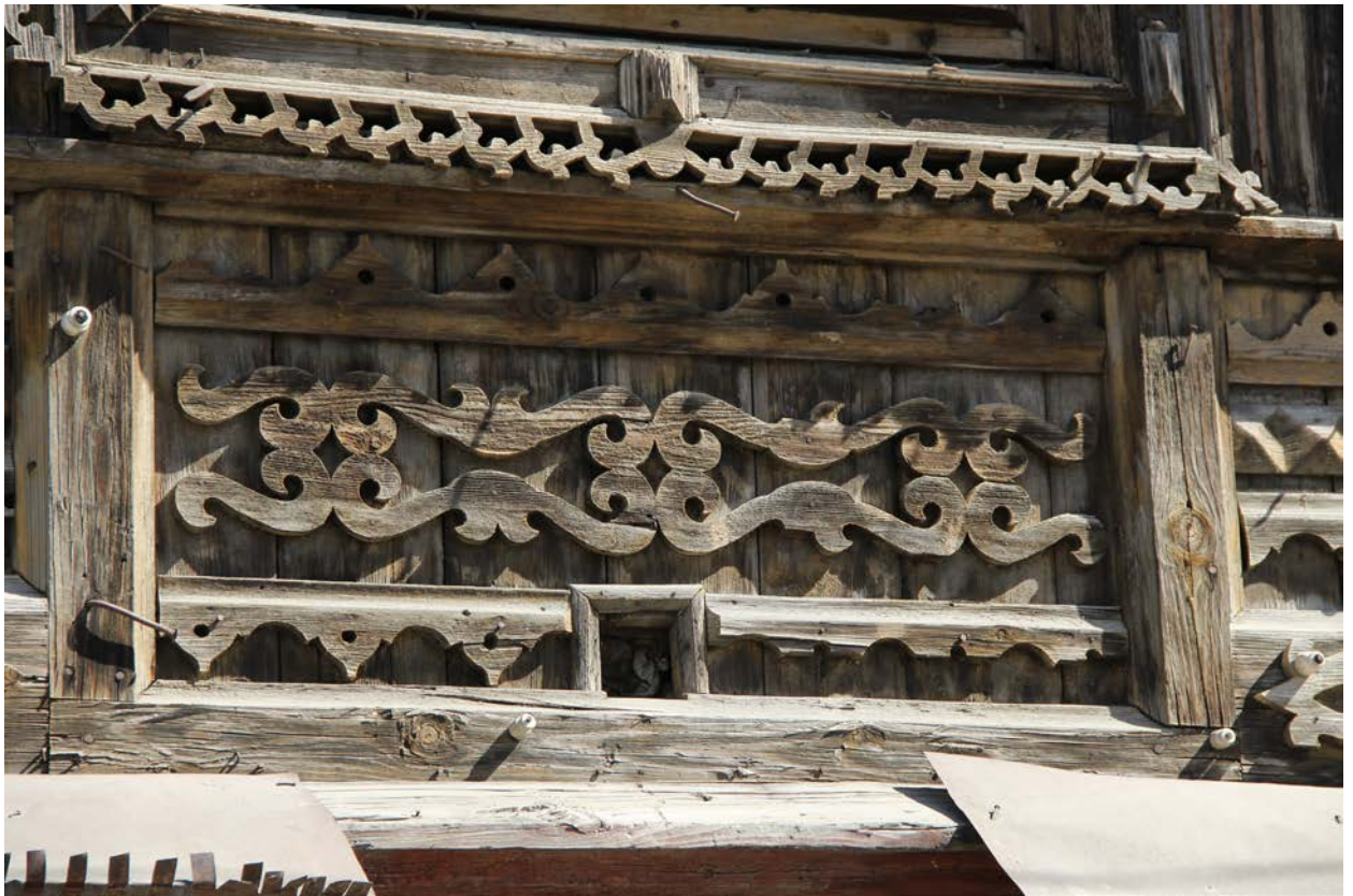
Фото 5. Объект культурного наследия. Декоративные элементы. Резьба на окнах.
