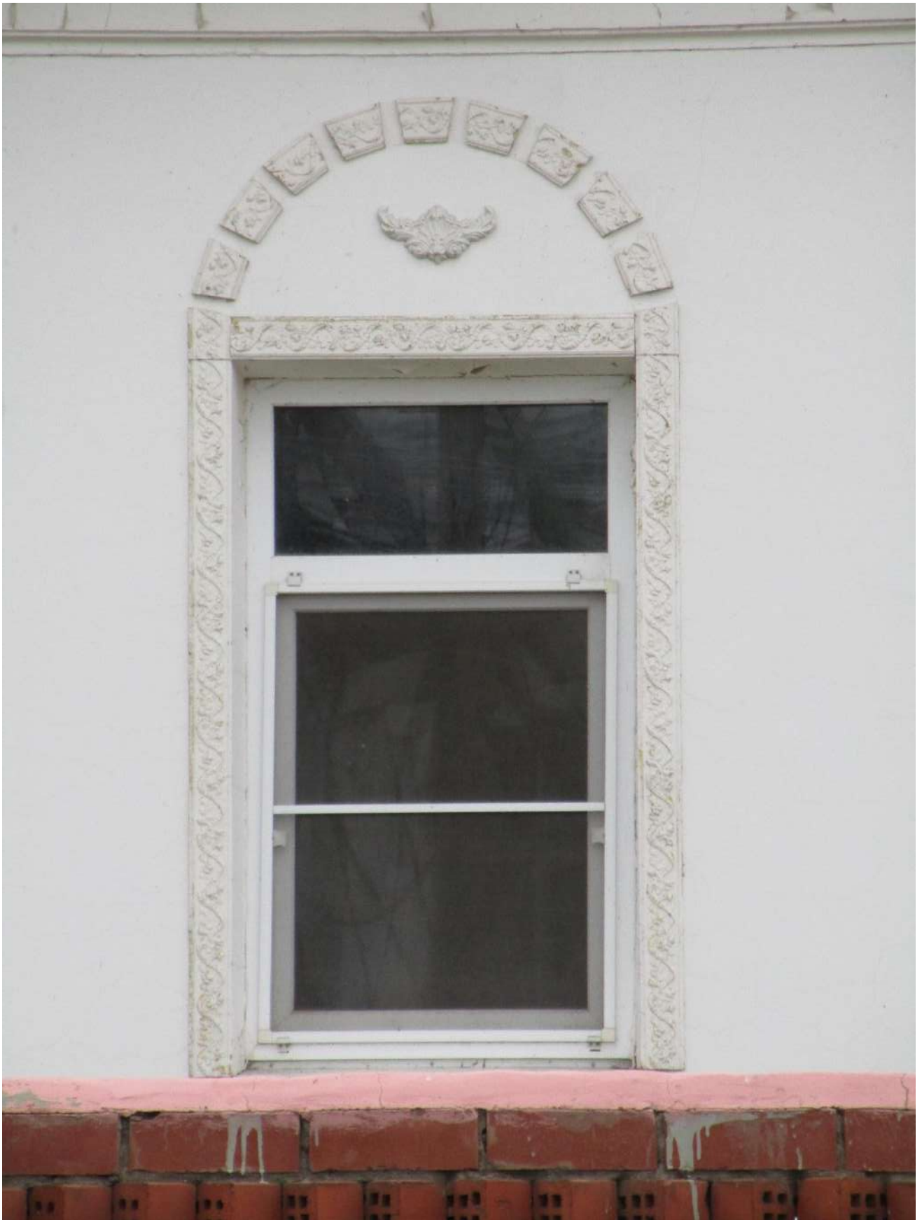
13. Оконный проем. Октябрь 2023 г.
