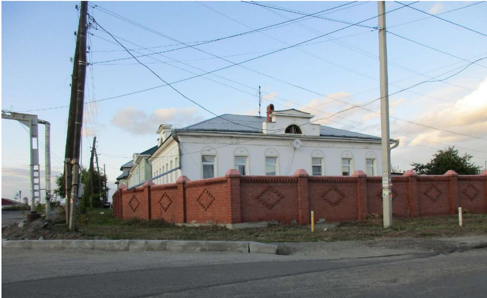
5. Особняк. Август, 2023 г.
