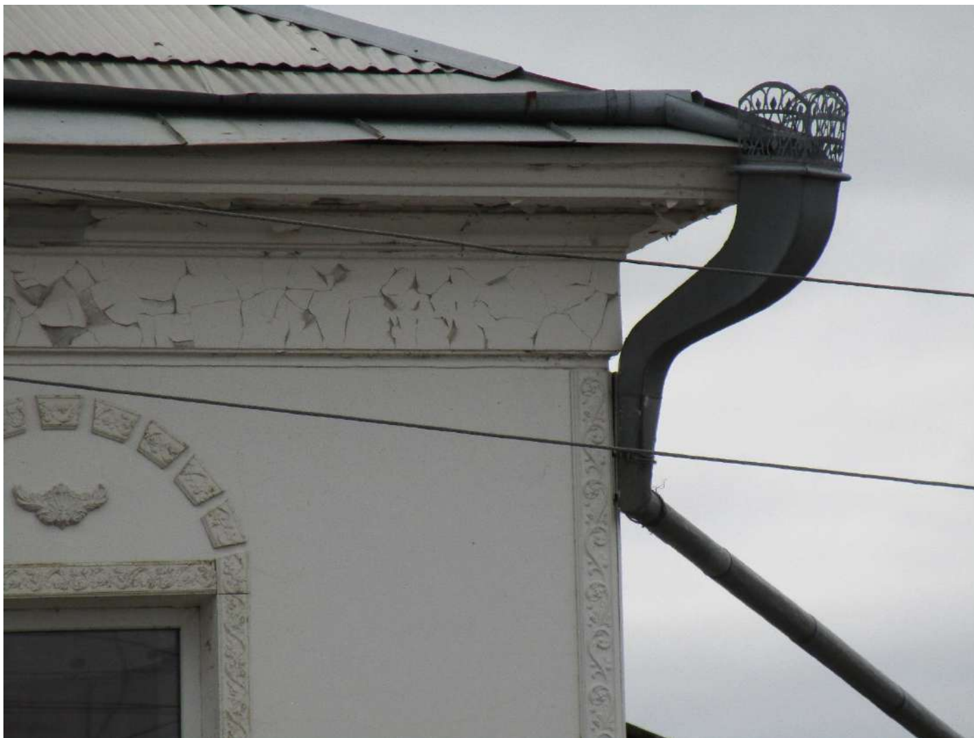
10. Фрагмент южного фасада. Фриз, свесы крыши. Современные диссонирующие накладные «украшения». Октябрь 2023 г.
