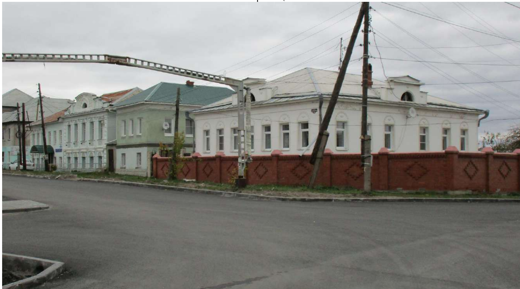
1. Общий вид объекта с юго-запада. Особняк справа, флигель – слева. Октябрь 2023 г.
