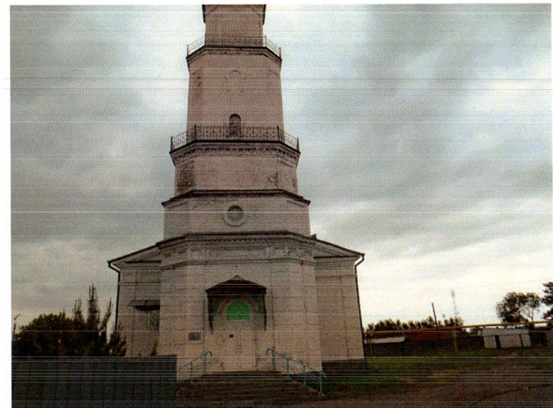
2.2. Общие габариты здания: 15 × 31 м, главного двухсветного пространства высотой 6,5 м и высотой минарета 25 м;
