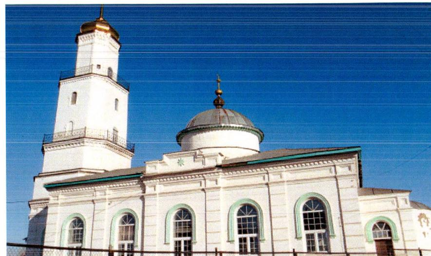
арочных окна, обрамленные профилированными тягами, верхнее окно глухое – фальшокно с габаритами 0,7 м × 0,9 м, нижнее из исторического материала – деревянные рамы с расстекловкой из двойных оконных блоков (с восстановлением при проведении реставрационно-ремонтных работ);
