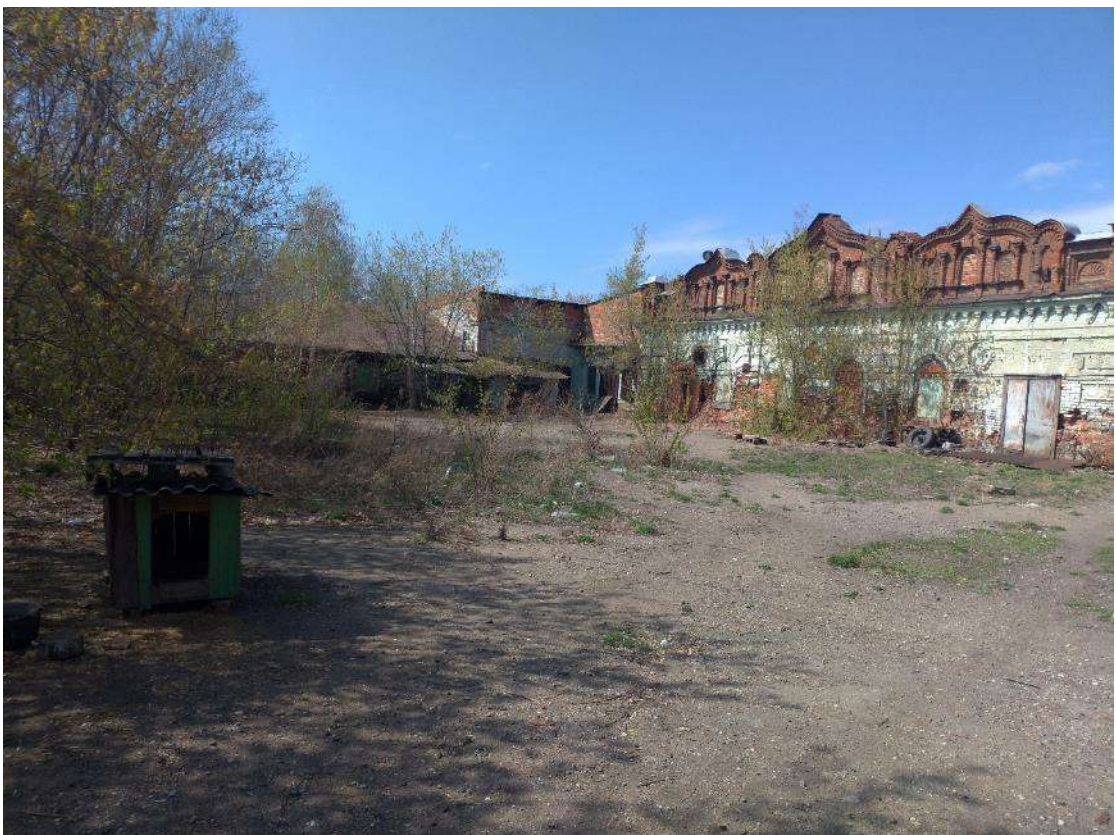
Фото 6. Объект культурного наследия - Комплекс строений пивного завода Зуккера. г. Троицк, им. С.И. Ловчикова ул., 41. Вид с востока.
