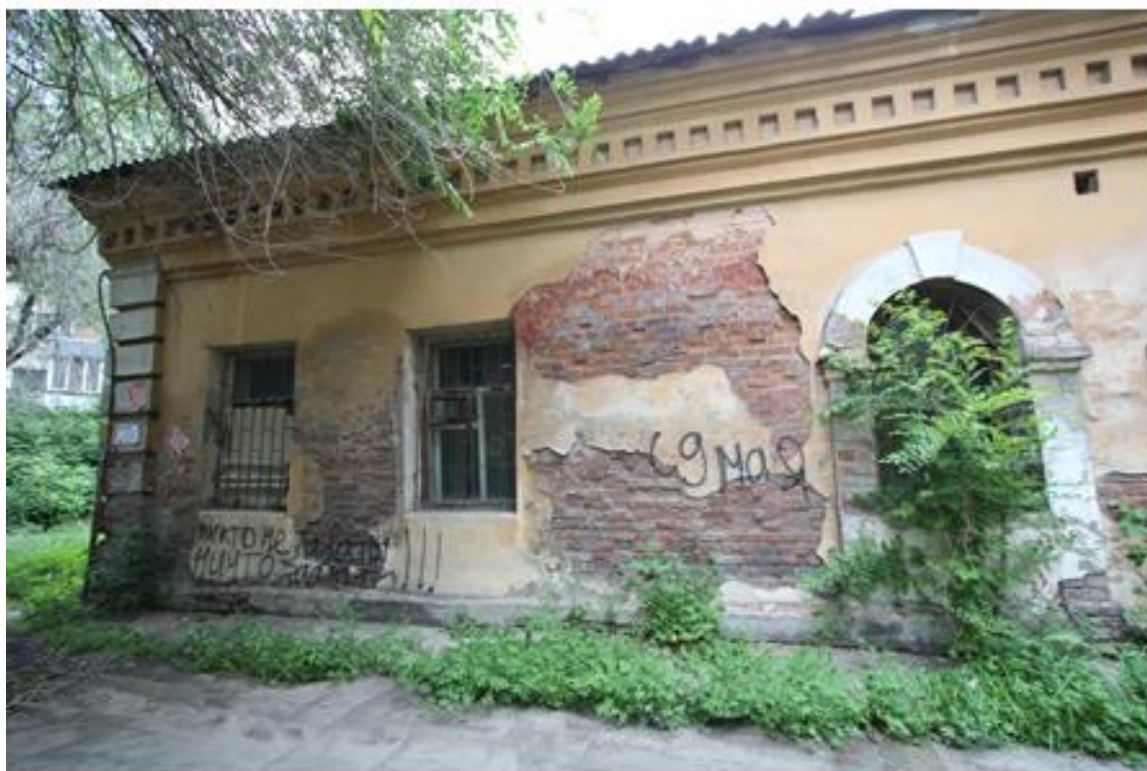
Фрагмент юго-западного фасада. Прорублены два прямоугольных окна
