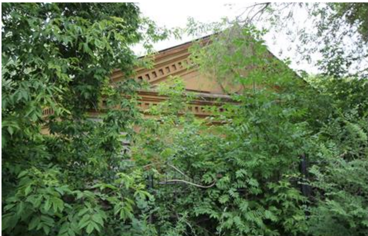
Вид на юго-восточный фасад
