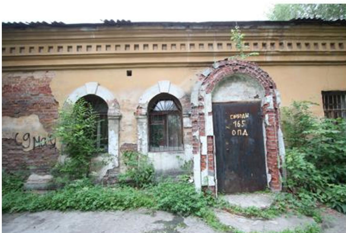
Фрагмент юго-западного фасада. Пристроенный тамбур.
