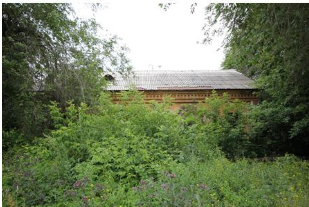
Вид с ул. Российской на юго-западный фасад
