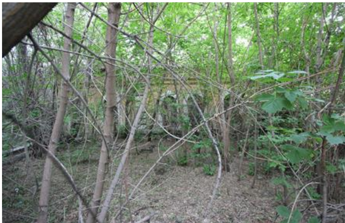
Вид на северо-западный фасад
