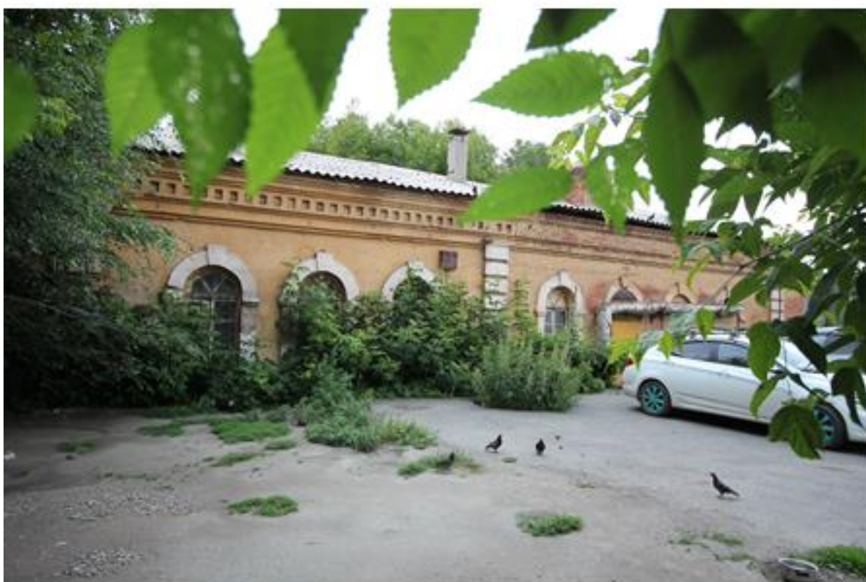
Фрагмент юго-восточного фасада. По фасаду проходят инженерные сети
