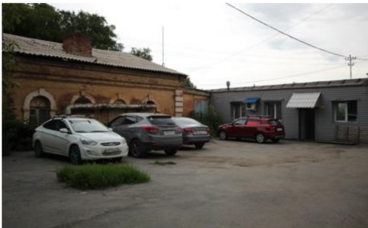
Фрагмент юго-восточного фасада. С северо-востока к зданию пристроены гаражи
