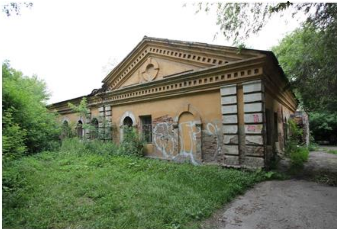
Вид на здание с запада
