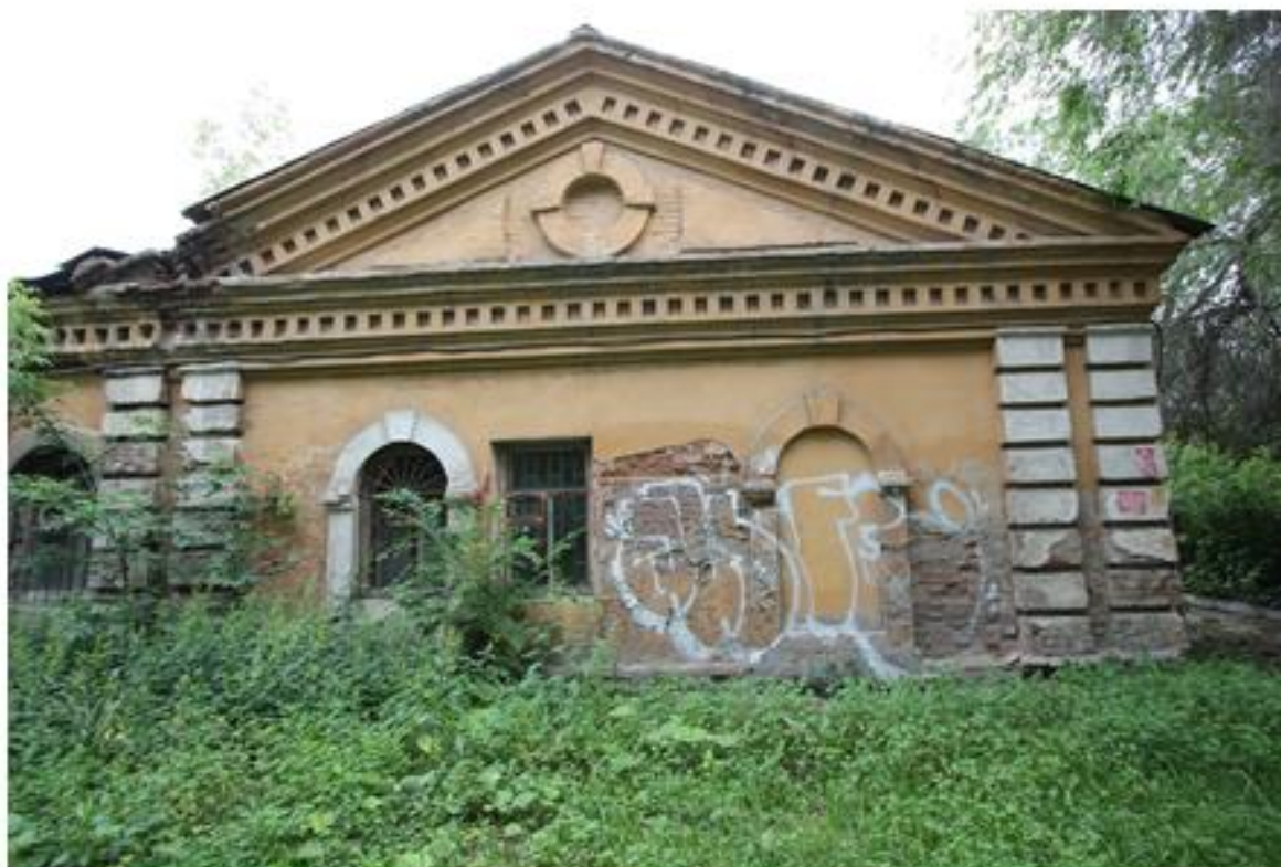
Фрагмент северо-западного фасада. Фронтон
