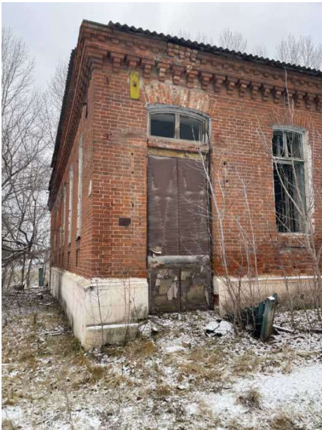
Фото 40. Выявленный объект культурного наследия «Здание Красной больницы» по адресу: Челябинская обл., г. Катав-Ивановск, ул. Больничная, 16. Западная часть, фрагмент восточного фасада выявленного объекта культурного наследия.
