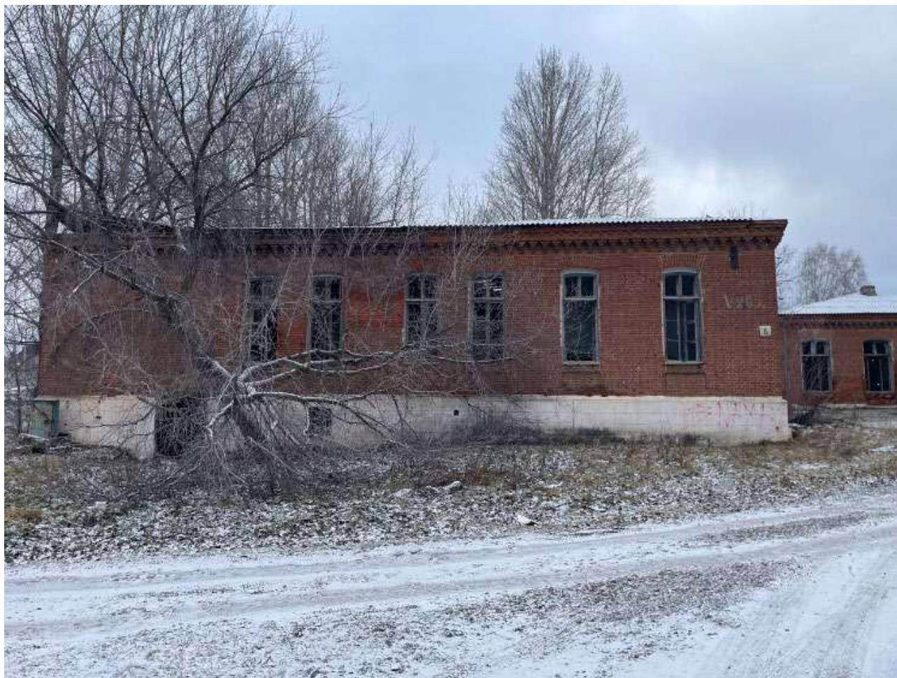
Фото 4. Выявленный объект культурного наследия «Здание Красной больницы» по адресу: Челябинская обл., г. Катав-Ивановск, ул. Больничная, 16. Западная часть, южный фасад выявленного объекта культурного наследия.
