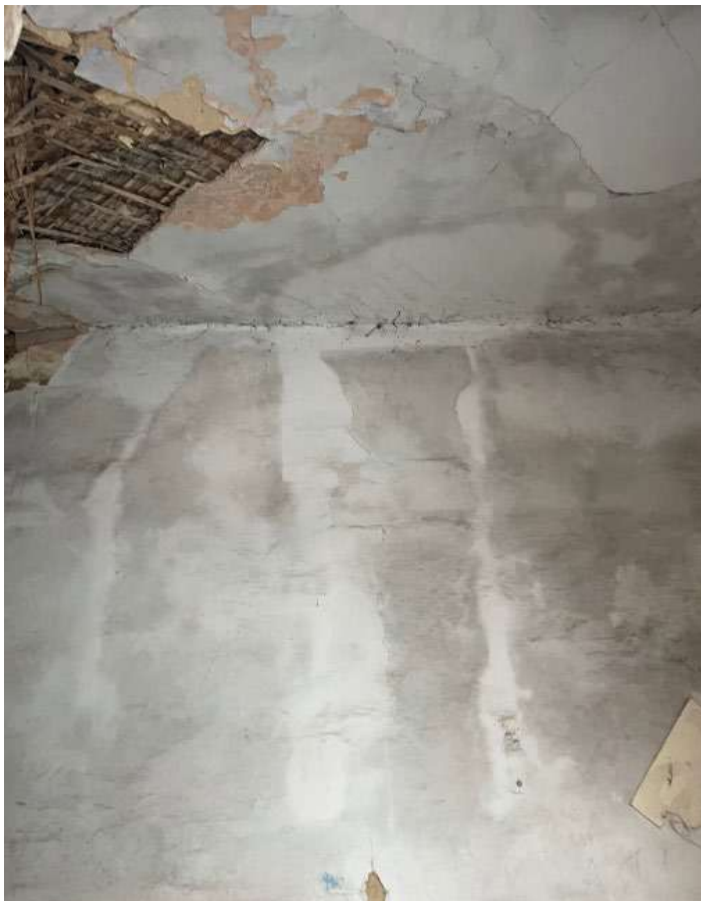
Фото 48. Выявленный объект культурного наследия «Здание Красной больницы» по адресу: Челябинская обл., г. Катав-Ивановск, ул. Больничная, 16. Интерьер выявленного объекта культурного наследия.
