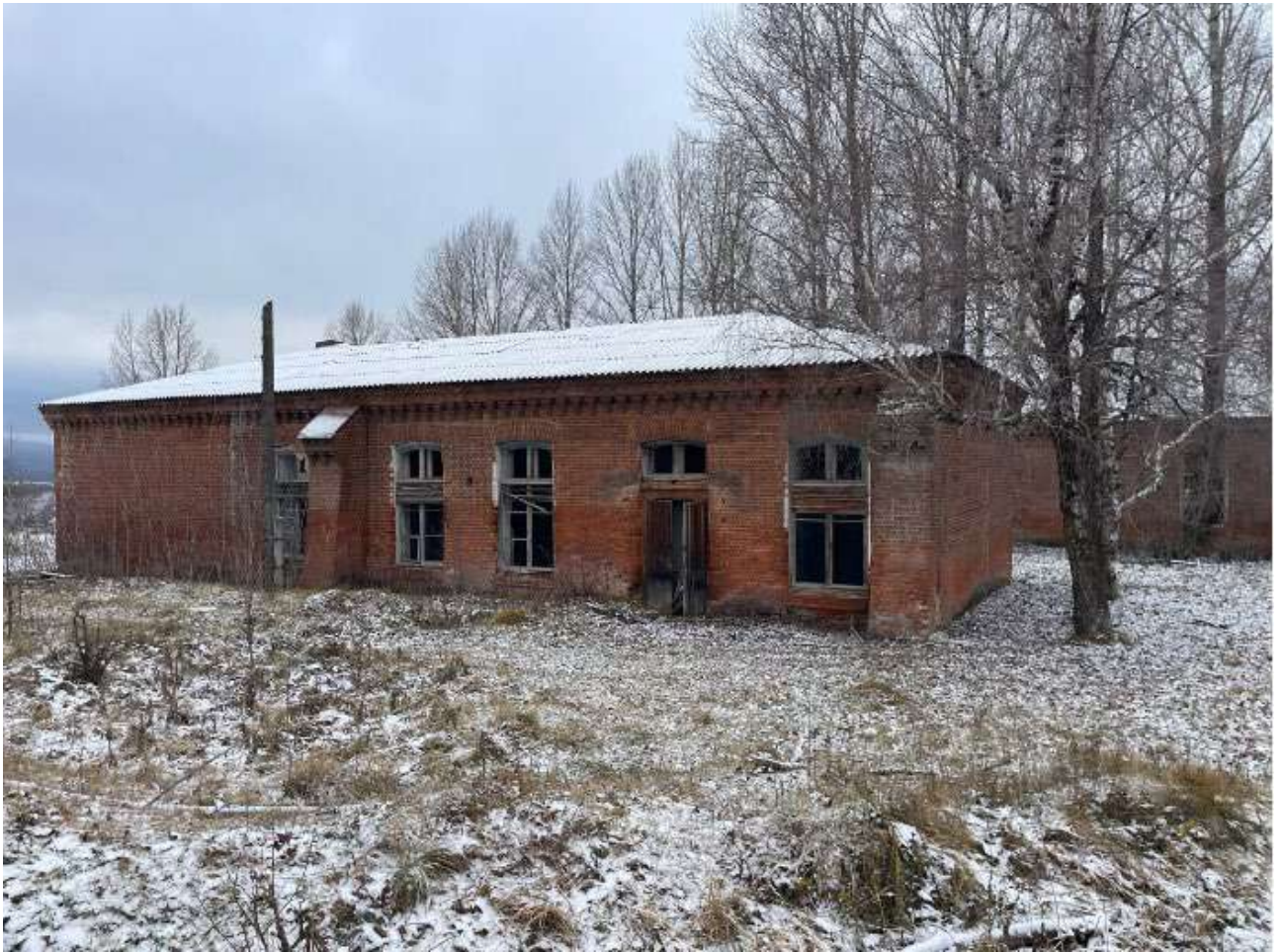
Фото 31. Выявленный объект культурного наследия «Здание Красной больницы» по адресу: Челябинская обл., г. Катав-Ивановск, ул. Больничная, 16. Восточная часть, восточный фасад выявленного объекта культурного наследия.
