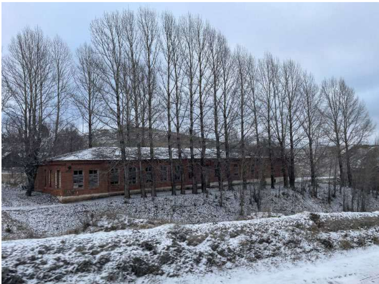
Фото 2. Выявленный объект культурного наследия «Здание Красной больницы» по адресу: Челябинская обл., г. Катав-Ивановск, ул. Больничная, 16. Общий вид выявленного объекта культурного наследия.
