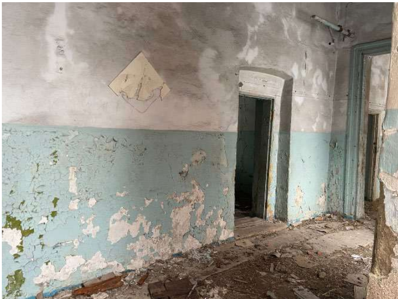
Фото 46. Выявленный объект культурного наследия «Здание Красной больницы» по адресу: Челябинская обл., г. Катав-Ивановск, ул. Больничная, 16. Интерьер выявленного объекта культурного наследия.
