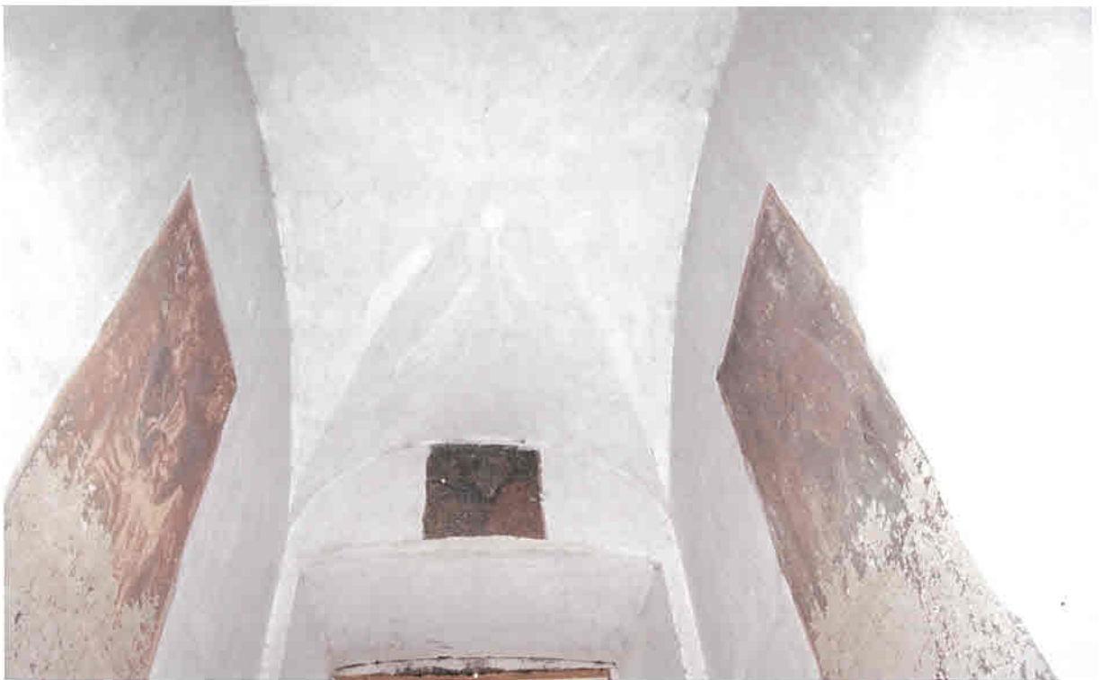
Фото 20. Фрагмент сводчатого потолка в притворе церкви
