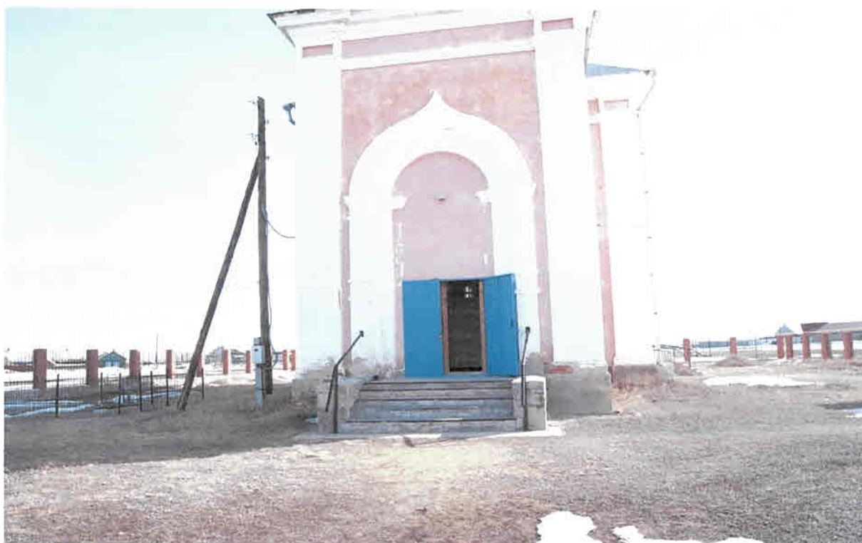
Фото 10. Вид на главный вход в церковь с западной стороны
