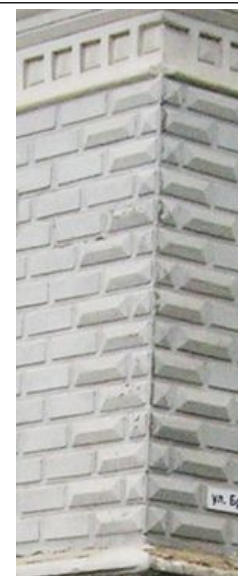
Рельеф углов стены первого этажа уличных (главных) фасадов блоками с «бриллиантовой огранкой»
