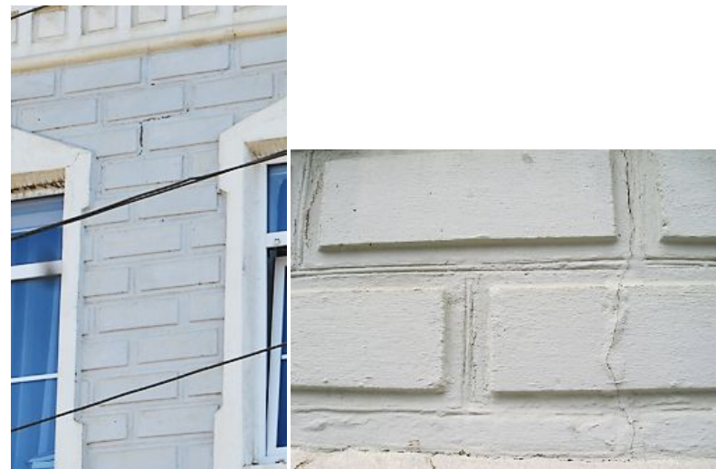
Рельеф стены уличных (главных) фасадов фацетированными блоками
