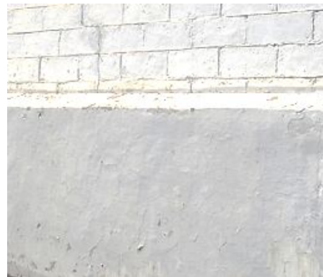
Техника отделки цокольного этажа дворовых фасадов
