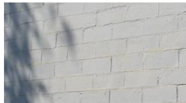
Рельеф стены дворовых фасадов «гладкими» блоками
