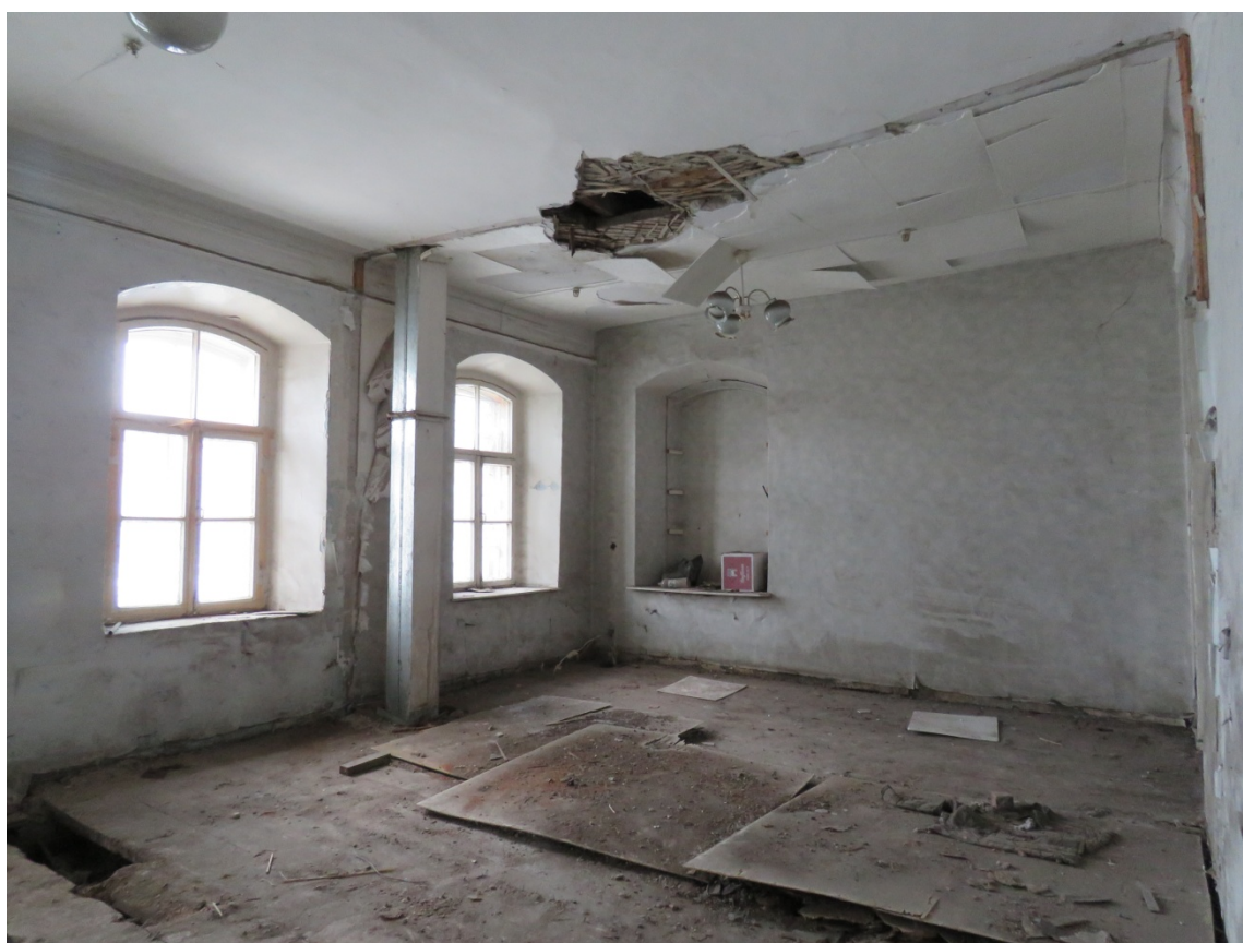
Рис. 29, 30. Здание дома Н.И. Каширина. Фрагменты интерьера первого этажа. Заложенный оконный проем южного фасада, скрытого поздним пристроем
