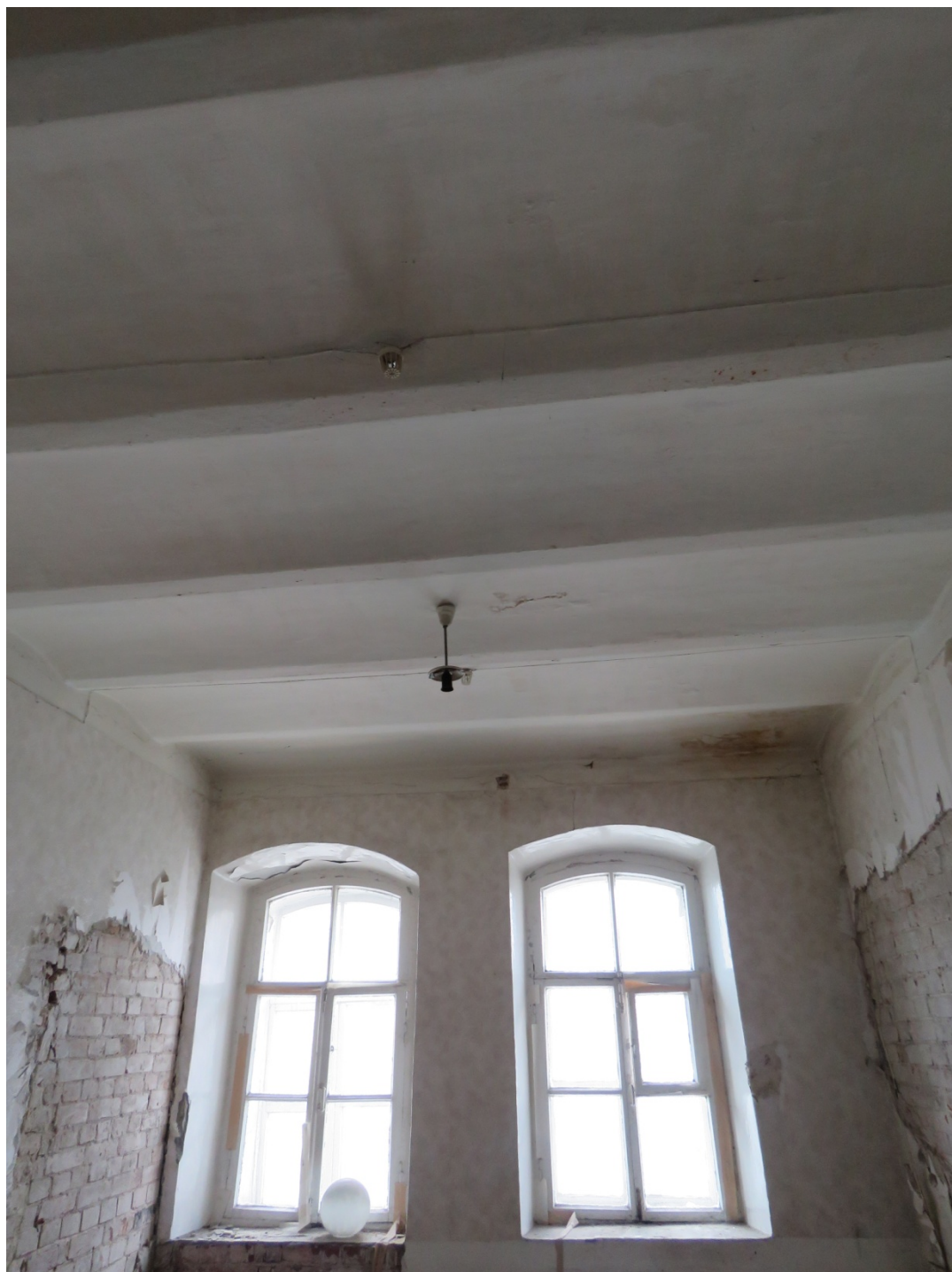
Рис. 26. Здание дома Н.И. Каширина. Фрагмент интерьера первого этажа. Сводчатое перекрытие
