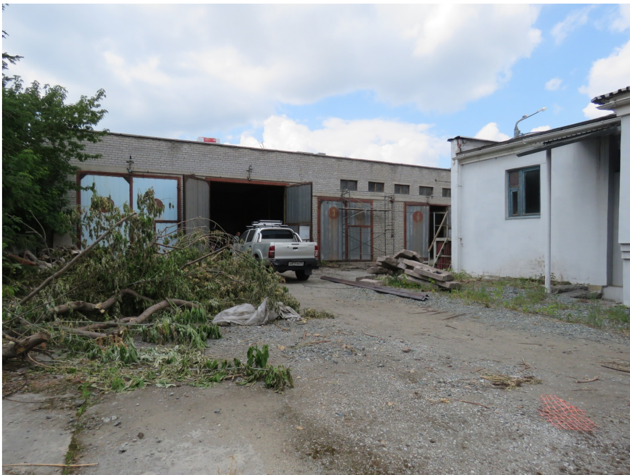
Рис. 31. Здание гаража. Вид с востока, с дворовой территории
