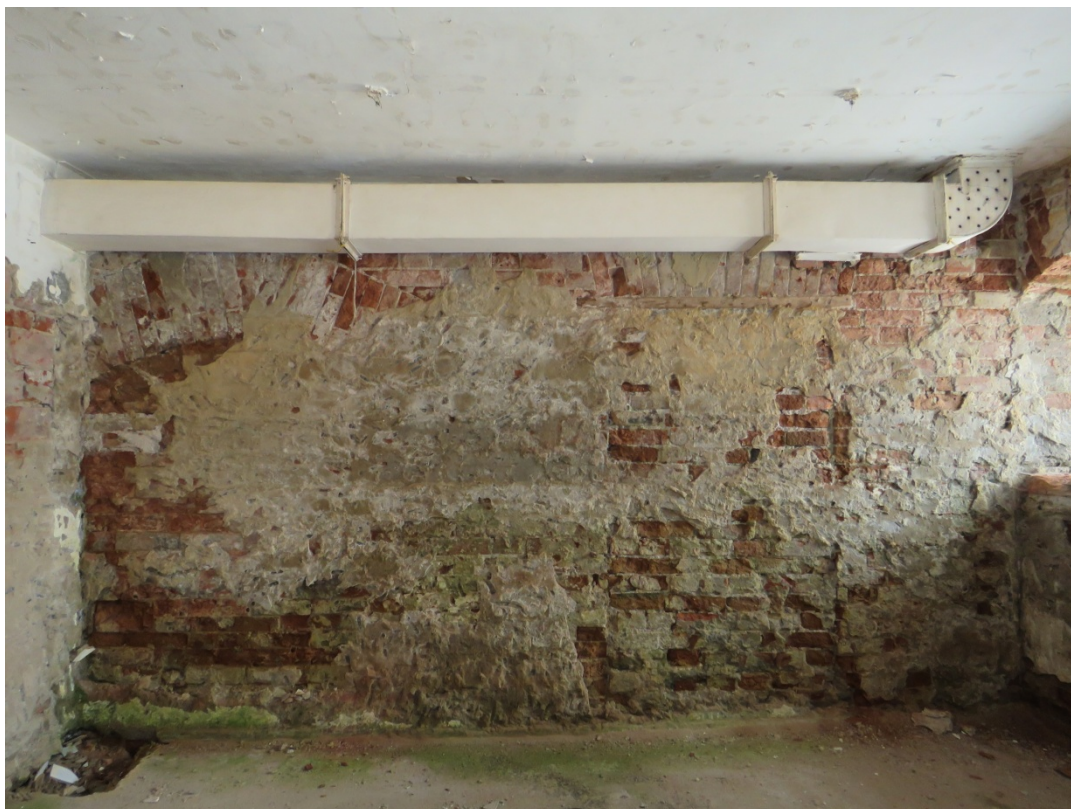
Рис. 20. Здание дома Н.И. Каширина. Фрагмент интерьера цокольного этажа.
