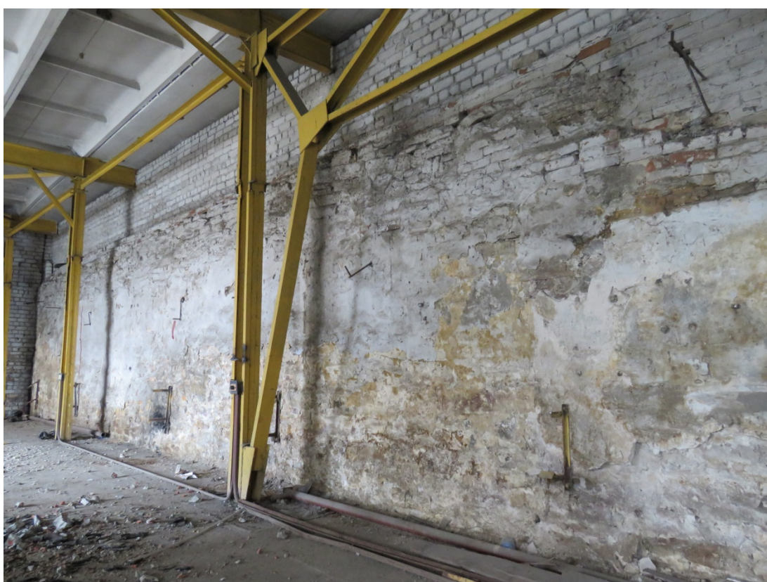
Рис. 32, 33. Западная стена гаража с сохранившимся фрагментом брандмауэрной стены бывшего торгового помещения (лавки)
