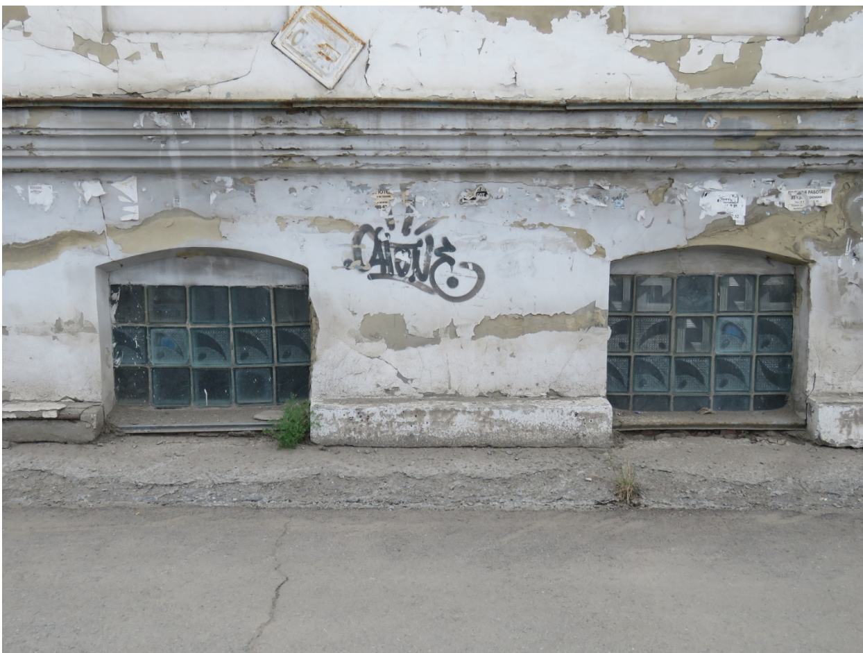
Рис. 11. Здание дома Н.И. Каширина. Фрагмент лицевого, восточного фасада. Окна цокольного этажа
