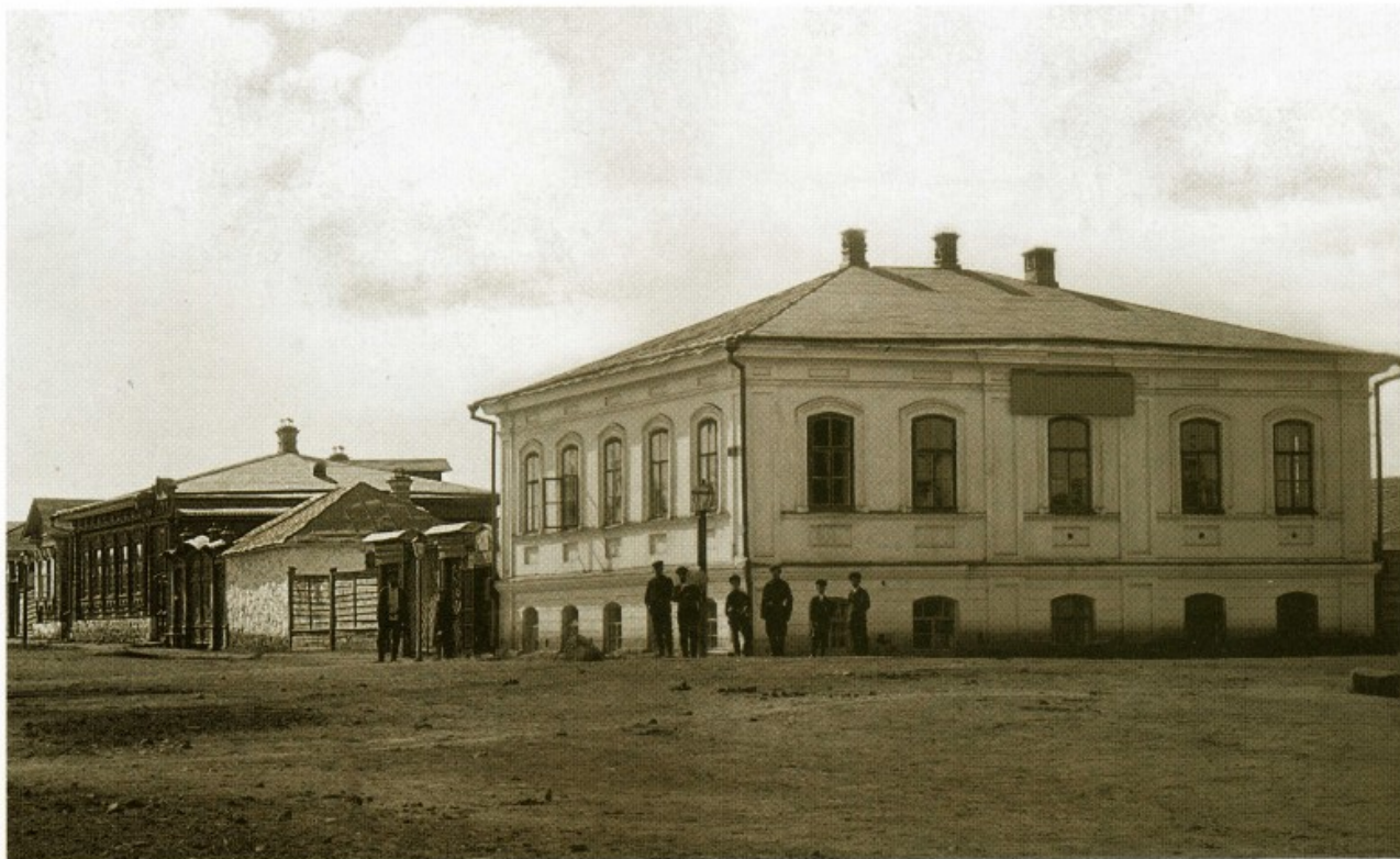
Рис. 18. Выявленный объект культурного наследия «Дом купца Каширина Н.И.». Фотография до 1910 г. Источник: Старый Челябинск в открытках и фотографиях. Ч.: Каменный пояс, 2008.
