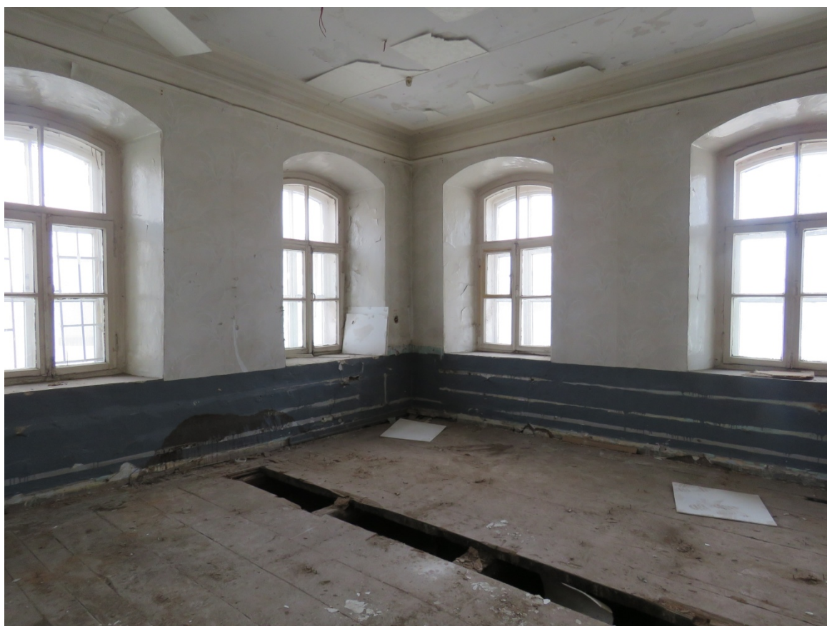
Рис. 27, 28. Здание дома Н.И. Каширина. Фрагменты интерьера первого этажа.
