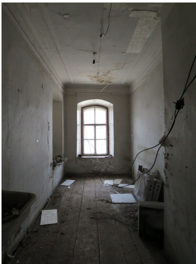
Рис. 23. Здание дома Н.И. Каширина. Фрагменты интерьера первого этажа.
