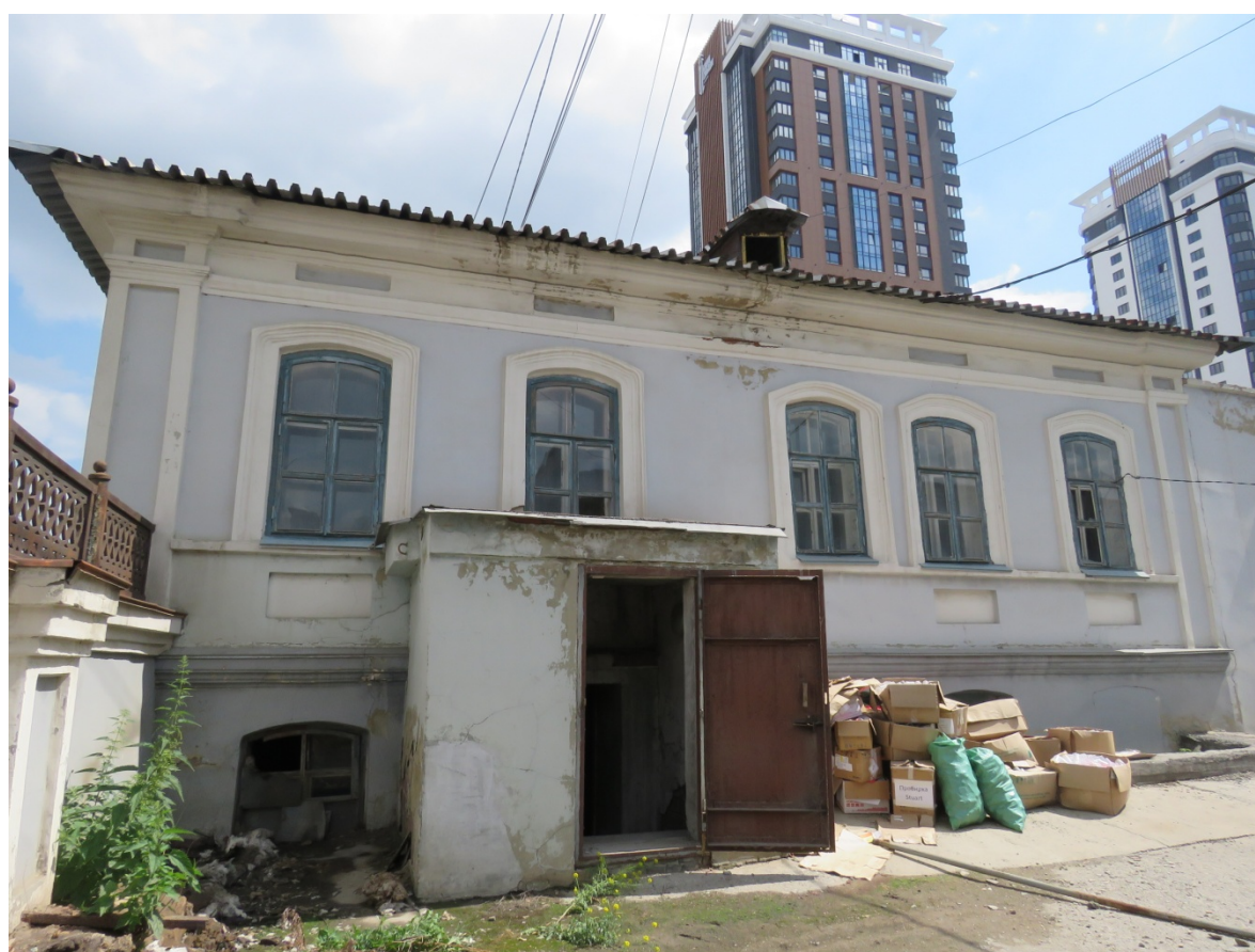
Рис. 5, 6. Здание дома Н.И. Каширина. Дворовый, западный фасад
