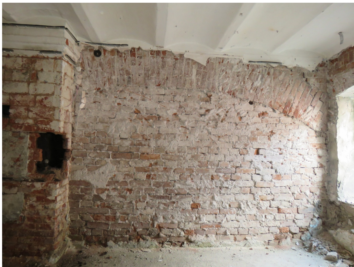
Рис. 15,16. Здание дома Н.И. Каширина. Фрагменты интерьера цокольного этажа. Кладка стен
