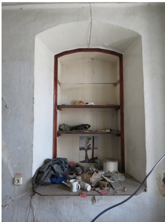
Рис. 24. Здание дома Н.И. Каширина. Фрагмент интерьера первого этажа. Заложенный оконный проем южного фасада, скрытого поздним пристроем
