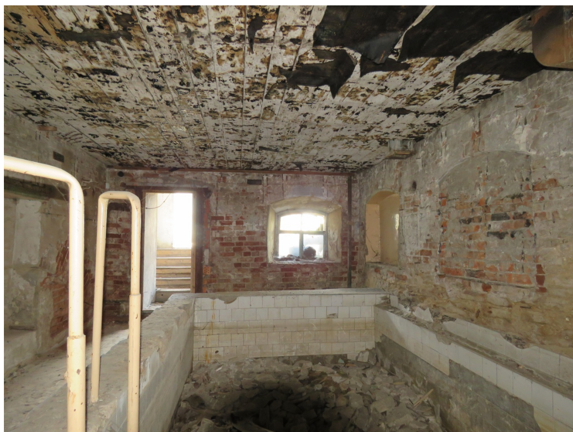
Рис. 13,14. Здание дома Н.И. Каширина. Фрагменты интерьера цокольного этажа.
