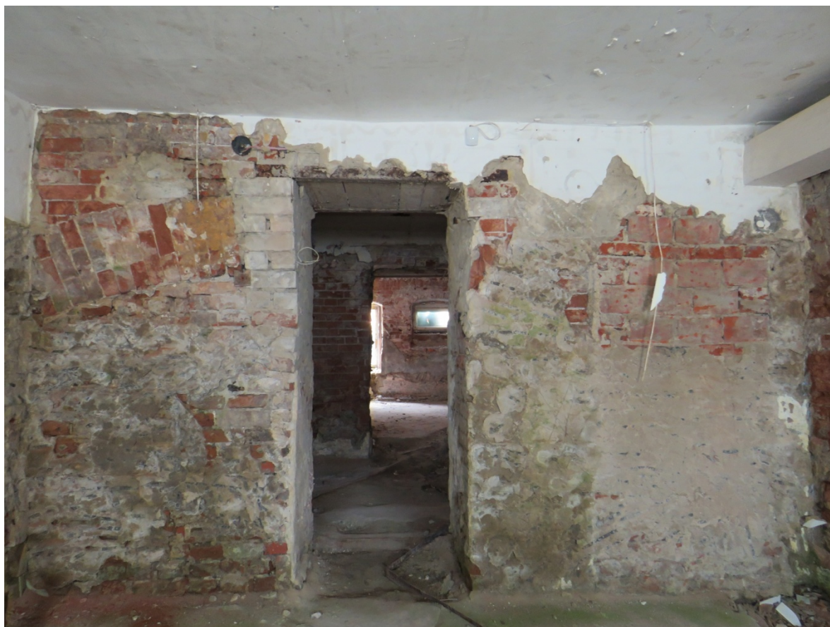
Рис. 18,19. Здание дома Н.И. Каширина. Фрагменты интерьера цокольного этажа.
