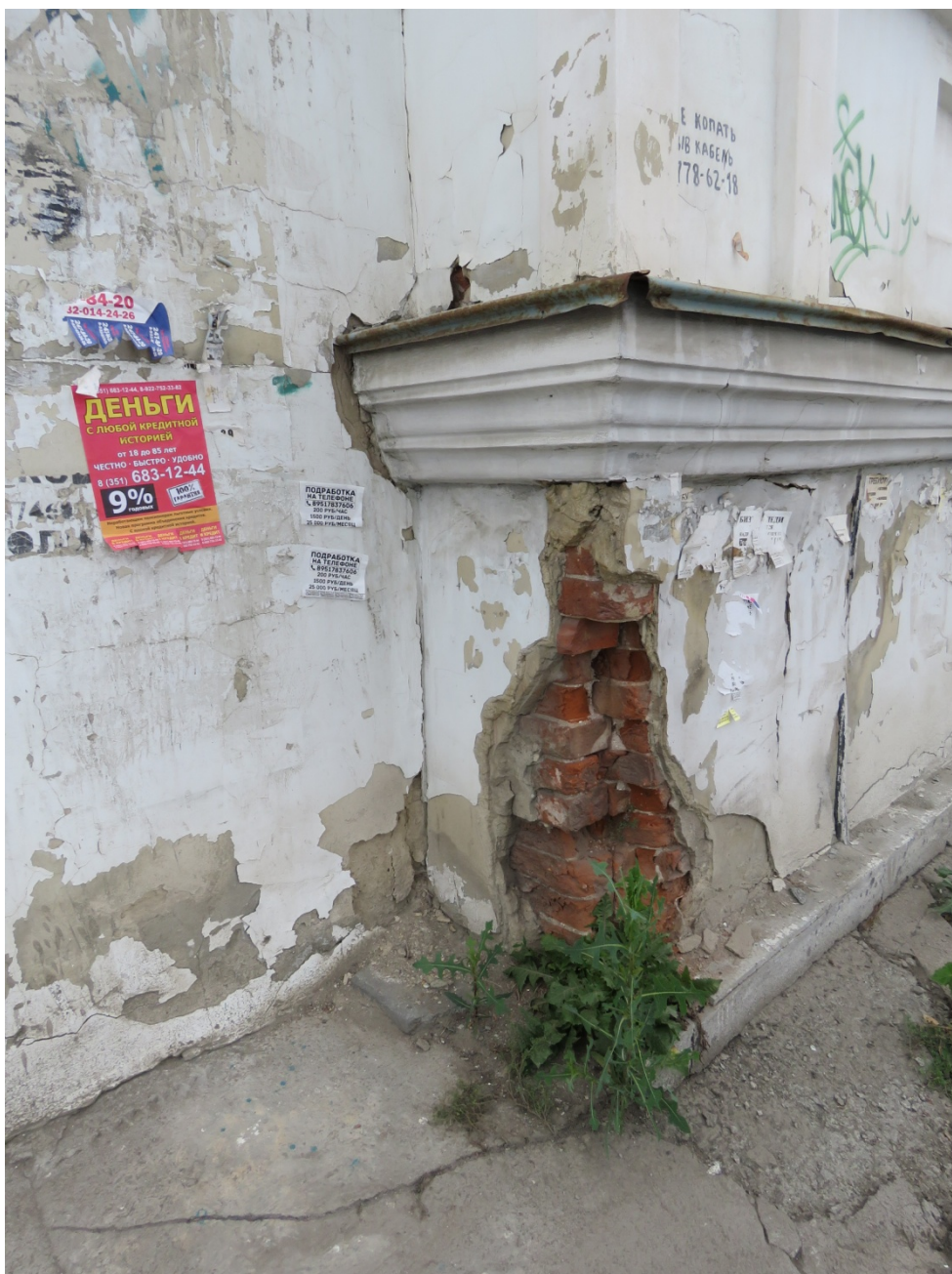
Рис. 9. Здание дома Н.И. Каширина. Фрагмент лицевого, восточного фасада. Междуэтажный карниз.
