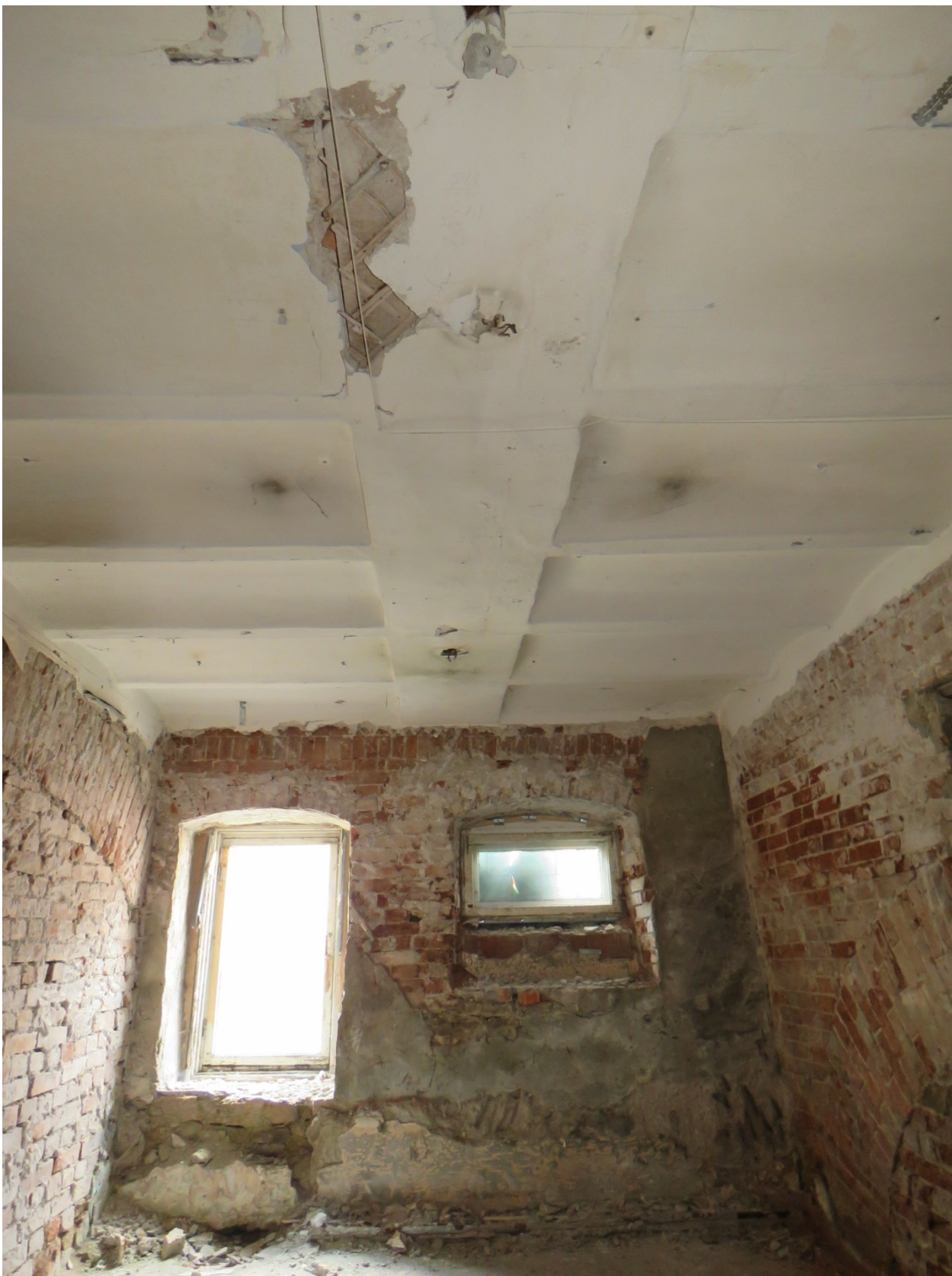
Рис. 17. Здание дома Н.И. Каширина. Фрагменты интерьера цокольного этажа. Сводчатое перекрытие
