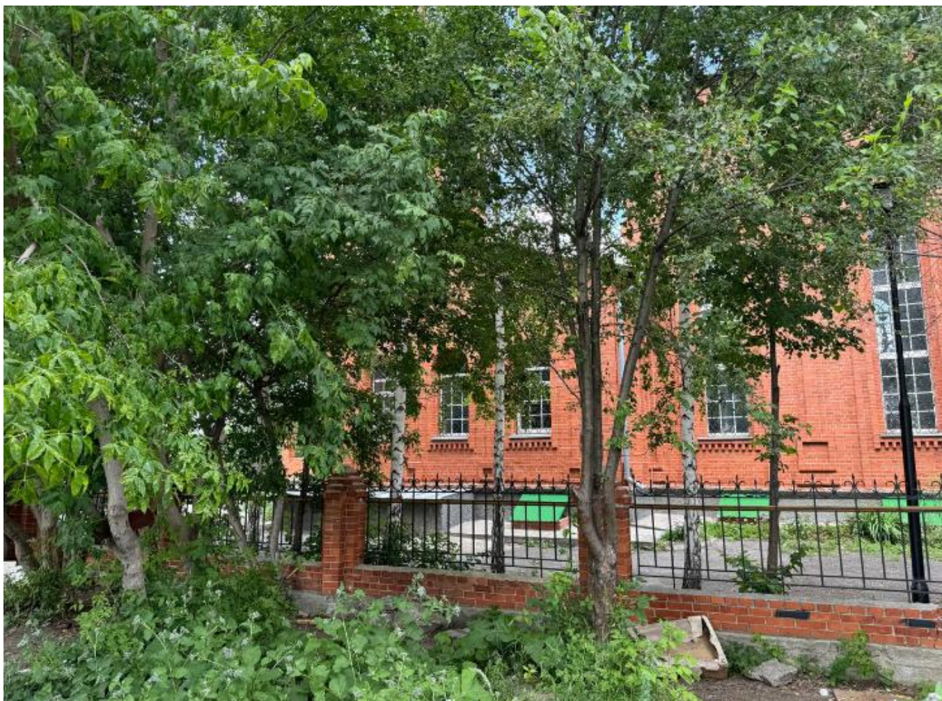
Фото 13. Вид на выявленный объект культурного наследия «Церковь старообрядческая Покрова Пресвятой Богородицы», расположенный по адресу: Челябинская область, Миасский городской округ, г. Миасс, ул. Малышева, 38.
