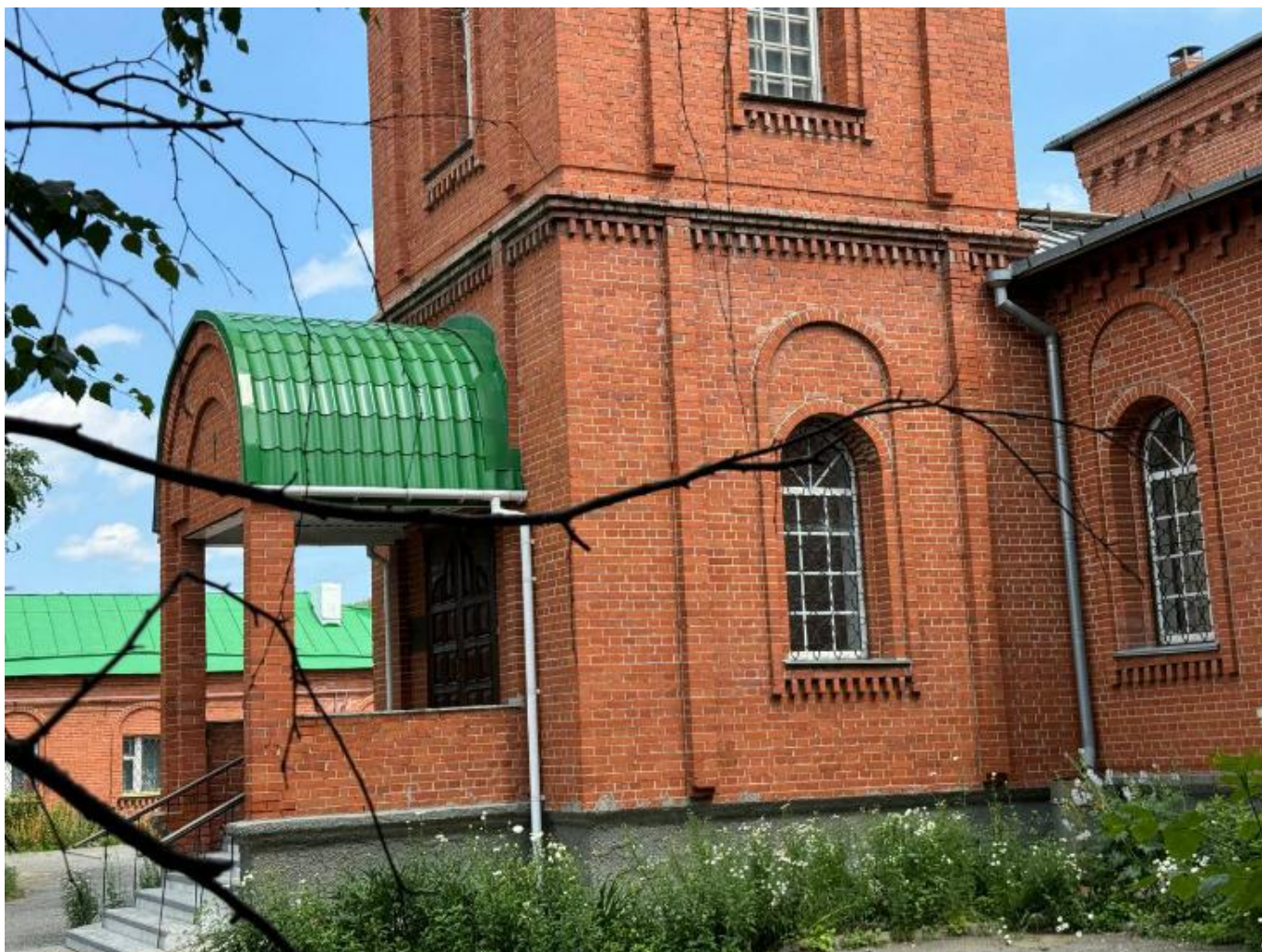
Фото 3. Вид на выявленный объект культурного наследия «Церковь старообрядческая Покрова Пресвятой Богородицы», расположенный по адресу: Челябинская область, Миасский городской округ, г. Миасс, ул. Малышева, 38.
