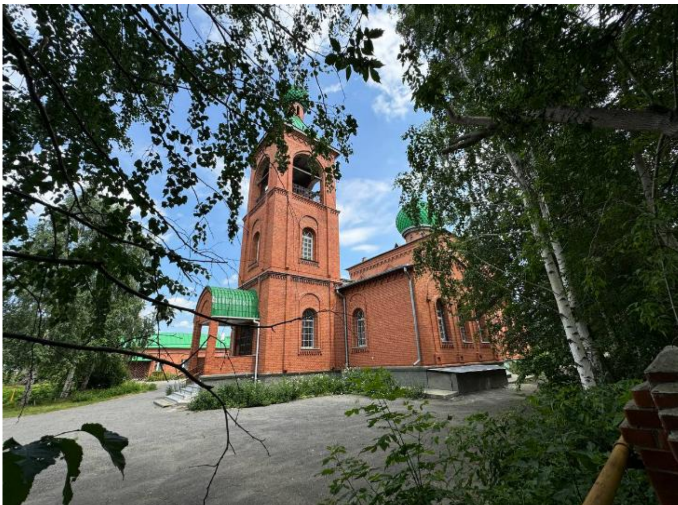
Фото 1. Вид на выявленный объект культурного наследия «Церковь старообрядческая Покрова Пресвятой Богородицы», расположенный по адресу: Челябинская область, Миасский городской округ, г. Миасс, ул. Малышева, 38.
