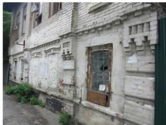
Фрагмент центрального фасада
