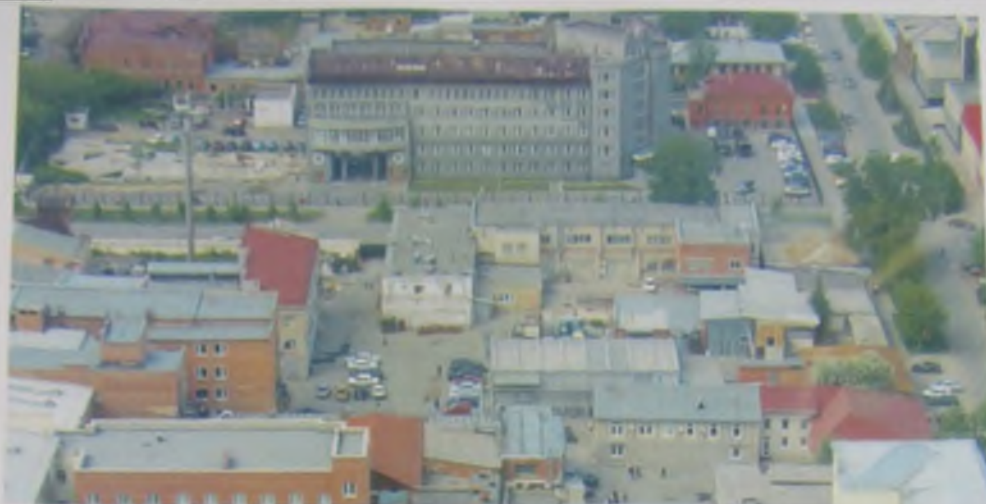
Рис.1. Общий вид участка застройки с юга (фото - 2008г.)
