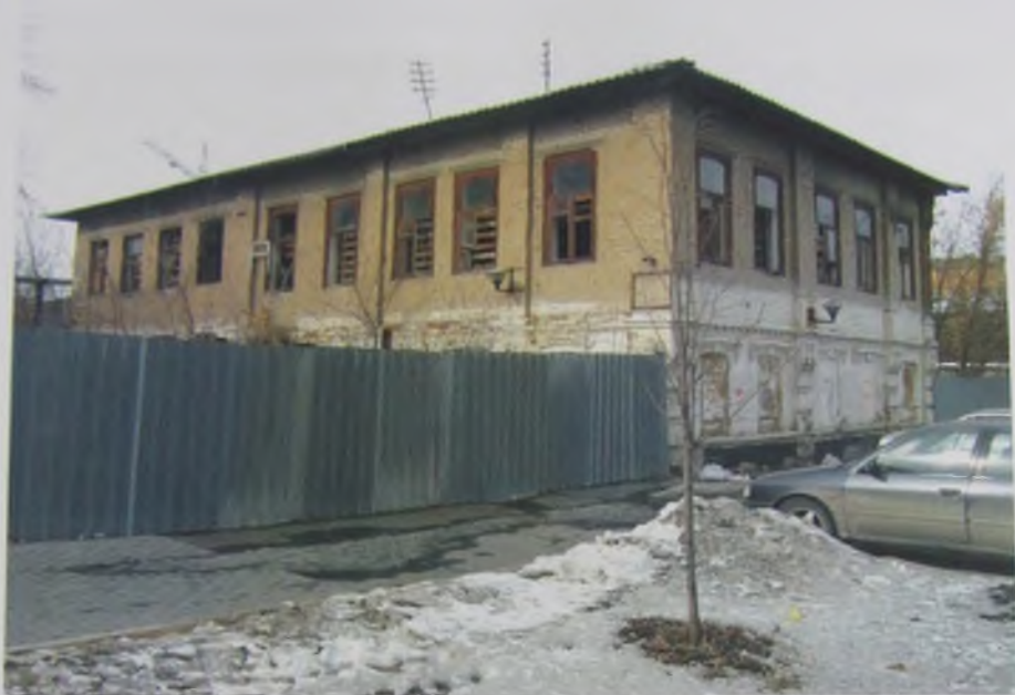
Рис.5. Общий вид здания по ул.Елькина, 22 с юго-востока
