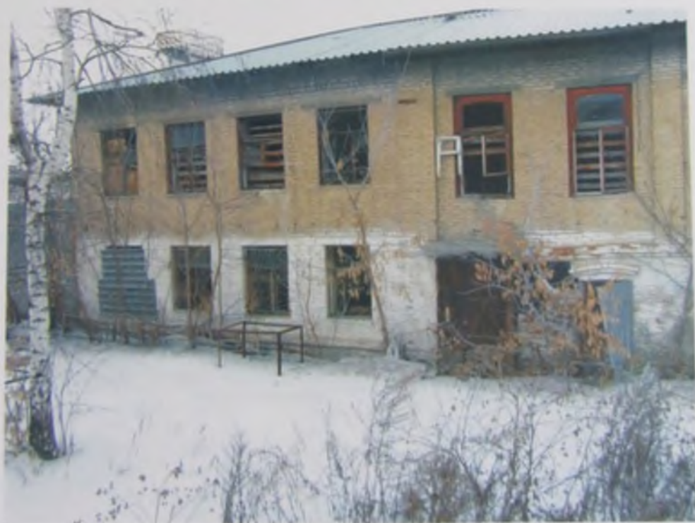
Рис.8. Левая часть южного фасада здания
