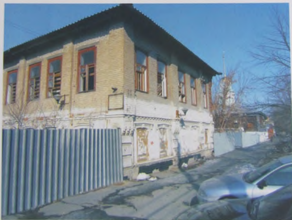
Рис.6. Восточный фасад здания
