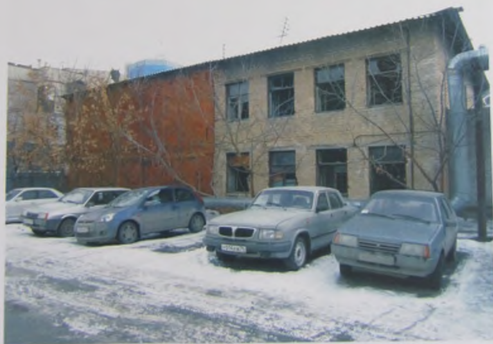
Рис.10. Северный фасад здания
