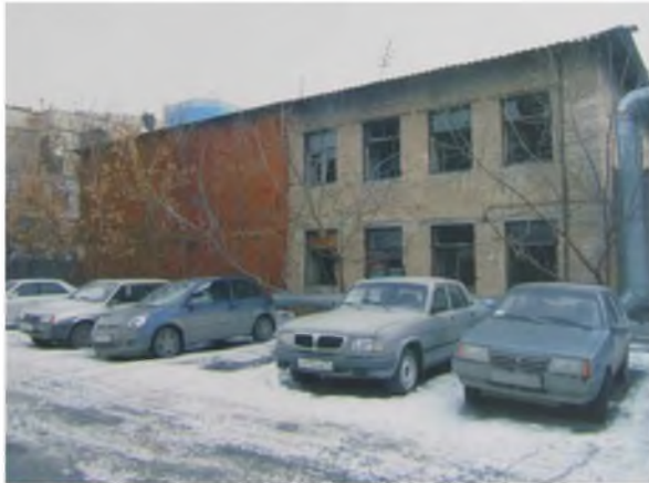
Общий вид северного фасада объекта культурного наследия
