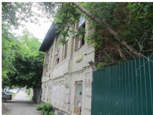
Общий вид центрального (восточного) фасада, выходящего на улицу Елькина
