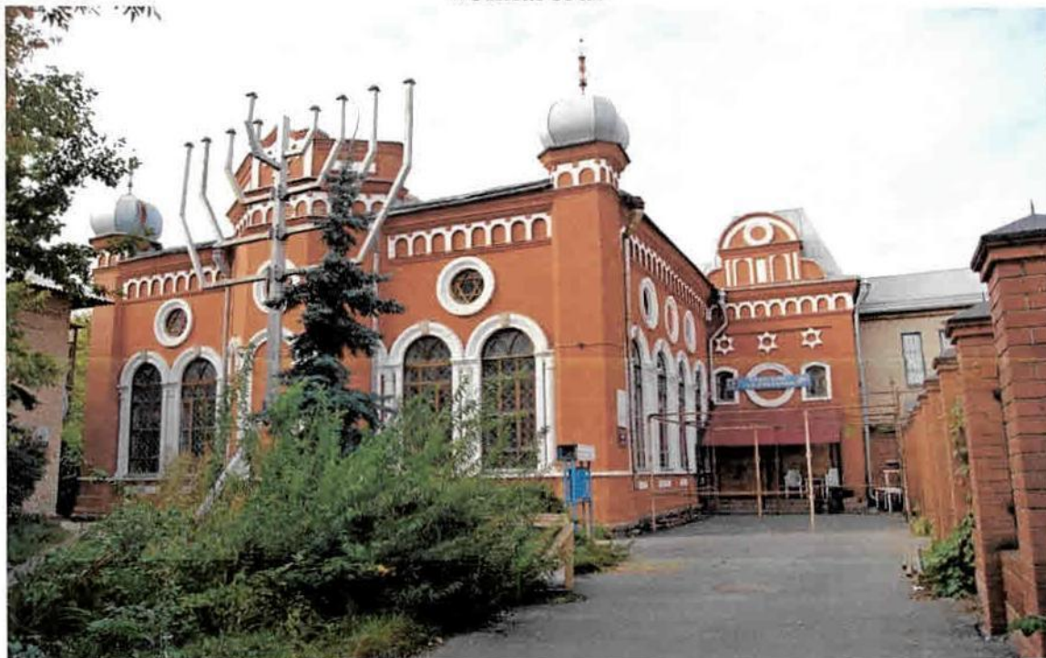
Фото 1. Общий вид здания с северо-востока
