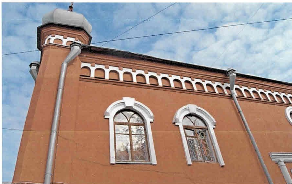
Фото 5. Фрагмент западного фасада. Вид на арочные окна 2-го этажа
