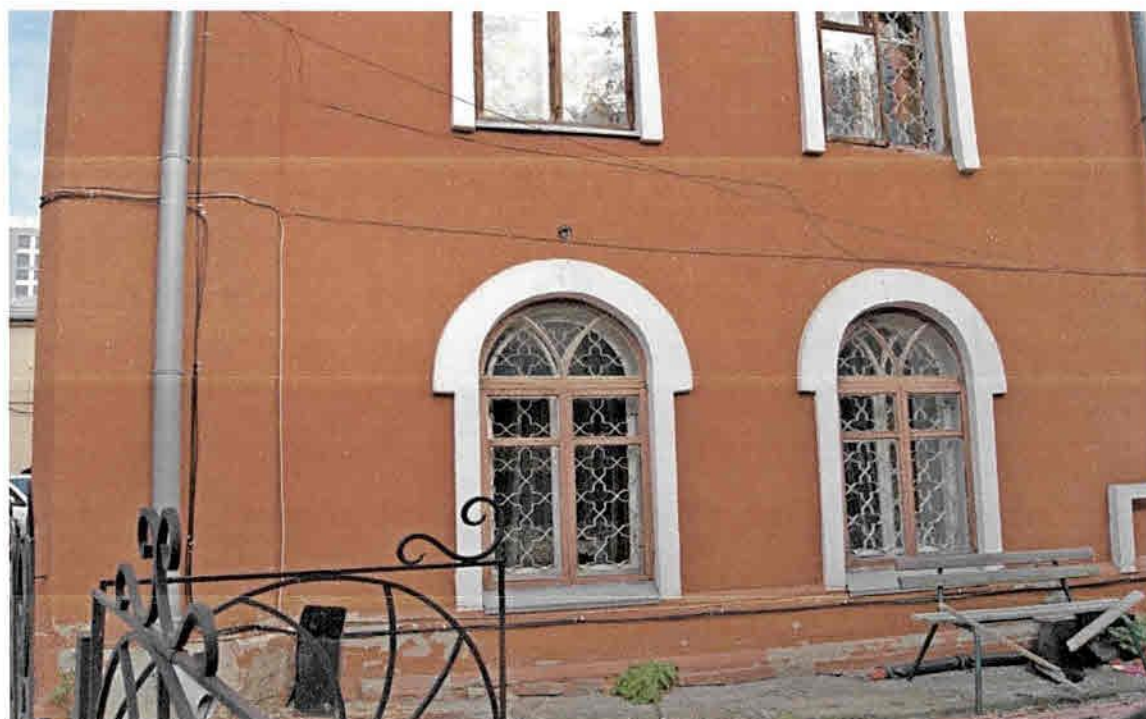
Фото 6. Фрагмент западного фасада. Вид на арочные окна 1-го этажа
