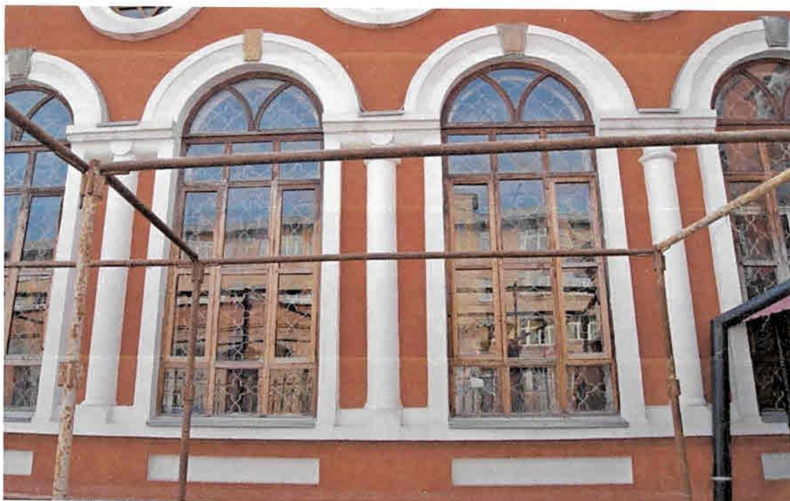
Фото 11. Фрагмент восточного фасада. Вид на арочные окна
