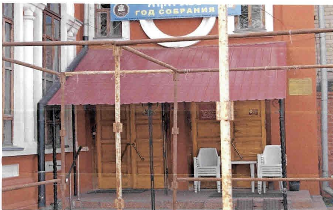
Фото 12. Главный вход в здание с восточной стороны
