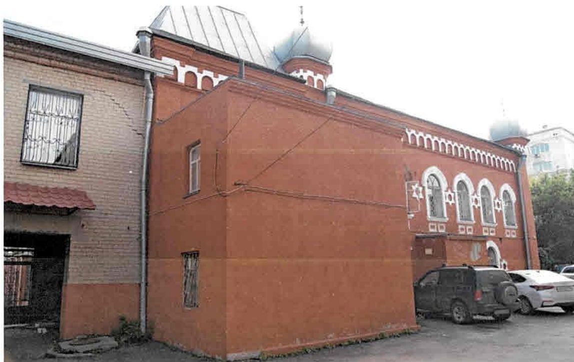
Фото 3. Вид на западный фасад с северо-западной стороны
