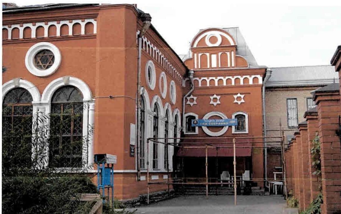
Фото 10. Вид на здание с северо-востока
