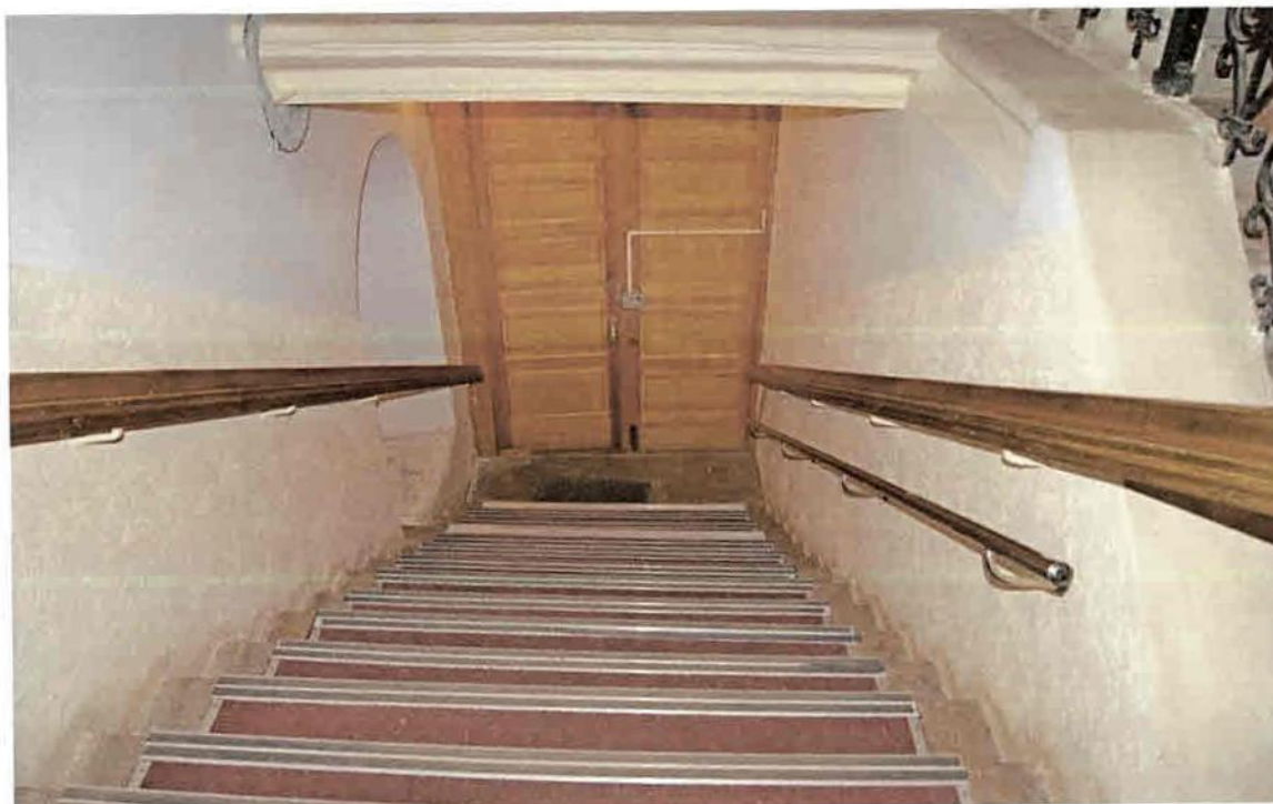
Фото 19. Фрагмент лестничного марша со 2-го этажа. Вид на входную дверь.
