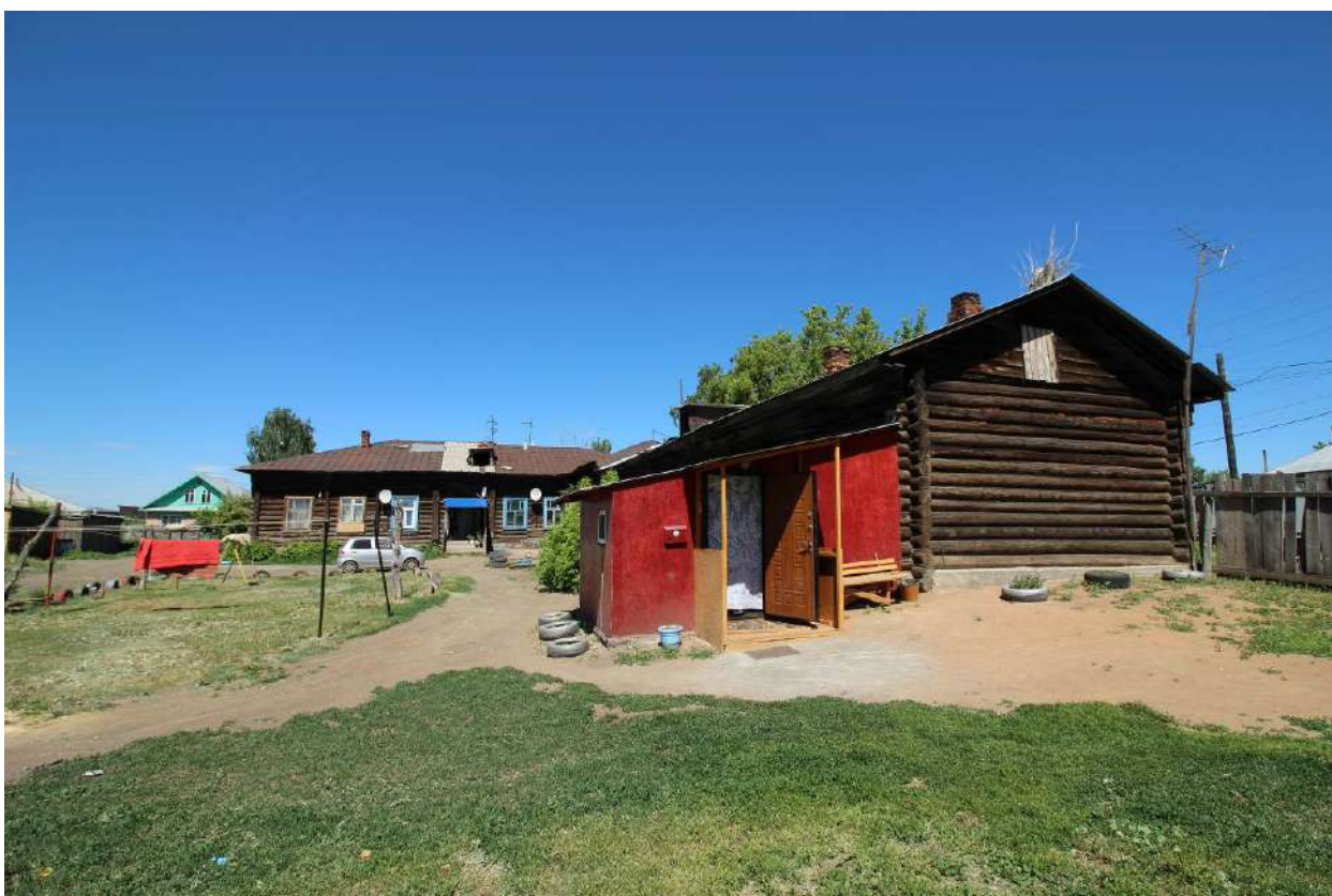
Фото 29. Выявленный объект культурного наследия. Внутренний двор, юго-восточный фасад. Направление на северо-запад.
