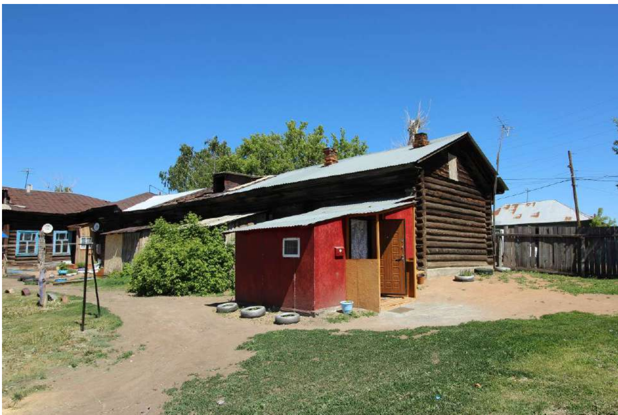
Фото 28. Выявленный объект культурного наследия. Внутренний двор. Направление на северо-запад.
