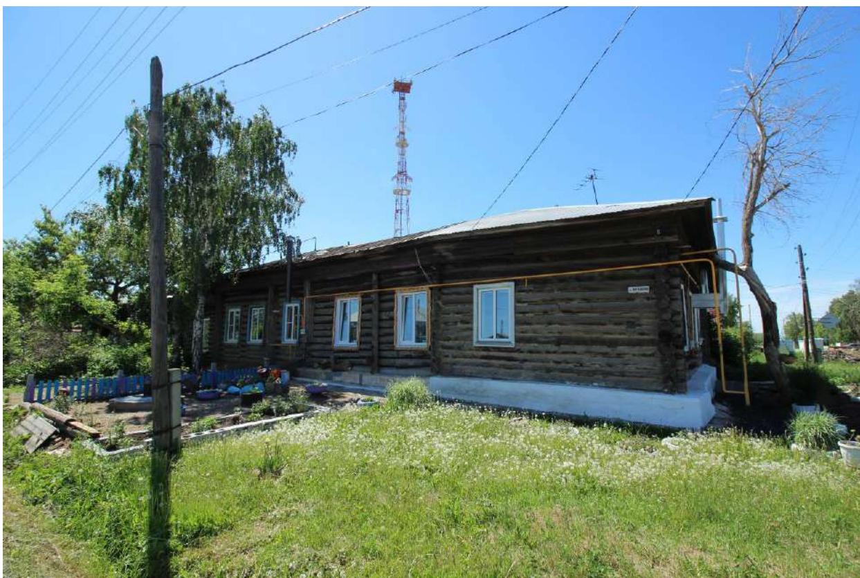
Фото 8. Выявленный объект культурного наследия. Северо-восточный фасад. Направление на юго-восток.
