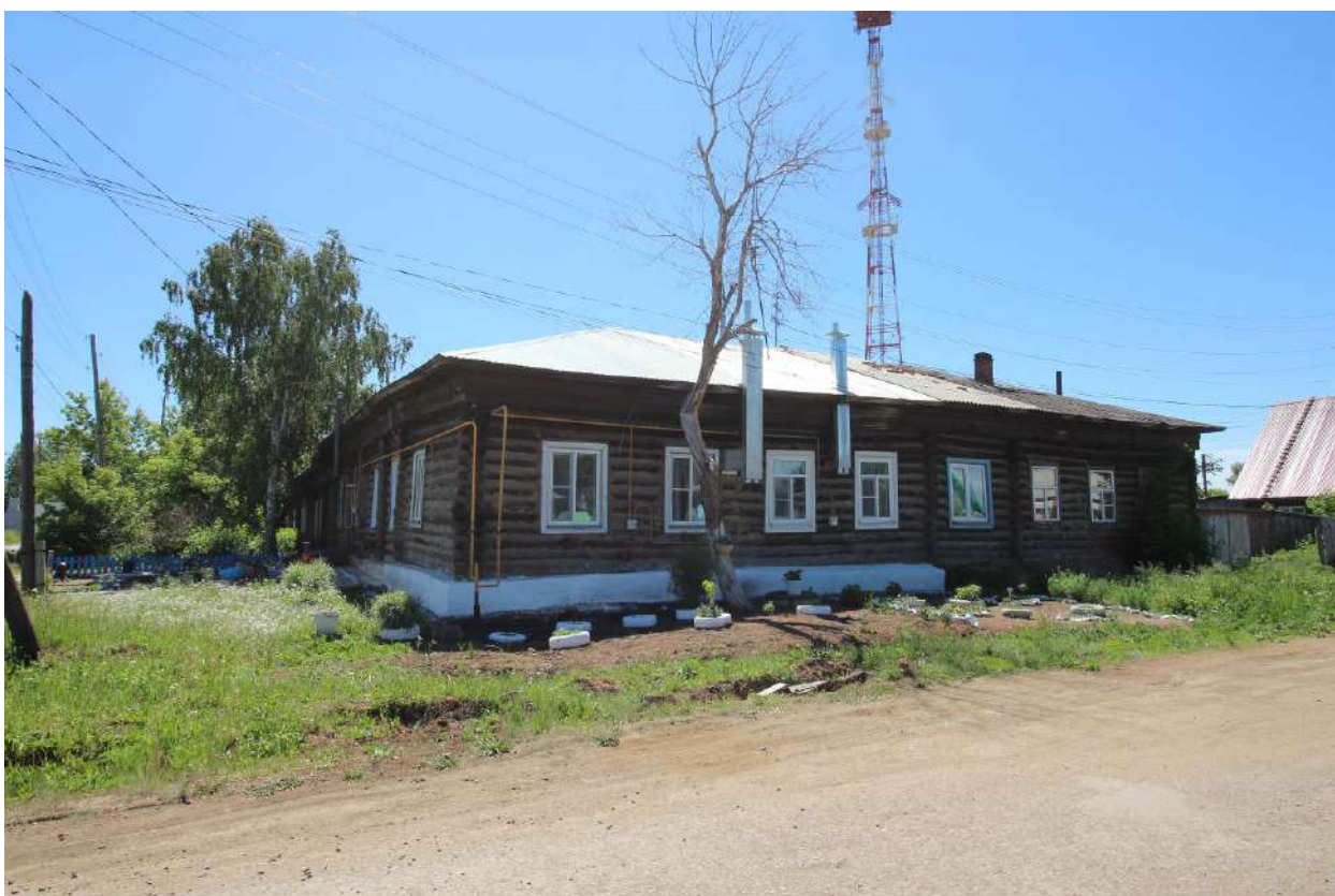
Фото 6. Выявленный объект культурного наследия. Северный угол. Направление на юго-запад.
