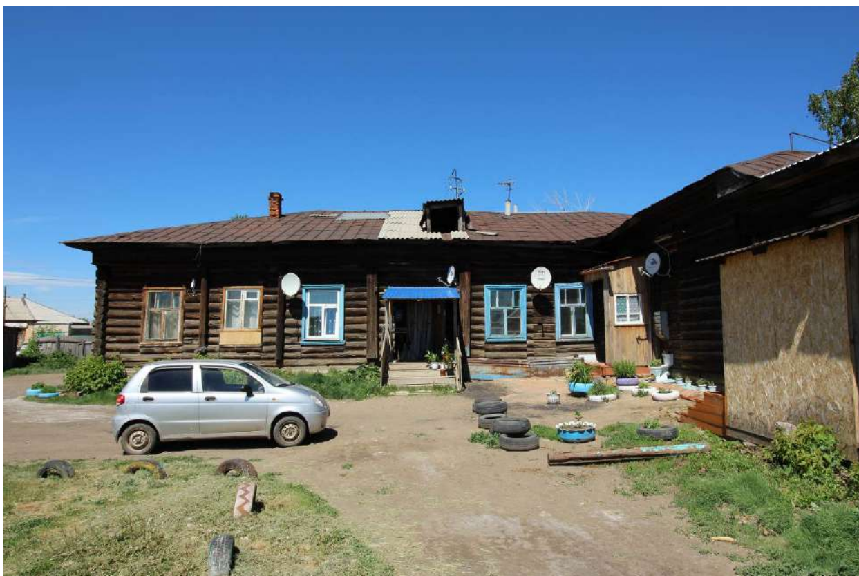
Фото 30. Выявленный объект культурного наследия. Внутренний двор, юго-восточный фасад. Направление на северо-запад.
